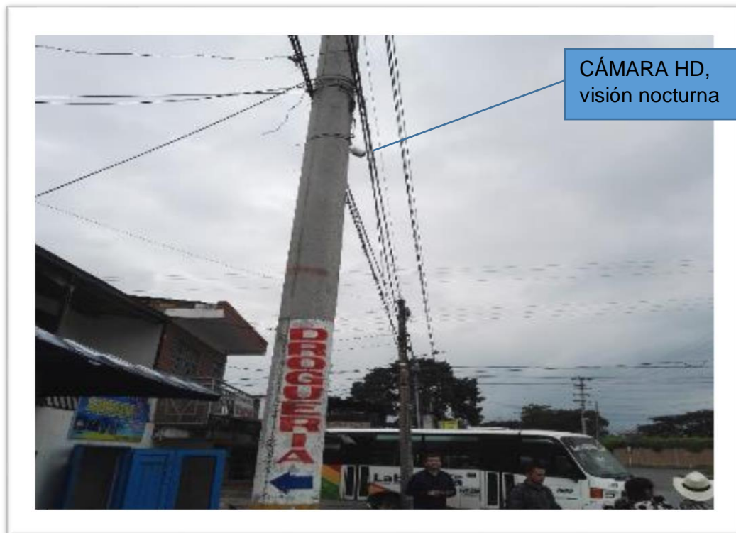
Ilustración 5. Instalación de la cámara.
