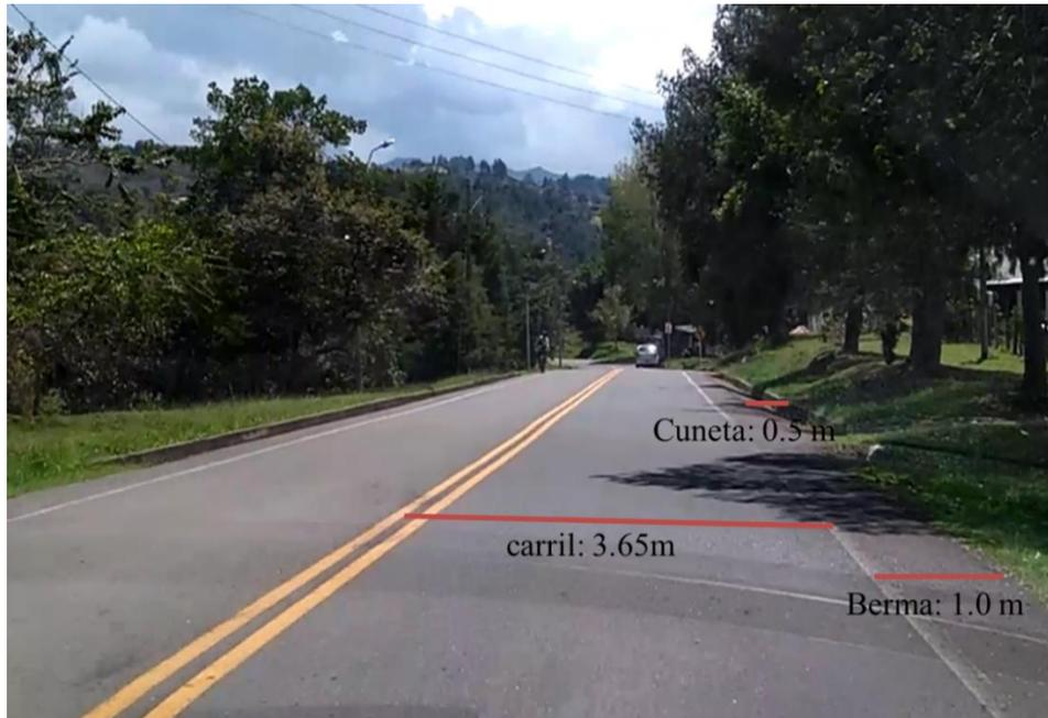
**Figura 3. Sección transversal típica del tramo de estudio.**
