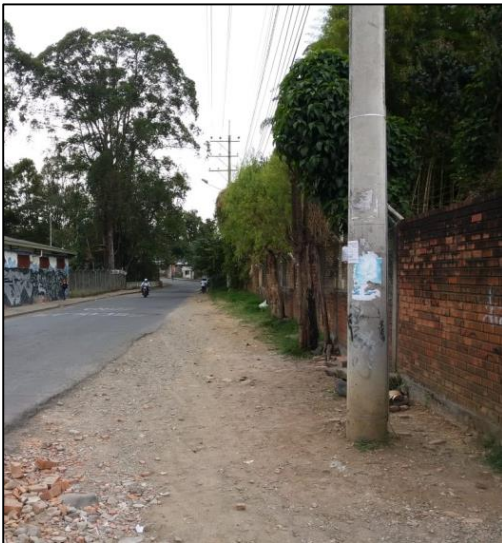
Foto 14. Andén Tramo 2 – Costado derecho
