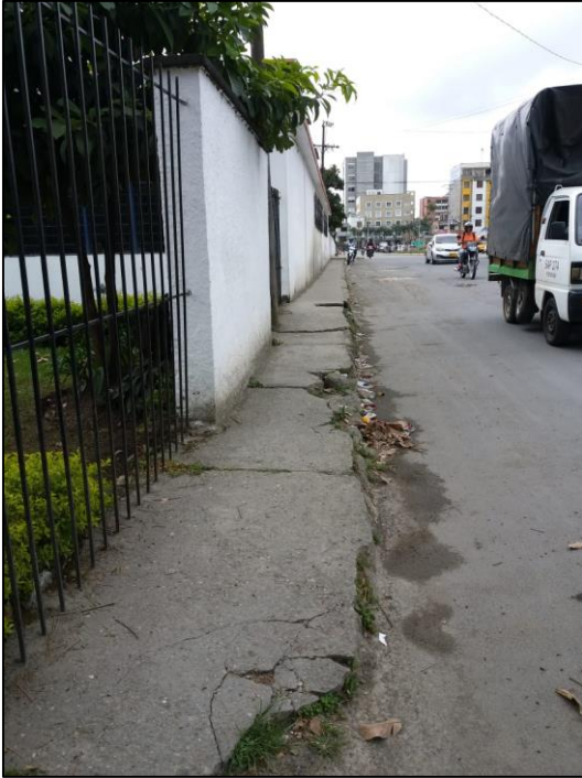
Foto 19. Andén Tramo 5 – Costado izquierdo
