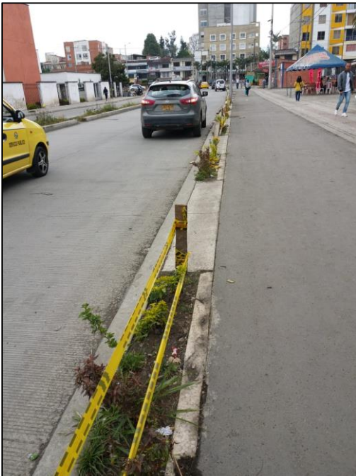
Foto 22. Andén Tramo 6 – Costado derecho
