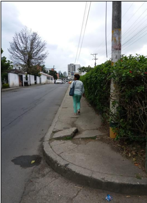
Foto 20. Andén Tramo 5 – Costado derecho
