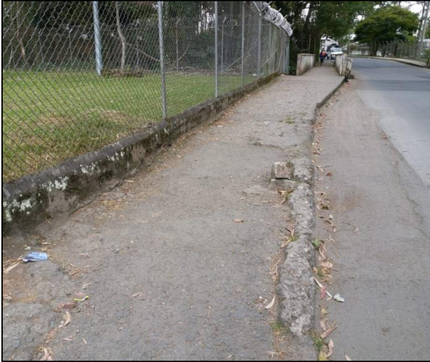
Foto 13. Andén Tramo 2 – Costado izquierdo
