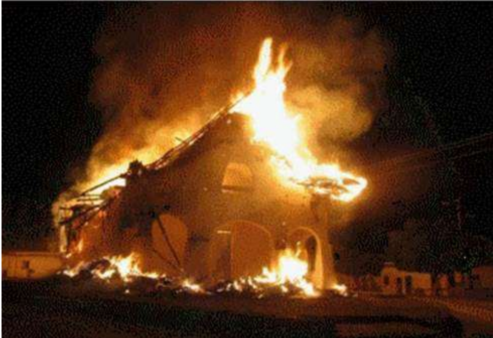
Foto No. 24. Incendio provocado de la Iglesia de San Andrés de Pisimbalá – Inzá, 2013
