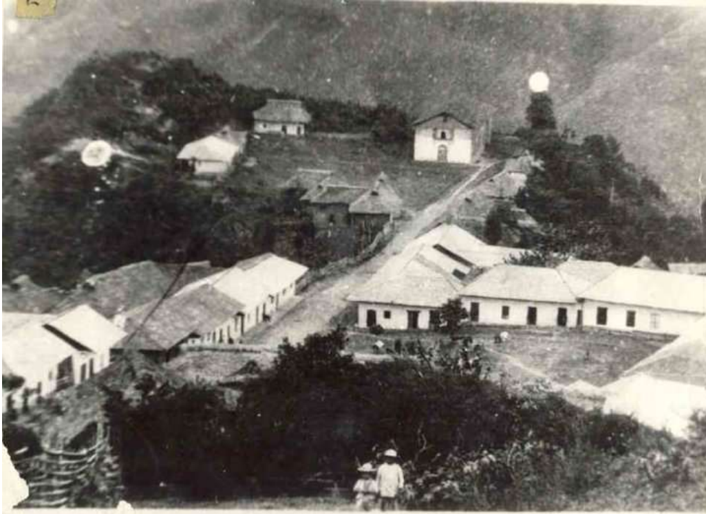
Foto No. 5. Vista de la Plaza y del Parque de Inzá. Posiblemente en la década de 1940.
