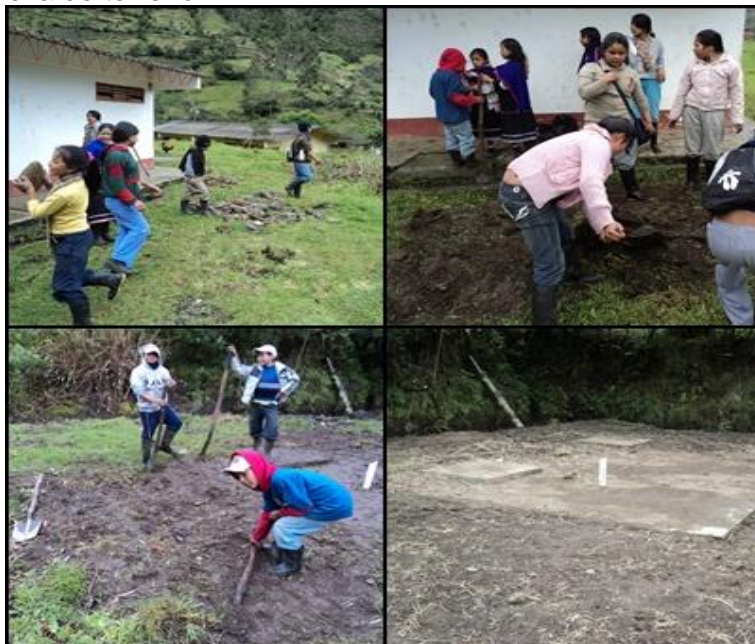
Figura 16. Limpieza de terreno
