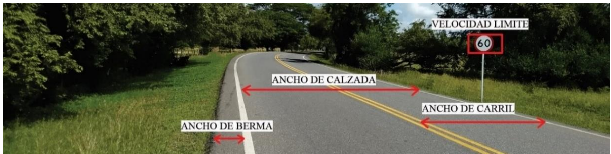
Ilustración 8. Elementos de la sección transversal
