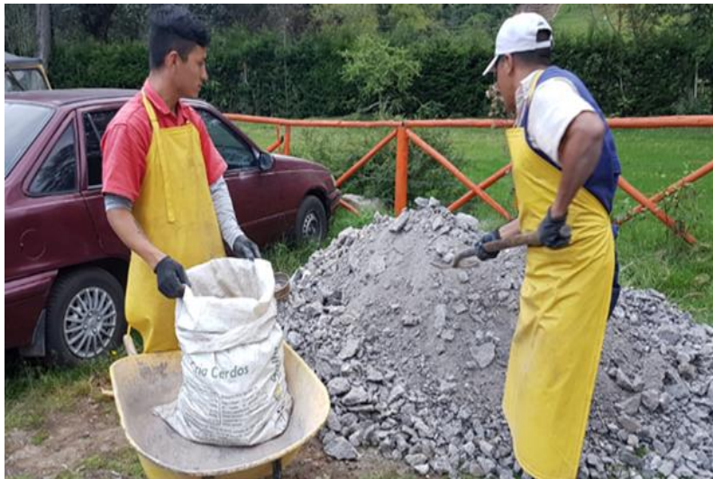
Figura 2 Selección manual de material fragmentado proveniente de demolición de pavimento rígido.
