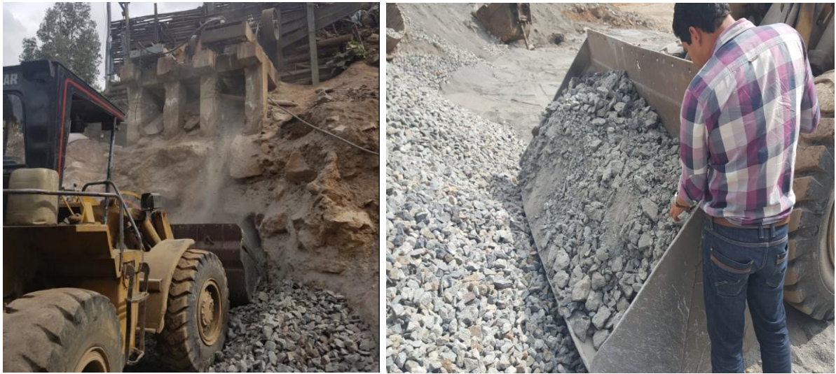
Figura 1 Trituración de material proveniente de demolición de pavimento rígido.
