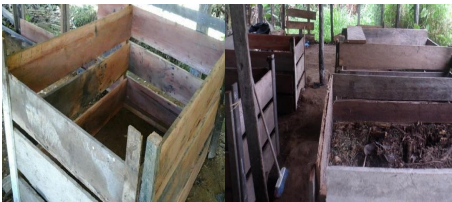
Figura 5 Construcción de cajones
