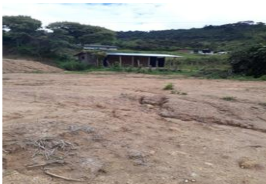
Figura 11. Erosión en DBG, terrenos perjudicados por la urbanización.
