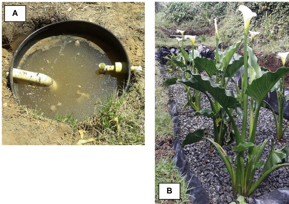
**Figura 4.** Sistema de tratamiento. A) Tanque de sedimentación y B) Humedal construido con cartucho blanco (*Zantedeschia aethiopica*).
