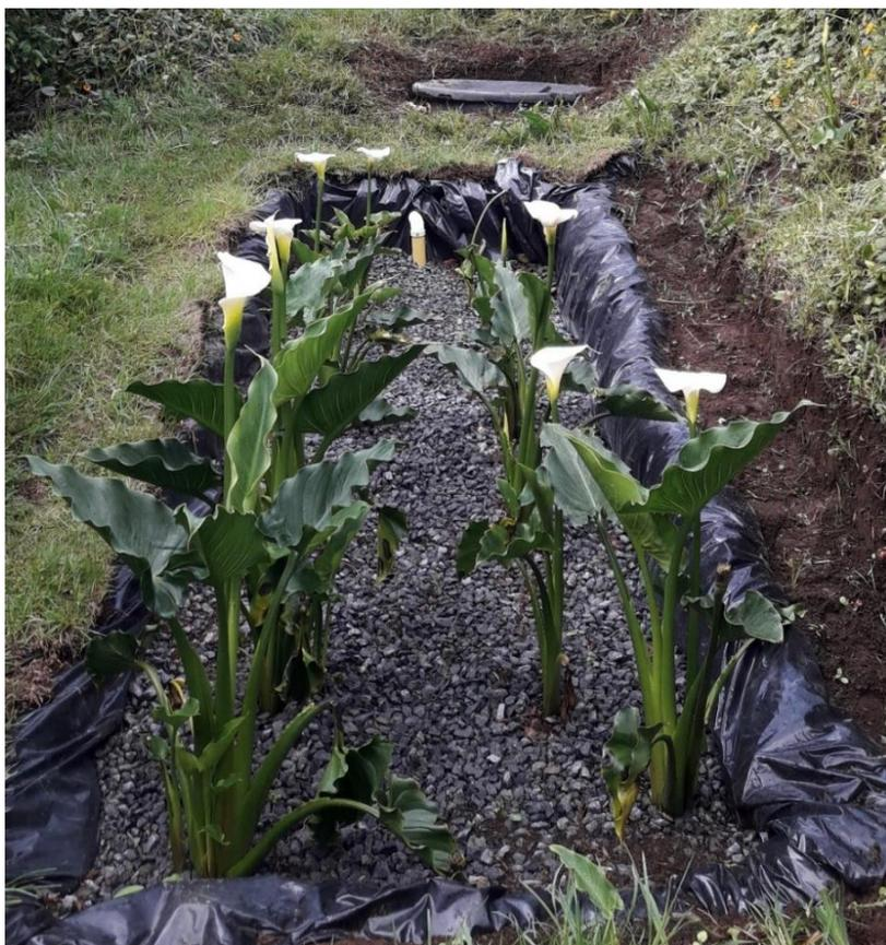
**Figura 2.** Sistema de tratamiento con un humedal construido en el Hostal El Molino-corregimiento de Paispamba, Sotará (2°11'59.5"N 76°38'55.5" W).
