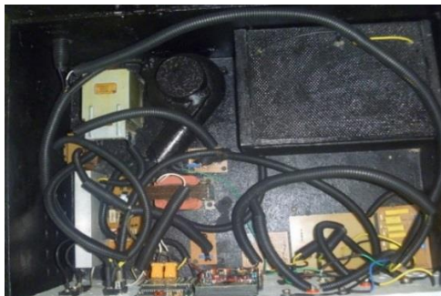
Imagen 10 construcción del sistema eléctrico del equipo.
