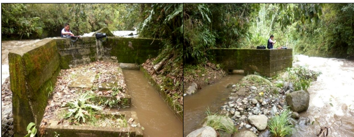
Imagen 15. Bocatoma Acueducto La Venta – El Cofre.
