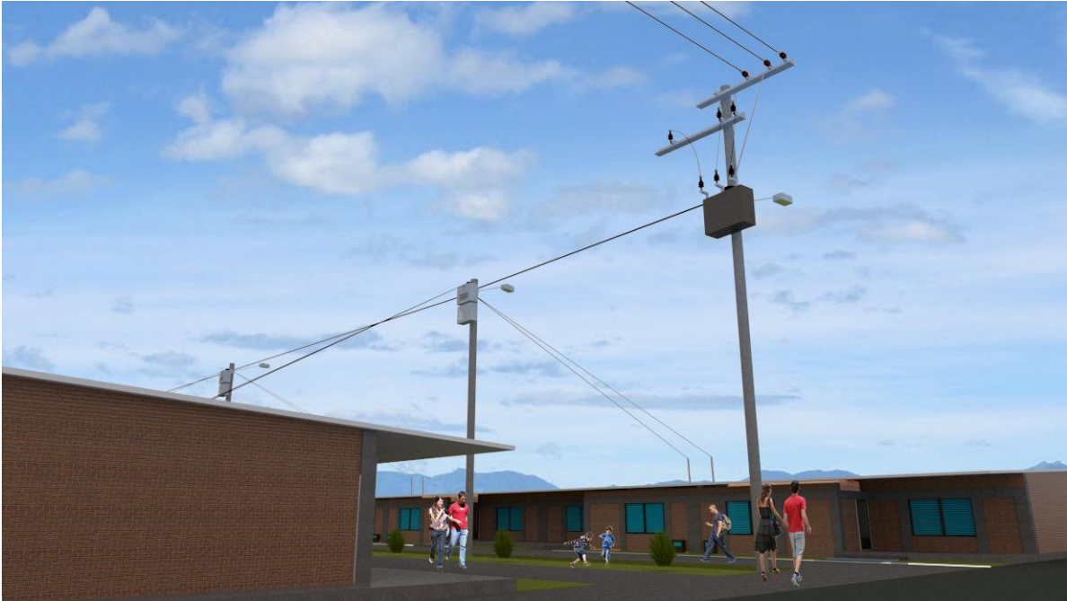
Figura 34. Vista 3D montaje de armarios de medida concentrada barrio portal de las ferias II etapa. (Fuente: elaboración propia)
