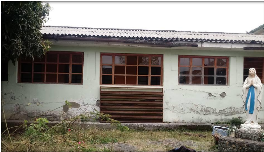
Ilustración 24 instalación del muro al finalizar fase 1
