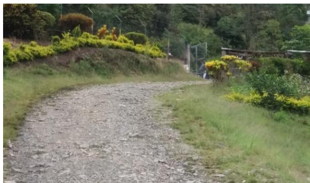
Imagen 7. Portón principal habilitado para el ingreso de estudiantes y parque automotor.
