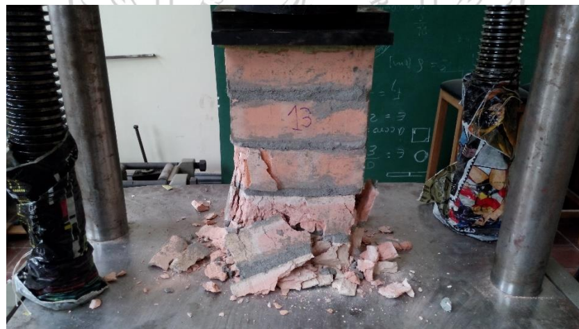
Foto 41. Falla a compresión de prisma 13
