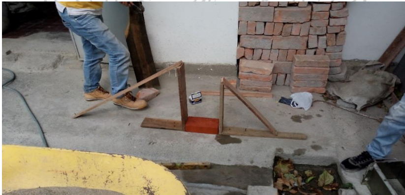
Foto 19. Formaleta utilizada para la alineación y acomodo correcto de los ladrillos.
