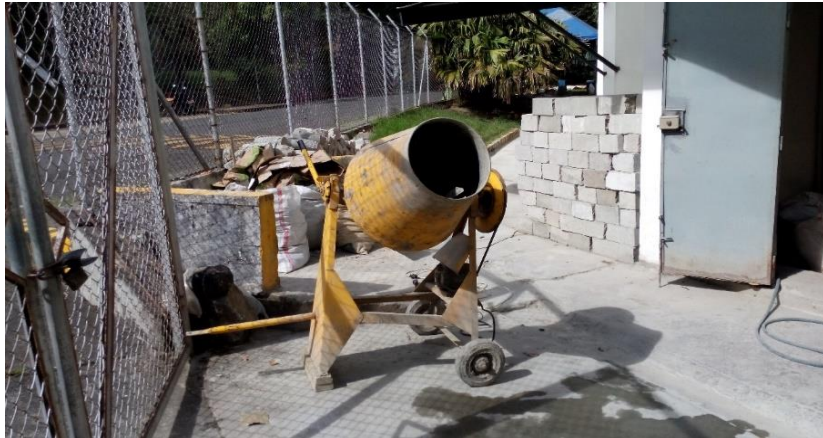
Foto 18. Mezcladora mecánica utilizada para la preparación de la mezcla de mortero.
