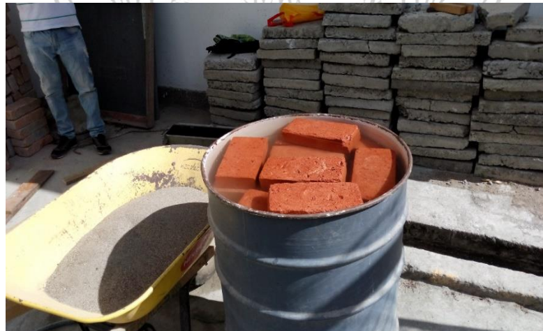
Foto 16. Humedecimiento de unidades de mampostería.
