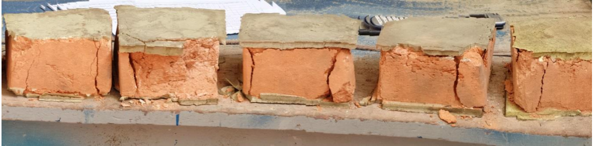
Foto 4. Falla de las unidades de mampostería.
