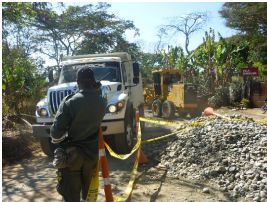
Imagen No. 15 Vía Cerrada Por trabajos
