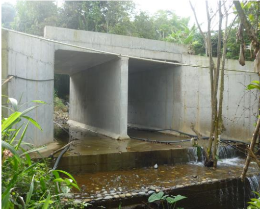
Imagen No.1 Box Culvert doble celda
