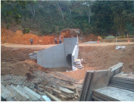
Imagen No.5 Alcantarilla en construcción
