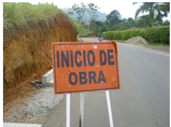
Imagen No.14 Obra señalizada
