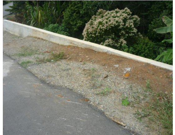
Imagen No.2 Muro de contención
