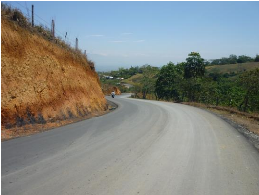
Imagen No.3 Pavimento Flexible
