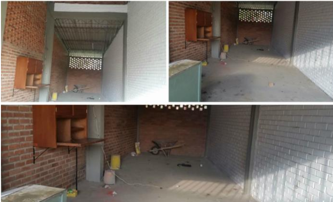
Figura No.36 Registro fotográfico del salón que se le va a realizar enchape del piso y cielo raso.
