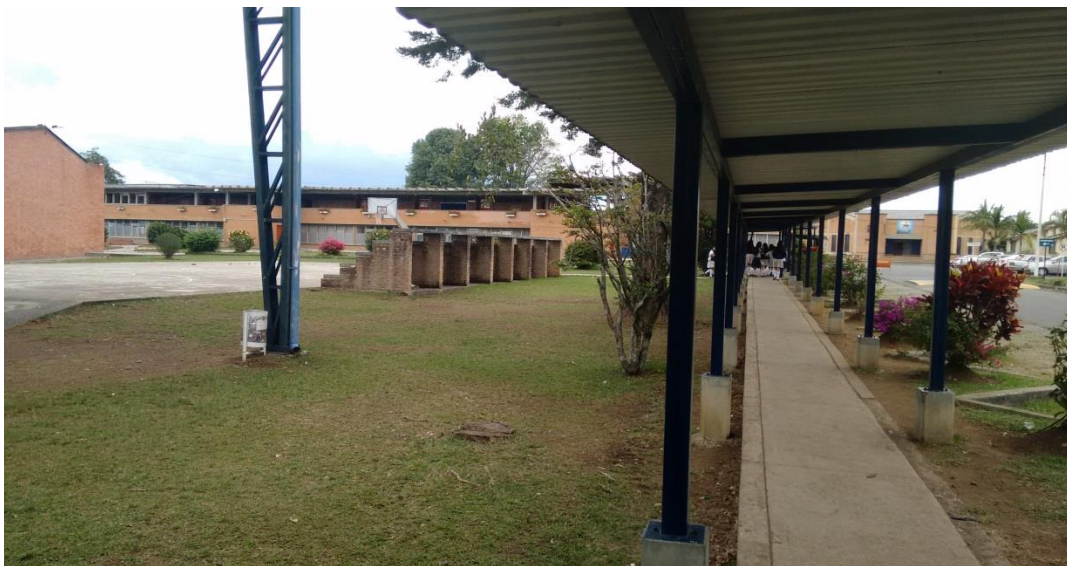
Figura no.20 Aguas lluvias de cubierta de cancha y paso peatonal descargadas en el terreno.
