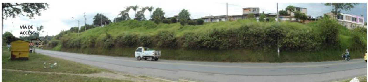
Figura 1.2 Vista panorámica del talud desde la variante de Popayán.
