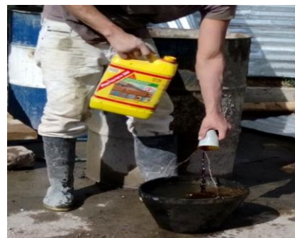
Figura N°27: Adición de plastocrete Sika.
