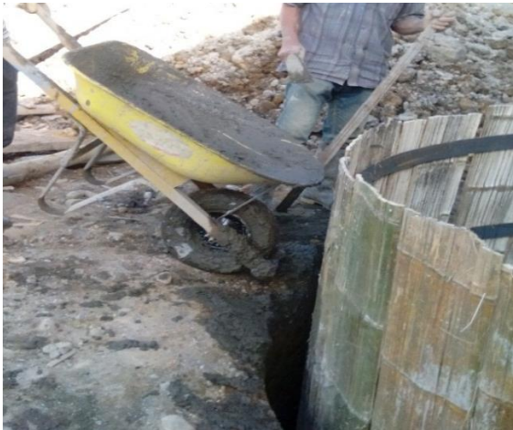
Figura N°11 : Fundición del anillo.
