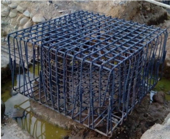
Figura N° 39: Refuerzo cabezal interno.
