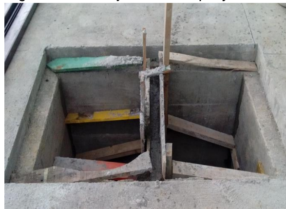
Figura N° 66 : Caja 3 con tabique y cañuela.
