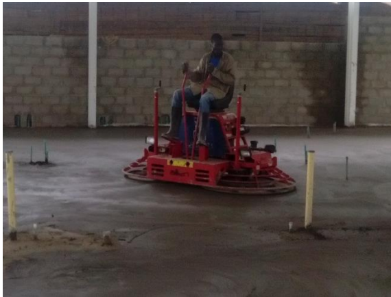
Figura N° 75 : Pulimiento de la losa.
