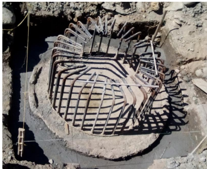
Figura N° 32: Excavación y solado para cabezales.
