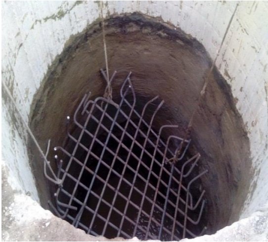
Figura N° 21: Refuerzo de caisson completo.
