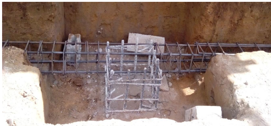
Figura N° 51: Refuerzo vigas y zapatas de cimentación.
