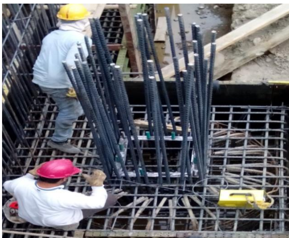
Figura N° 42: Arranques de columna
