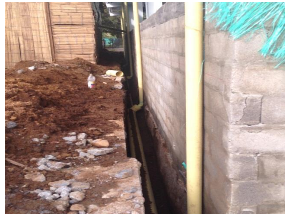
Figura N° 63: Bajantes de agua lluvia.
