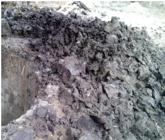
Figuras N° 16 y 17 : Material producto de la excavación.
