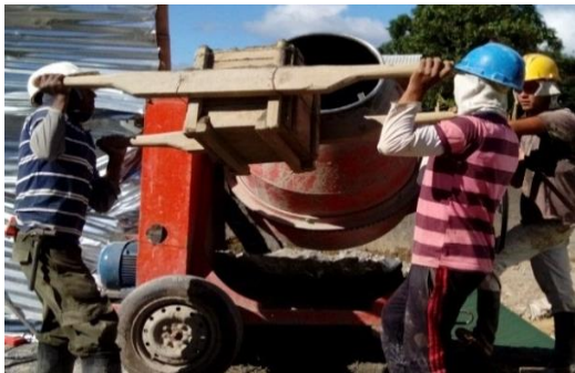
Figura N° 26: Mezcla mecánica.
