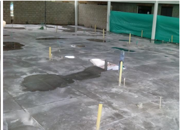
Figura N° 76: Losa y juntas de dilatación.
