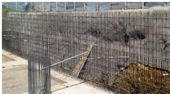
Figura N° 38: Refuerzo en muro de contención.
