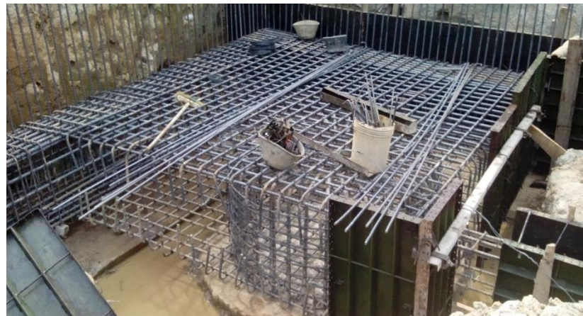
Figura N° 41: Refuerzo cabezal esquinero.
