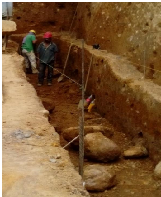
Figura N° 30 y 31: Excavación y solado en Vigas - Muro.
