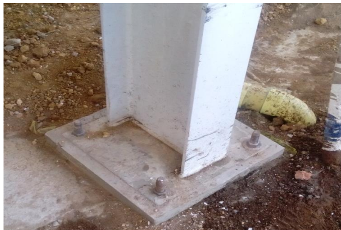
Figura N° 59: Relleno entre platina y pedestal de la zapata.
