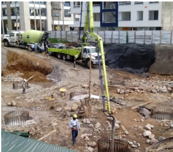
Figura N° 22: Fundición con autobomba.
