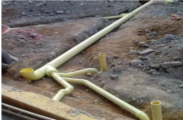
Figura N° 64: Tubería de 4" y 2" para sanitarios.
