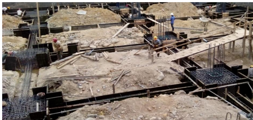
Figura N° 46: Formaletas instaladas.
