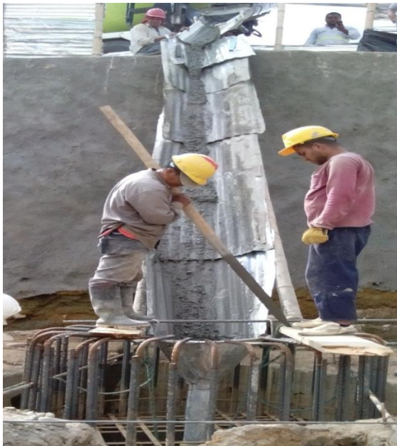
Figuras N° 24 y 25: Fundición sin autobomba.
