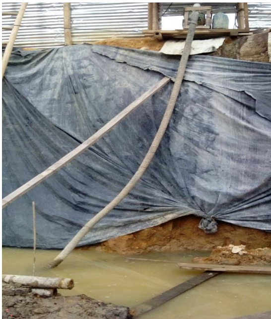
Figura N°6: Drenaje de aguas freáticas.
