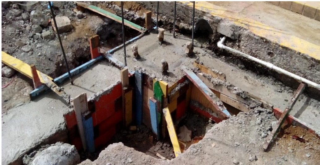
Figura N° 54: Fundición de vigas y zapatas de cimentación.
