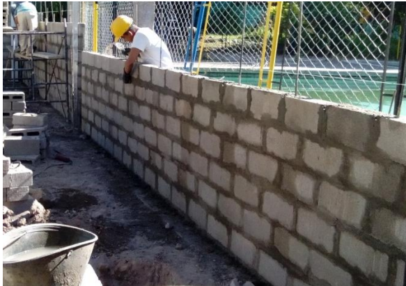
Figura N° 56: Construcción muro estructural.
