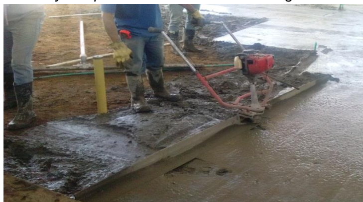
Figura N° 74 : Extendido y compactación del concreto con regla metálica.
