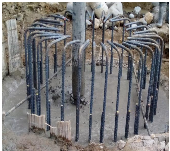
Figura N° 23: Caisson fundido.
