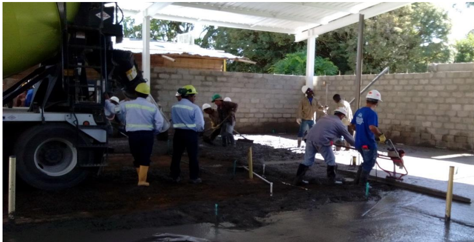
Figura N° 73 : Vaciado del concreto.
