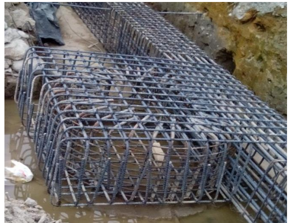
Figura N° 40: Refuerzo cabezal perimetral
