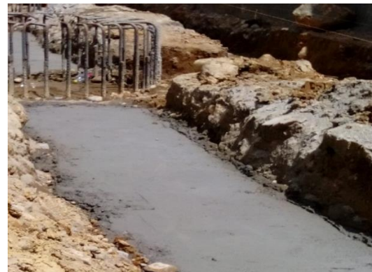
Figura N° 28 y 29: Excavación y solado en vigas de cimentación.
