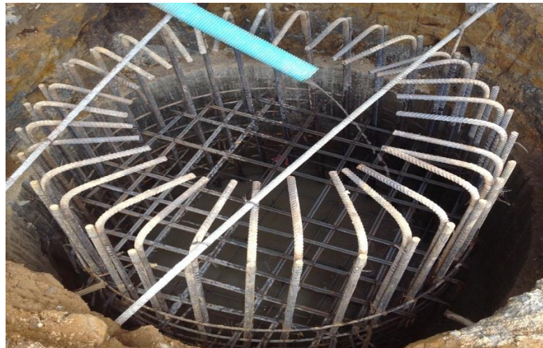
Figura N° 21: Refuerzo de caisson completo.
