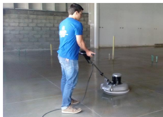
Figura N° 79: Brillo de la losa.
