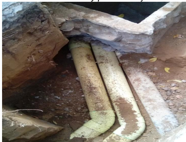
Figura N° 67 : Conexión de tubería residual y pluvial a caja encontrada.
