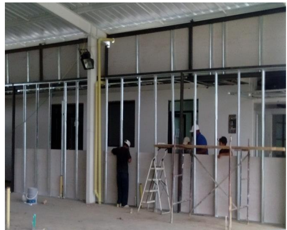
Figuras N° 81 y 82: Estructura liviana en muros perimetrales.
