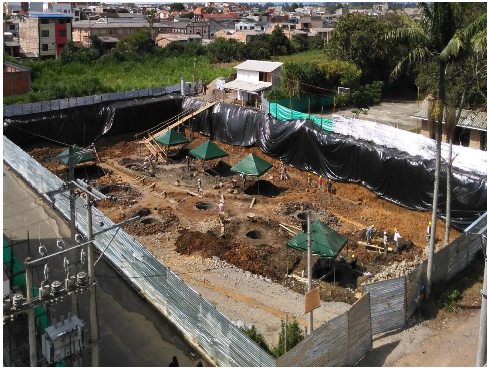
Figura N° 5: Adecuación, limpieza y descapote.
