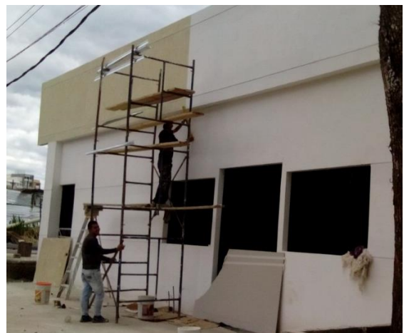
Figura N° 84 : Pintura en graniplast
