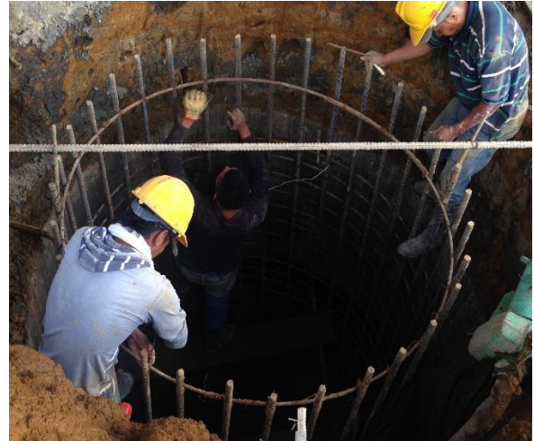
Figura N° 21: Refuerzo de caisson completo.
