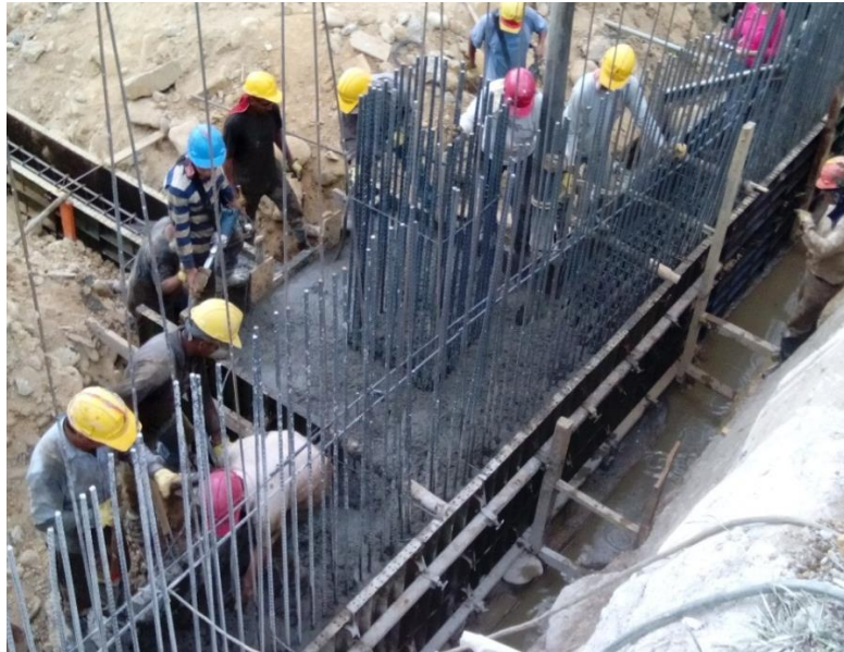
Figura N° 47: Fundición de cabezales, viga muro y viga de cimentación.
