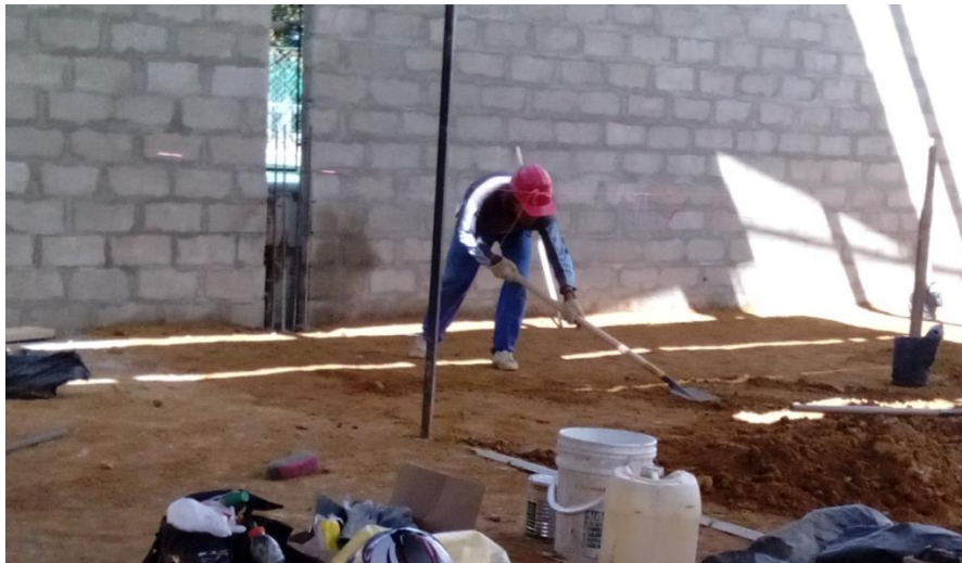
Figura N° 69 : Relleno con tierra amarilla.
