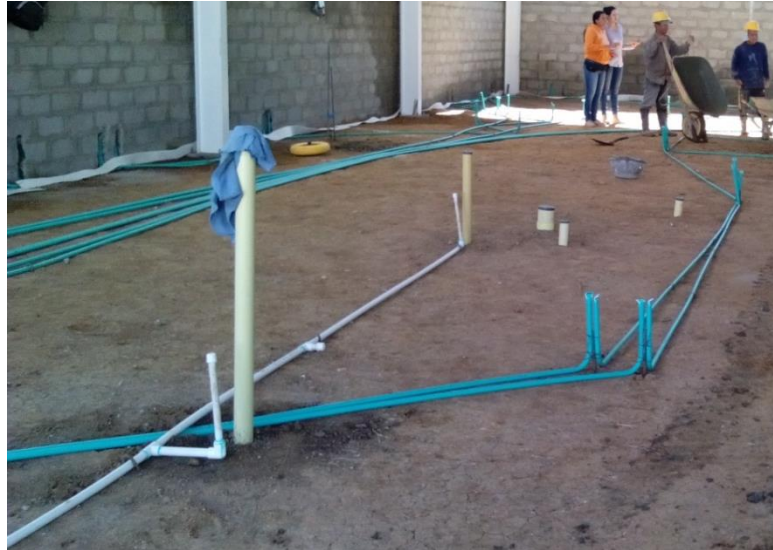
Figura N° 71 : Tendido de tubería de red electrica.
