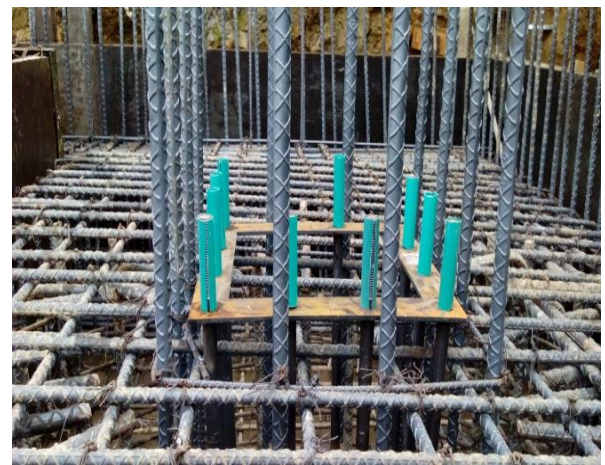
Figura N°43: Platina para estructura metálica
