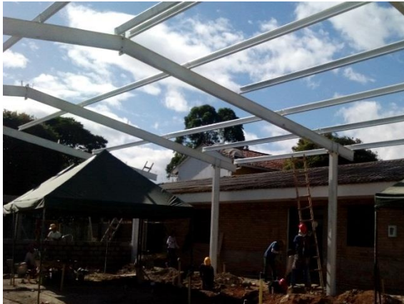
Figura N°60: Montaje estructura metálica.
