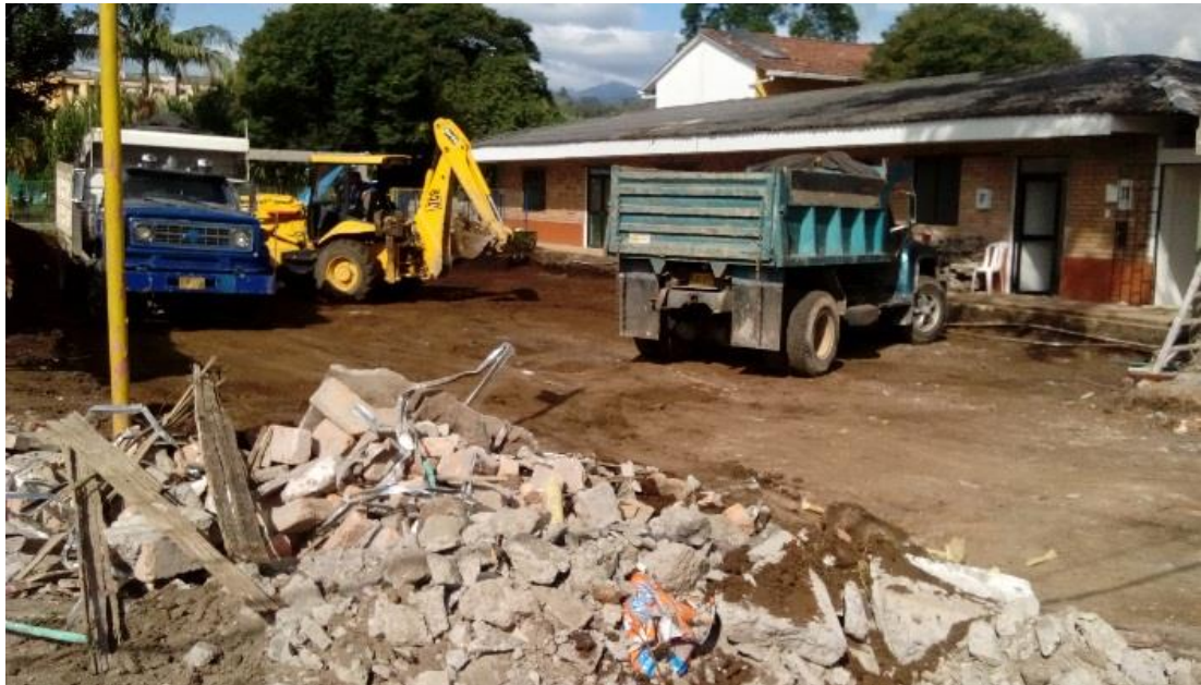
Figura N° 50: Limpieza y descapote del lote
