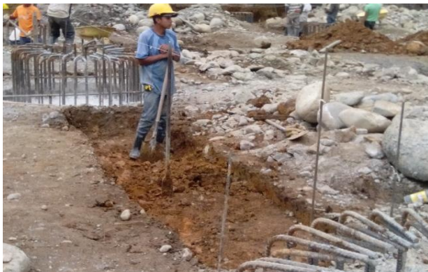
Figura N° 28 y 29: Excavación y solado en vigas de cimentación.
