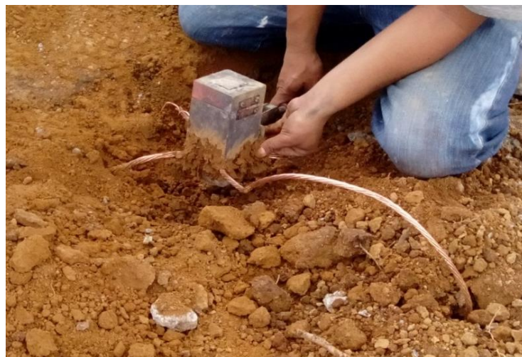
Figura N° 72 : Instalación de malla tierra.
