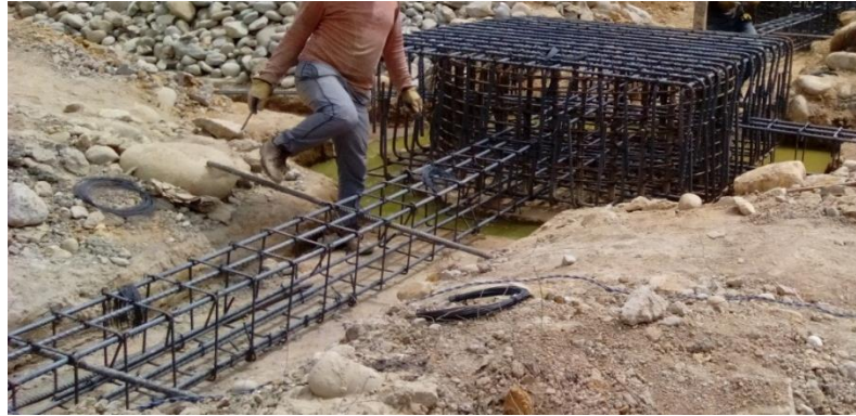
Figura N° 45: Refuerzo viga de cimentación
