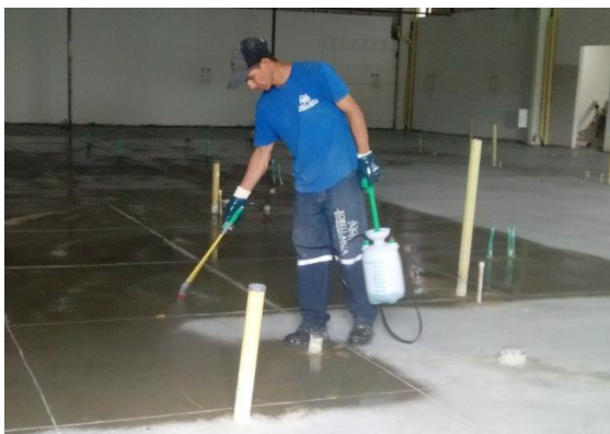
Figura N° 78: Aplicación de ácido.
