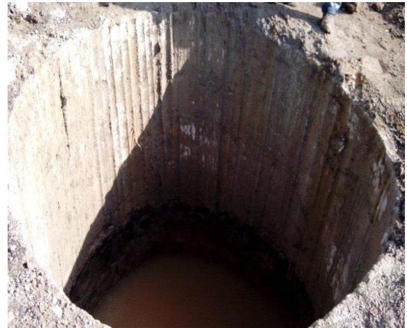
Figura N° 12: Anillo terminado.
