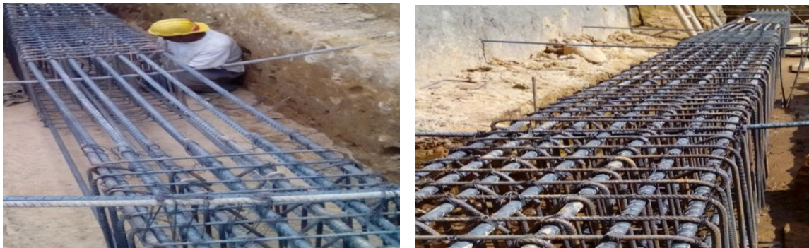
Figura N° 36: Espacio en Viga - Muro. Figura N°37: Refuerzo terminado en Viga - Muro
