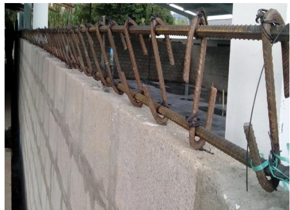
Figura N° 57: Refuerzo viga de amarre.
