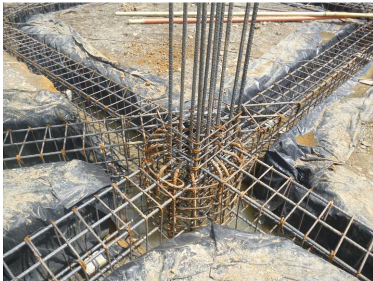
Figura No 2 Nacimiento de elemento estructural desde cabeza de caisson
