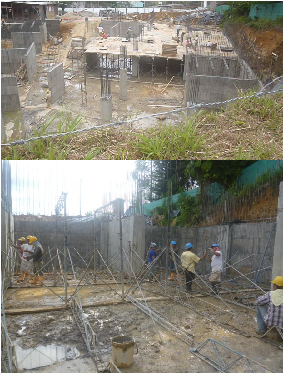
Figura No 13 Armado del encofrado de losa
