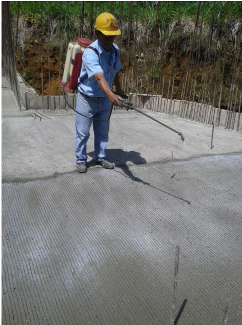
Figura No 23 Proceso de texturizado y curado del concreto
