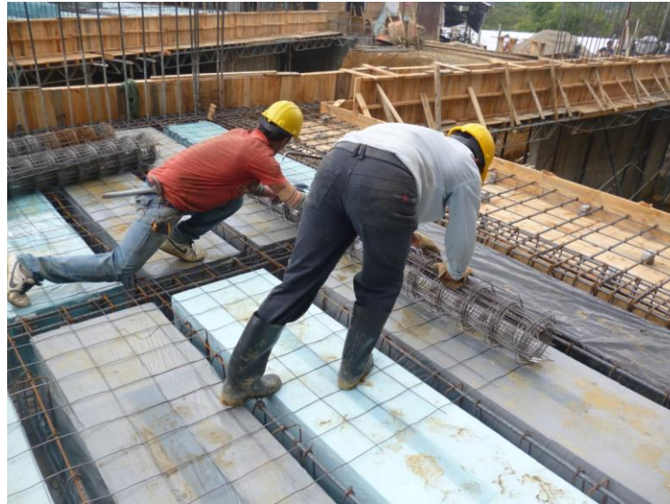
Figura No 18 Instalación de refuerzo de retracción y temperatura
