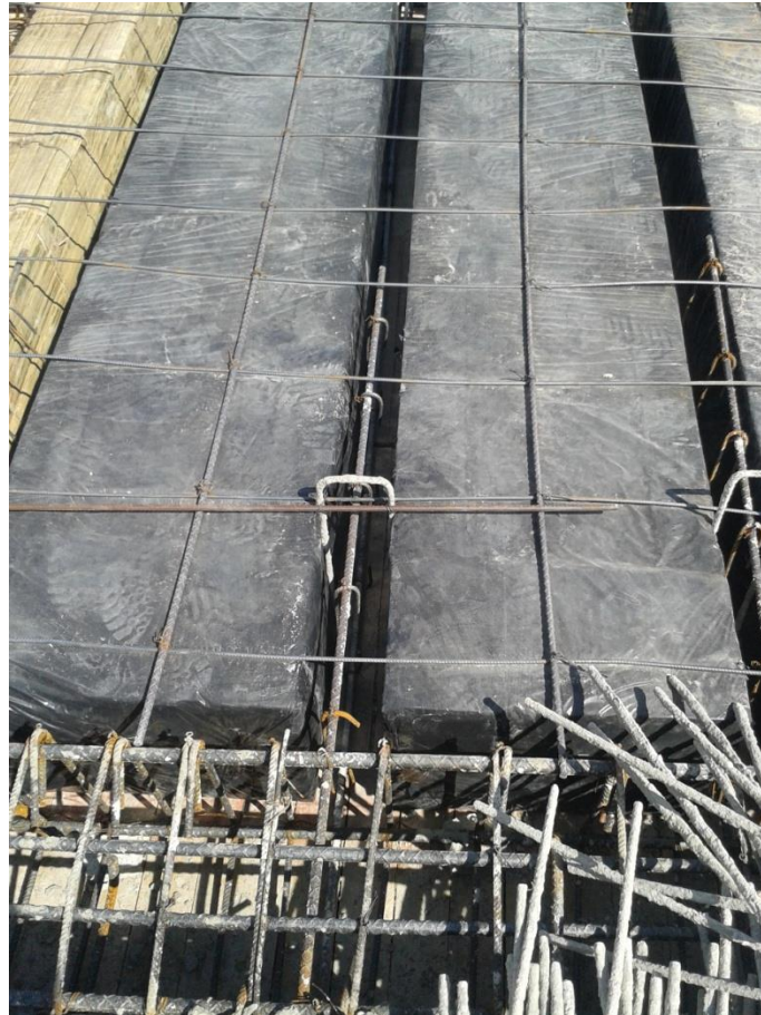
Figura No 17 Detalle del separador de casetones
