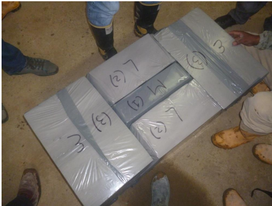
Figura No 25 Detalle de casetón de icopor recuperable
