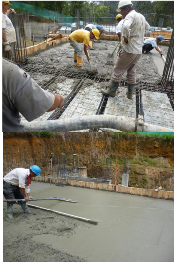
Figura No 22 Proceso de distribución y tallado del concreto
