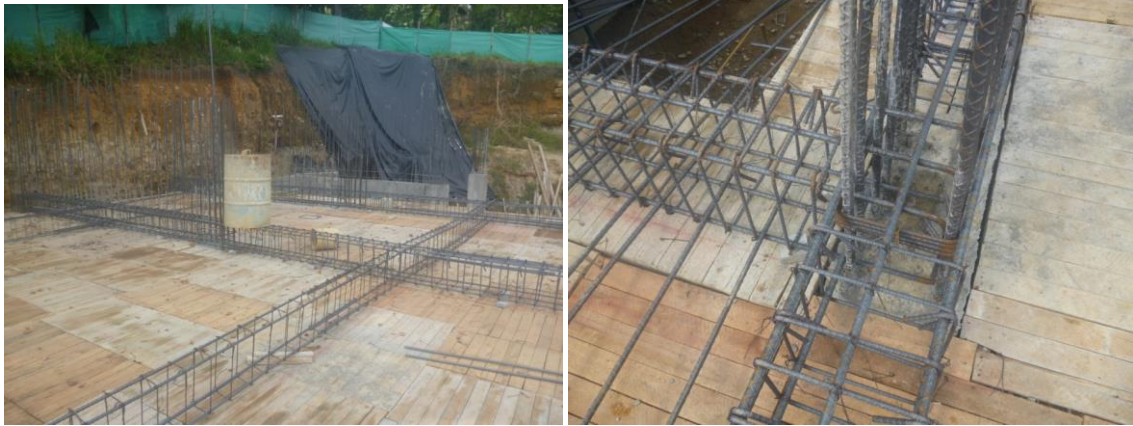
Figura No 14 Amarrado de refuerzo principal en las losas
