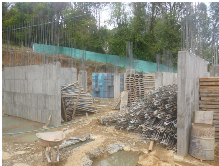
Figura No 12 Alistamiento del equipo para armado de losa
