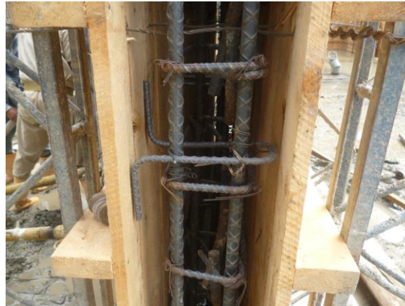
Figura No 7. Detalle del separador de formaleta
