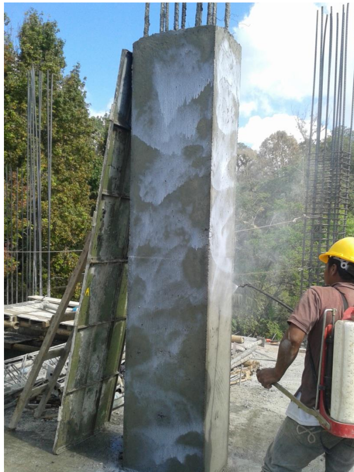
Figura No 11. Aplicación de Curador en elementos estructurales
