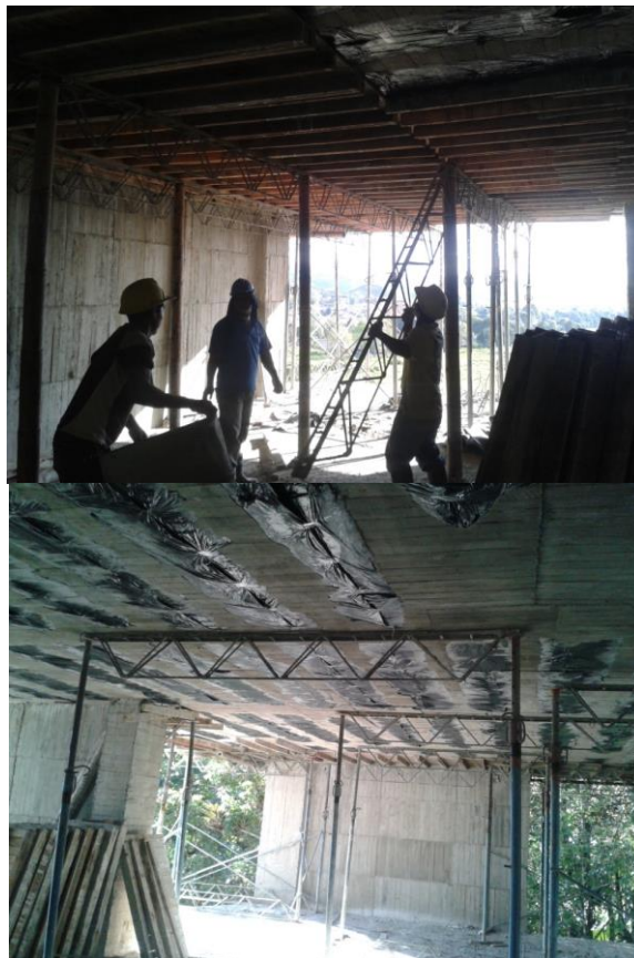
Figura No 24 Proceso de desencofrado y re-atraque de la losa
