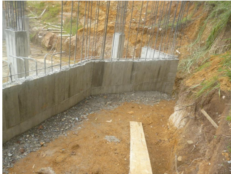
Figura No 28 Relleno del filtro con material granular
