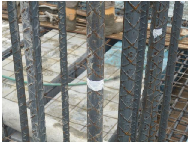
Figura No 20 Detalle de referenciación de niveles
