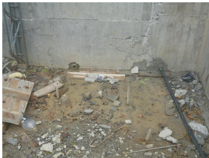
Figura No 29 Detalle de lagrimal de muro y conducción del mismo
