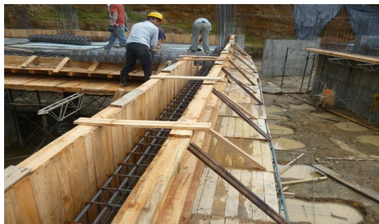
Figura No 19 Instalación de formaleta lateral
