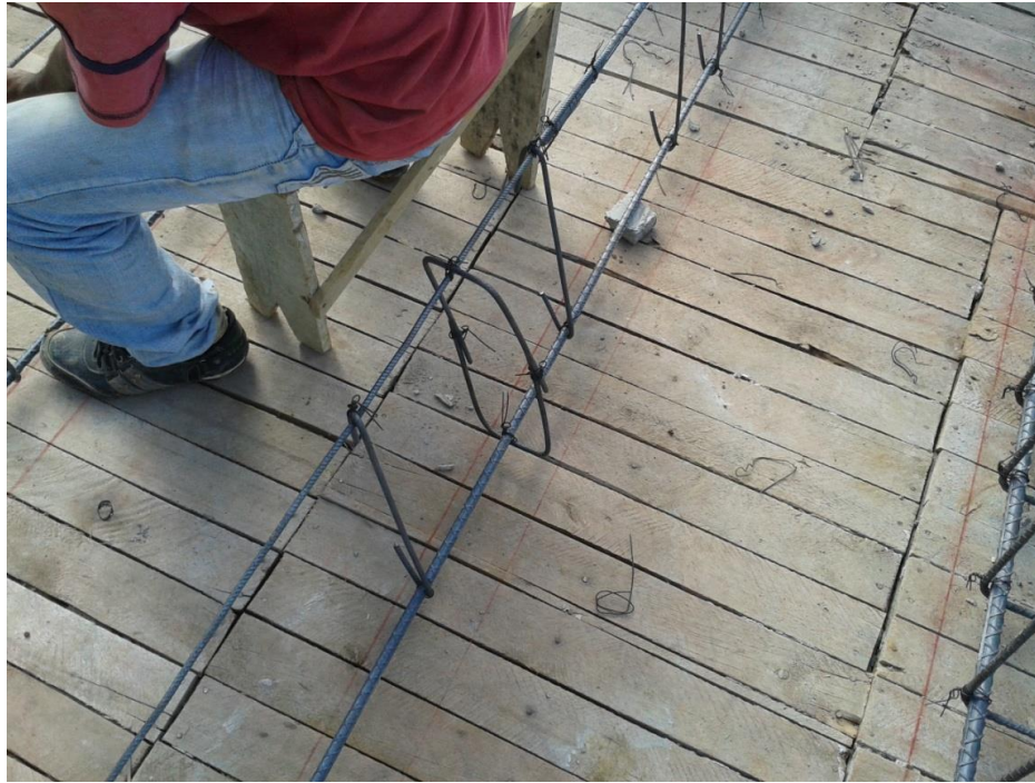
Figura No 15 Amarrado de refuerzo de nervios
