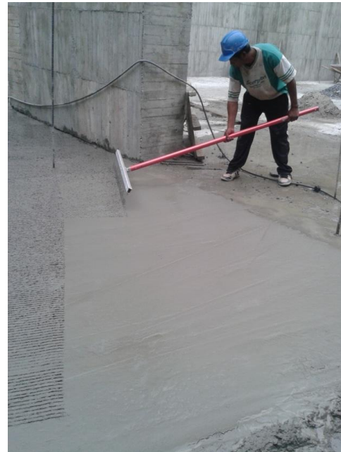
Figura No 23 Proceso de texturizado y curado del concreto
