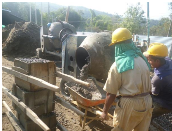
Figura No 8. Preparacion de concreto hecho en sitio
