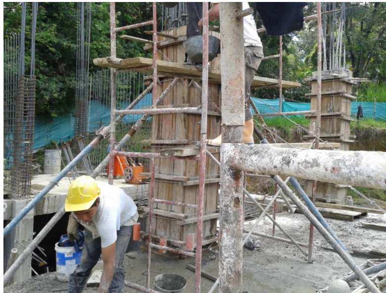
Figura No 9. Proceso de distribución del concreto
