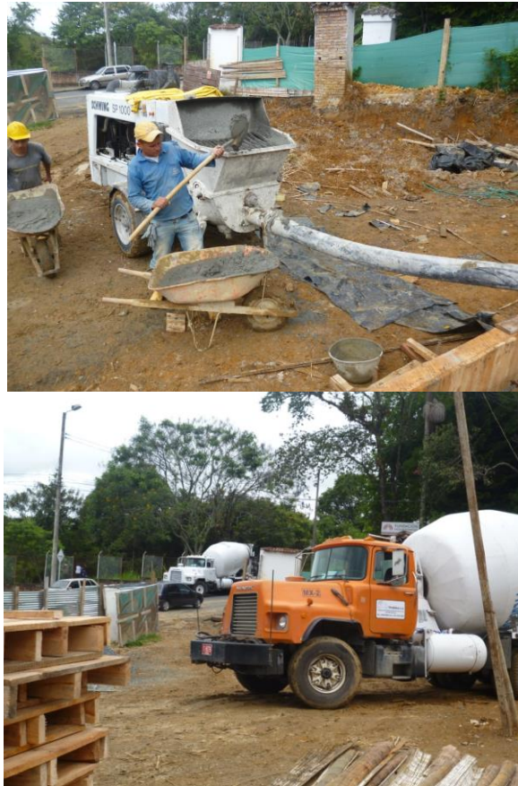
Figura No 21 Suministro de concreto premezclado por PREDELCA S.A.S
