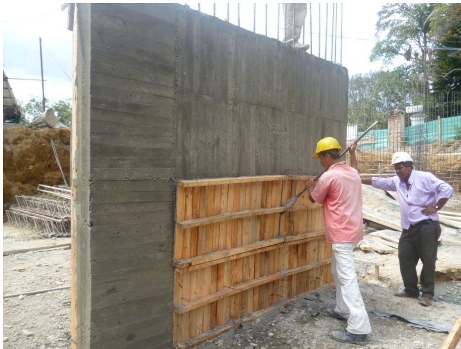
Figura No 10. Proceso de desencofrado
