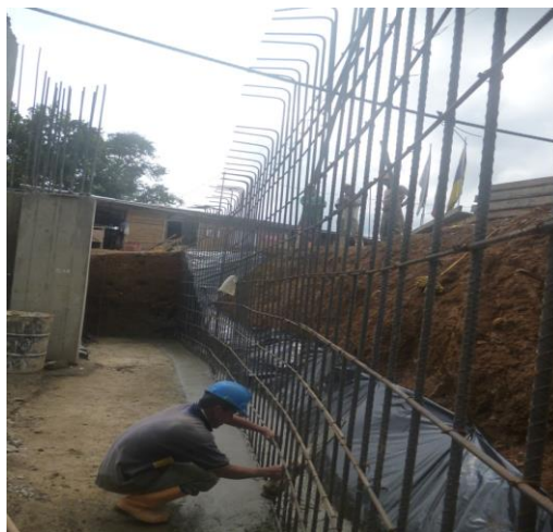
Figura No 5. Amarrado del refuerzo en elementos verticales
