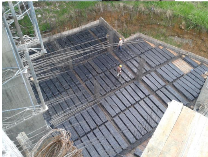
Figura No 16 Colocación de casetones de icopor
