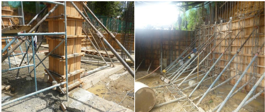
Figura No 6. Encofrado de elementos estructurales
