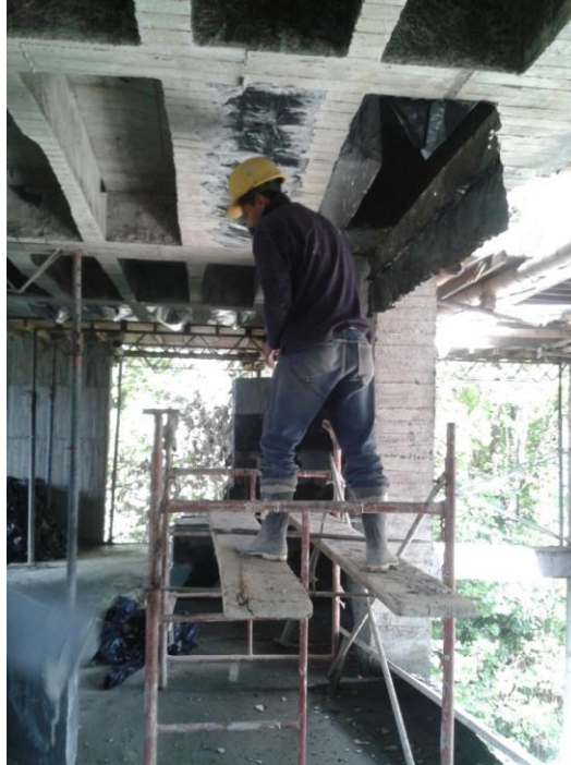
Figura No 26 Extracción de casetones de icopor
