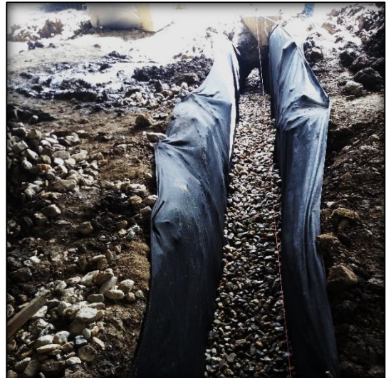
Imagen 8. Geotextil y Primera Capa de Material Filtrante.
