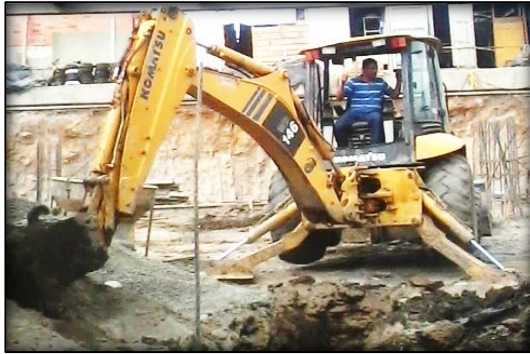
Imagen 62 Excavaciones (Filtros).
