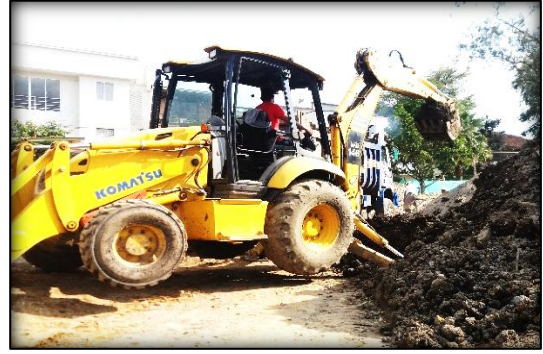
Imagen 63 Retiro de Materiales
