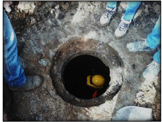
Imagen 47 Inspección de recamaras.
