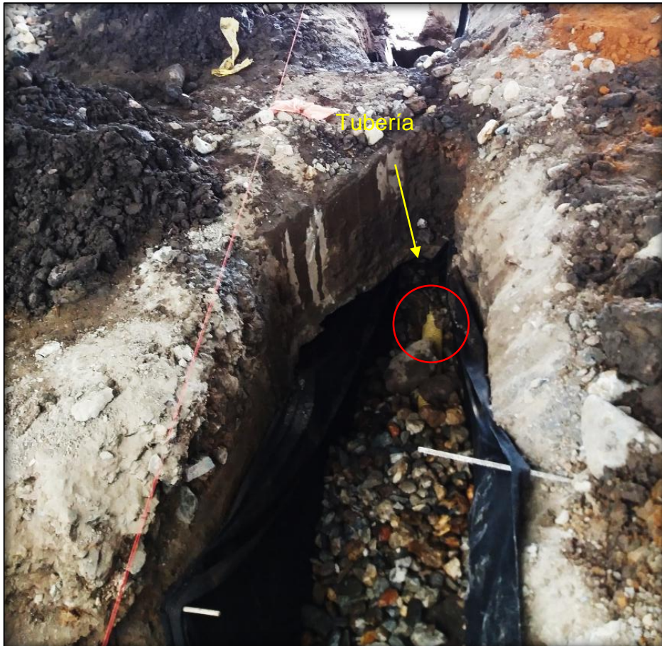
Imagen 9. Instalación de Tubería de Filtro y Material Filtrante
