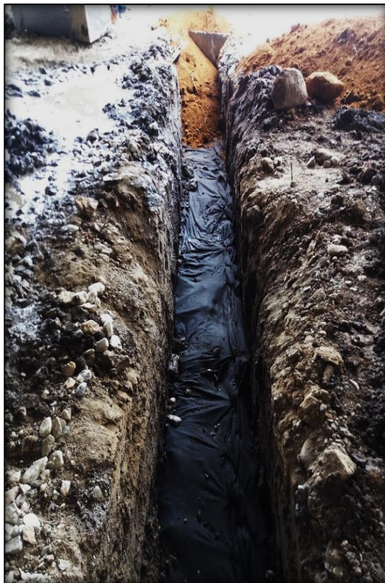
Imagen 10. Aseguramiento del Geotextil
