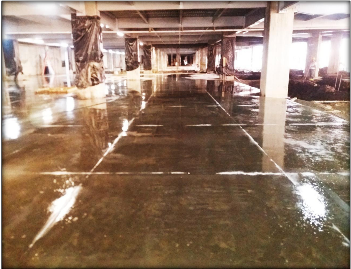
Imagen 38 PISO TERMINADO (Fundición por recuadro)
