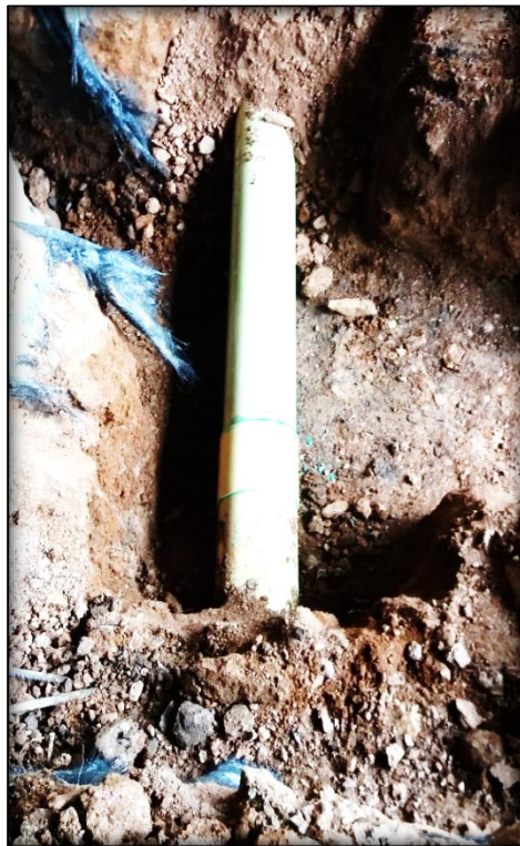
Imagen 19. Accesorios a la vista para la Prueba de Flujo.
