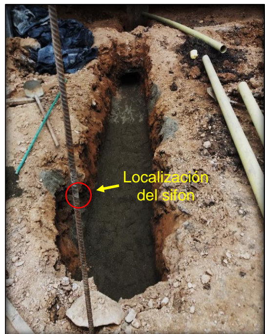
Imagen 16. Cama de Apoyo de Arena.
