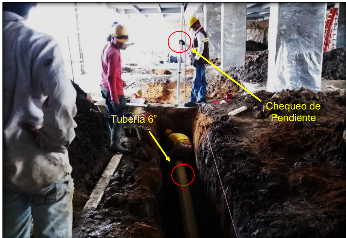
Imagen 17. Instalación de Tubería de Desagüe y Control de Niveles.
