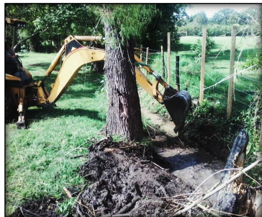
Imagen 52 Limpieza del sitio de descarga
