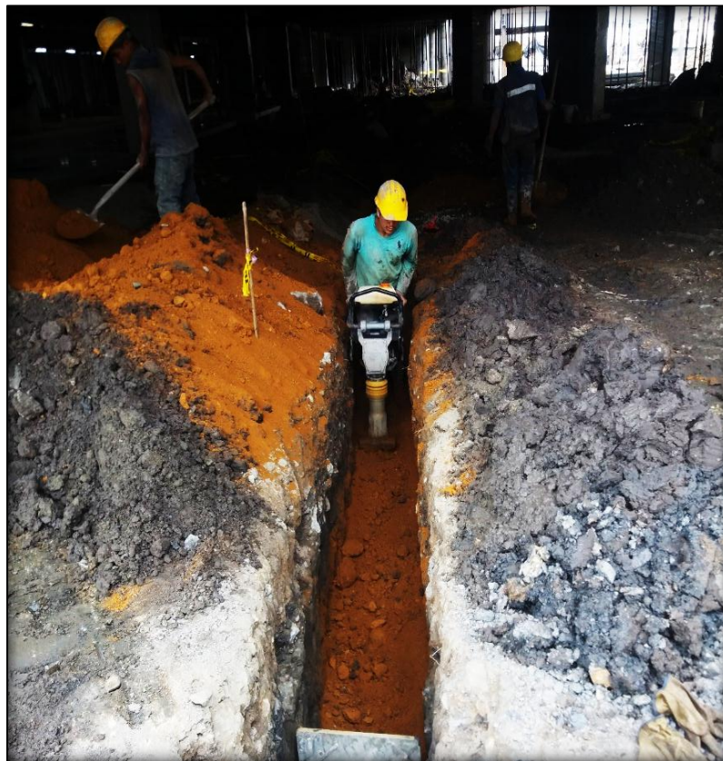
Imagen 18. Relleno y Compactación con Material Selecto.
