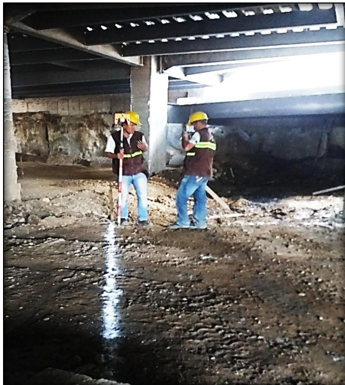
Imagen 13 Localización y Replanteo.
