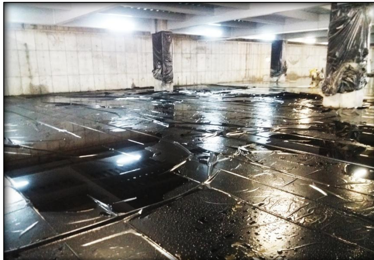
Imagen 35 Curado del Concreto
