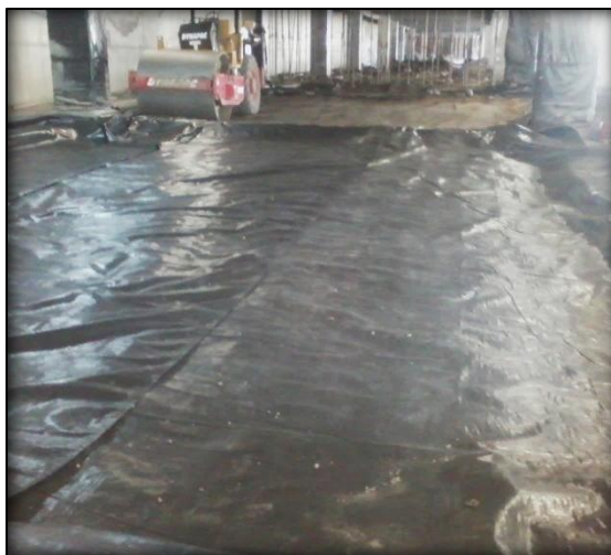
Imagen 24. Instalación del Geotextil.
