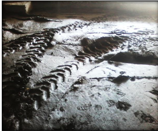
Imagen 43 Resultado de Compactar un Suelo Sobresaturado.
