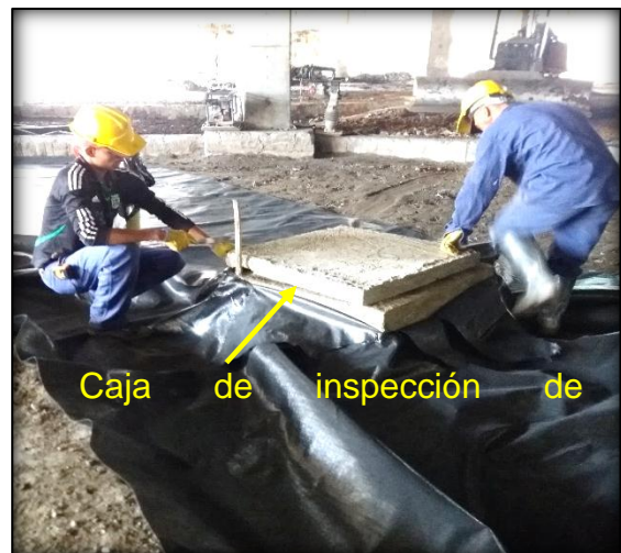
Imagen 25. Instalación del Geotextil
