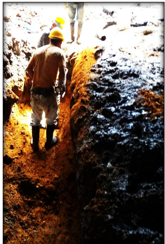
Imagen 11. Relleno de Protección del Filtro y Compactación.
