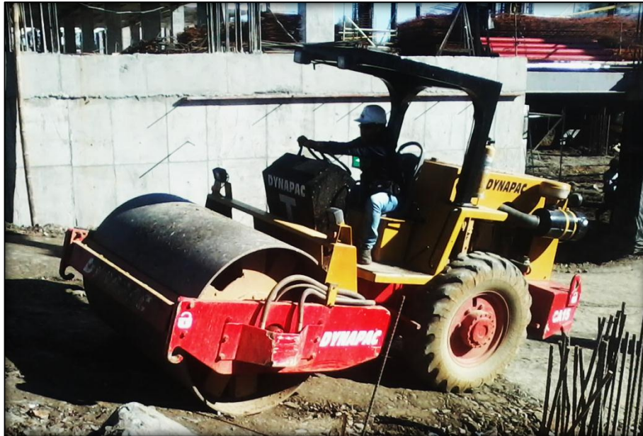
Imagen 65 Rampa de Acceso a Sótano (compactación)
