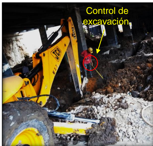
Imagen 5. Excavación Mecánica
