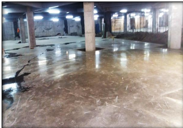
Imagen 34 Pavimento Pulido con Allanadora Mecánica
