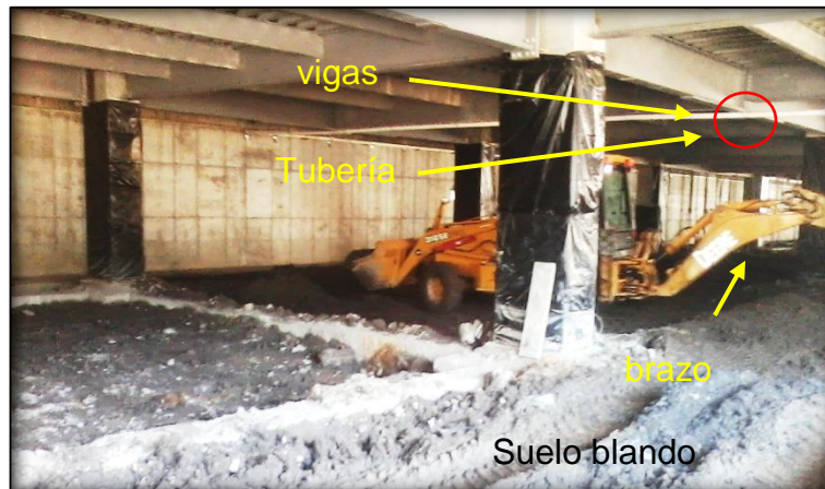
Imagen 66 Bajo Rendimiento (Retroexcavadora)
