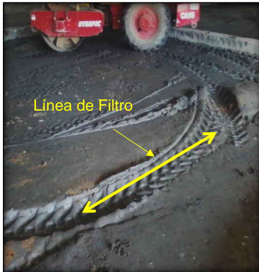
Imagen 22. Compactación deficiente.
