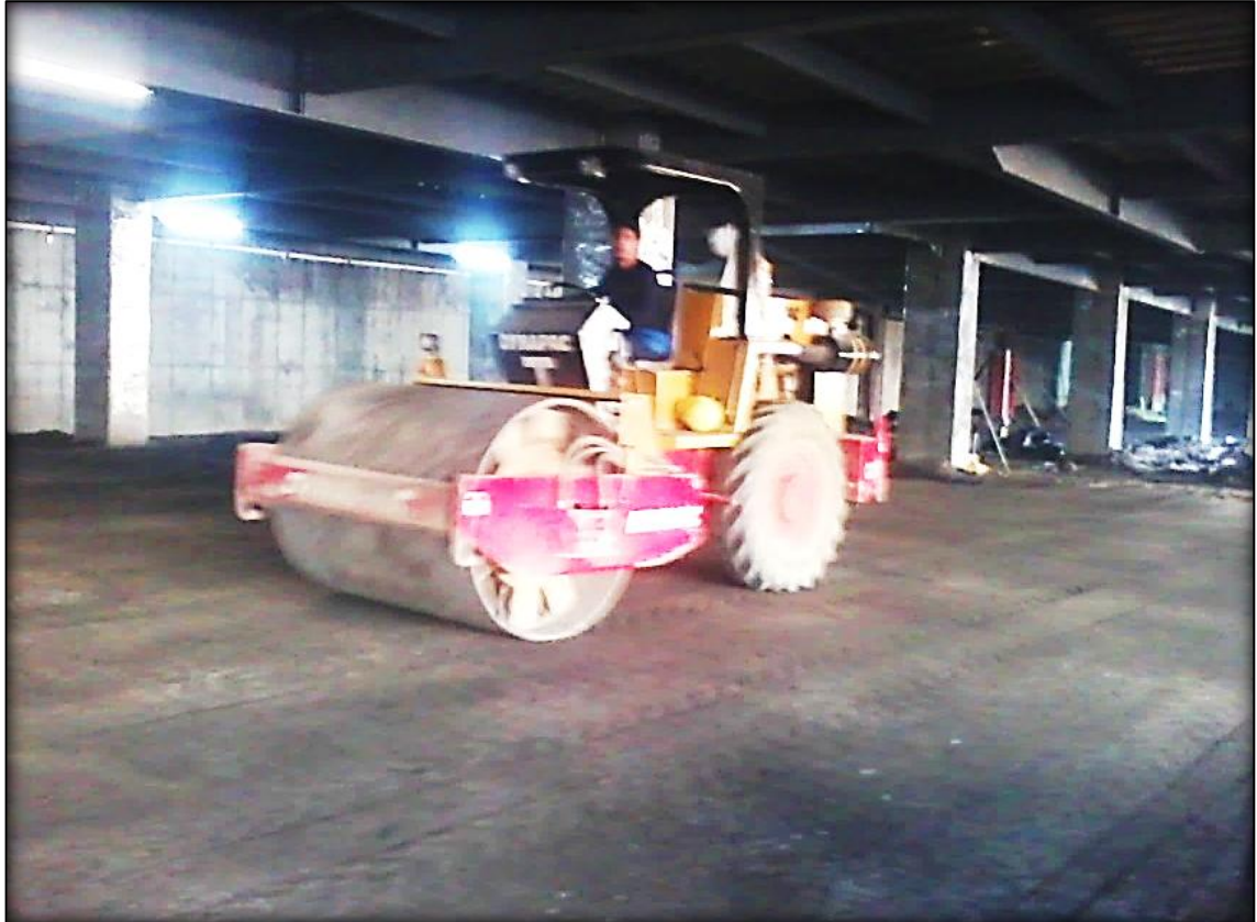
Imagen 28 Compactación de la Sub-Base.
