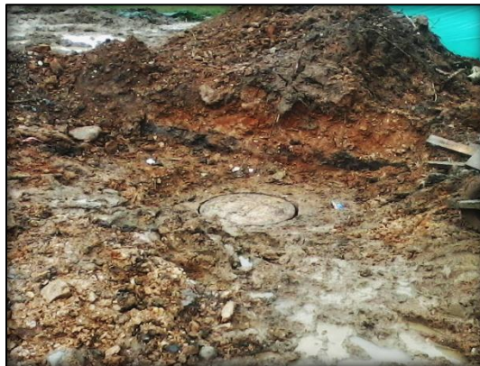
Imagen 46 Cámara de Inspección
