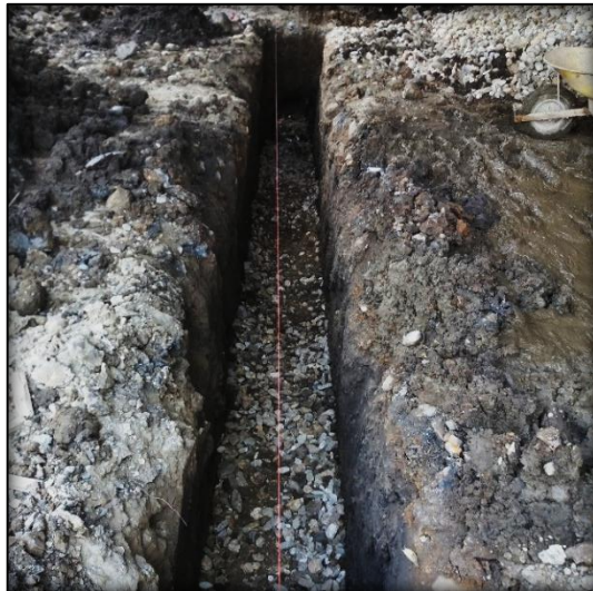
Imagen 7. Refine y Nivelación de la Excavación para Filtro.
