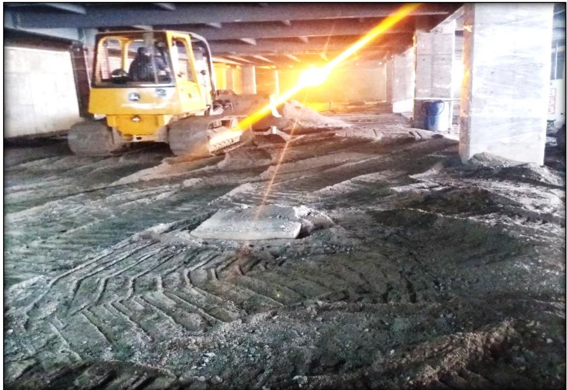
Imagen 27 Distribución del Material Granular de Sub-Base
