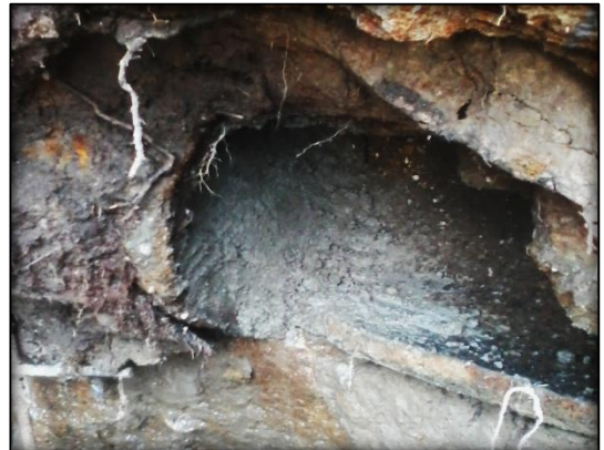
Imagen 48 Taponamiento de la Tubería
