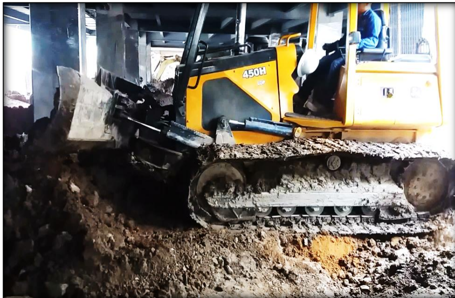
Imagen 64 Excavación (Módulos-sótano)
