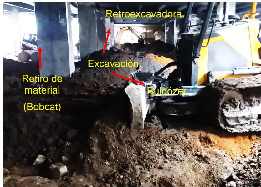
Imagen 67 Maquinaria para Movimiento de Tierra.
