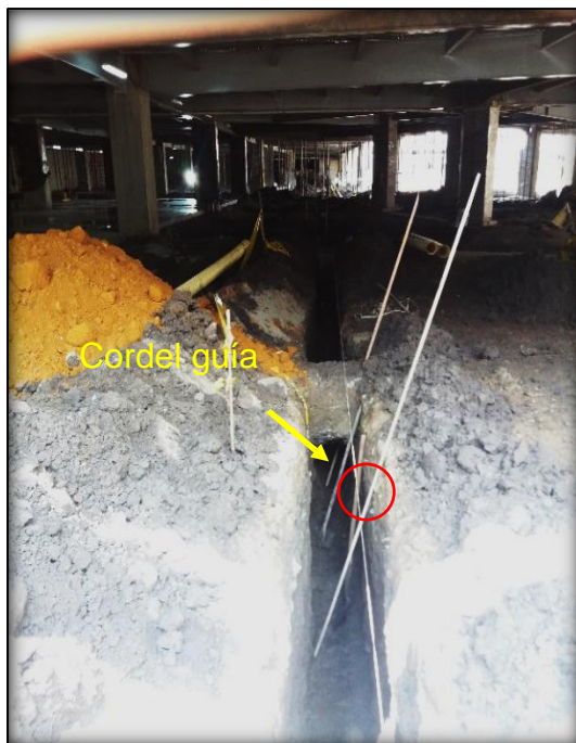
Imagen 15 Refine de la Excavación.
