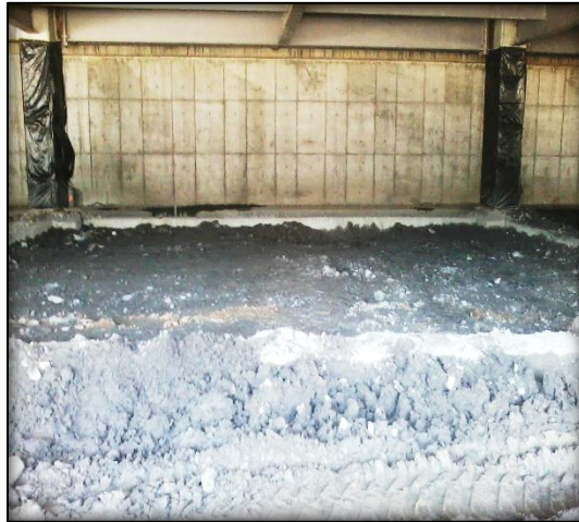
Imagen 39 Modulo Listo para Compactar
