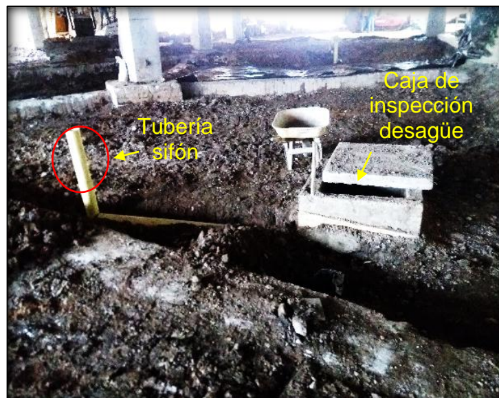
Imagen 12. Instalación de Sifones.
