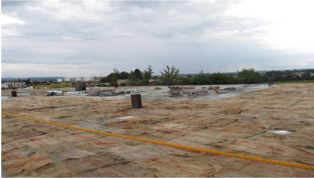
Figura N° 53. Curado de la losa por inundación cubierta con fique para mantener la humedad (Fuente: propia).
