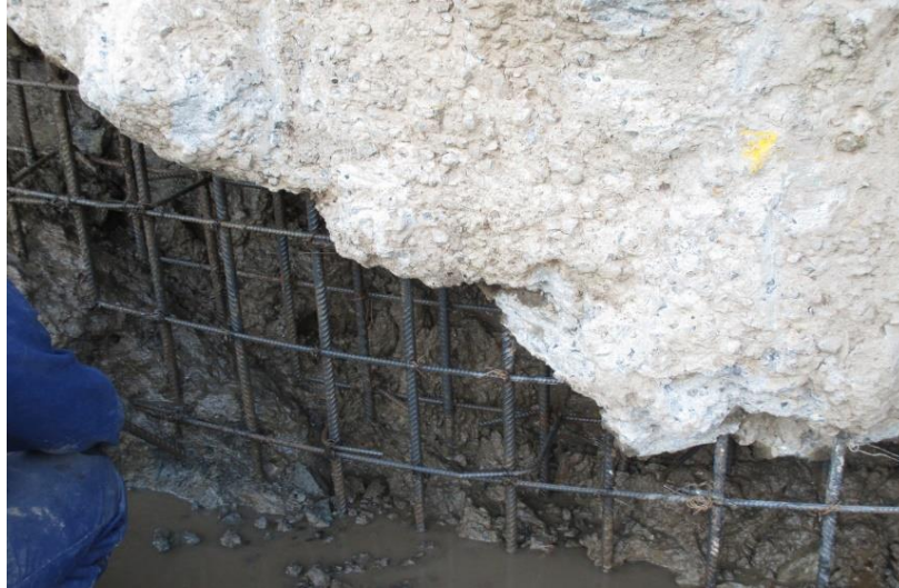
Figura N° 39. Exposición del refuerzo en las pantallas pre-excavadas (Fuente: Interventoría).
