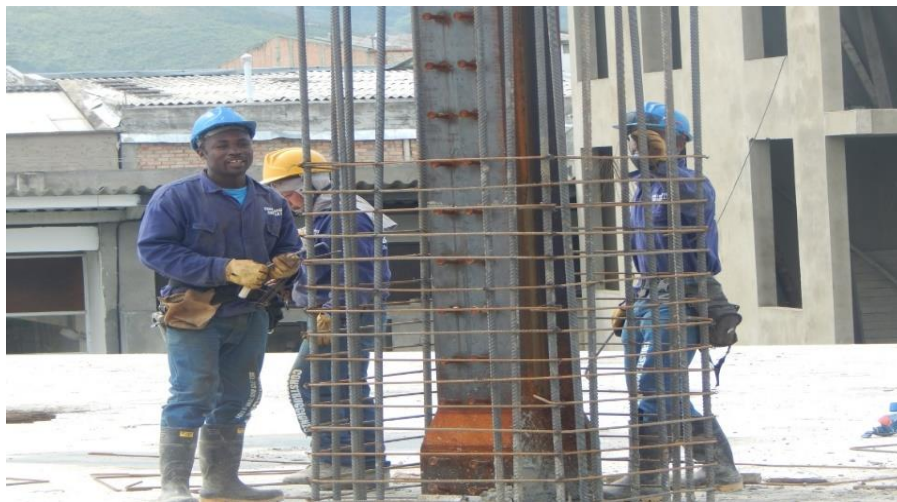
Figura N° 49. Personal armando el refuerzo de la columna (Fuente: propia).
