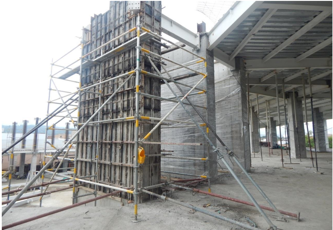
Figura N° 10. Pantalla formaleteada lista para ser fundida. (Fuente: propia).
