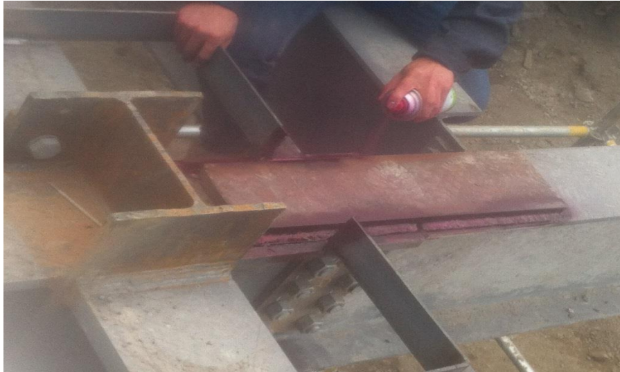
Figura N° 23. Aplicación de la tinta violeta sobre la soldadura (Fuente: propia).
