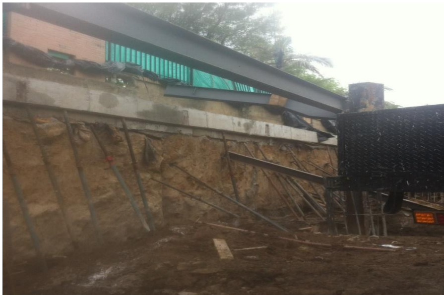
Figura N° 58. Apuntalamiento de la pantalla (Fuente: propia).
