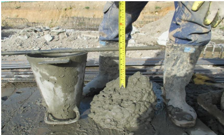
Figura N° 38. Asentamiento concreto usado en pantallas y barretes (Fuente: Interventoría).
