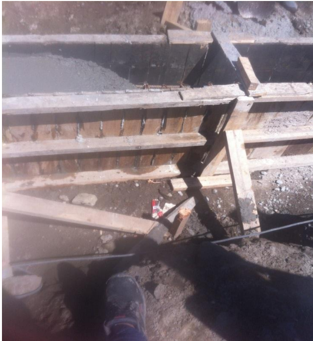
Figura N° 48. Formaleta en madera de un tramo de viga de amarre (Fuente: propia).
