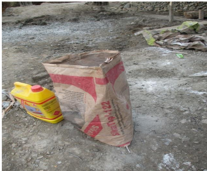
Figura N° 51. Saco de sika top 122 usado para realizar resanes en las columnas combinadas (Fuente: Interventoría).
