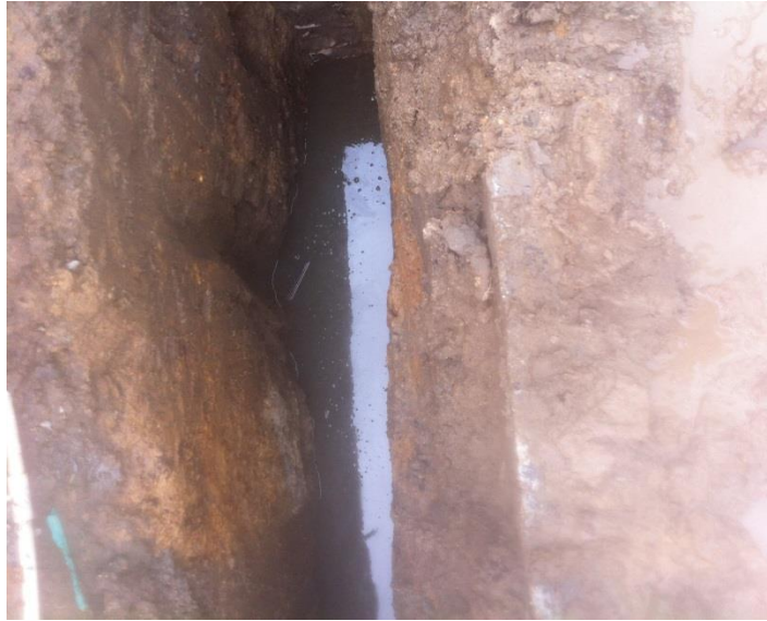
Figura N° 33. Excavación para pantallas y barretes. Se observa el nivel que alcanzan las aguas freáticas en la zona (Fuente: propia).
