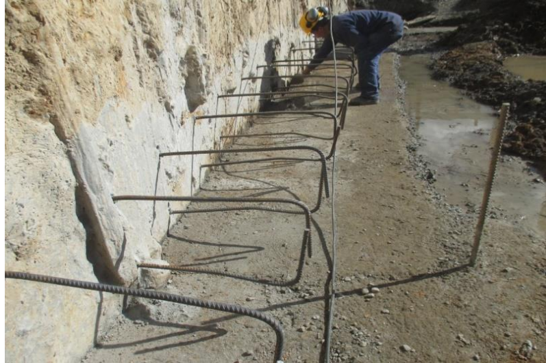
Figura N° 40. Anclajes de Viga cinturón (Fuente: Interventoría).
