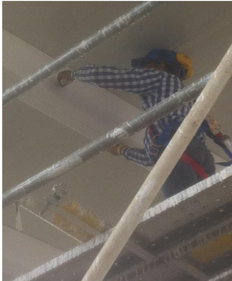
Figura N° 28. Prueba de espesores de pintura en los elementos metálicos (Fuente: propia).
