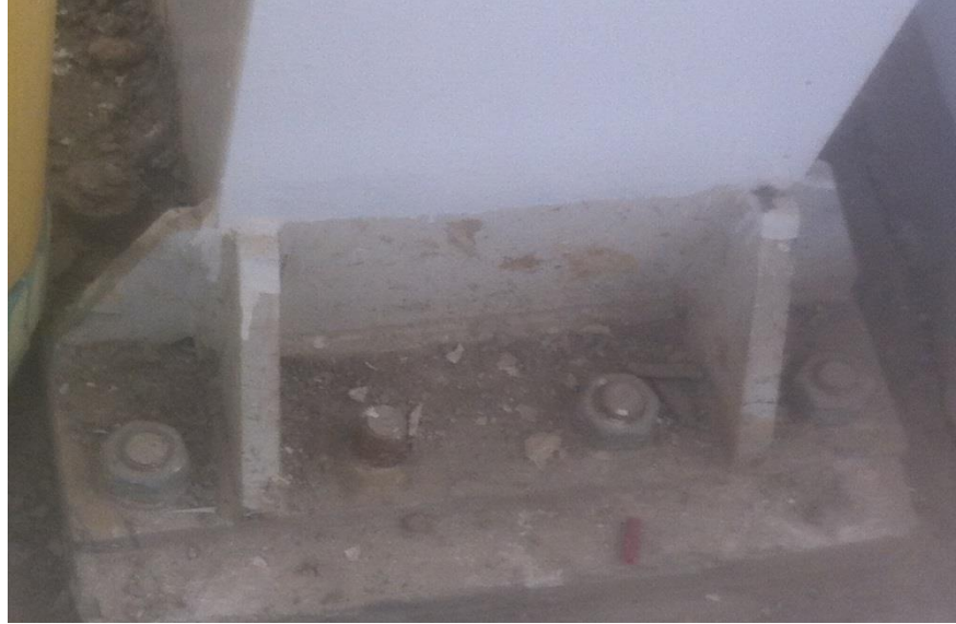
Figura N° 22. Pata de columna metálica sobre base en Sika grout (Fuente: propia).
