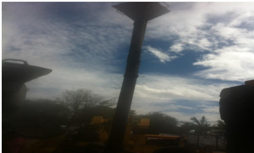
Figura N° 35. Embudo Tremie conectado a la tubería con profundidad igual a la de la excavación (Fuente: propia).
