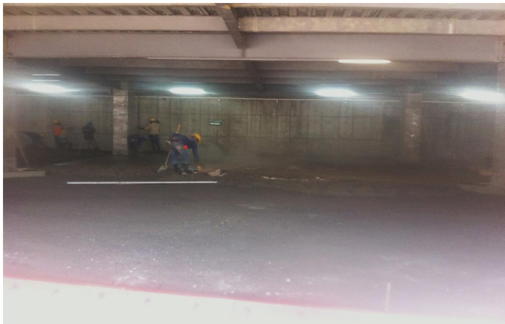
Figura N° 55. Fundición de la losa del pavimento rígido en sótano (Fuente: propia).
