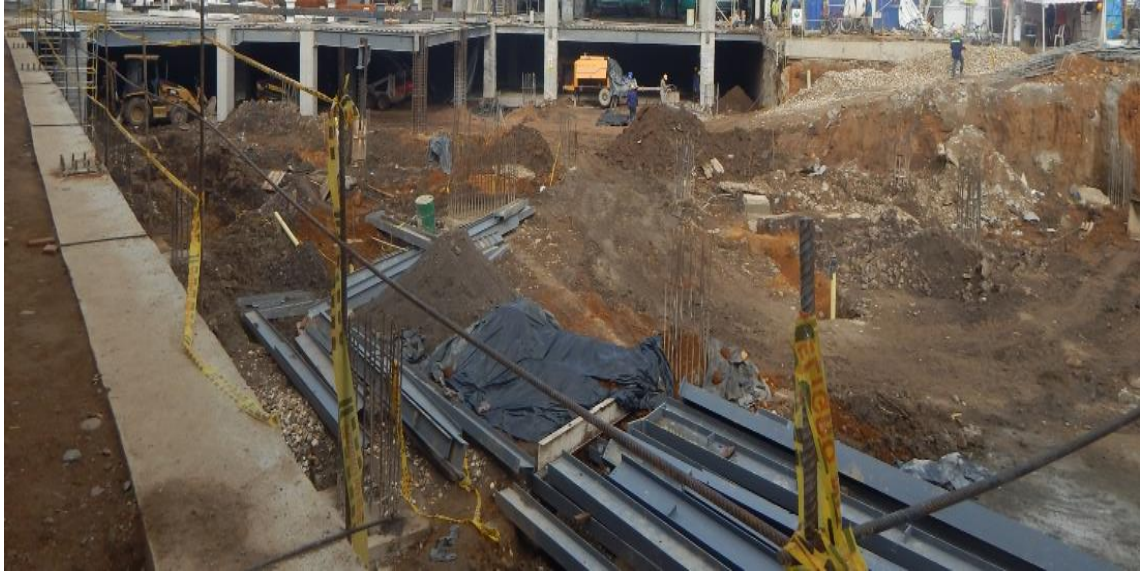
Figura N° 45. En la imagen se puede apreciar la viga corona y los anclajes que sobresalen. En la excavación se ven las barras donde se ubicarán las columnas metálicas (Fuente: propia).
