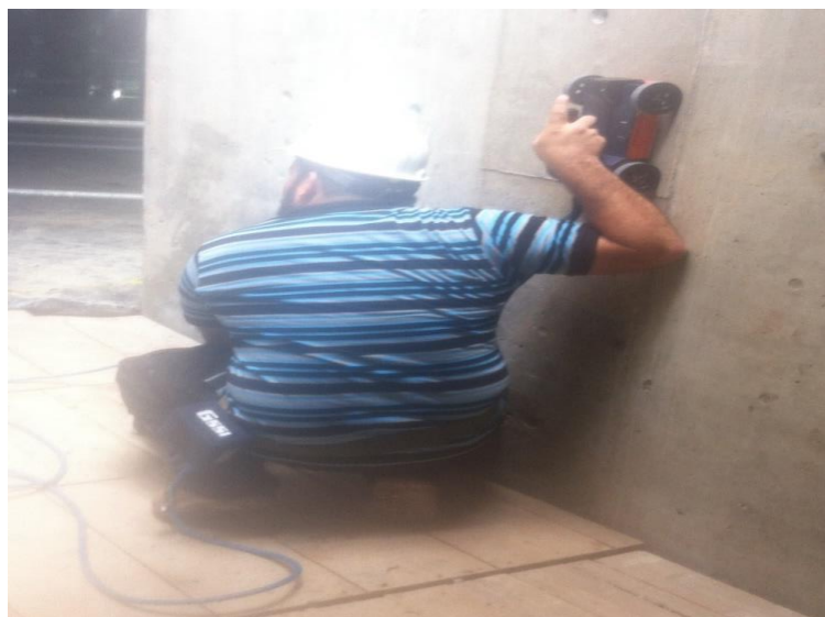
Figura N° 16. Operario usando el radar para marcar la zona de la toma de núcleos (Fuente: propia).
