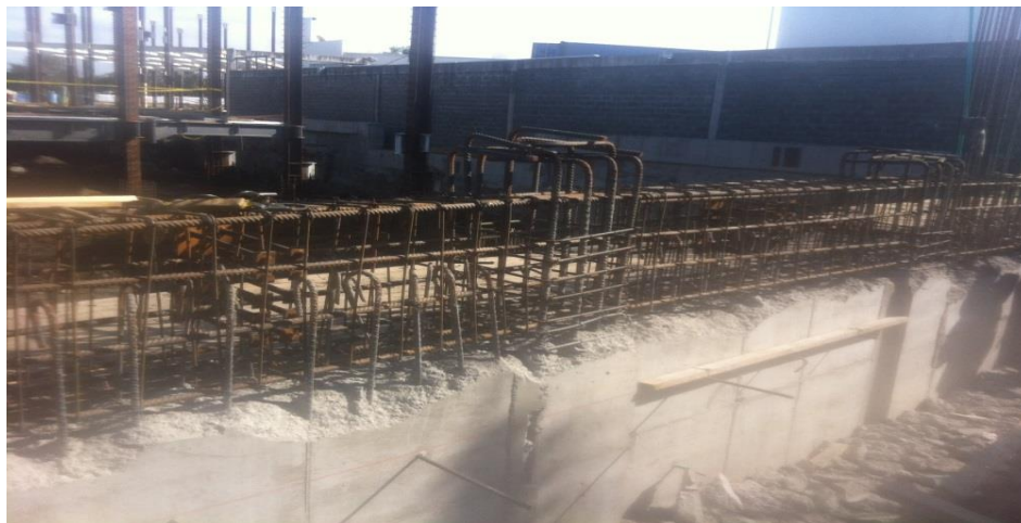
Figura N° 42. Refuerzo de un tramo de viga corona (Fuente: propia).
