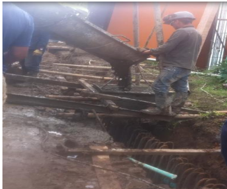
Figura N° 37. Fundición de una pantalla (Fuente: propia).
