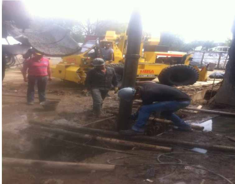
Figura N° 36. Personal ubicando la tubería dentro de la excavación (Fuente: propia).
