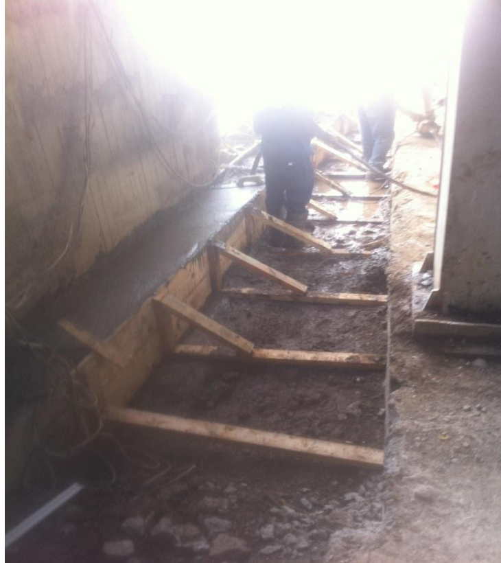
Figura N° 41. Fundición tramo de viga cinturón (Fuente: propia).
