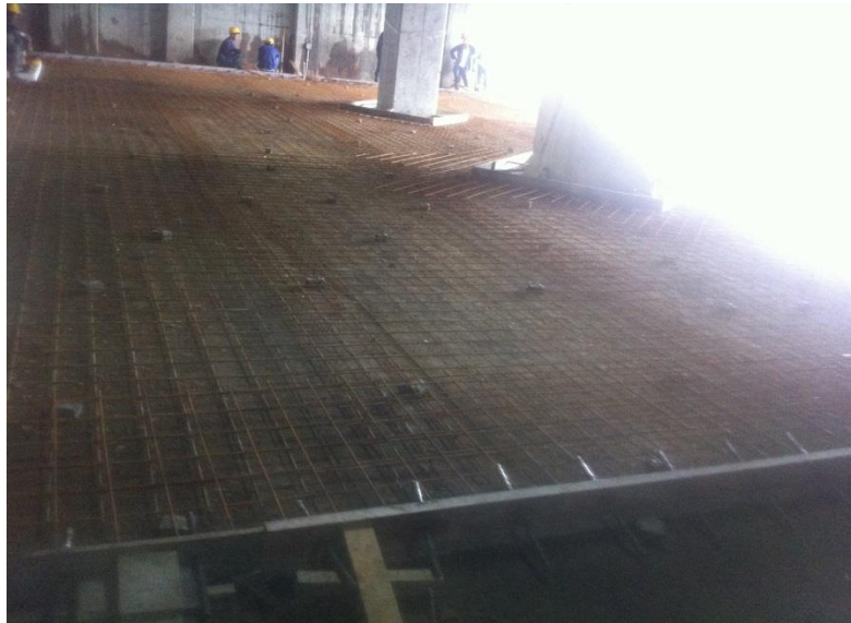
Figura N° 56. Área del sótano lista para fundir (Fuente: propia).
