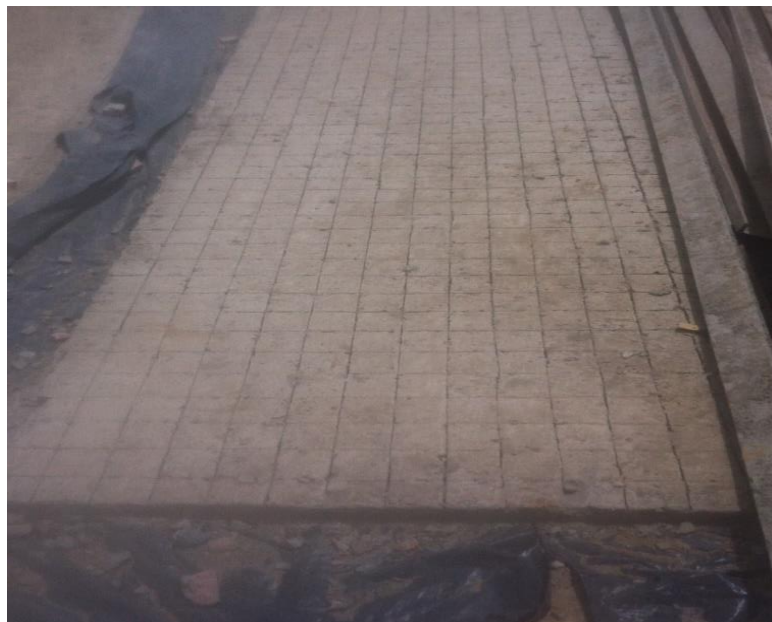
Figura N° 9. Separadores hechos con mortero para garantizar recubrimientos (Fuente: propia).
