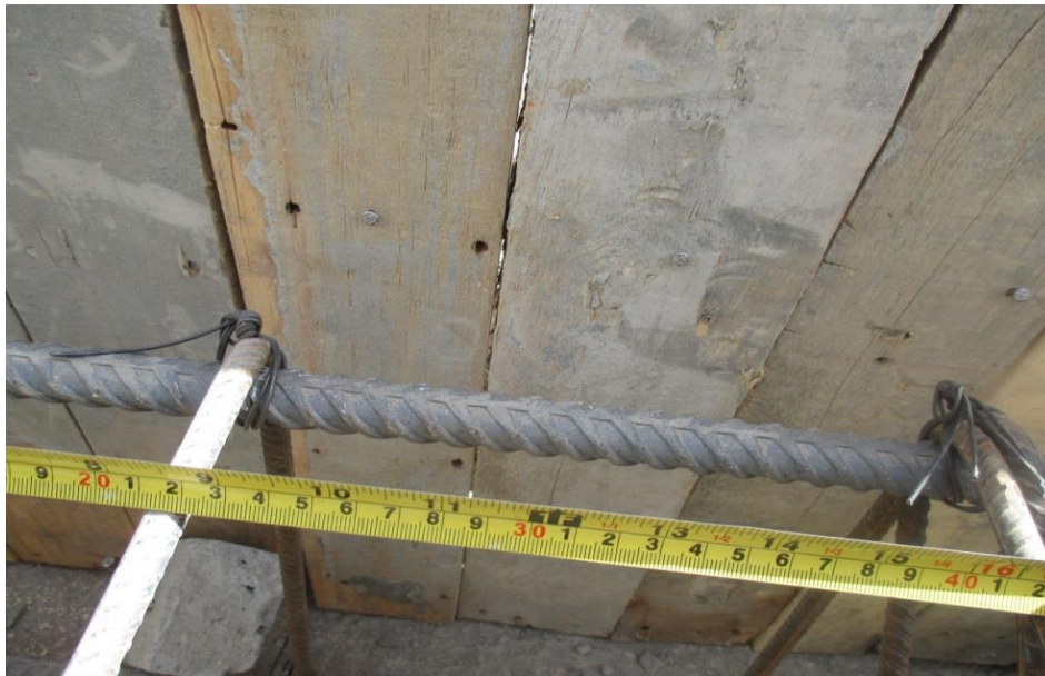
Figura N° 43. Medición de la separación entre estribos de un tramo de viga corona (Fuente: Interventoría).
