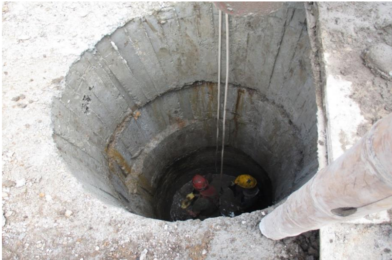
Figura N° 46. Excavación manual de caisson.
