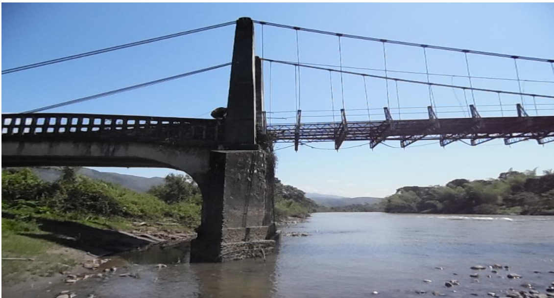
Figura No. 8 Registro fotográfico Puente
