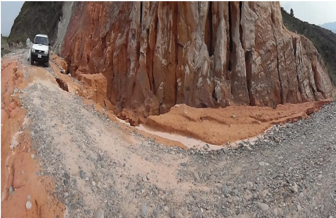
Figura No. 7 Registro fotográfico aspecto geotécnico
