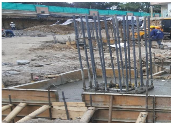
Fig. N°41. Acabado después de la fundición.
