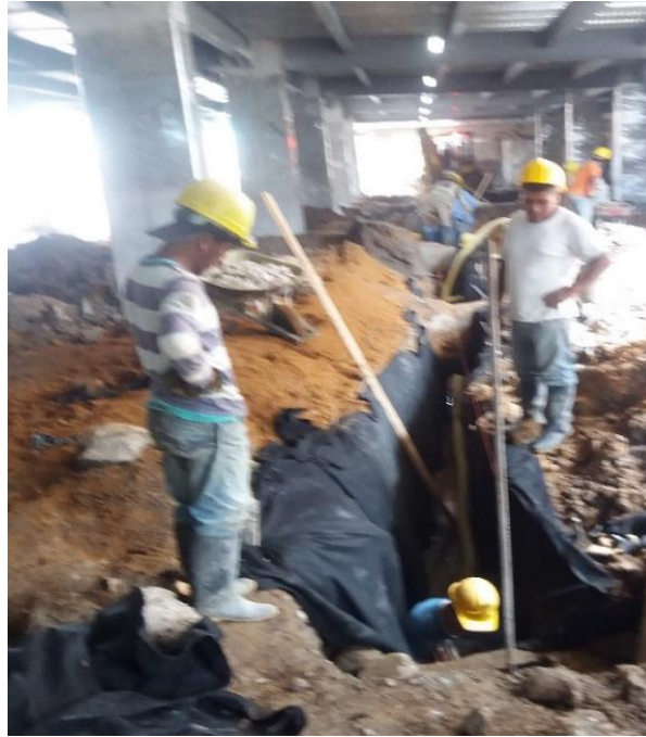
Fig. N°19 Geotextil drenante no tejido instalado.
