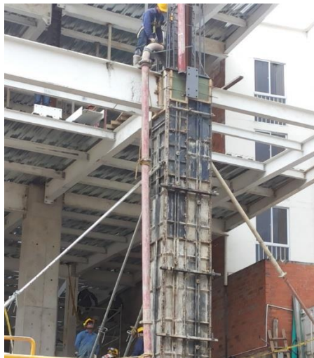
Fig. N°48. Fundición de columna.
