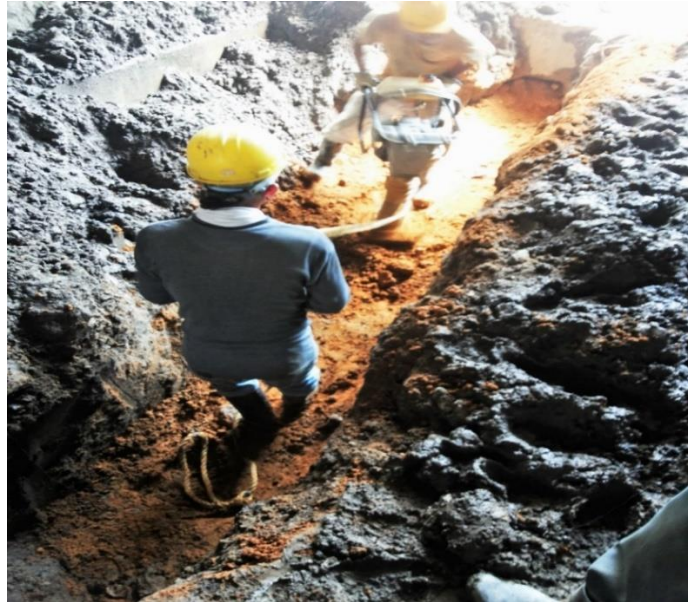
Fig. N°24 Compactación con saltarín.
