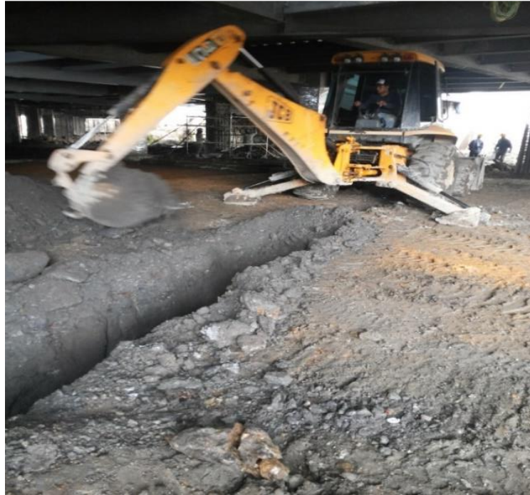
Fig. N°16. Retroexcavadora realizando labores de excavación de filtros.
