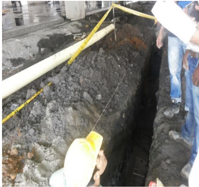
Fig. N°17. Utilización de hilo para la perfilar.
