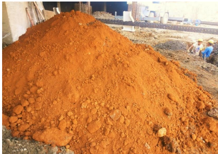
Fig. N°23 Tierra amarilla utilizada para la compactación.
