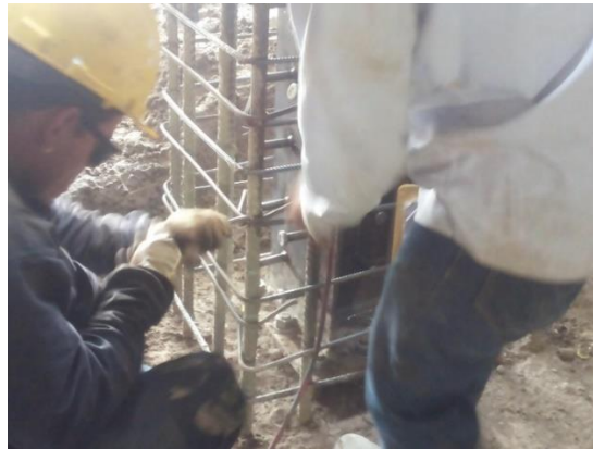
Fig. N°44. Armado del refuerzo para la columna.
