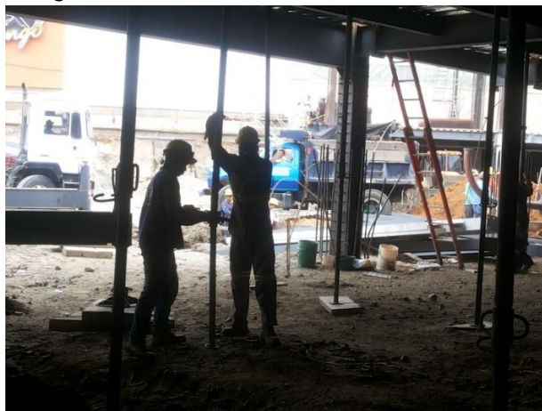
Fig. N°55. Colocación de gatos.
