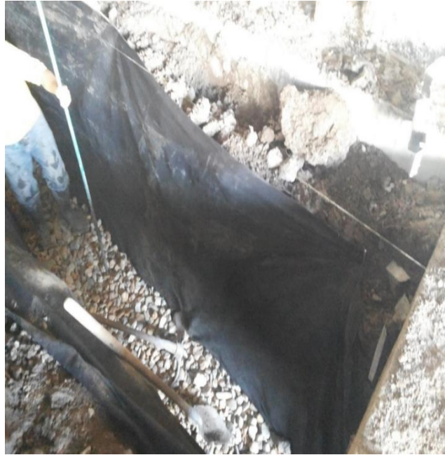
Fig. N°21. Colocación del material de filtro en la zanja.
