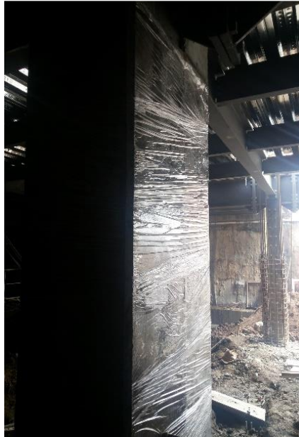
Fig. N°49. Columnas en proceso de curado.
