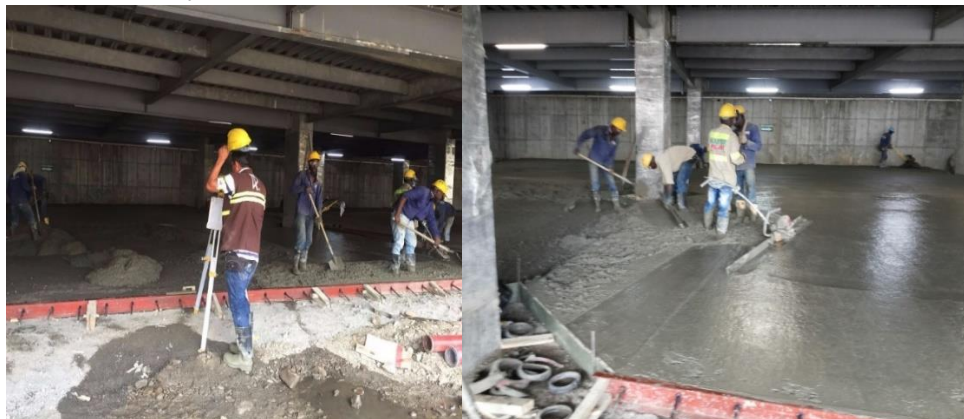
Fig. N°74. Suministro y nivelación del concreto.
