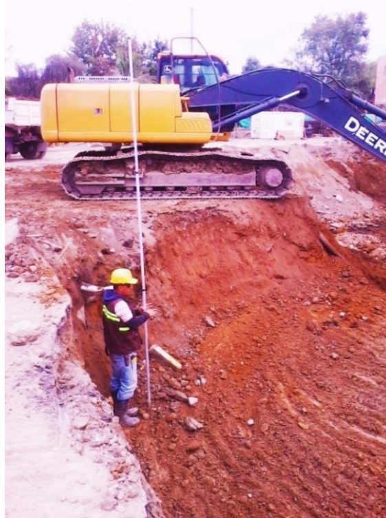
Fig. N°28. Excavadora removiendo material.
