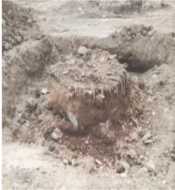
Fig. N°33. Pilote listo para descabezar.
