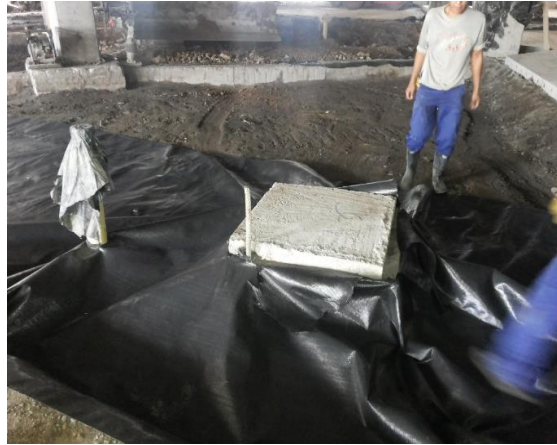
Fig. N°63. Colocación del geotextil.
