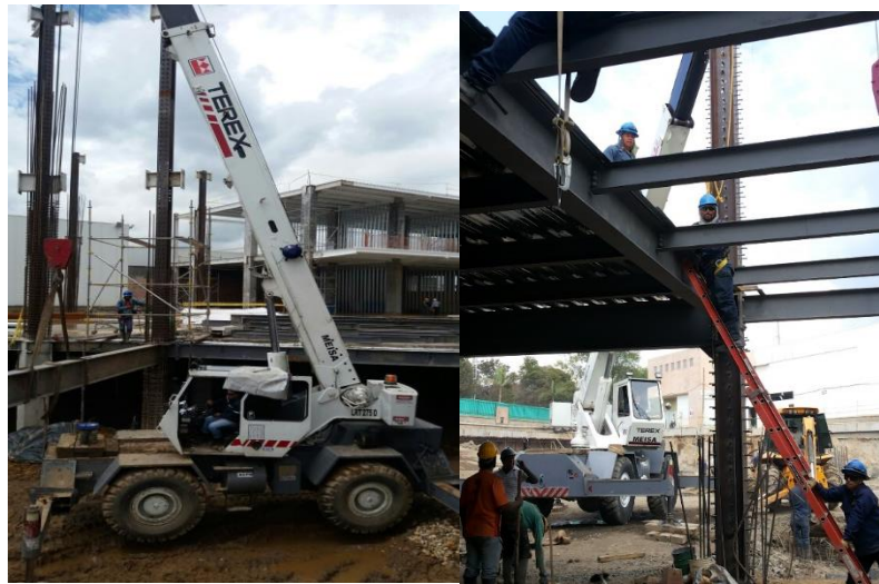
Fig. N°51. Montaje de estructura.
