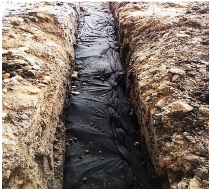
Fig. N°22 Conjunto de filtro cocido y listo para compactar.
