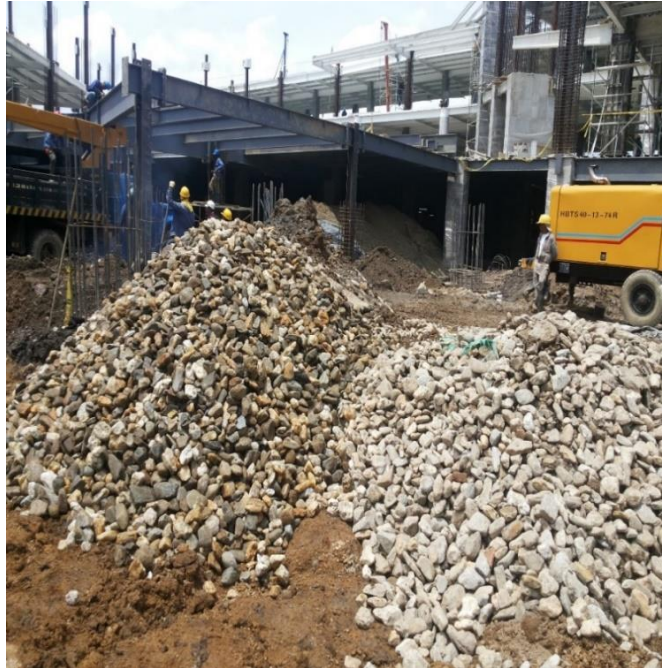
Fig. N°20. Material para filtro.
