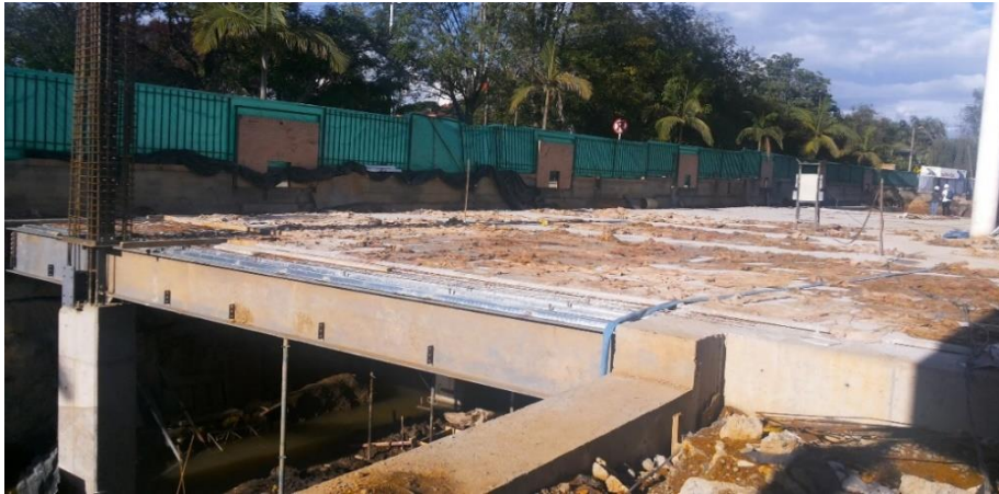
Fig. N°57. Curado de la losa con fique húmedo.
