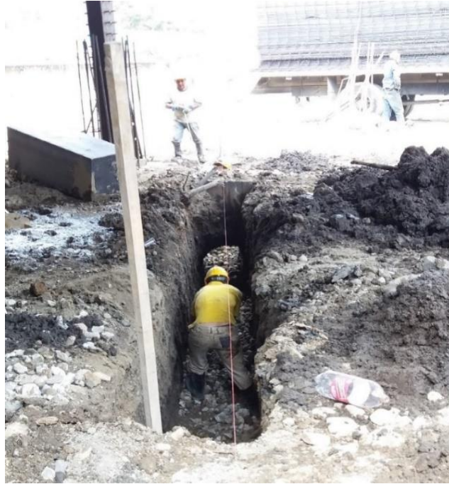
Fig. N°18. Colocación de cama de piedra sucia.
