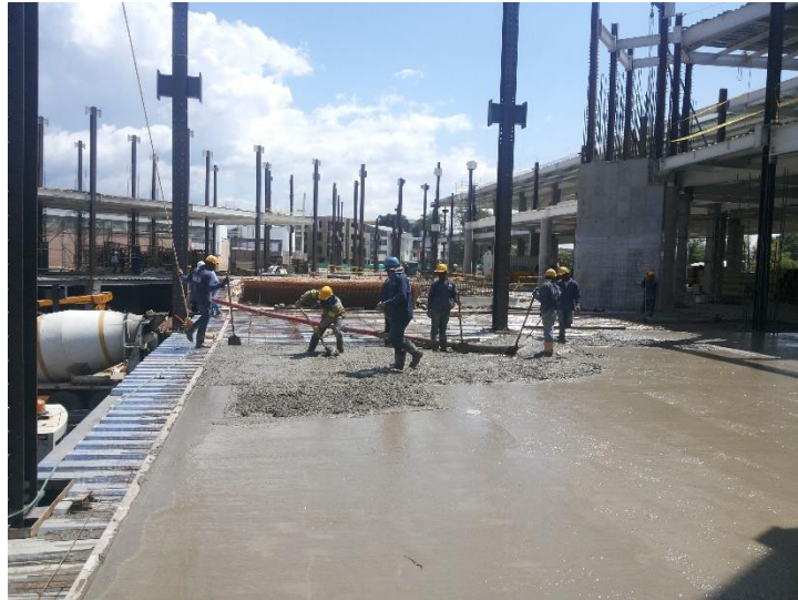
Fig. N°56. Fundición de la losa.
