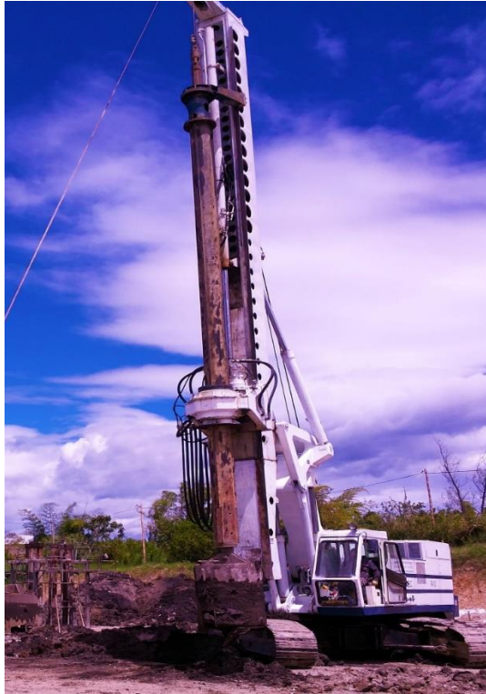
Fig. N°29. Piloteadora R12 SOILMEC excavando.
