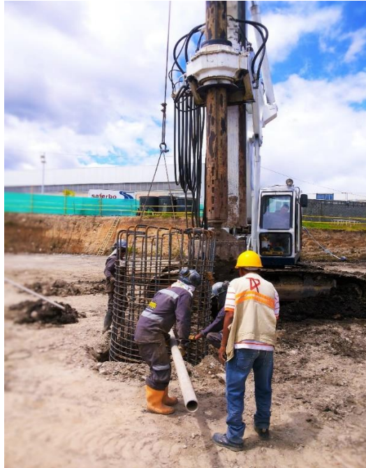
Fig. N°32. Colocación de refuerzo pilotes.
