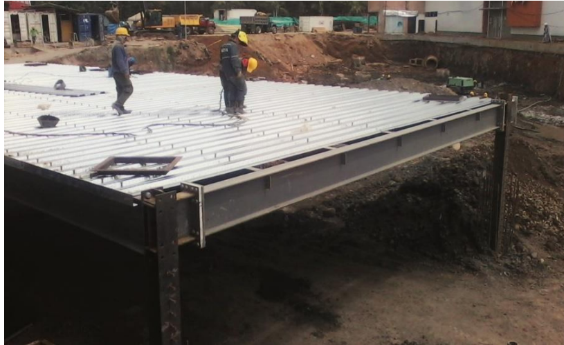
Fig. N°53. Colocación de la lámina y conectores de cortante en las vigas.
