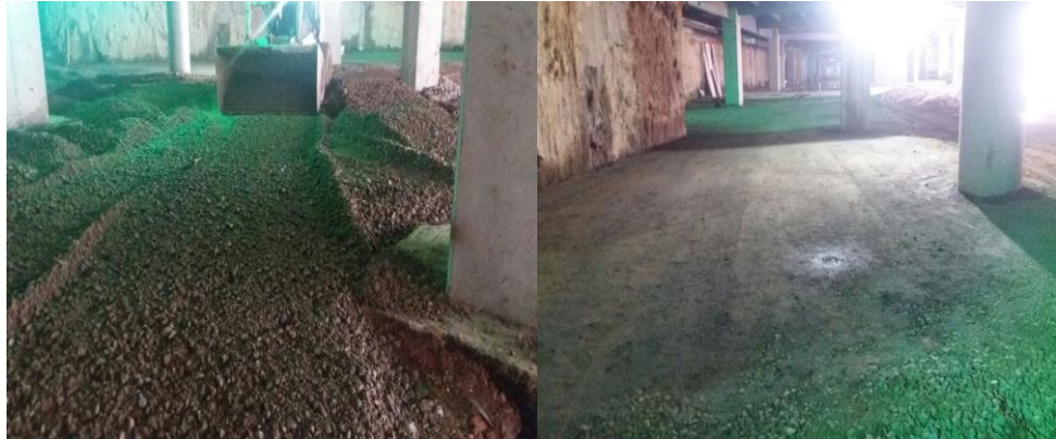
Fig. N°66. Regado de material de subbase y modulo compactado.
