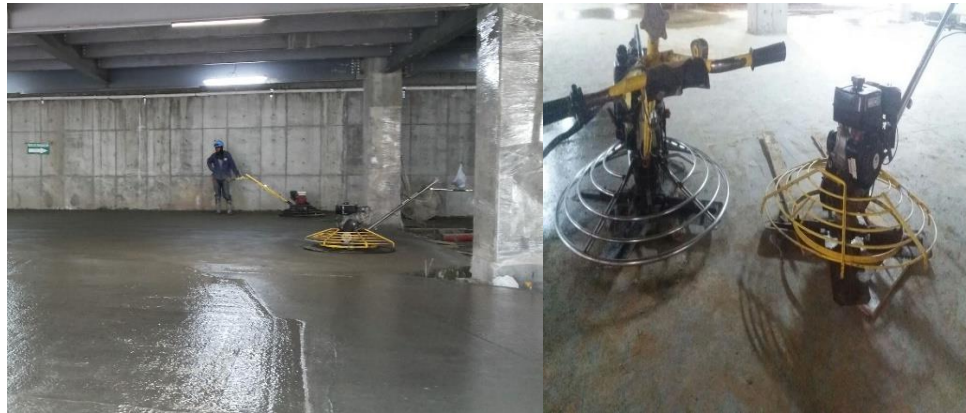
Fig. N°75. Allanado del concreto.
