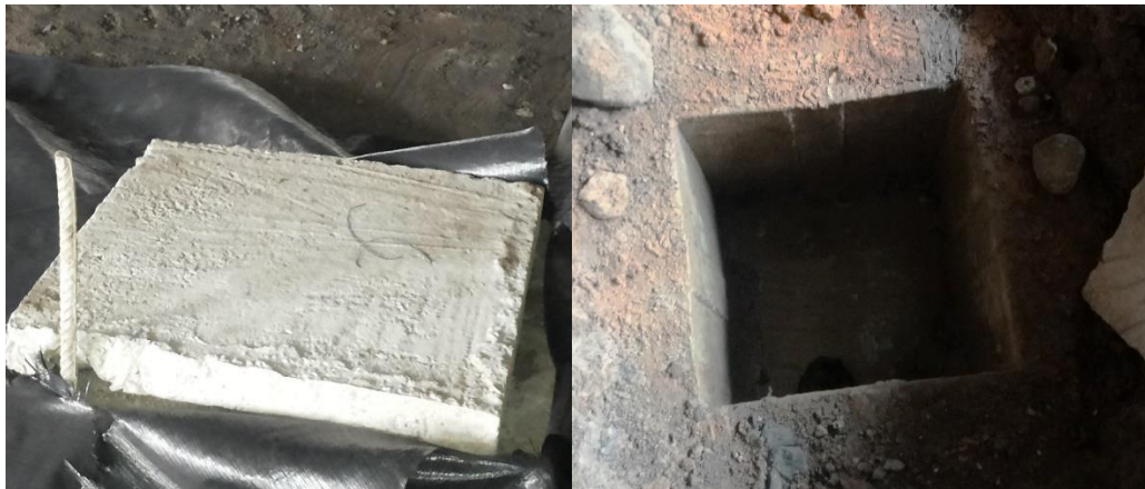
Fig. N°26. Cajas de inspección.
