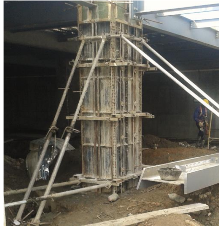
Fig. N°47. Formaleta armada y lista para fundición.
