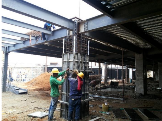
Fig. N°46. Colocación de la formaleta.
