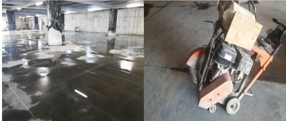
Fig. N°76. Ejecución de juntas de dilatación y curado de la losa.
