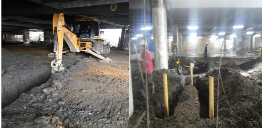
Fig. N°60. Excavación para drenajes y sifones.
