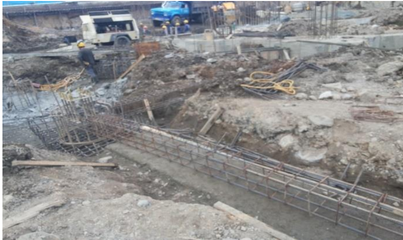
Fig. N°38. Armado de refuerzo dados y vigas de cimentación.
