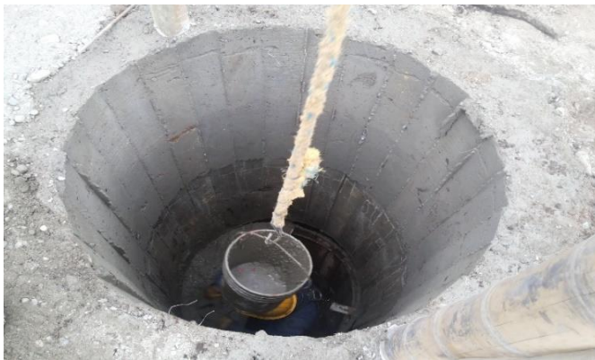
Fig. N°35 Avance de construcción de pozos indios.
