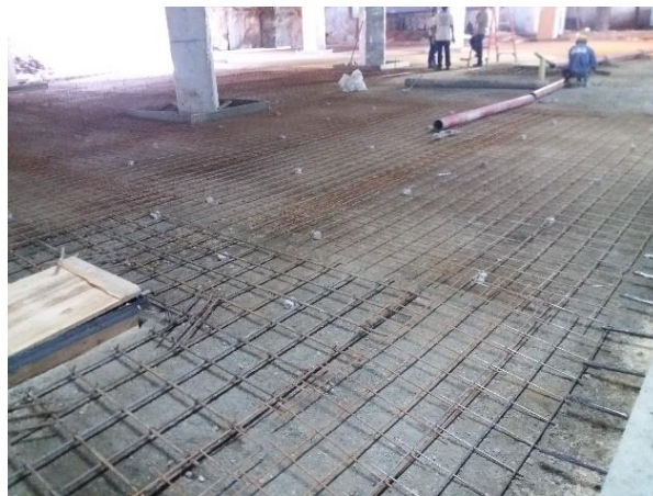
Fig. N°72. Malla electro soldada en módulos.
