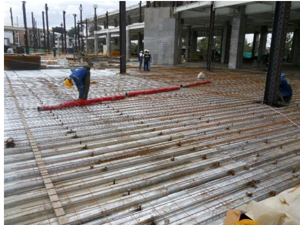
Fig. N°54. Malla electro soldada instalada.
