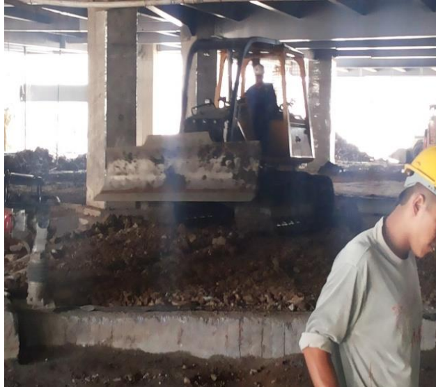
Fig. N°65. Esparcimiento del material de mejoramiento.
