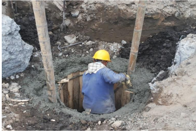
Fig. N°34. Construcción de pozos indios de cimentación.
