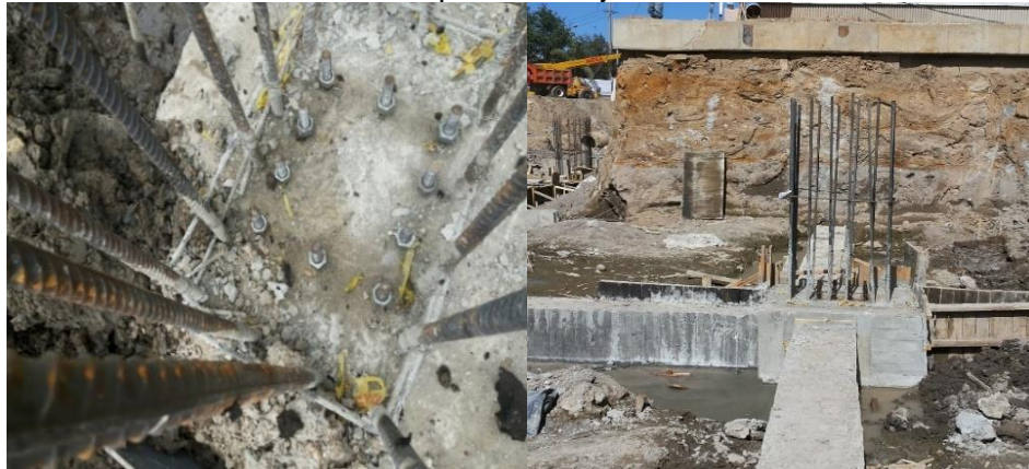
Fig. N°43. Dados de cimentación listos para montaje de columna metálica.
