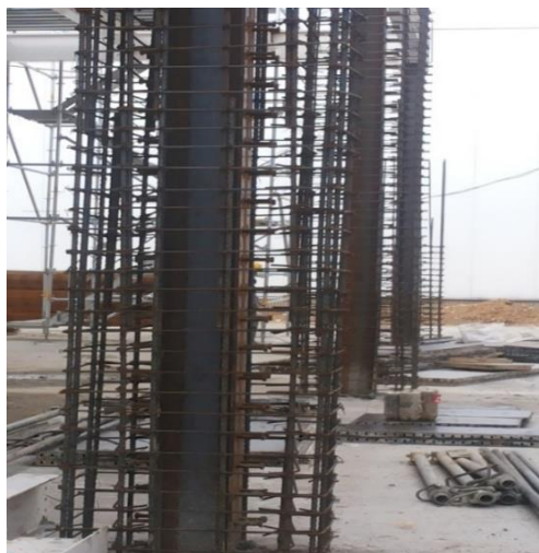
Fig. N°45. Armado del refuerzo para la columna terminado.
