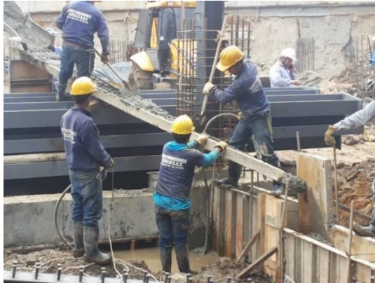
Fig. N°39. Vaciado del concreto en la formaleta.
