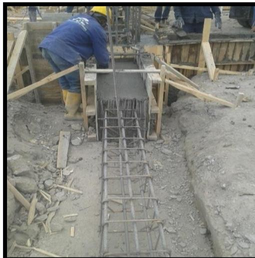
*Figura 59. Nivelación de fundición de viga de amarre. (Fuente: Propia)*
