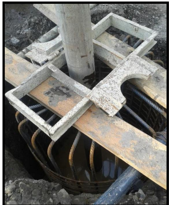
*Figura 32. Tubo Shelby, para vaciado de concreto. (Fuente: Propia)*
