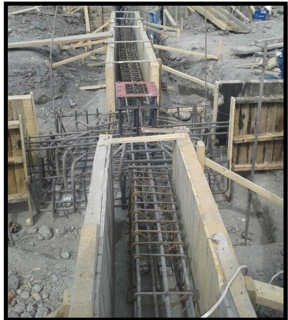
*Figura 56. Armado y amarre de acero de vigas. (Fuente: Propia)*
