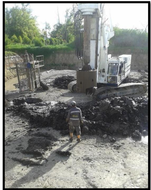
*Figura 27. Excavación de pilotes.
