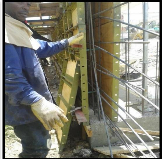
*Figura 64. Chequeo de traslapos, muros estructurales.
