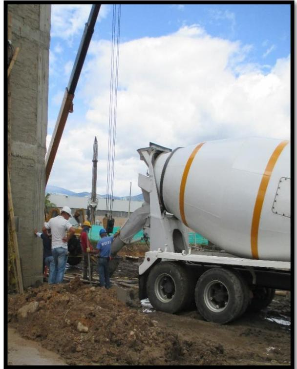
*Figura 44. Descarga de concreto para barrete. (Fuente: Propia)*
