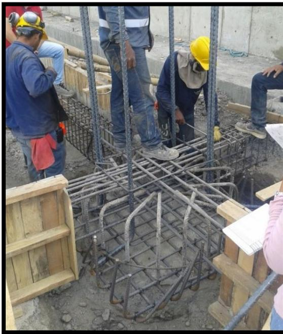
*Figura 48. Arranque de columnas.
