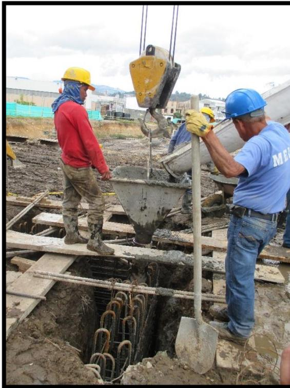
*Figura 43. Descarga de concreto para barrete. (Fuente: Propia)*
