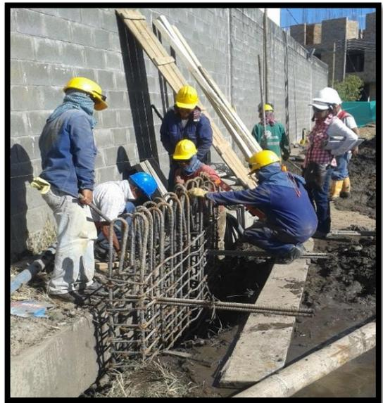
*Figura 42. Instalación de castillo para
