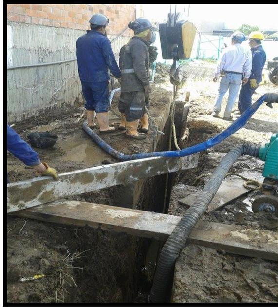
*Figura 37. Extracción agua subterránea de pantallas y barretes. (Fuente: Propia)*
