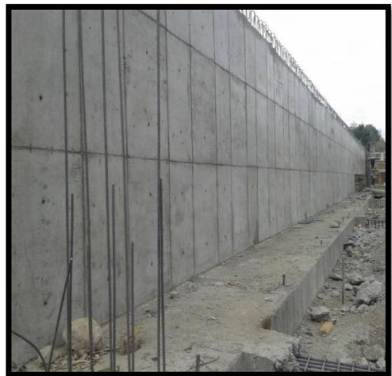
*Figura 71. Muro terminado. (Fuente: Propia)*
