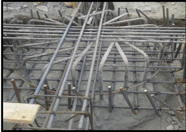
*Figura 46. Armado y amarre de acero para cabezal.
