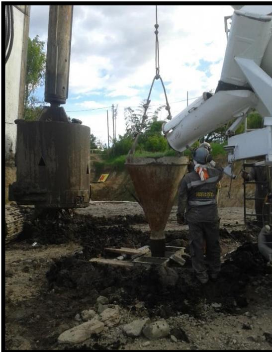
*Figura 31. Vaciado de concreto en pilotes. (Fuente: Propia)*
