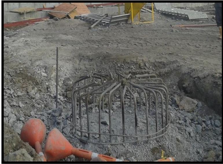
*Figura 45. Demolición de sobre fundición del Caisson. (Fuente: Propia)*
