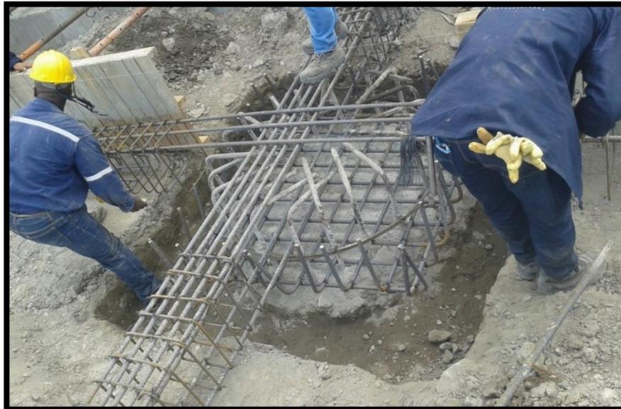
*Figura 47. Armado y amarre de acero para cabezal. (Fuente: Propia)*
