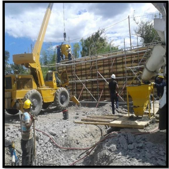
*Figura 67. Vaciado de concreto con bache. (Fuente: Propia)*
