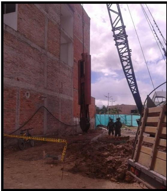
*Figura 38. Excavación de pantallas y barretes con Almeja. (Fuente: Propia)*
