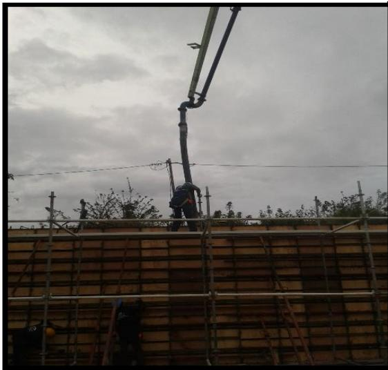
*Figura 70. Manipulación del "moco" de la boba y el vibrador. (Fuente: Propia)*
