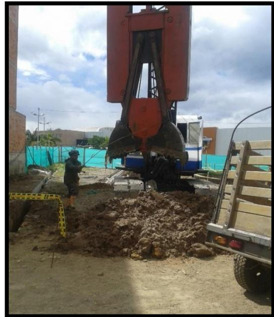
*Figura 39. Excavación de pantallas y barretes con Almeja. (Fuente: Propia)*
