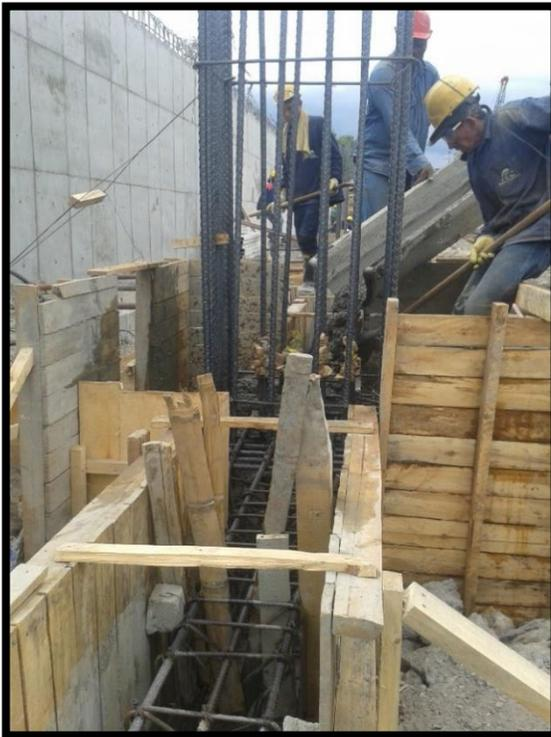
*Figura 52. Vaciado de concreto para cabezales. (Fuente: Propia)*
