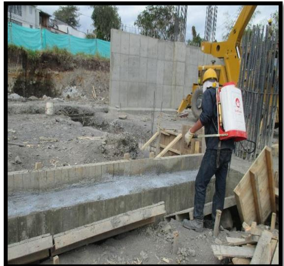
*Figura 61. Anti-sol para el curado.
