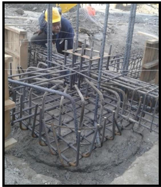
*Figura 49. Instalación de anclajes y chequeo de niveles. (Fuente: Propia)*
