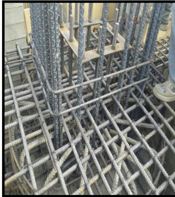
*Figura 51. Cabezal listo para fundición.
