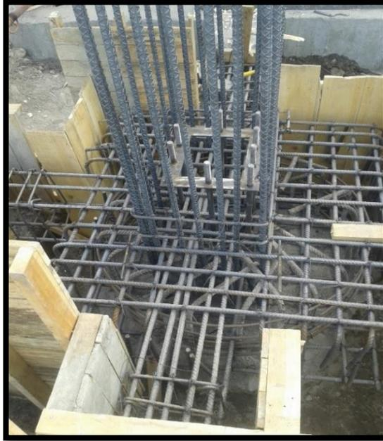
*Figura 50. Cabezal listo para fundición.
