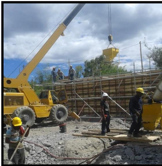
*Figura 66. Vaciado de concreto con bache. (Fuente: Propia)*
