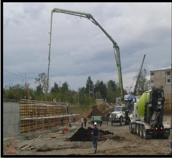
*Figura 68. Vaciado del concreto con Bomba ARGOS.*
