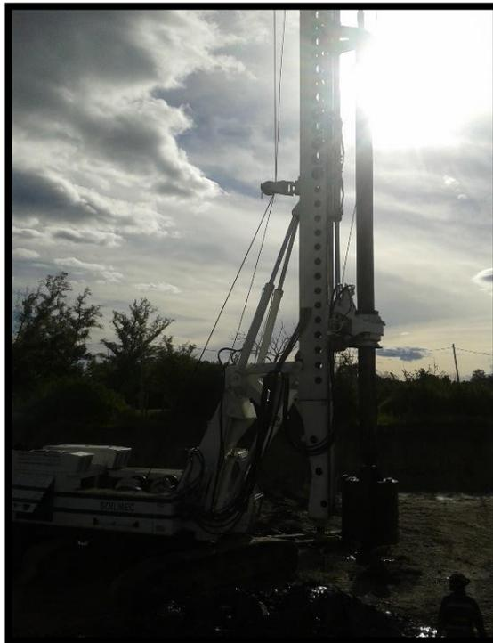
*Figura 26. Excavación de pilotes.
