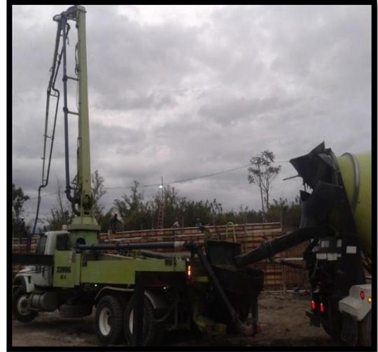
*Figura 69. Vaciado del concreto del Mixer a la Bomba ARGOS.*
