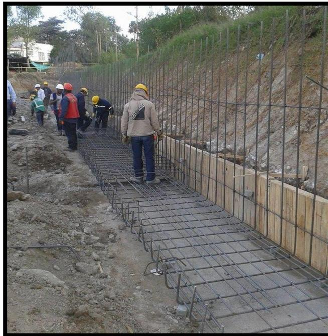
*Figura 62. Armado y amarre de acero, muro de contención. (Fuente: Propia)*
