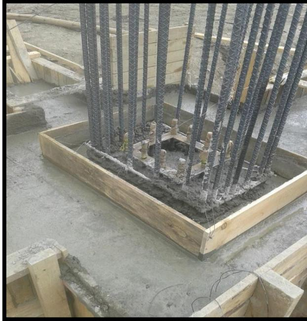
*Figura 54. Cabezal Fundido. (Fuente: Propia)*
