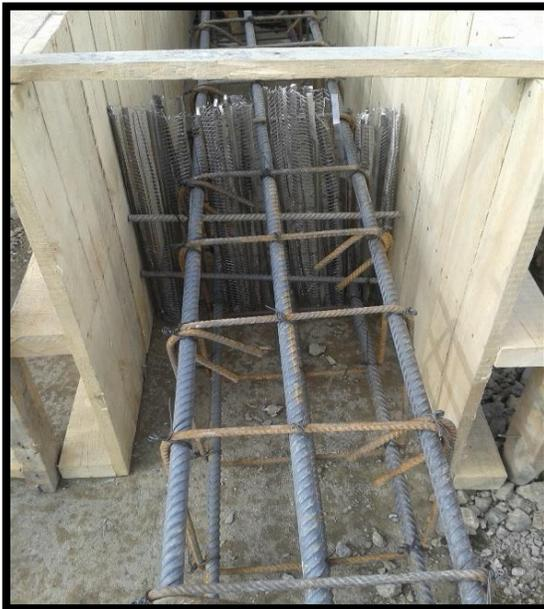
*Figura 57. Instalación de la malla con Vena antes de la fundición. (Fuente: Propia)*
