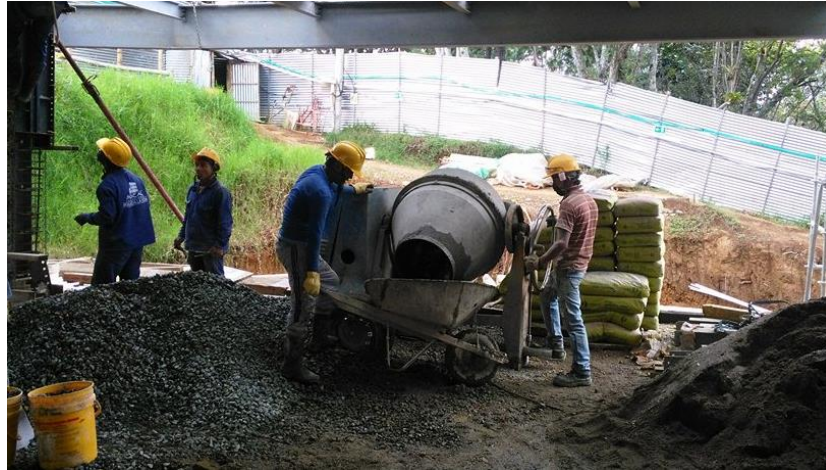
Figura No. 45 vaciado de concreto en carretas. Fuente propia.
