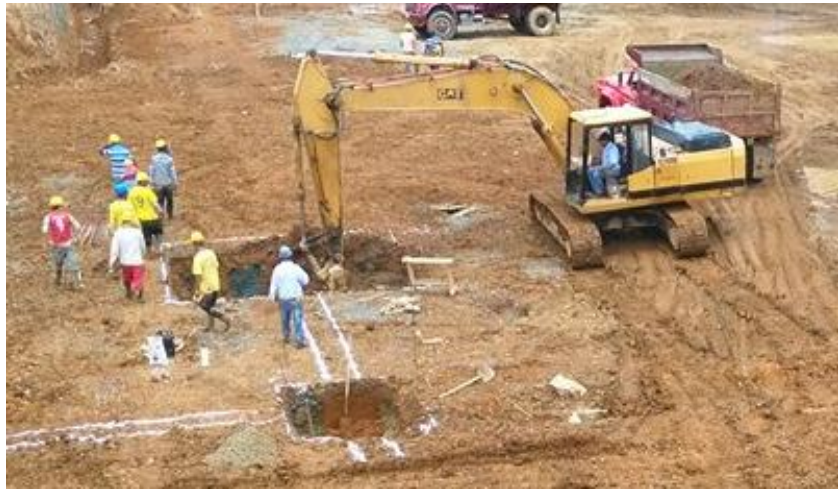
Figura No. 9 Excavación de zapata con retroexcavadora. Fuente propia.
