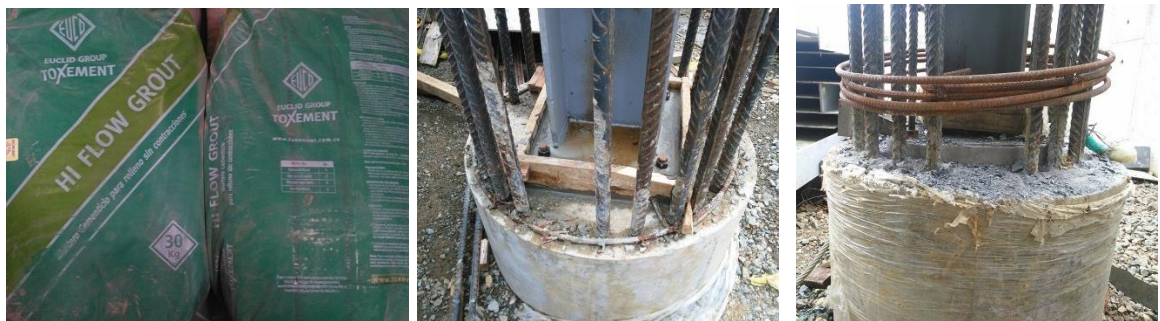
Figura No. 32 Hi Flow Grout utilizado en pedestales-Fundición de Grouting en pedestales. Fuente propia.
