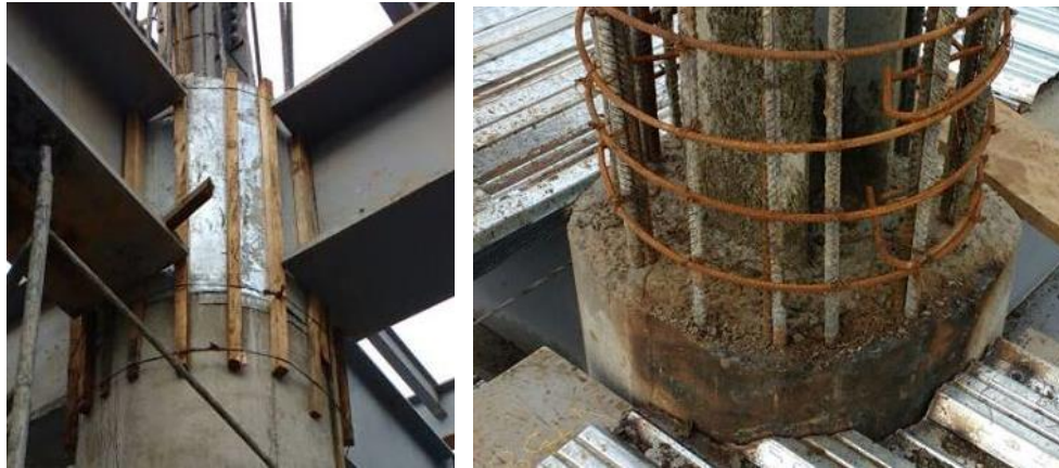
Figura No. 36 Encofrado y fundición de nudo de columna. Fuente propia.
