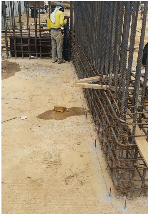
Figura No. 20 Cimbrado y colocación de pines para fundición de pedestal en pantalla. Fuente propia.
