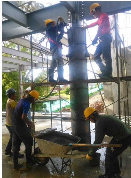
Figura No. 34 Colocación y vibrado de concreto en columna. Fuente propia.
