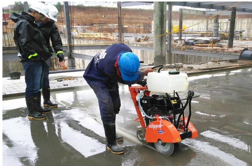
Figura No. 42 Corte de dilatación con cortadora de concreto. Fuente propia.
