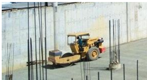
Figura No. 30 Compactación de sub base con vibro compactador. Fuente propia.
