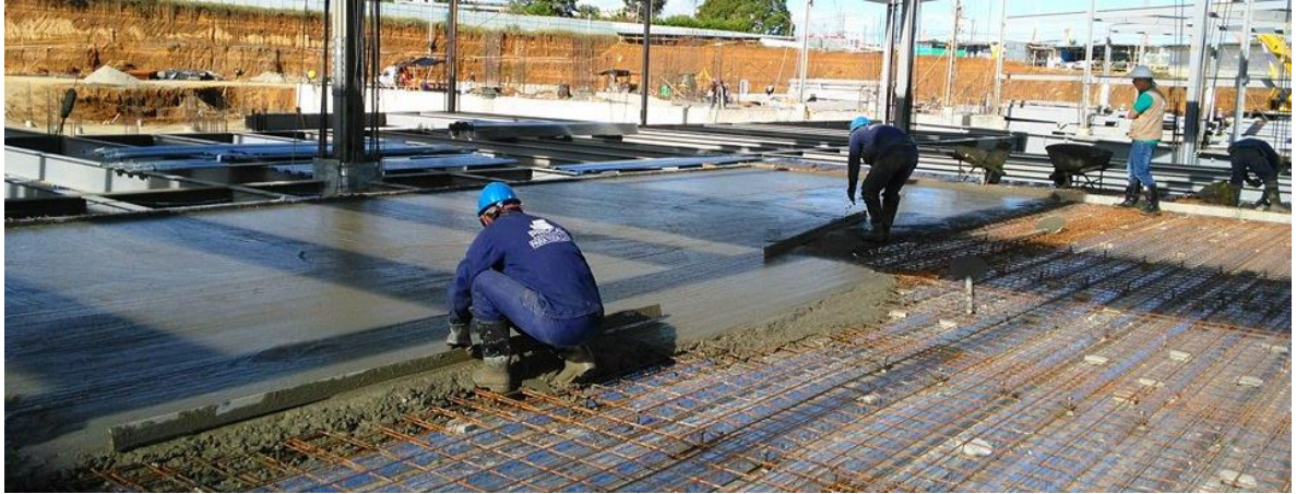
Figura No. 41 Nivelación de concreto con llana metálica. Fuente propia.
