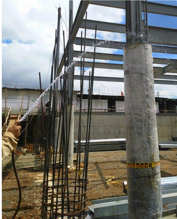
Figura No. 35 Curado de columna envuelta en papel celofán. Fuente propia.
