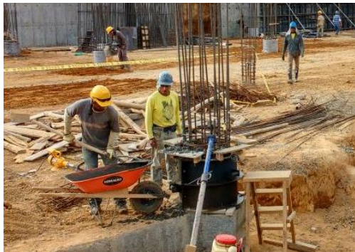
Figura No. 22 Fundición de pedestal de pantalla. Fuente propia.
