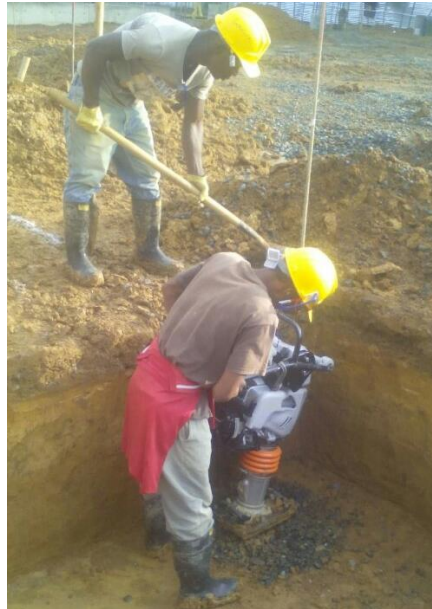
Figura No. 11 Compactación de geopier en zapata realizado a mano. Fuente propia.
