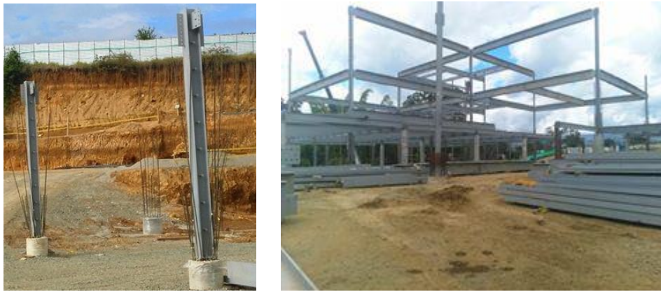
Figura No. 31 Montaje de estructura metálica. Fuente propia.
