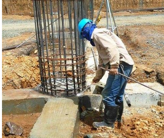
Figura No. 19 Curado de zapatas y vigas de cimentación. Fuente propia.
