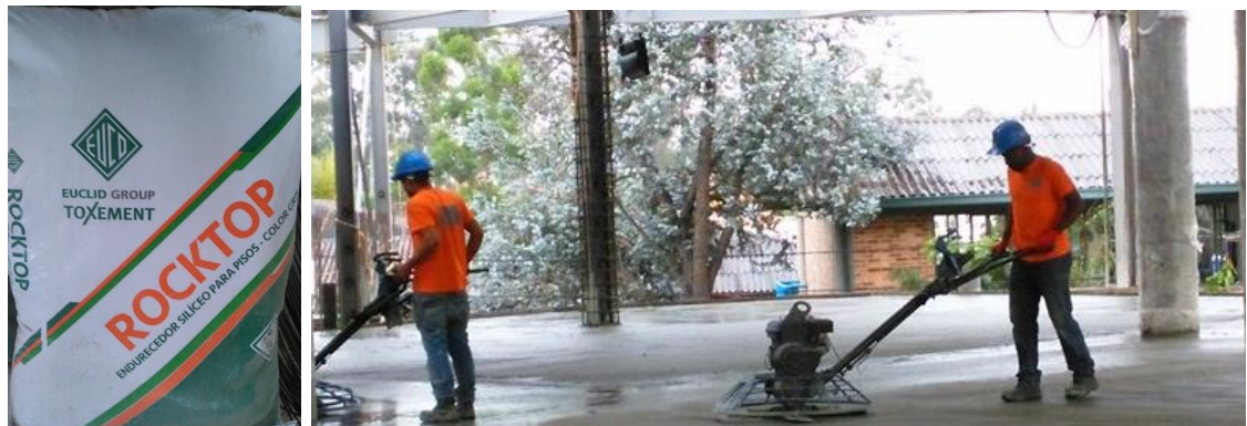
Figura No. 43 Endurecedor para pisos-Pulimiento con máquinas allanadoras. Fuente propia.
