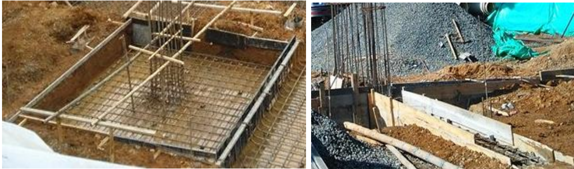
Figura No. 17 Colocación de formaleta metálica y en madera para fundición de zapatas y vigas de cimentación. Fuente propia.
