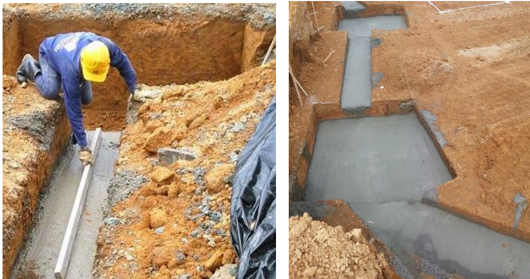
Figura No. 12 Solado de viga de cimentación y zapata. Fuente propia.
