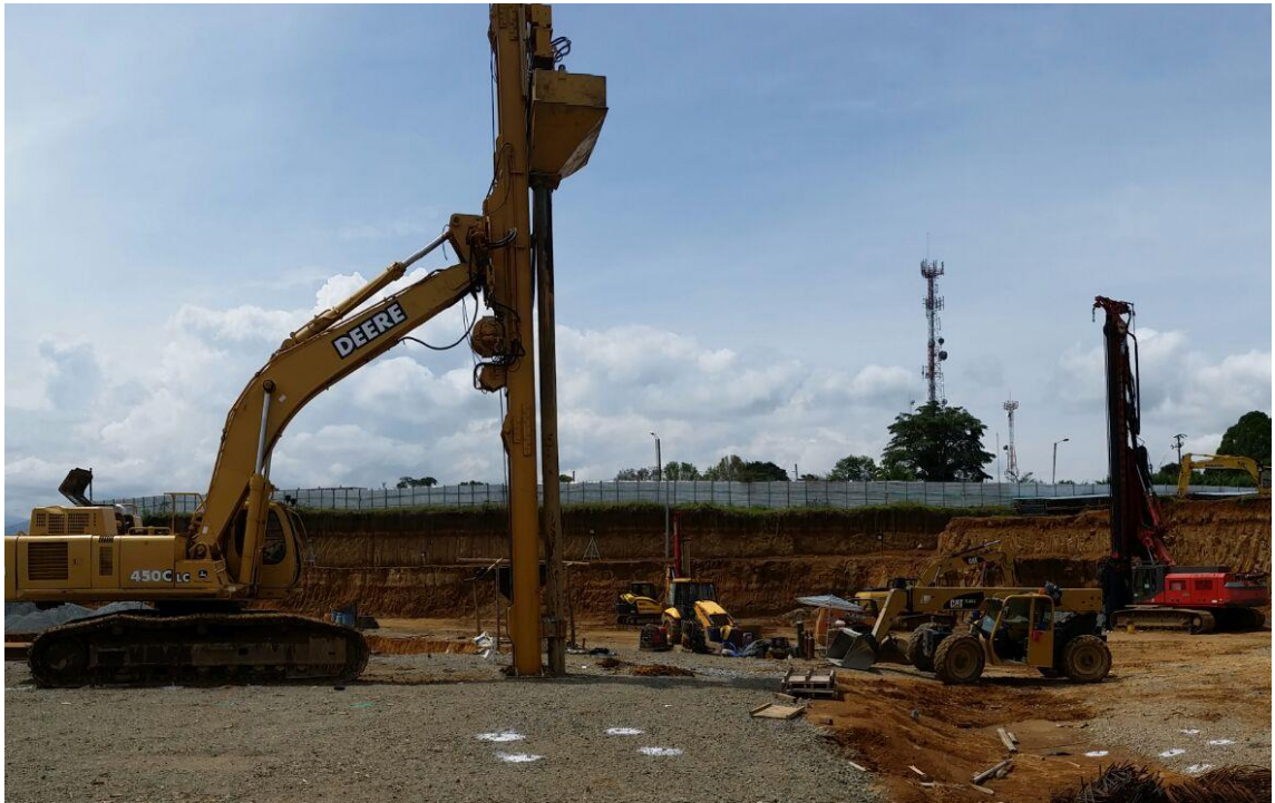
Figura No. 7 Ubicación de puntos de geopier en campo. Fuente Propia.
