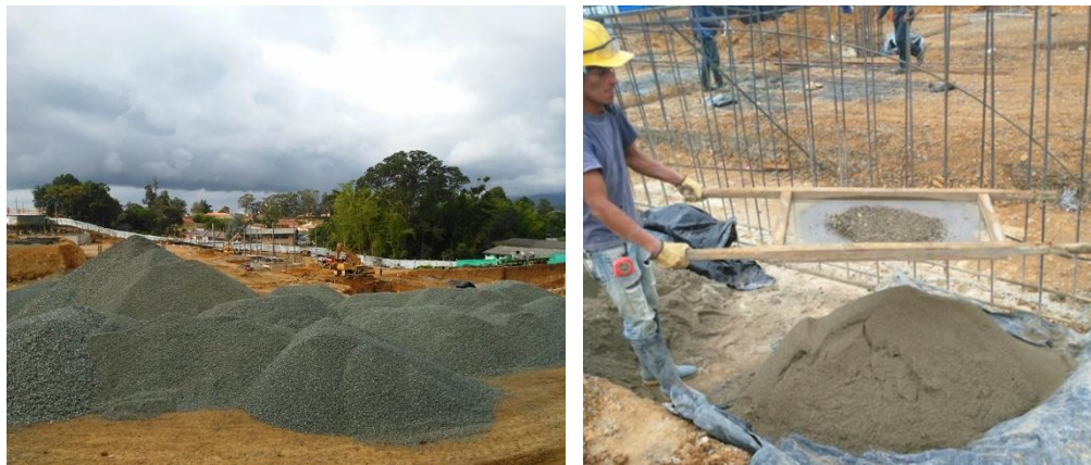
Figura No. 44 Triturado almacenado en obra- Tamizado de arena antes de mezclado. Fuente propia.
