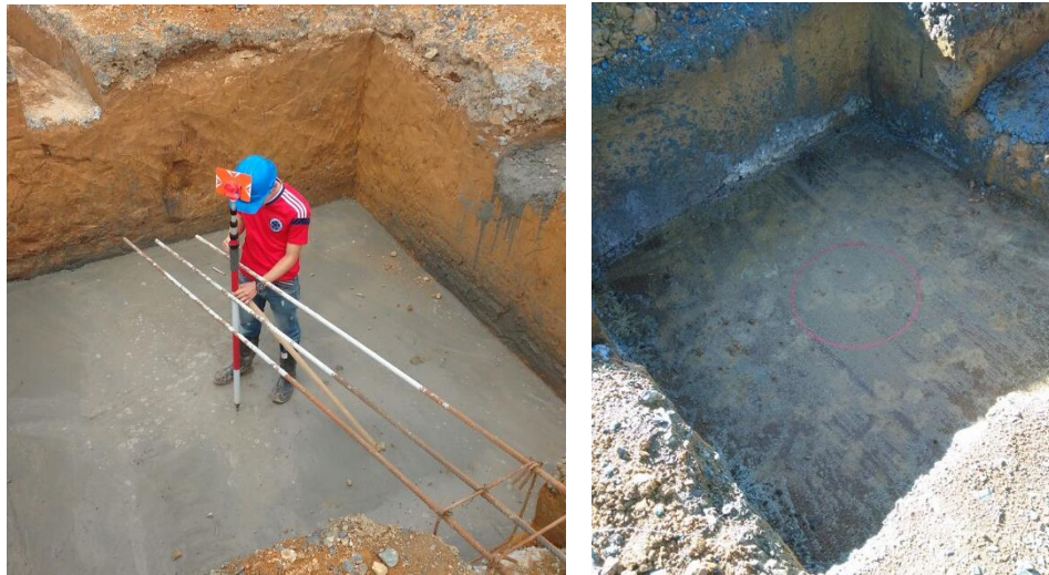
Figura No. 13 Localización con estación total y cimbrado de columna en zapata. Fuente propia.
