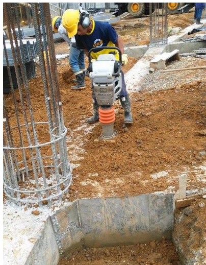
Figura No. 29 Nivelación del terreno con saltarín. Fuente propia.
