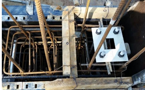
Figura No. 21 Localización de platina para fundición de pedestal de pantalla. Fuente propia.
