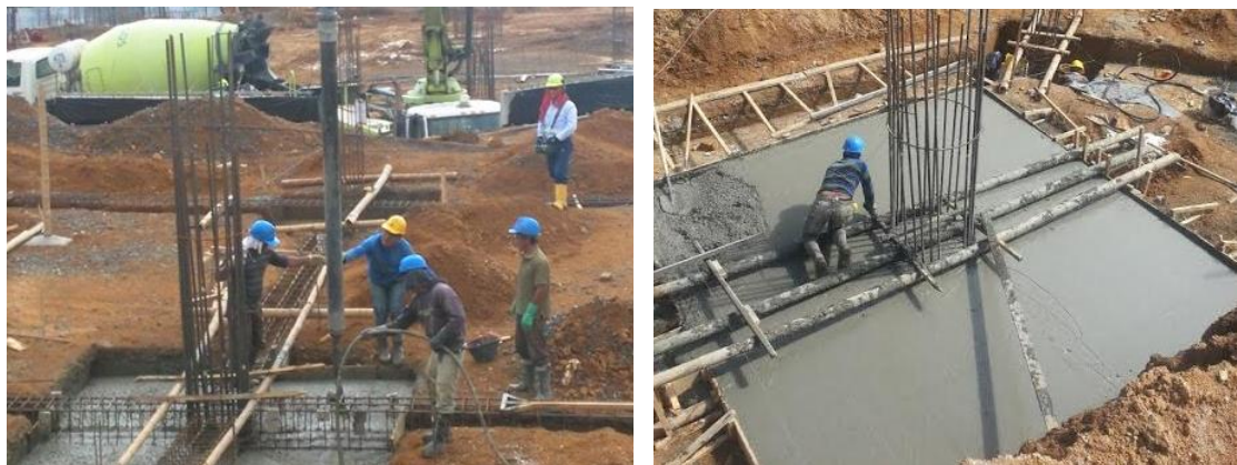
Figura No. 18 Fundición de zapatas y vigas de cimentación. Fuente propia.
