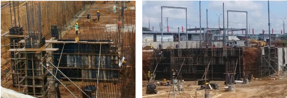
Figura No. 28 Formaleta aplomada para fundición de muros de contención. Fuente propia
