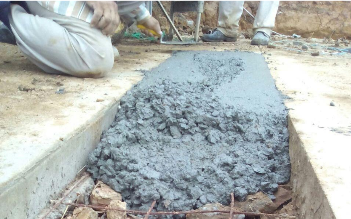
Figura 35. Proceso detalle constructivo canaletas.
