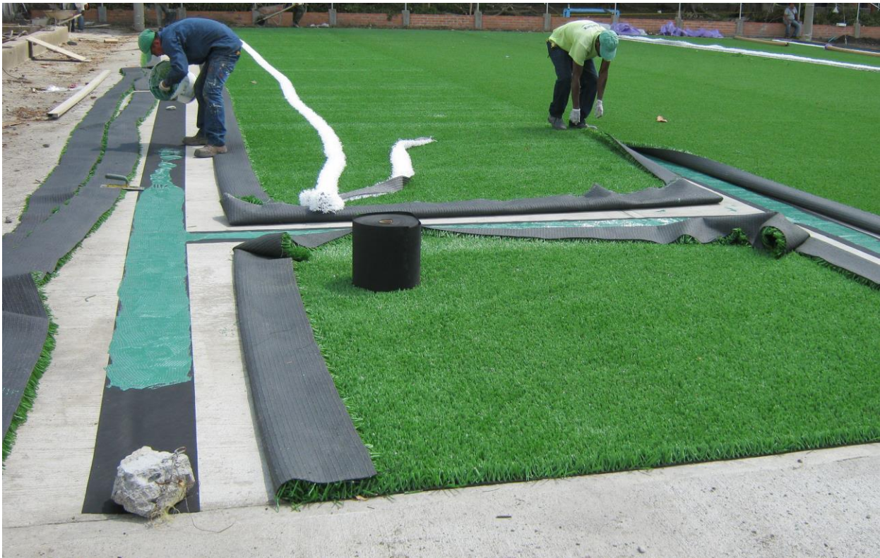
Figura 25. Instalación Grama sintética
