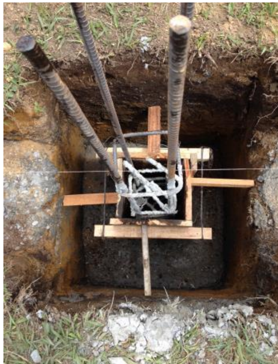
Figura 27. Proceso constructivo zapatas.
