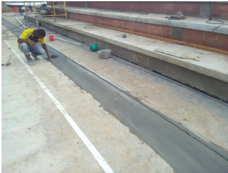
Figura 34. Proceso constructivo canaletas Argelia Valle.
