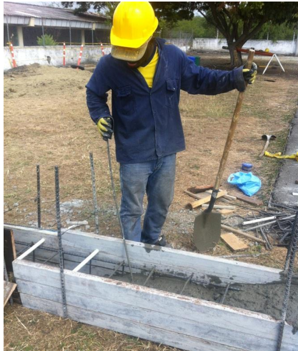
Figura 28. Proceso constructivo Vigas de cimentación.
