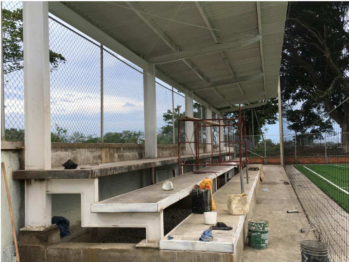
Figura 32. Cubierta tipo PVC.
