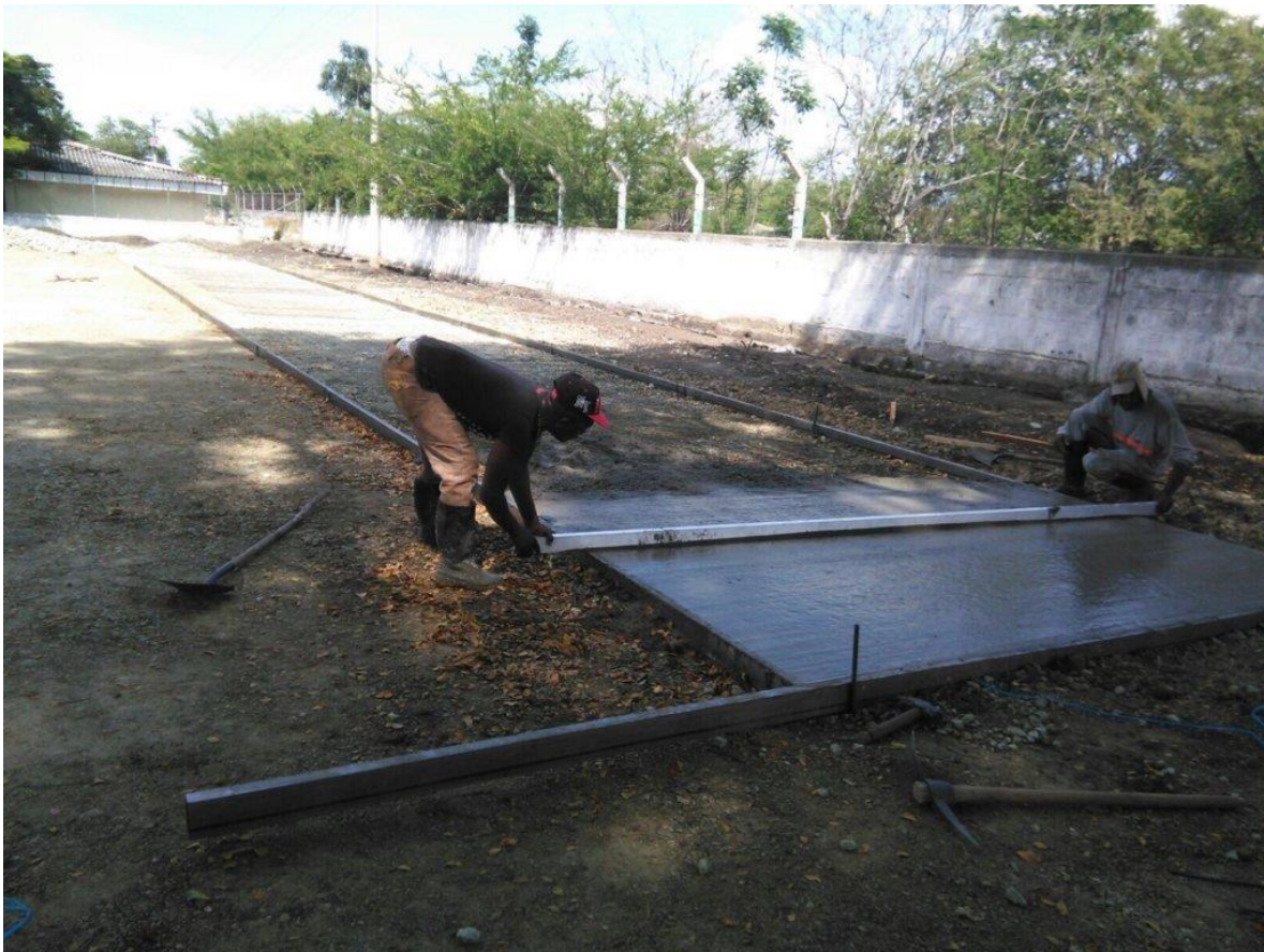
Figura 23. Vaciado losa de la cancha
