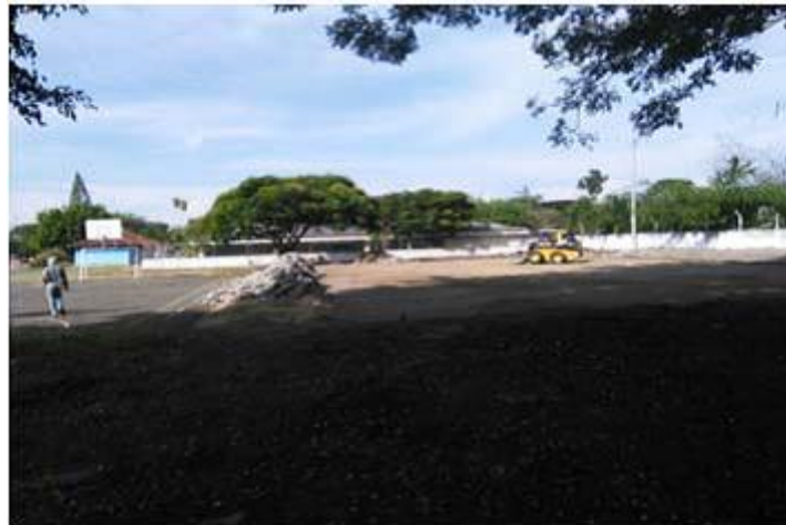
Figura 18. Excavación para placa.
