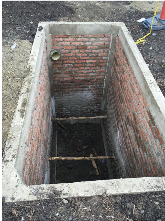
Figura 33. Proceso constructivo pozo ciego.
