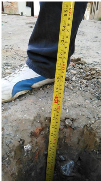
Figura 12 – Verificación y control profundidad de los barrenos.
