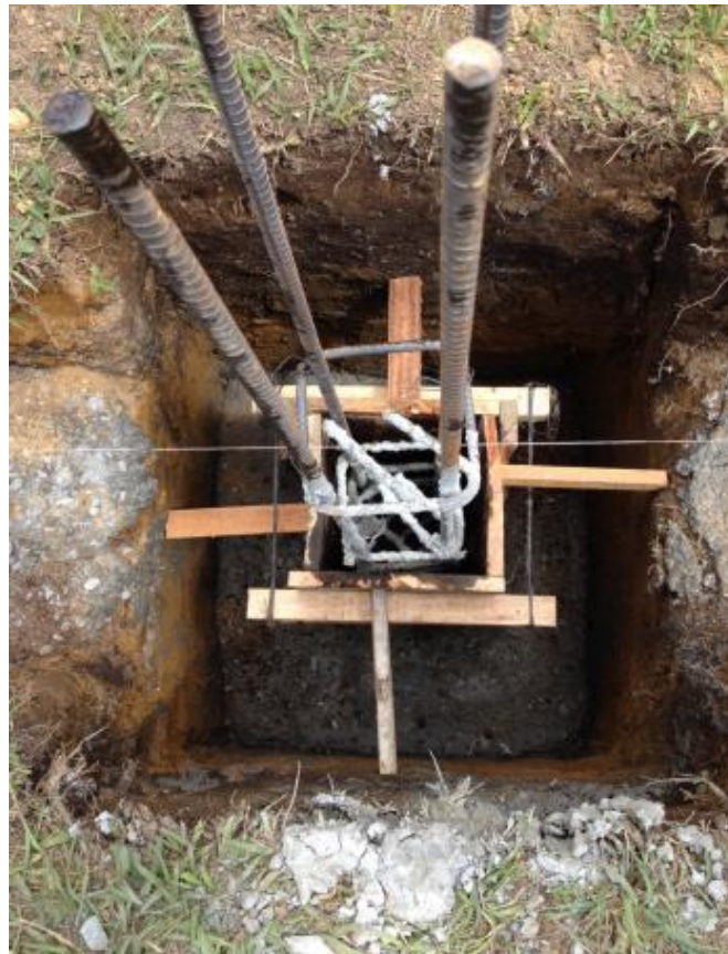
Figura 17. Alineamiento para localización zapata y pedestal.
