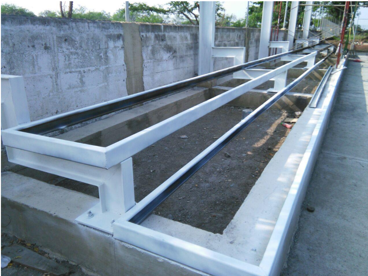
Figura 30. Proceso constructivo graderías.
