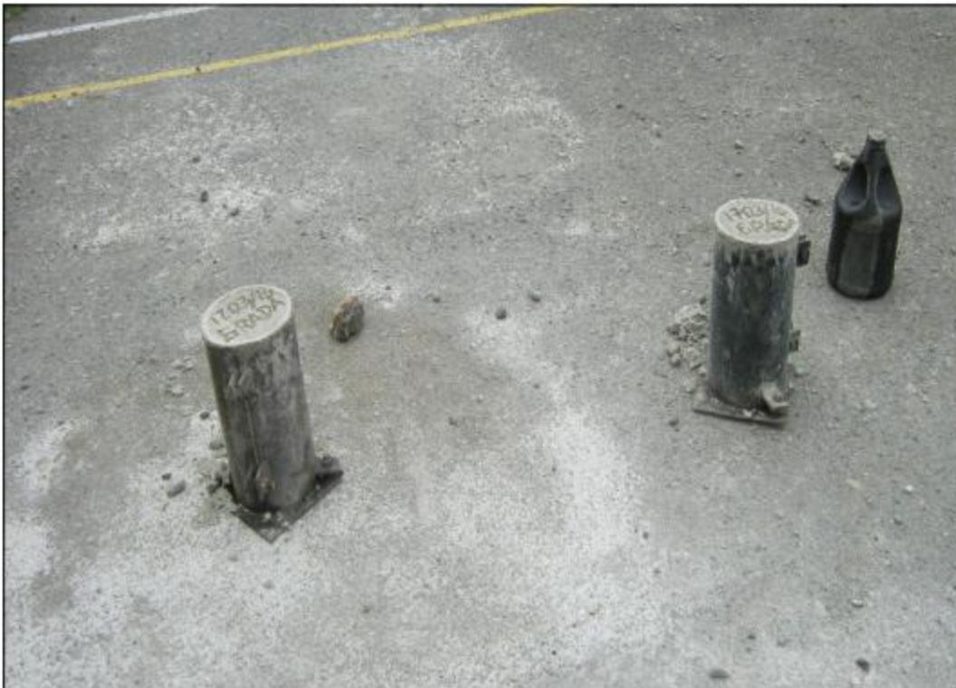
Figura 31. Toma de Muestras Cilindros de Concreto graderías.
