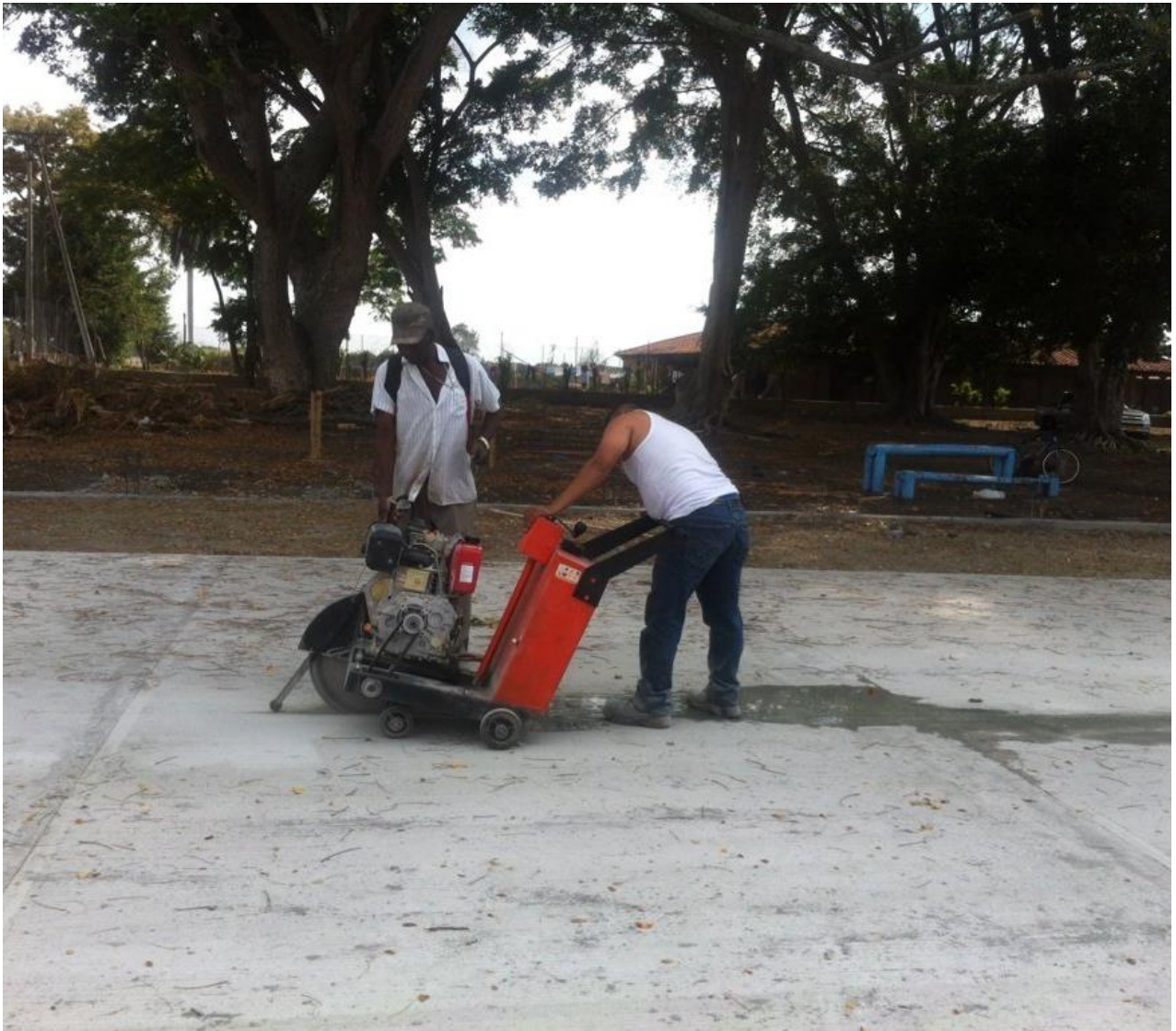
Figura 24. Proceso de corte de la losa
