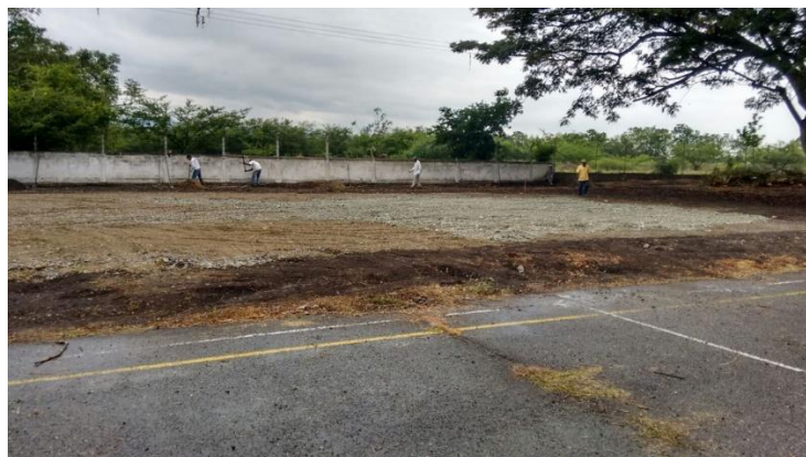
Figura 21. Proceso de riego del material
