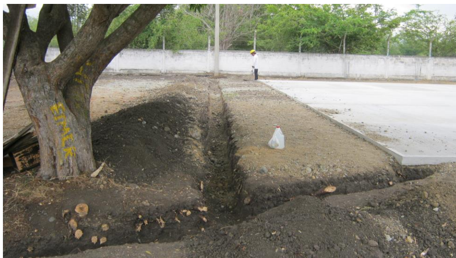
Figura 19. Excavación para la red de alcantarillado
