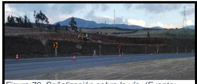
Figura 76. Señalización sobre la vía. (Fuente: Propia)
