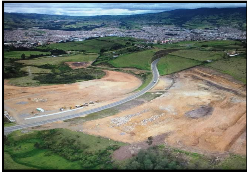
Figura 24. Vista general etapas 1 y 2 Julio 2016. (Fuente: Registro fotográfico EPROC.COM)
