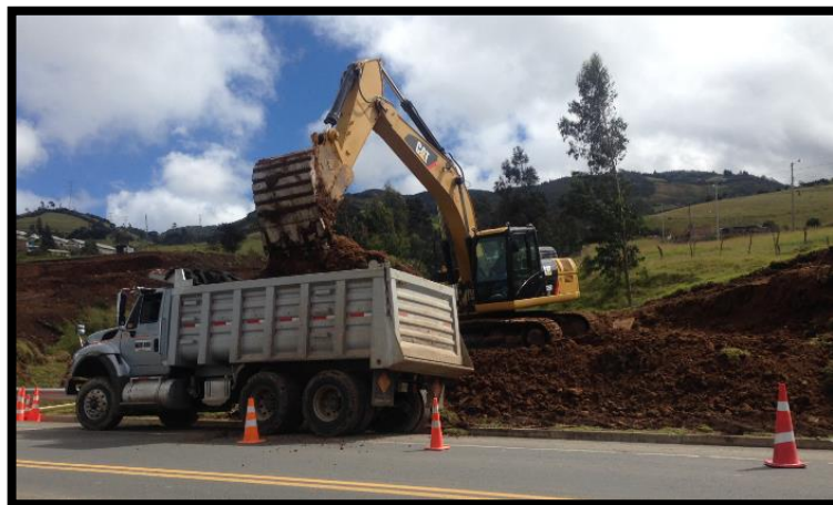
Figura 34. Volquetas para acarreo de material. (Fuente Propia)
