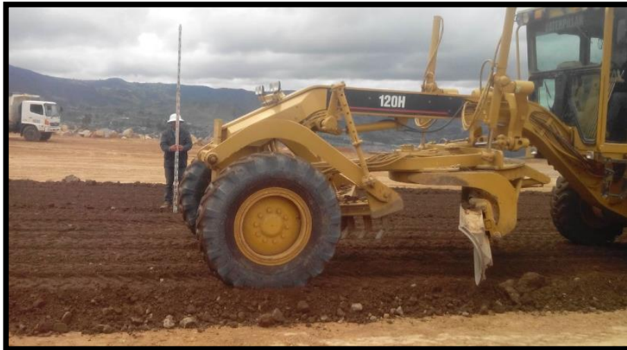
Figura 59. Extendido de capa de mejoramiento. (Fuente: Propia).
