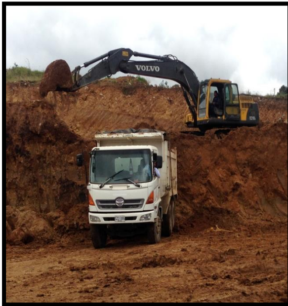
Figura 29. Excavadora VOLVO Ec 210B. (Fuente: Propia)
