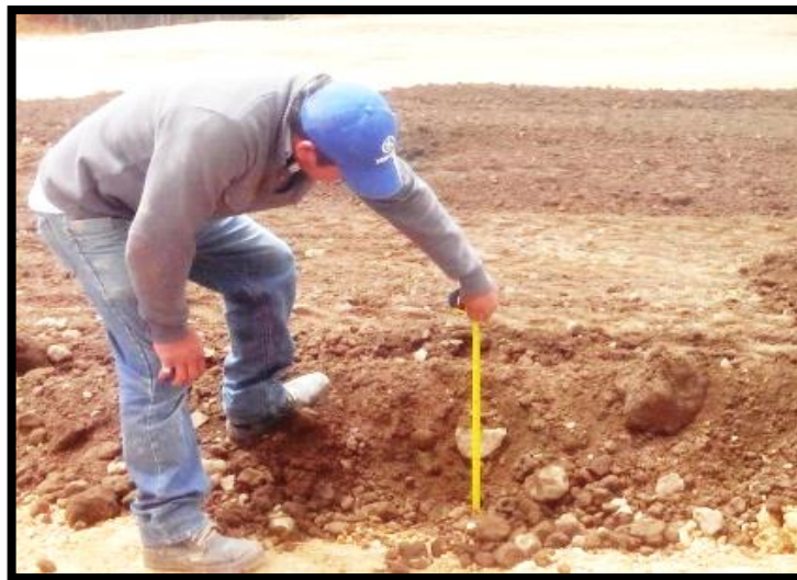
Figura 54. Medición espesor capa de terraplén. (Fuente: Propia)
