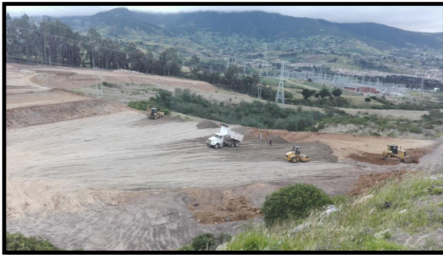
Figura 55. Proceso de conformación de terraplén. (Fuente: Propia)
