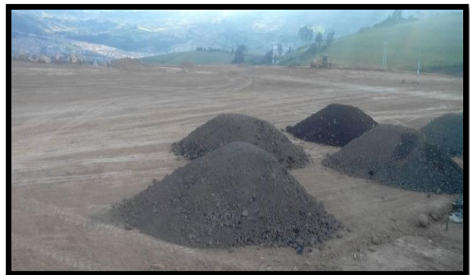
Figura 60. Material de mejoramiento, Granzón. (Fuente: Propia)
