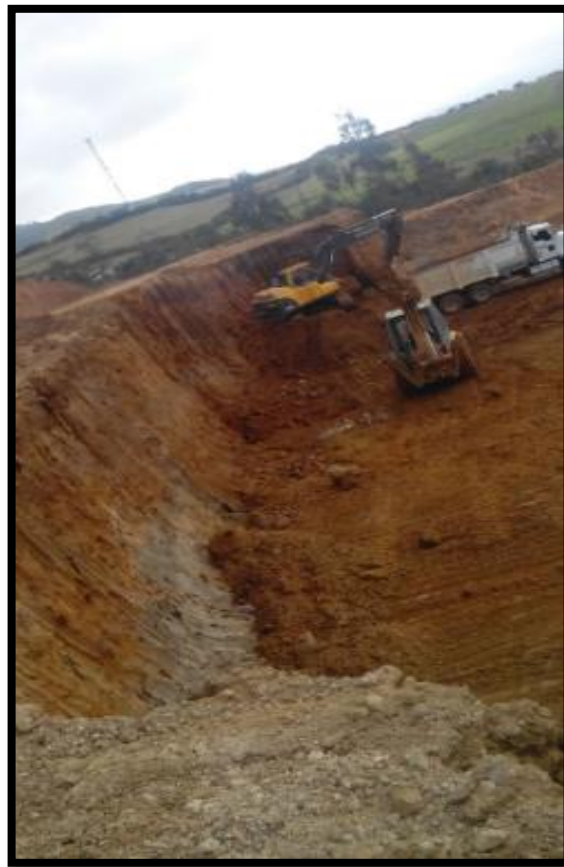
Figura 44. Avance de corte bodegas 1-2. (Fuente: Propia).
