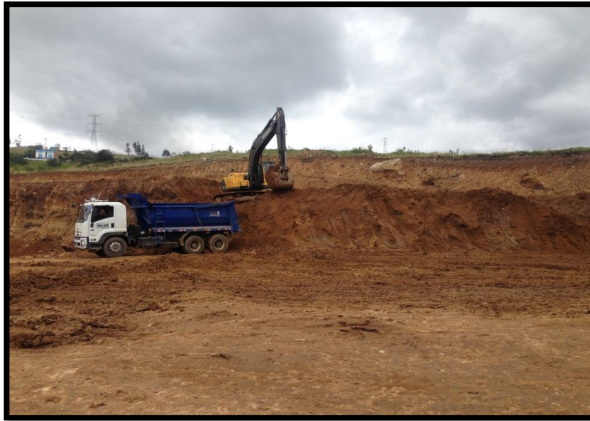
Figura 39. Avance en corte de material agosto 2016. (Fuente: Propia)
