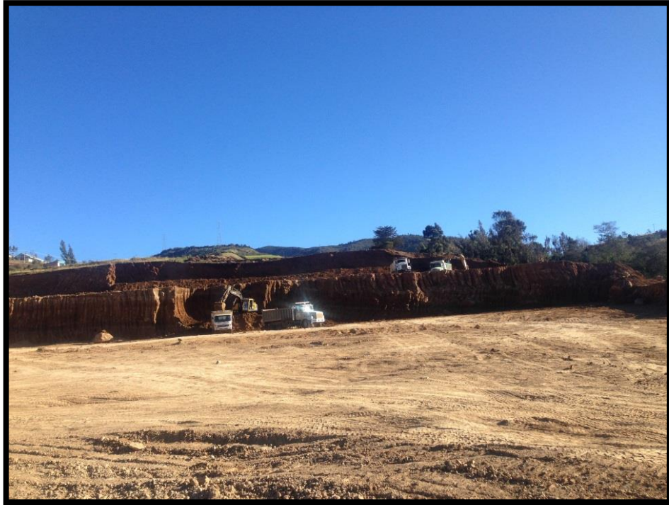
Figura 41. Corte de material con dos máquinas. (Fuente: Propia)
