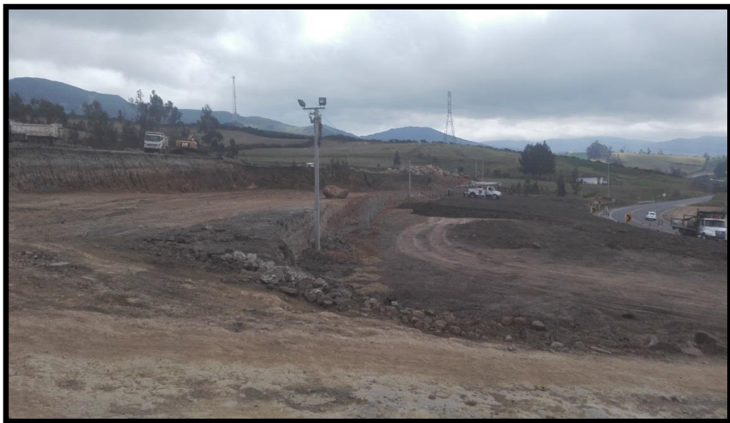
Figura 25. Vista de terrazas etapa 2. (Fuente: Propia).
