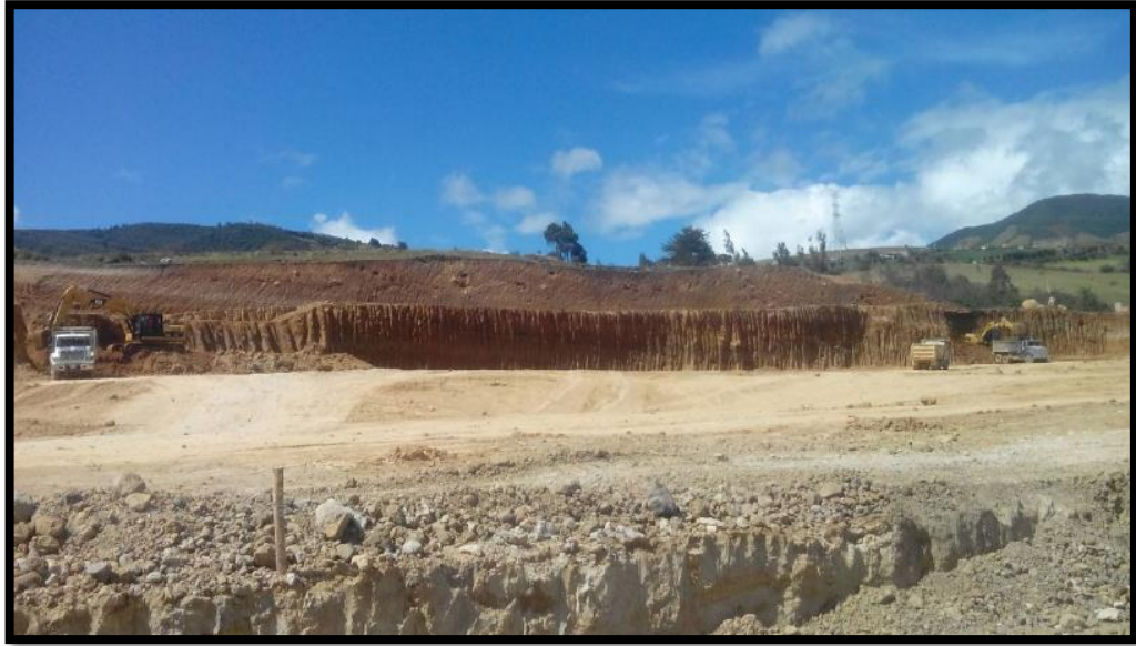
Figura 43. Avance de corte bodegas 1-5 28 de septiembre. (Fuente: Propia)
