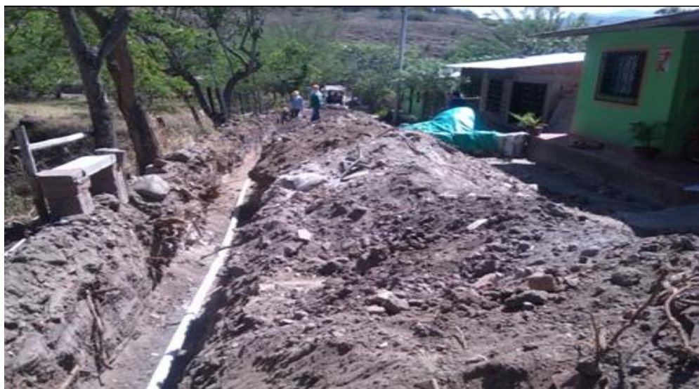
FIGURA 4. Material de la misma excavación a utilizar para relleno de zanja en red principal de acueducto entrada al Batallón Pigoanza.
