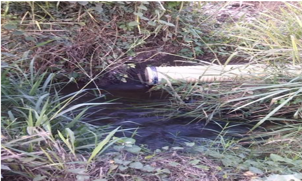
FIGURA 10. Punto de descole sobre el zanjón Charco del Burro.
