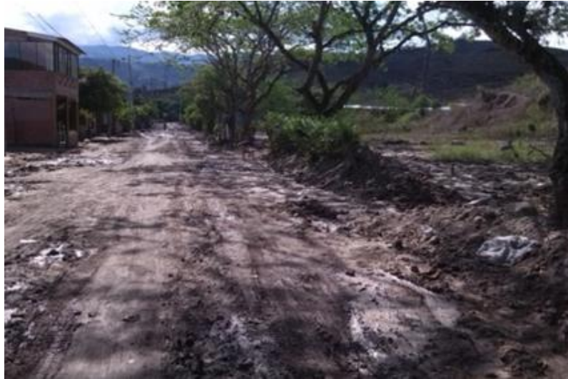
FIGURA 12. Vía en mal estado por las obras de construcción de red principal de alcantarillado.
