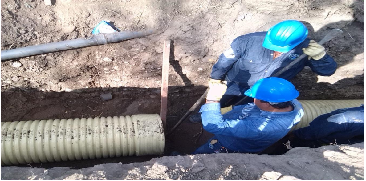
FIGURA 8. Personal de EMPUGAR E.S.P., instalando tubería de 20" sobre la vía hacia el Batallón Pigoanza.
