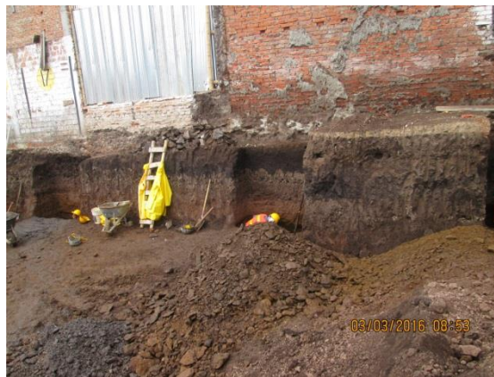
Imagen 12. Cimentación casa de habitación colindante.
