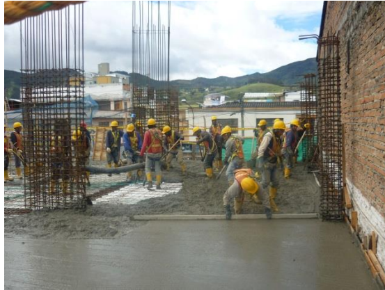
Imagen 23. Ejemplo constructivo fundición de losa de entrepiso.
