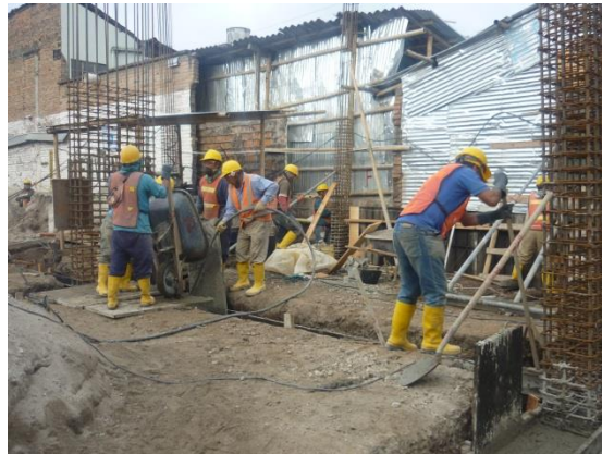
Imagen 11. Ejemplo constructivo vigas de cimentación.
