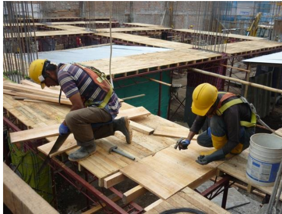
Imagen 19. Ejemplo constructivo encofrado.
