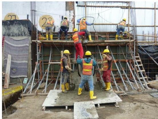
Imagen 13. Ejemplo constructivo muro de contención 1.
