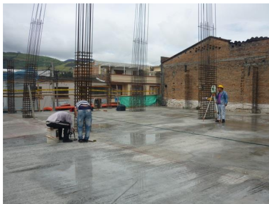
Imagen 24. Replanteo de ejes.
