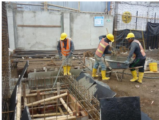
Imagen 16. Ejemplo constructivo foso del ascensor.
