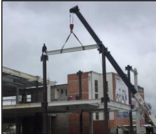
*Figura 31. Montaje de vigas y viguetas por medio de grúa. (Fuente: Autoría Propia)*
