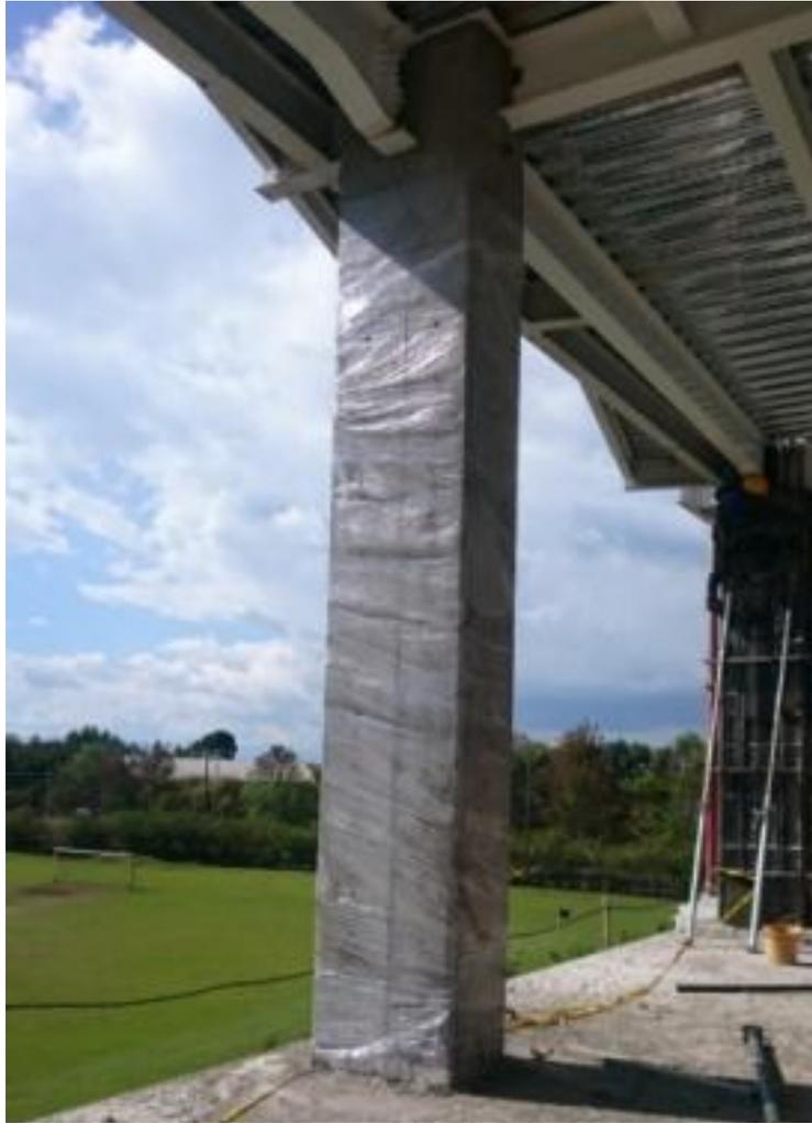
*Figura 75. Columna cubierta con película de plástico para conservar la humedad y garantizar correcto curado del concreto (Fuente: Autoría Propia).*
