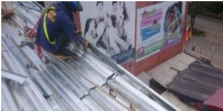
Figura 36. Instalación de testero (borde losa). (Fuente: Autoría Propia)
