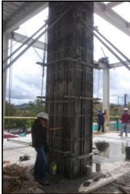
*Figura 68. Instalación de formaleta y chequeo de verticalidad (Fuente: Autoría Propia).*
