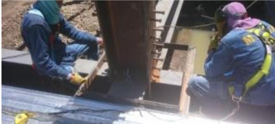
Figura 35. Instalación de collares de columna. (Fuente: Autoría Propia)
