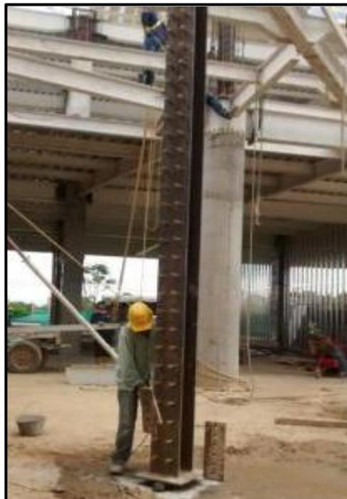
*Figura 28. Instalación aplome y aseguramiento de perfil. (Fuente: Autoría Propia)*
