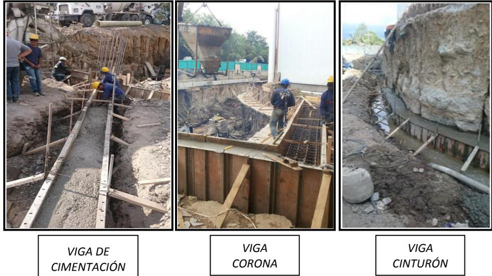
*Figura 23. Fundición de vigas. (Fuente: Autoría Propia)*
