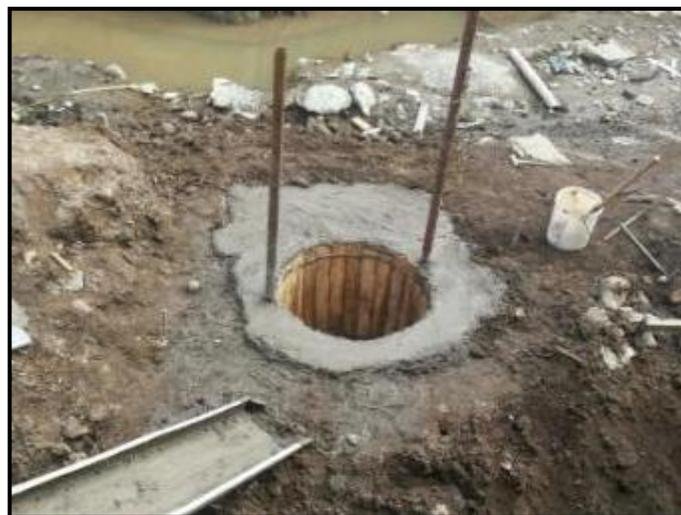
*Figura 5. Fundición del primer anillo. (Fuente: Autoría Propia)*
