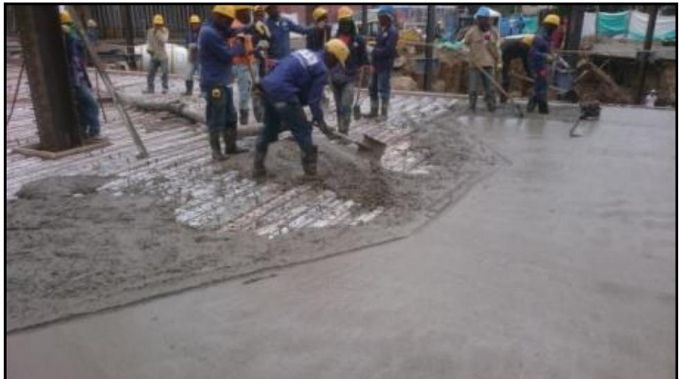
Figura 61. Descarga y vertimiento de concreto. (Fuente: Autoría Propia)
