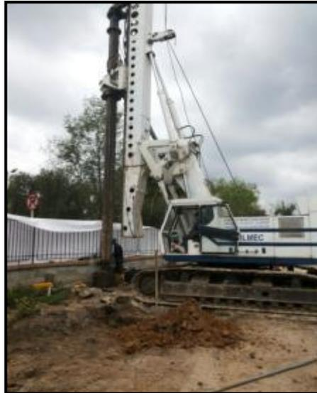
*Figura 4. Inicio de la excavación con la piloteadora. (Fuente: Autoría Propia)*
