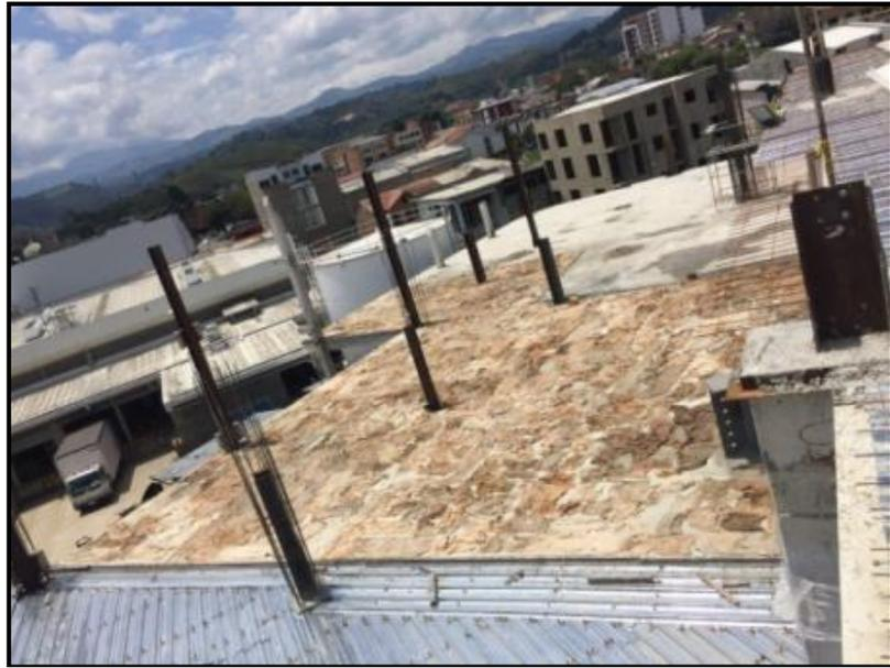
*Figura 62. Colocación de estopas de fique para garantizar la humedad y correcto curado del concreto (Fuente: Autoría Propia)*
