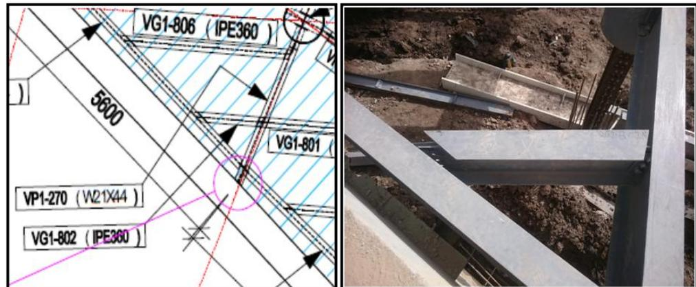
Figura 40. Supervisión plano con montaje físico. (Fuente: Autoría Propia)
