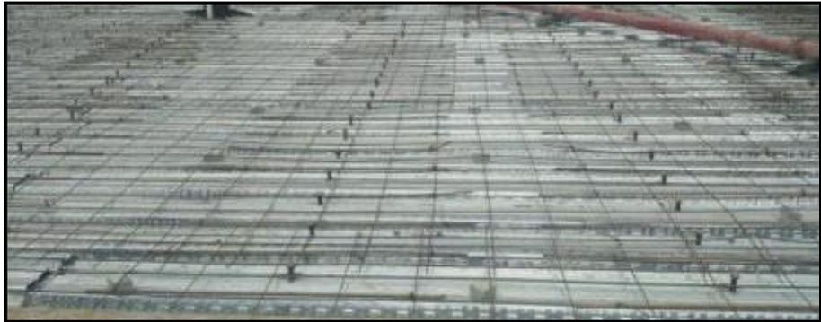
Figura 60. Instalación de acero de refuerzo negativo (Fuente: Autoría Propia)
