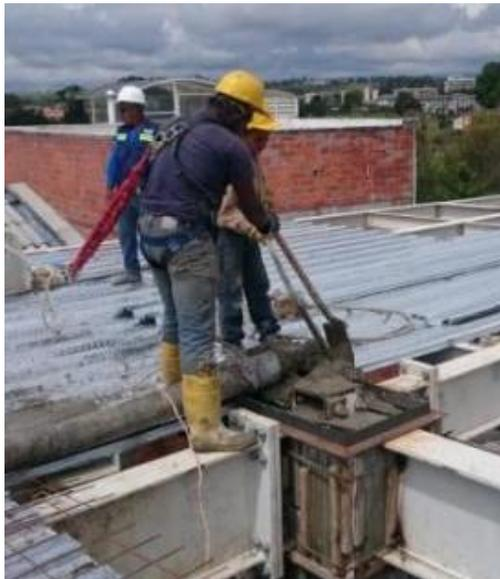
*Figura 69. Fundición y vibrado de concreto de columna (Fuente: Autoría Propia).*
