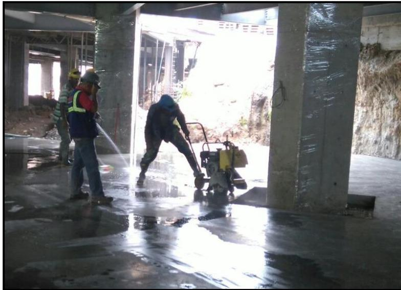
*Figura 57. Corte de las juntas de contracción. (Fuente: Autoría Propia)*
