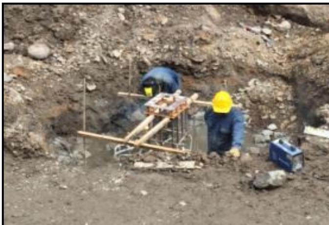
*Figura 14. Instalación de anclaje para columna perfil metálico. (Fuente: Autoría Propia)*
