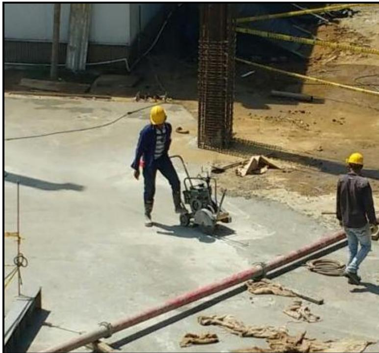
*Figura 63. Localización y corte de juntas de dilatación (Fuente: Autoría Propia)*
