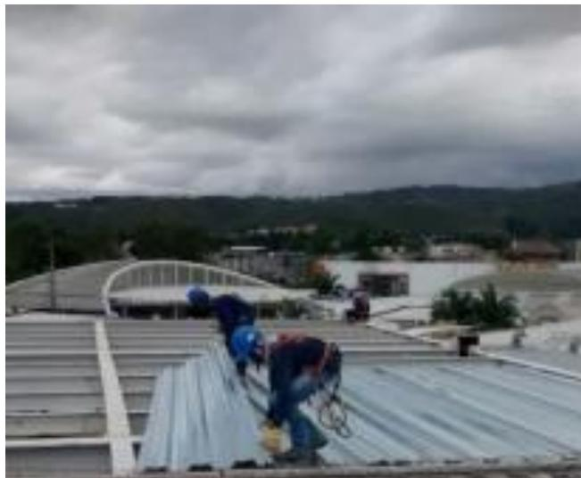
*Figura 34. Instalación de lámina colaborante (Fuente: Autoría Propia)*
