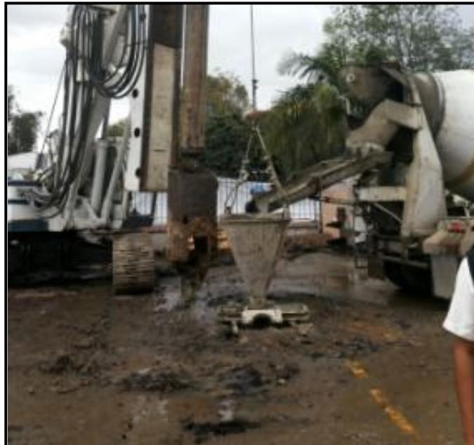
*Figura 11. Fundición con tubería tremie. (Fuente: Autoría Propia)*
