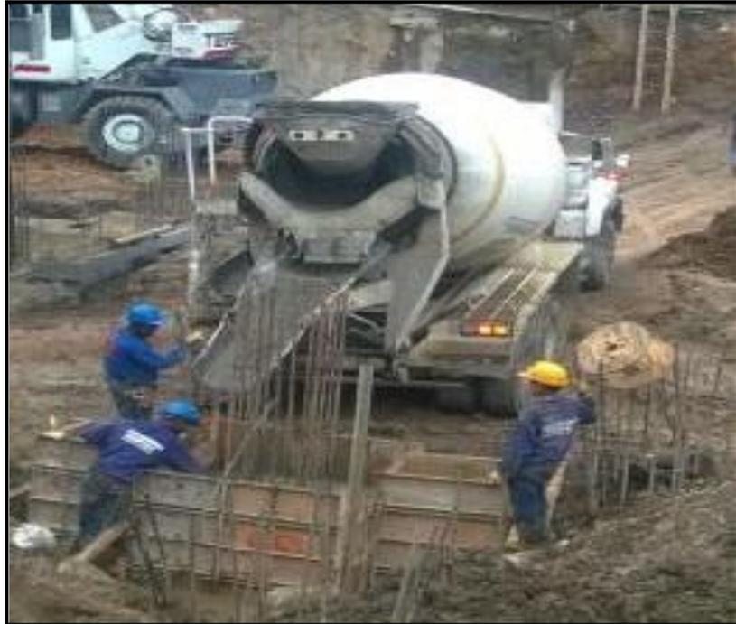
*Figura 17. Fundición de concreto mediante descarga directa desde el camión hormigonera. (Fuente: Autoría Propia)*
