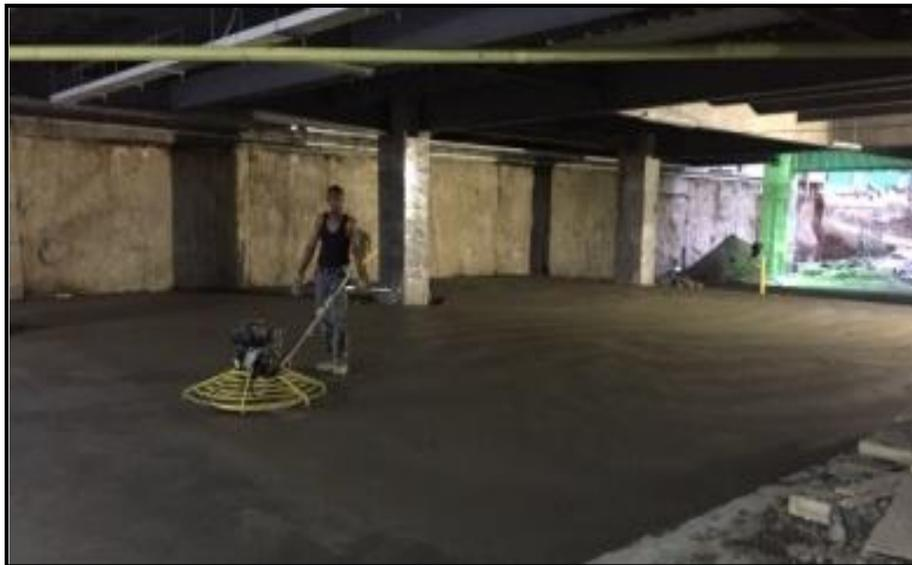
*Figura 49. Pulimento de la capa de rodadura. (Fuente: Autoría Propia)*
