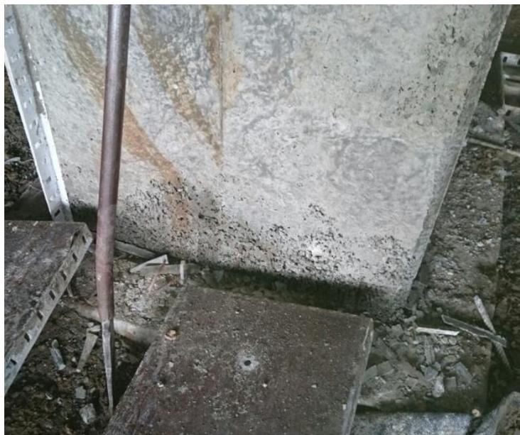
*Figura 73. Columna con base hormigonada (Fuente: Autoría Propia).*
