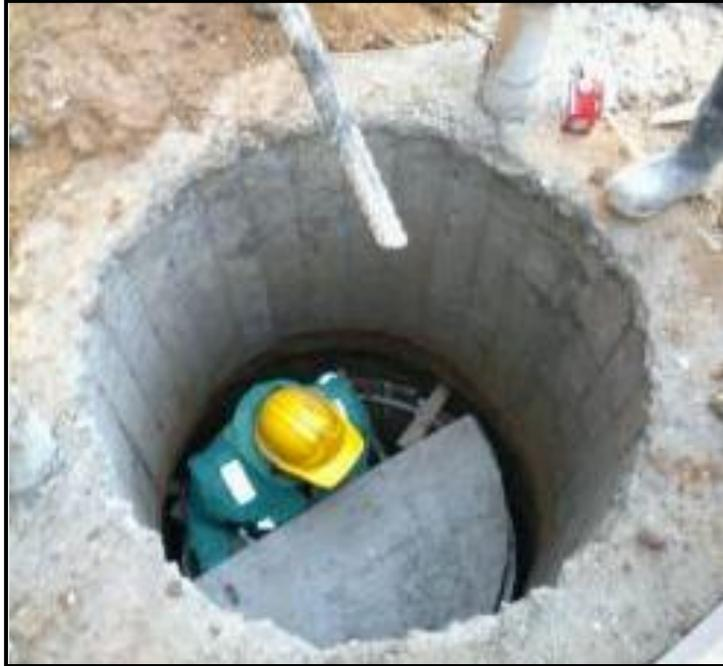
*Figura 8. Instalación de formaleta segundo anillo (Fuente: Autoría Propia)*
