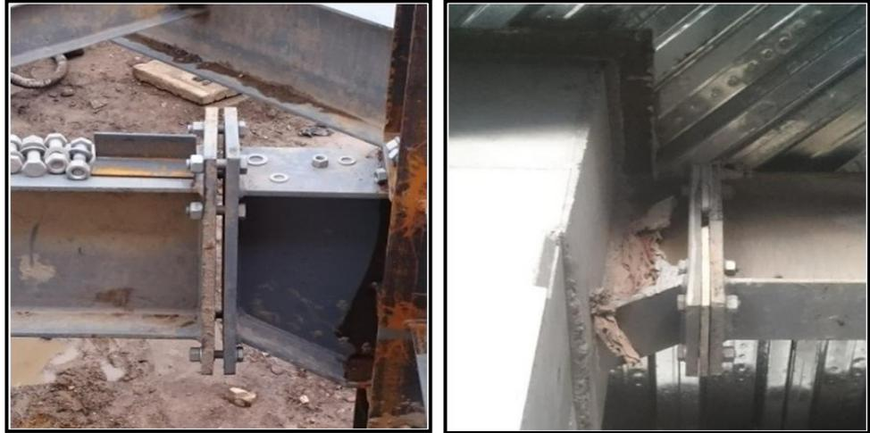
*Figura 42. Ajuste de conexión por medio de calza. (Fuente: Autoría Propia)*
