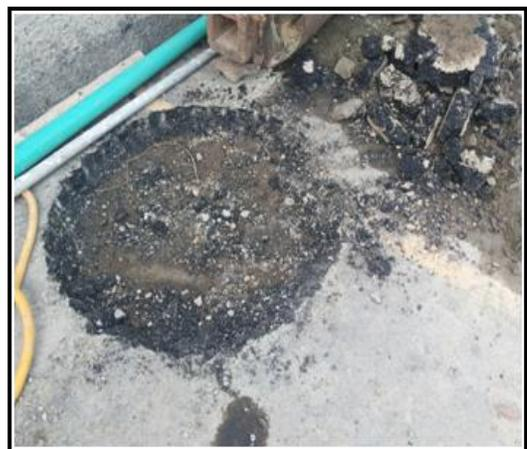
*Figura 3. Localización y demolición del pavimento (prehueco). (Fuente: Autoría Propia)*
