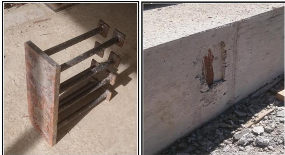
*Figura 22. Anclaje de platina para brochal de conexión a viga metálica. (Fuente: Autoría Propia)*
