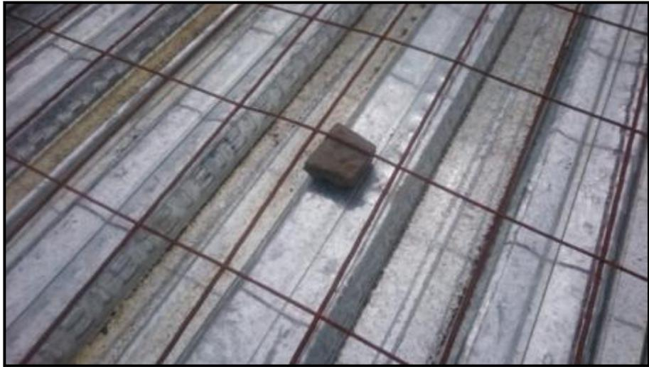
*Figura 65. Instalación de panelas de concreto para garantizar recubrimiento (Fuente: Autoría Propia).*
