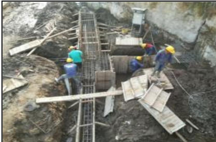
*Figura 16. Instalación de formaleta para dados de cimentación. (Fuente: Autoría Propia)*
