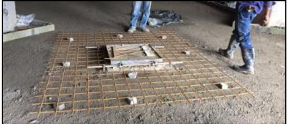
*Figura 45. Colocación de acero de refuerzo en áreas de concentración de esfuerzos. (Fuente: Autoría Propia)*
