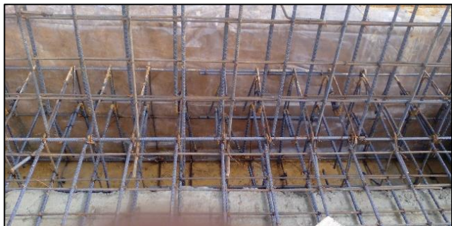
Figura 21: Conformación refuerzo muros de contención. Fuente Propia
