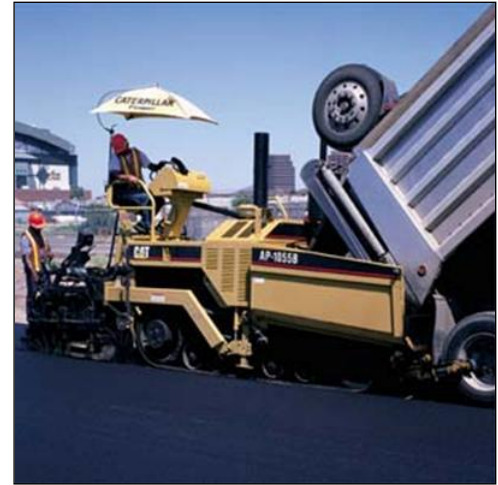
IMAGEN N° 1. Extendido de mezcla asfáltica
