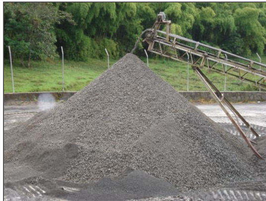
IMAGEN N° 33. Agregados de trabajo
