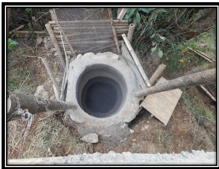
FIGURA 21: ANILLOS DE CAISSON FINALIZADO.
