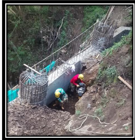
FIGURA 51: COMPACTACIÓN DE MATERIAL DE RELLENO CON SALTARIN.
