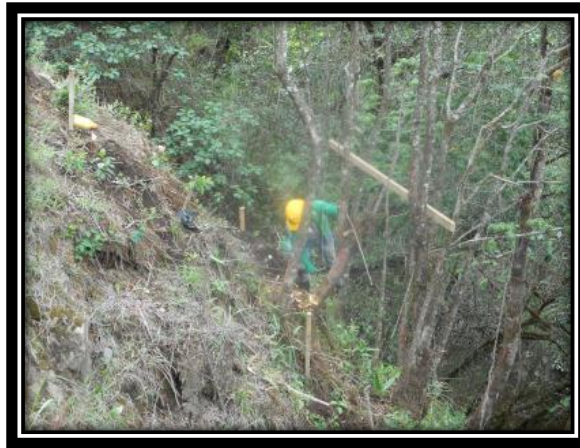
FIGURA 16: RETIRO DE CAPA VEGETAL
