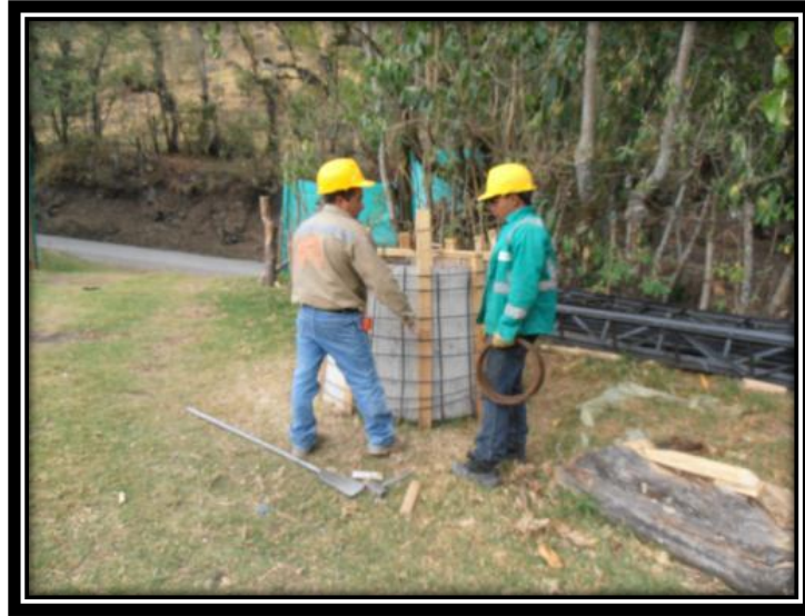
FIGURA 17: ARMADO DE ACERO PARA ANILLOS DE CAISOON.
