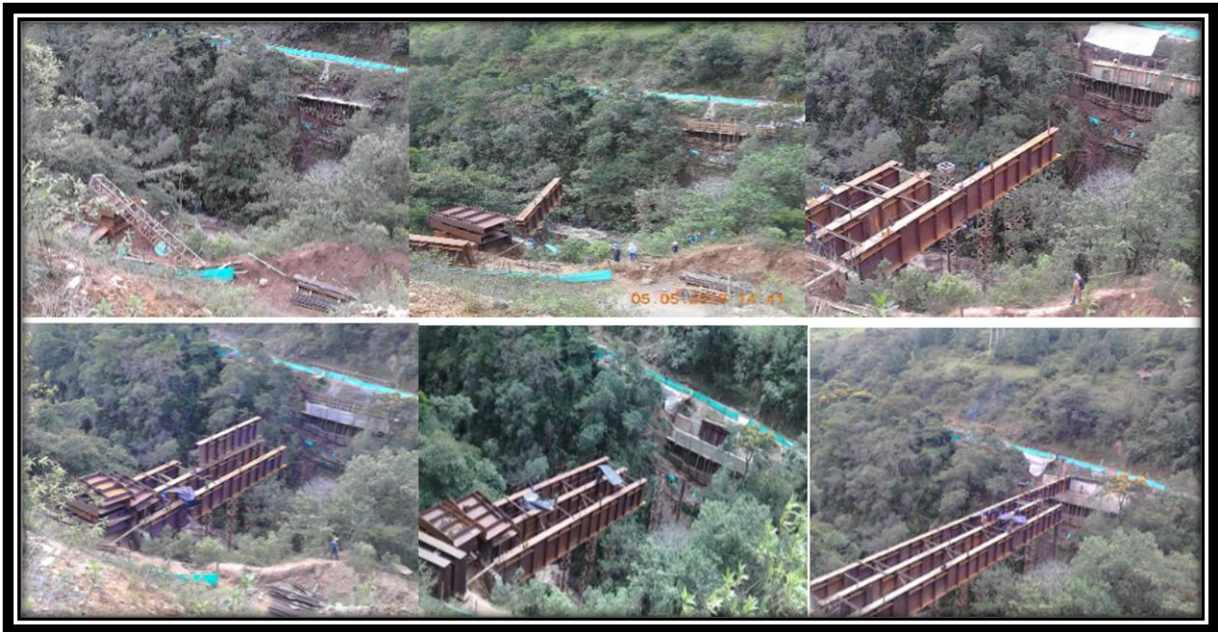
FIGURA 68: SECUENCIAS DEL PROCESO DE MONTAJE DE VIGAS METALICAS.
