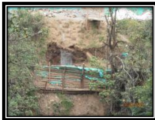
FIGURA 32: TRINCHO CONSTRUIDO EN GUADUA
