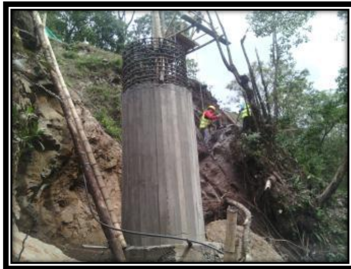
FIGURA 30: RETIRO DE FORMALETA
