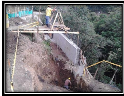
FIGURA 62: VASTAGO CENTRAL FUNDIDO ESTRIBO IZQUIERDO
