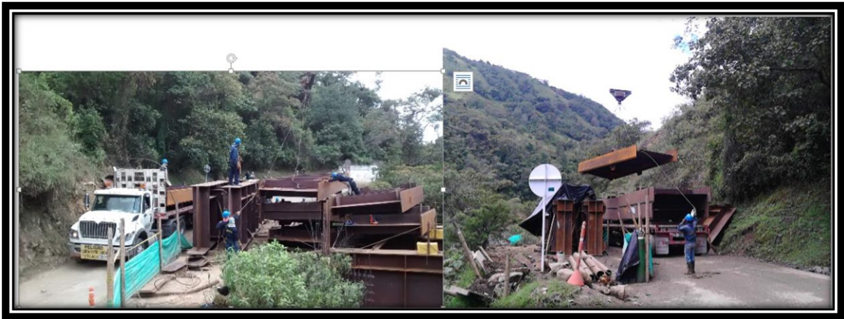
FIGURA 66: DESCARGUE DE VIGAS METALICAS EN EL FRENTE DE OBRA.
