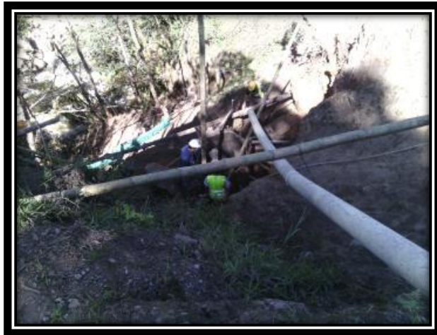
FIGURA 20: PROCESO DE VACIADO DE CONCRETO.
