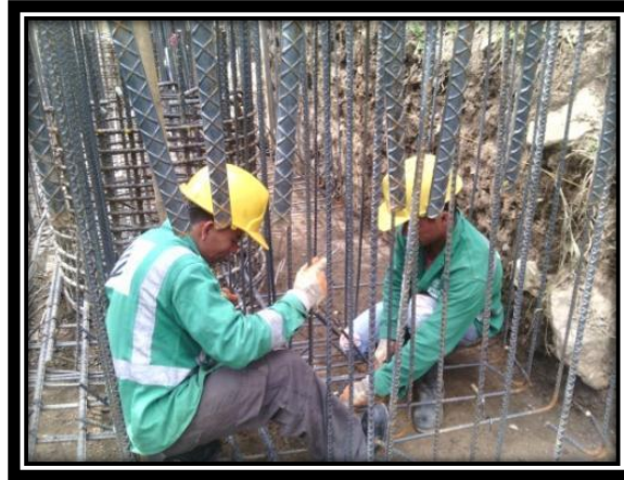
FIGURA 39: AMARRE DEL ACERO CON ALAMBRE CALIBRE 16.
