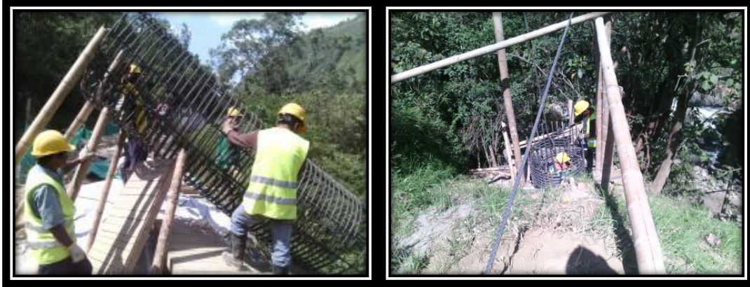
FIGURA 23: UBICACION DE REFUERZO PRINCIPAL DEL CAISSON
