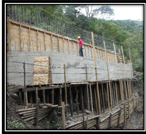
FIGURA 61: ESTRIBO IZQUIERDO FINALIZADO.
