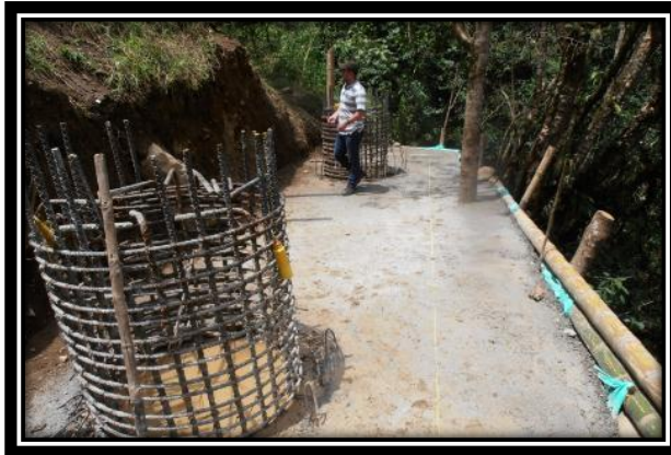
FIGURA 38: DEMARCAACION DE ESTRIBO CON PINTURA AMARILLA.
