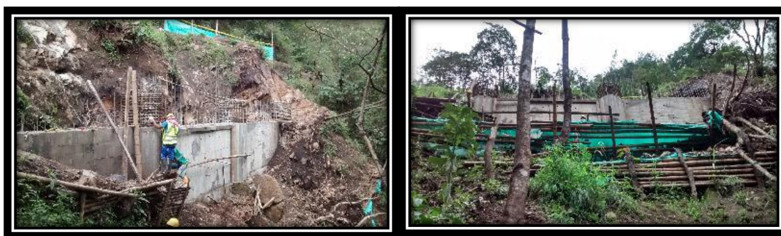
FIGURA 49: RETIRO DE FORMALETAFIGURA 50: MURO EN CONCRETO REFORZADO.
