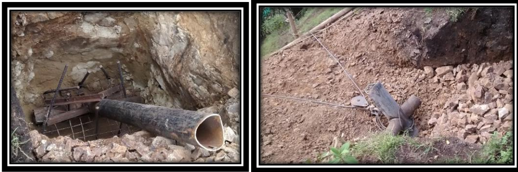
FIGURA 64: ANCLAJES USADOS EN EL SISTEMA DE MONTAJE
