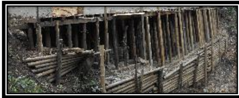
FIGURA 55: TACOS PARA SOPORTE DE PLATAFORMA DE MADERA.
