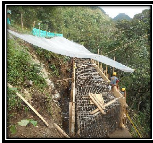
FIGURA 58: INSTALACION DE FORMALETA
