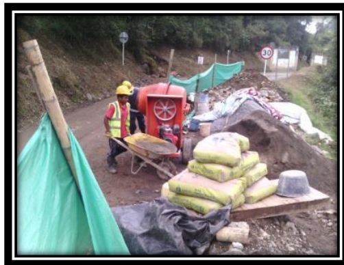
FIGURA34: ELABORACION DE SOLADO DE LIMPIEZA CON MEZCLADORA.
