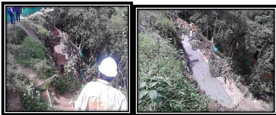
FIGURA 52: RELLENO FINALIZADO A NIVEL REQUERIDO FIGURA 53: COLOCACION DE SOLADO DE LIMPIEZA.
