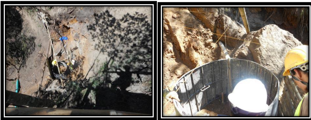
FIGURA 18: INSTALACIÓN DE FORMALETAS.FIGURA 19: UBICACIÓN FINAL DE FORMALETA.
