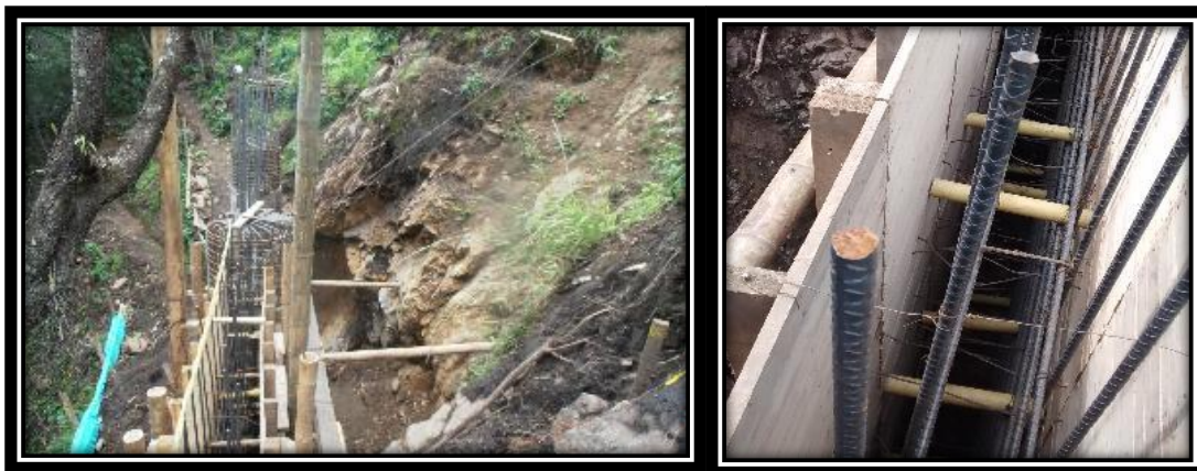
FIGURA 47: INSTALACION DE FORMALETA.FIGURA 48: LAGRIMALES DEL MURO.
