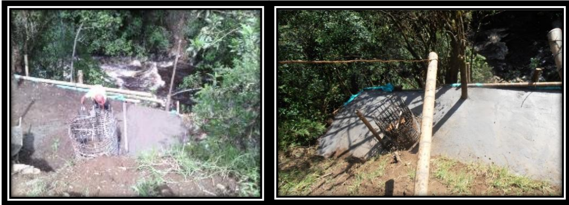
FIGURA35: COLOCACION DE SOLADO DE LIMPIEZA.FIGURA 36: SOLADO DE LIMPIEZA TERMINADO.
