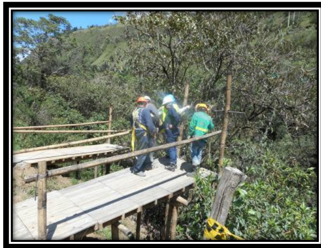
FIGURA 14: RETIRO DE MATERIAL COMUN USANDO MOLINETE
