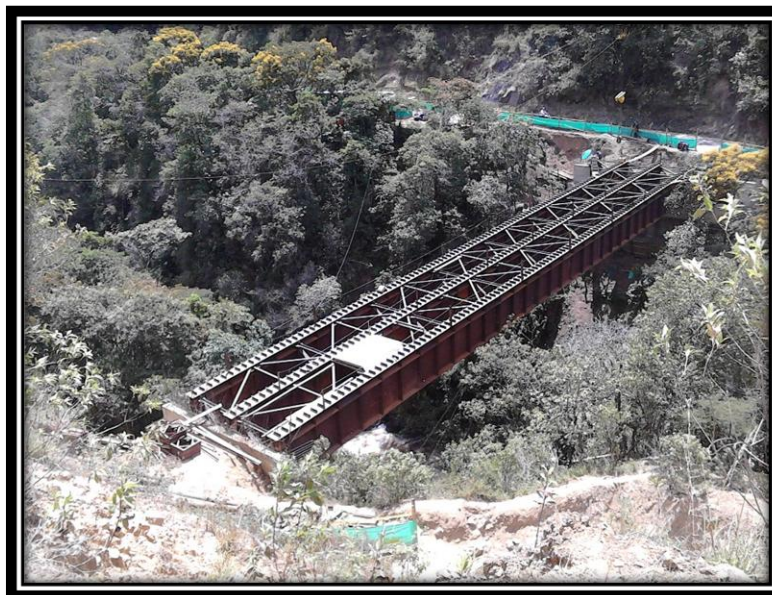
FIGURA 69: MONTAJE DE ESTRUCTURA METALICA FINALIZADO.
