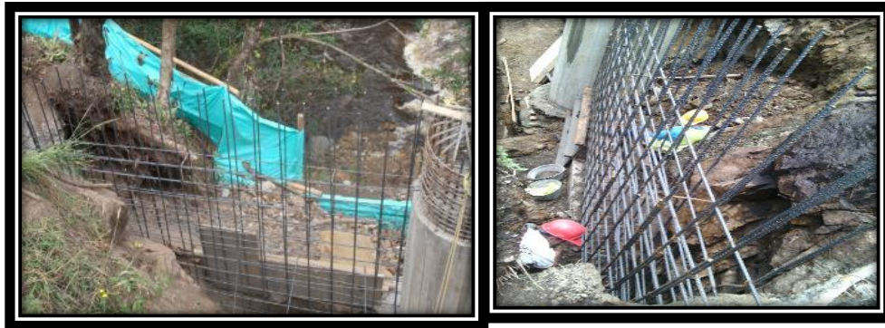
FIGURA 45: REFUERZO DE MURO EN CONCRETO.FIGURA 46: ANCLAJE DE HIERROS EN CAISSON.
