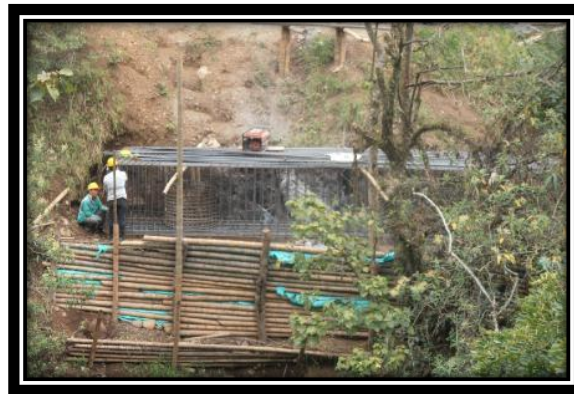
FIGURA40: REFUERZO DE ESTRIBO FINALIZADO.
