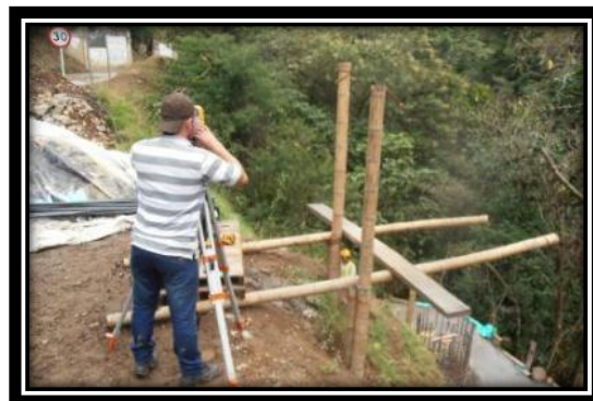
FIGURA 37: LOCALIZACION Y REPLANTEO CON ESTACION TOTAL.
