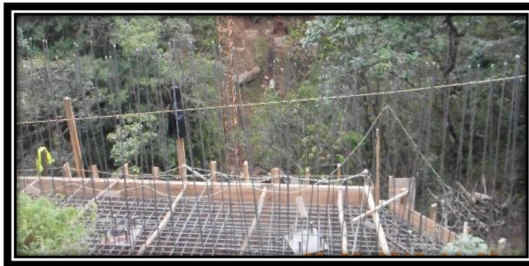
FIGURA 59: ANCLAJES PARA APOYO MÓVIL
