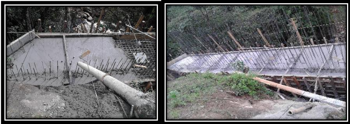
FIGURA 60: PROCESO DE VACIADO DEL CONCRETO PREMEZCLADO.
