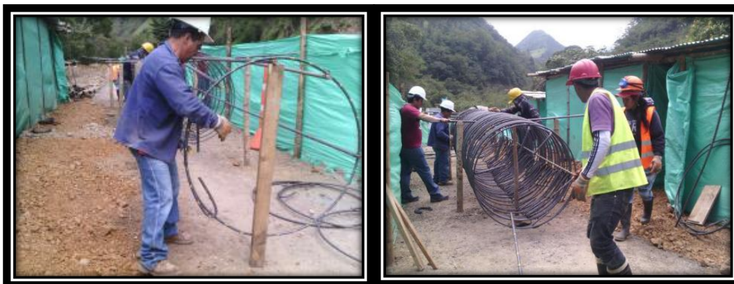
FIGURA 22: PROCESO DE ARMADO DE REFUERZO PRINCIPAL.
