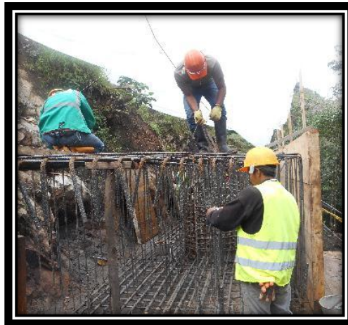
FIGURA 57: AMARRE DE ACERO CON ALAMBRE CALIBRE 16.
