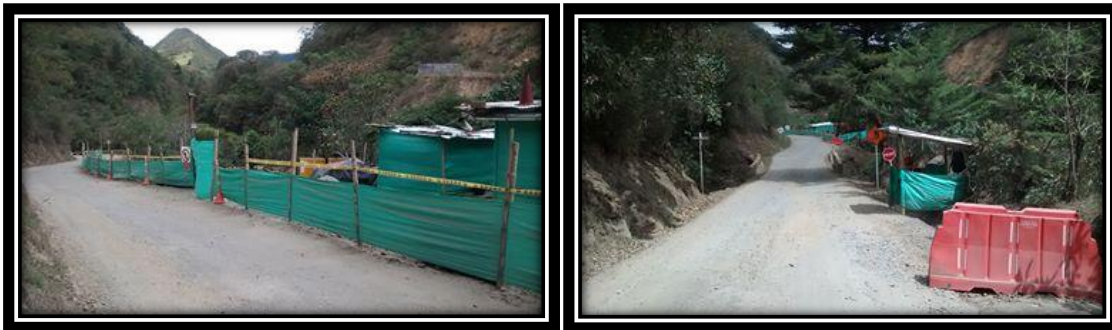
FIGURA 9: CERRAMIENTO FRENTE DE OBRA.FIGURA 10: CONTROL DE TRÁNSITO VEHICULAR.
