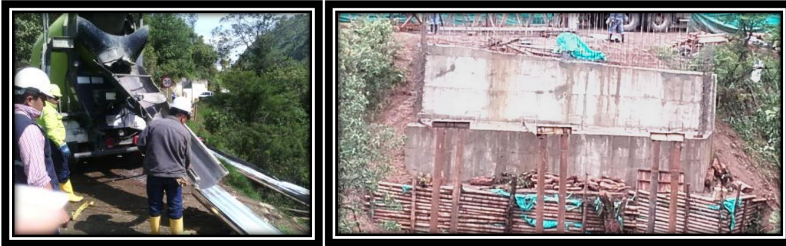
FIGURA 43: VACIADO DE CONCRETO CON MIXER.FIGURA 44: ESTRIBO DERECHO FINALIZADO
