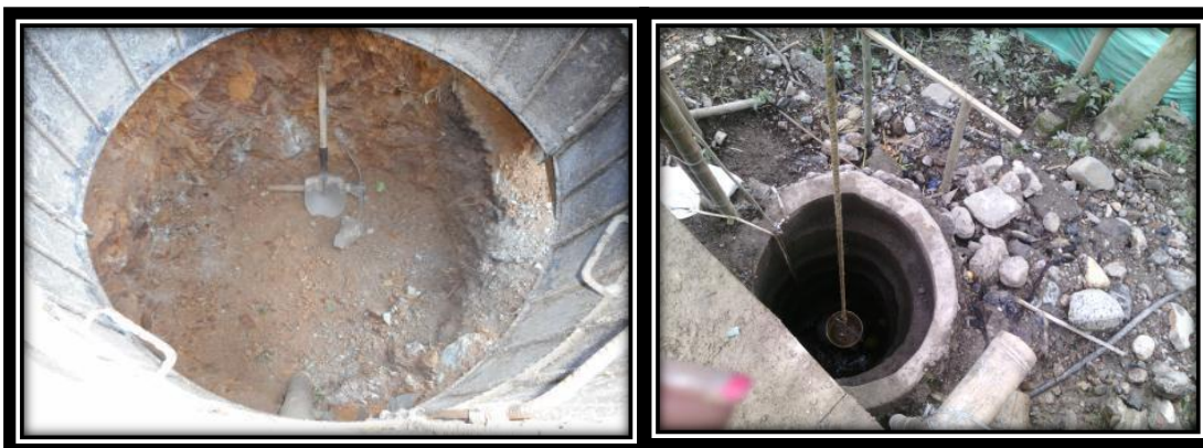
FIGURA 15: EXCAVACION EN MATERIAL COMÚN.
