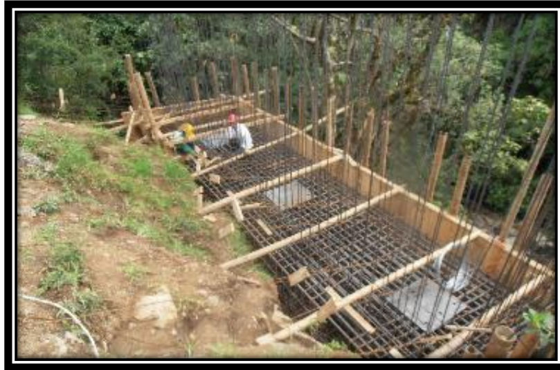
FIGURA 41: PLATINAS DE POSICIONAMIENTO PARA ANCLAJES DE APOYOS FIJOS.
