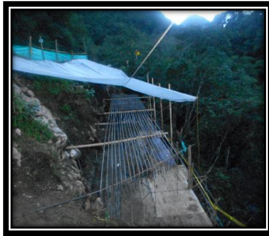
FIGURA 56: PROCESO DE ARMADO DE ACEROS DE REFUERZO.
