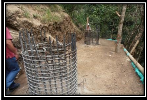
FIGURA 33: TERRENO NIVELADO CON MATERIAL SELECCIONADO.
