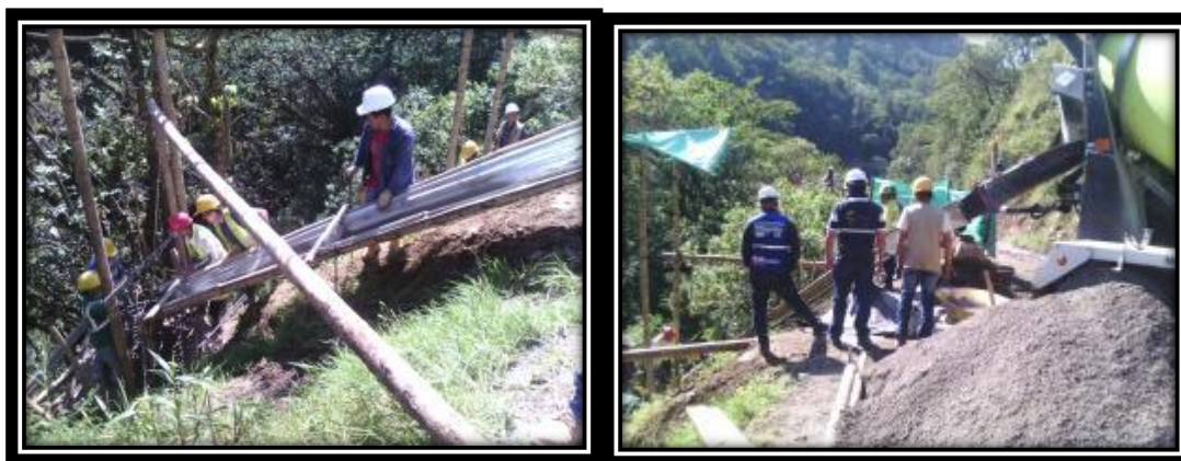
FIGURA 25: PROCESO DE VACIADO DE CONCRETO FIGURA 26: TOMA DE MUESTRAS DE CONCRETO.
