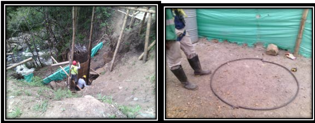
FIGURA 28: INSTALACION DE FORMALETA FIGURA 29: ANILLO DE ACERO PARA FORMALETA
