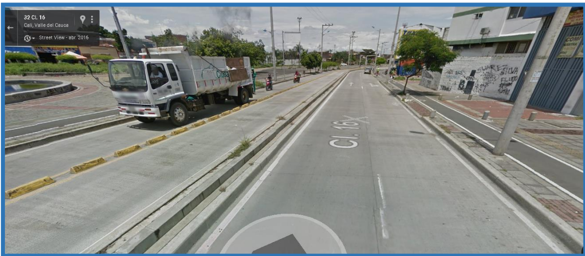
Figura 21 Calle 16, doble calzada-calzada MIO. Imagen tomada de Google Earth.
