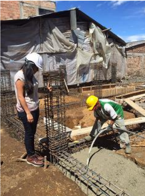
Figura No 11. Fundición de la cimentación. Fuente: Propia.
