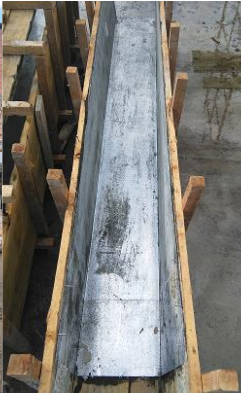
Figura No 14. Formaleta de columna.
