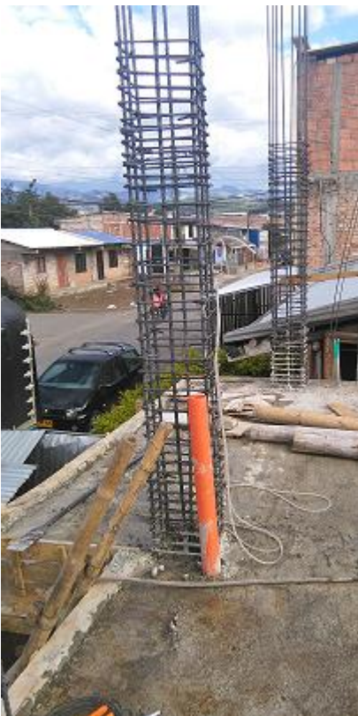
Figura No 13. Refuerzo en las columnas.
