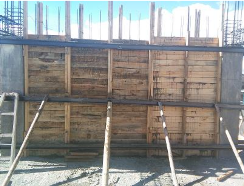
Figura No19. Desencofre de pantallas. Fuente: Propia.
