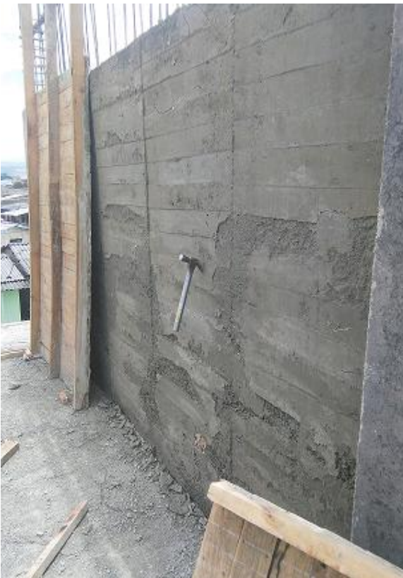
Figura No20. Curado del concreto de pantallas. Fuente: Propia.
