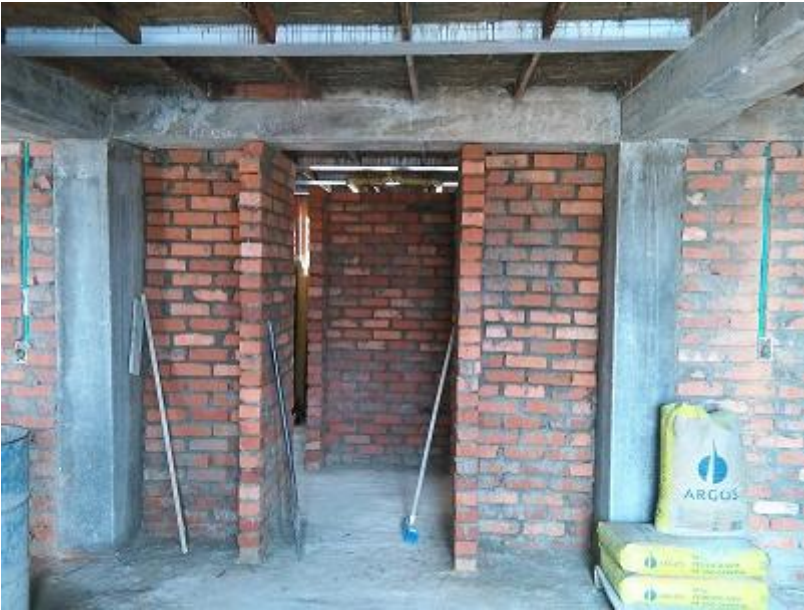
Figura No 26. Distribución de elementos no estructurales. Fuente propia.
