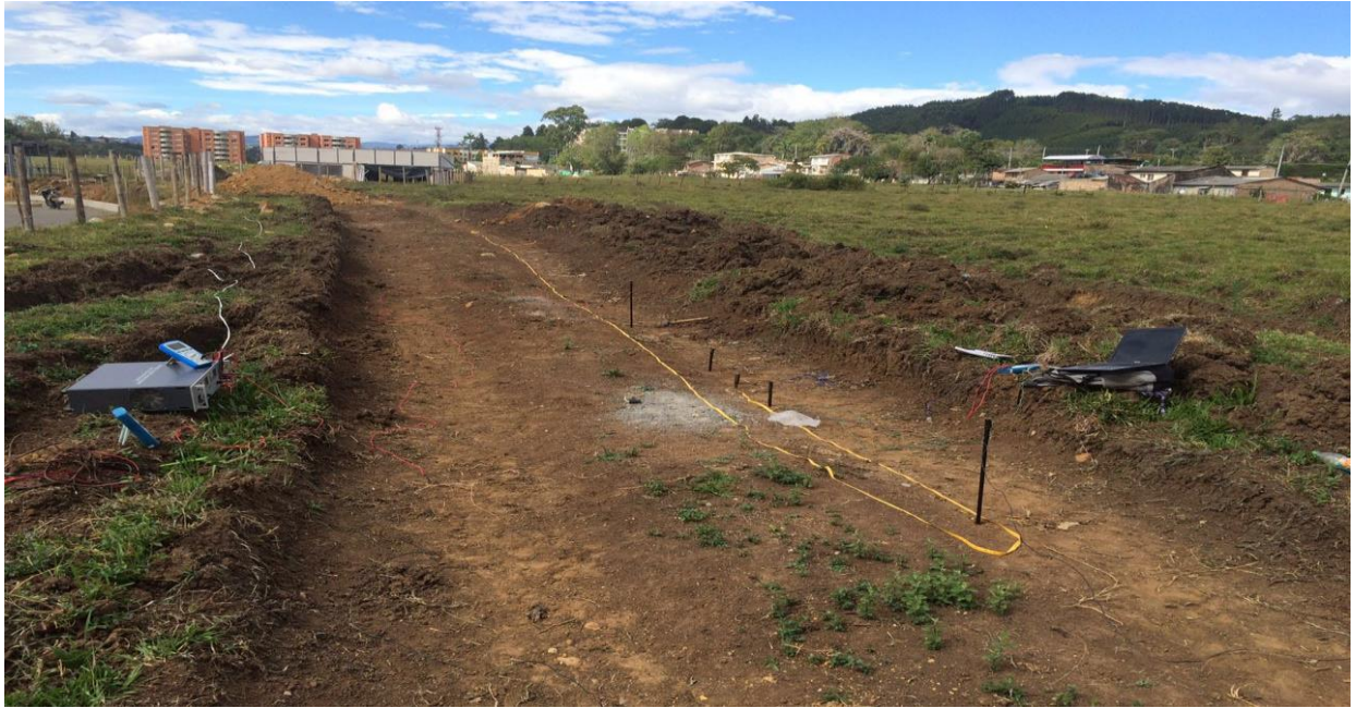
Figura 41. Fotografía general de dispositivos para sondeo eléctrico vertical (Agosto 2016)
