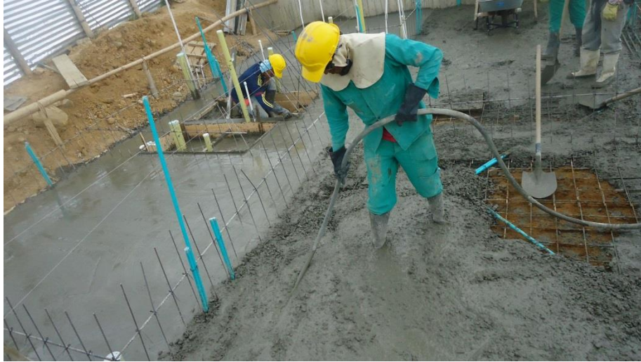
Figura No. 33 Vibrado del concreto
