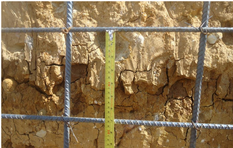
Figura No. 38 Chequeo de acero transversal
