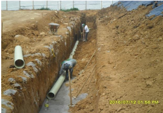
Figura No. 22. Instalación de tubería para alcantarillado
