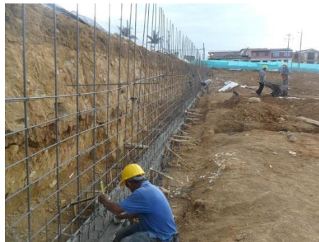
Figura No. 28 Vigas de cimentación
