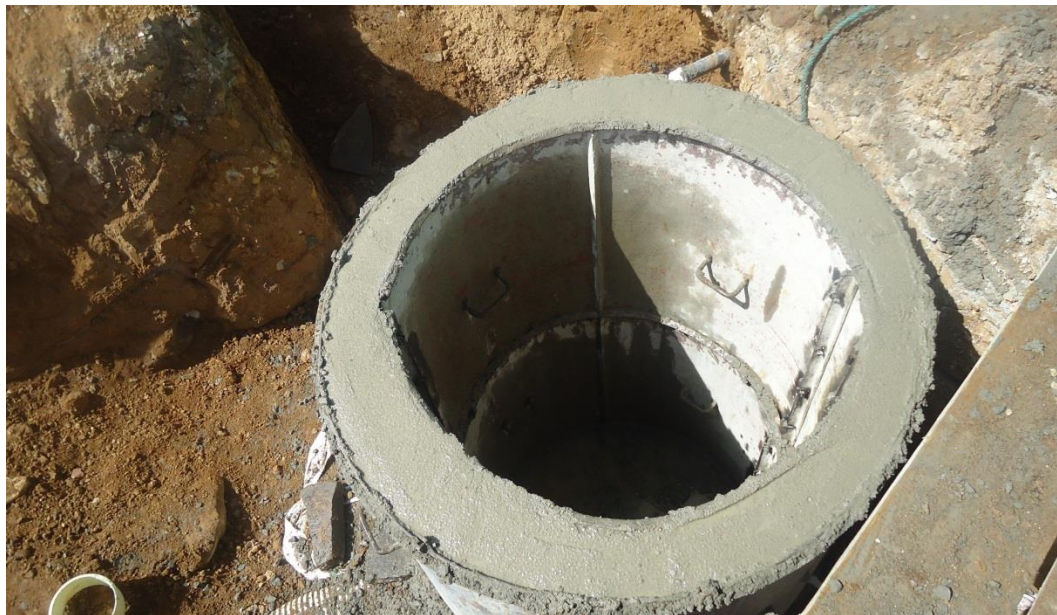
Figura No. 24 Fundición de cámaras de inspección.
