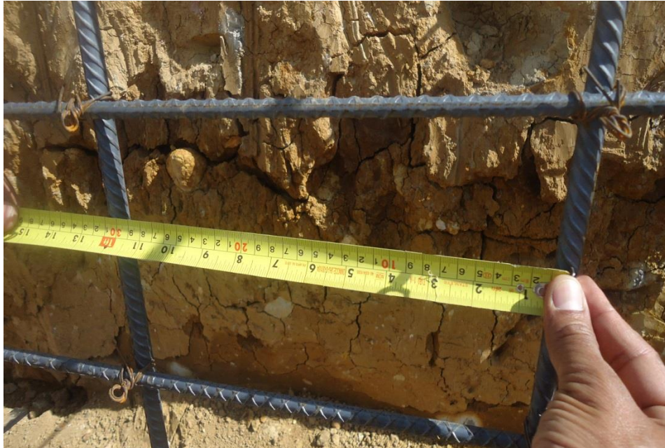
Figura No.37 Chequeo de acero longitudinal
