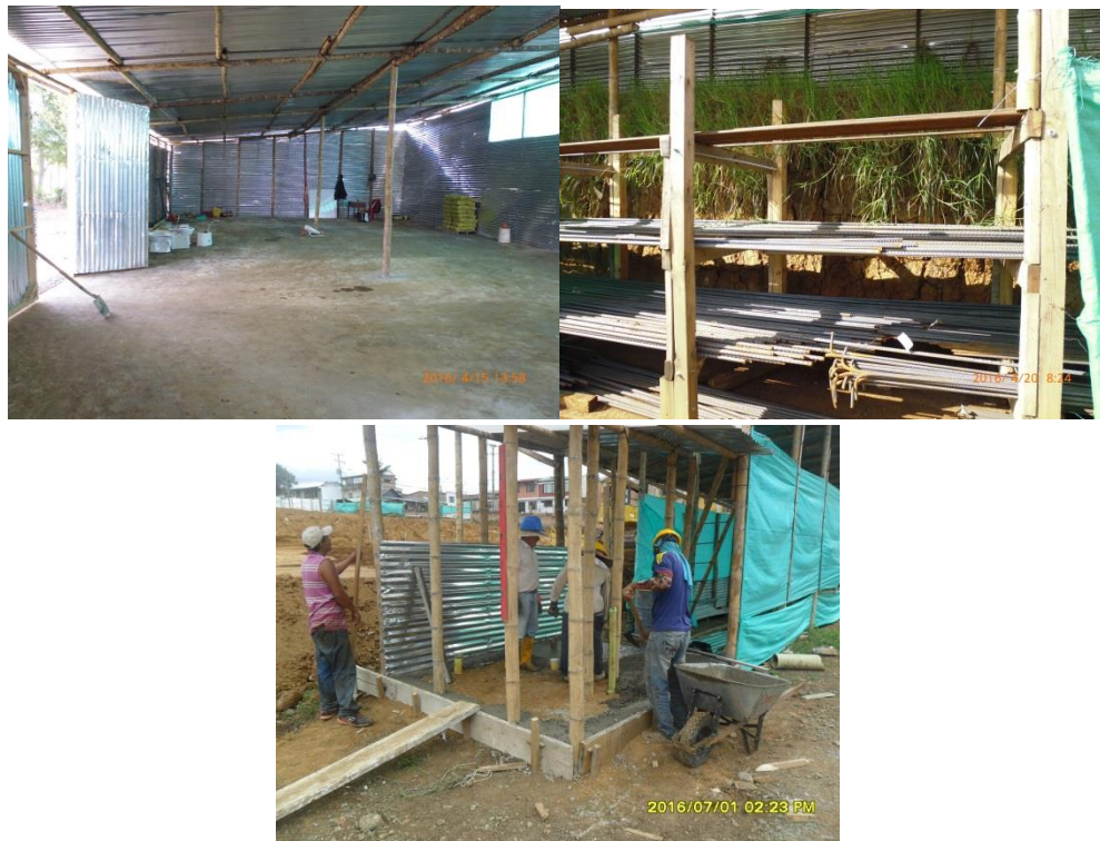
Figura No. 12 Instalaciones provisionales
