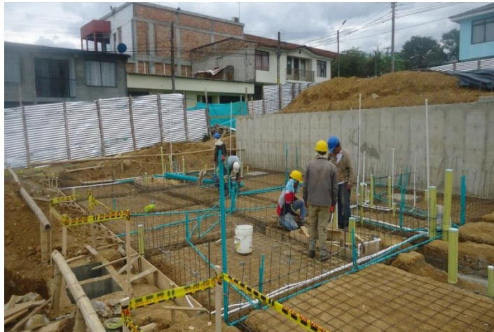
Figura No. 32 Instalación de red eléctrica, sanitaria, hidráulica y de gas.
