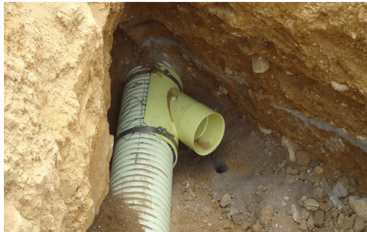
Figura No. 25 Instalación de sillas yee
