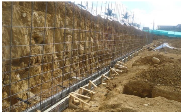
Figura No.36 Colocación de refuerzo para muro de contención
