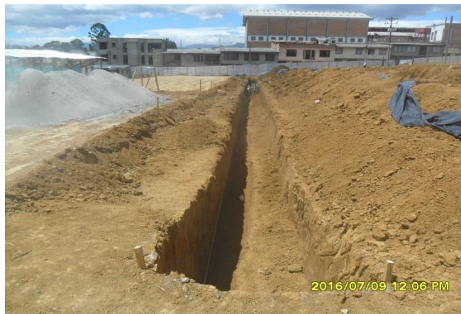
Figura No. 20. Excavaciones para alcantarillado
