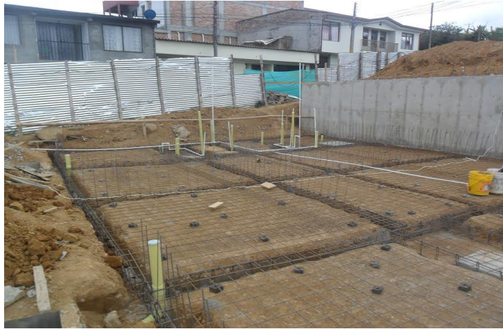
Figura No. 31 Malla electro soldada colocada con paneles
