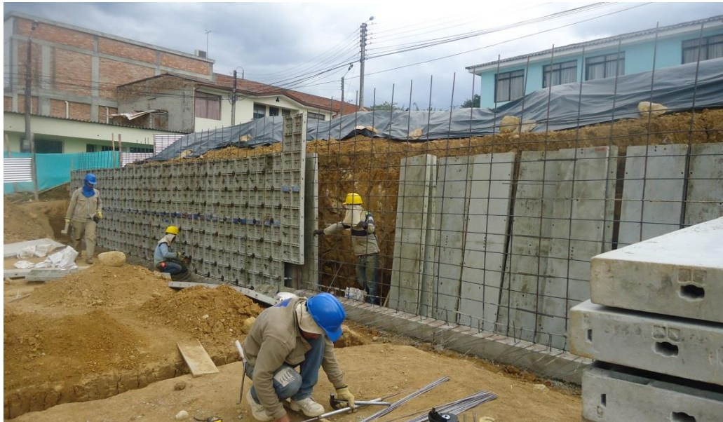
Figura No. 40 Formaleta para fundición de muros de contención
