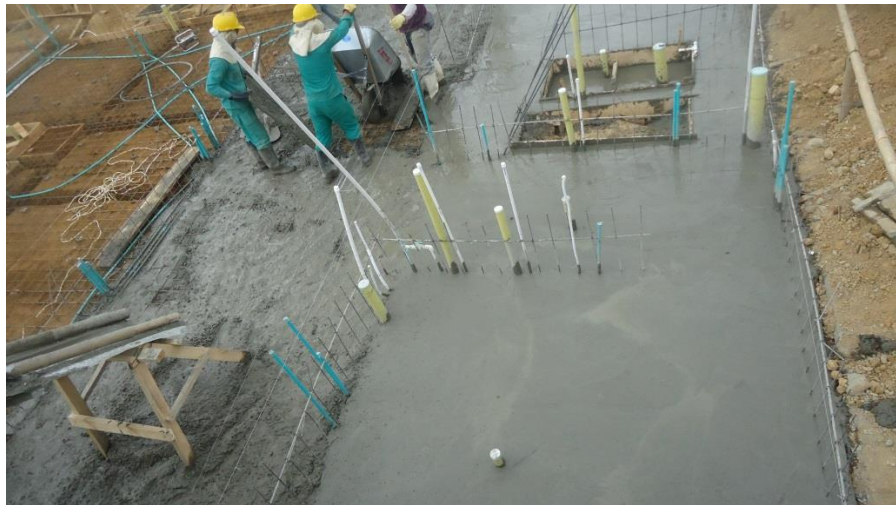
Figura No. 34 Acabado de la losa.
