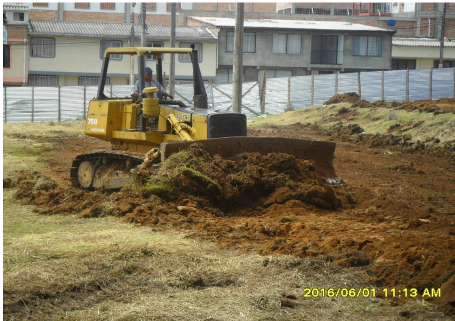
Figura No. 11 Retiro de material
