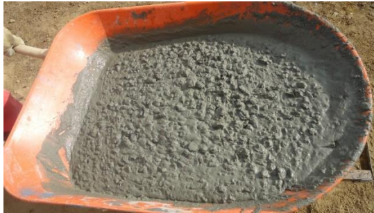
Figura No.48 Toma de muestras de concreto para la realización de cilindros y ensayos de asentamiento
