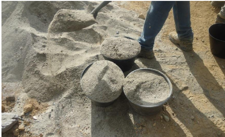
Figura No. 44 Arena utilizada para concreto
