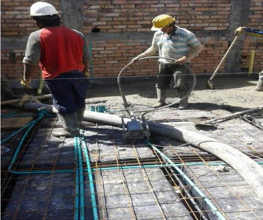
**Figura 82. Vibrado en losas**
