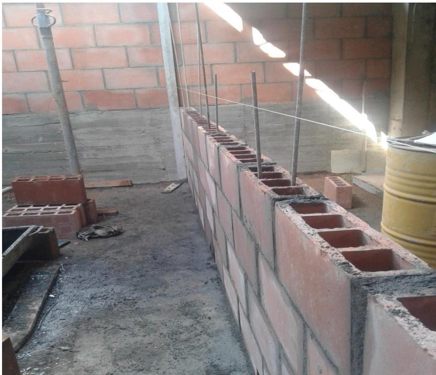
**Figura 94. Escuadras y plomos en la construcción de muros**
