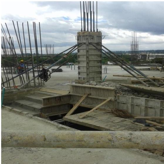
Figura 48. Encofrado de columnas
