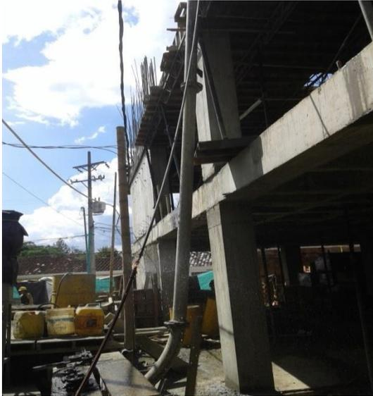
**Figura 56. Tubería para concreto**
