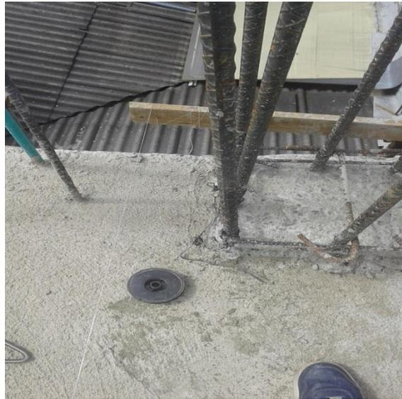
**Figura 45. Replanteo ejes de columna**
