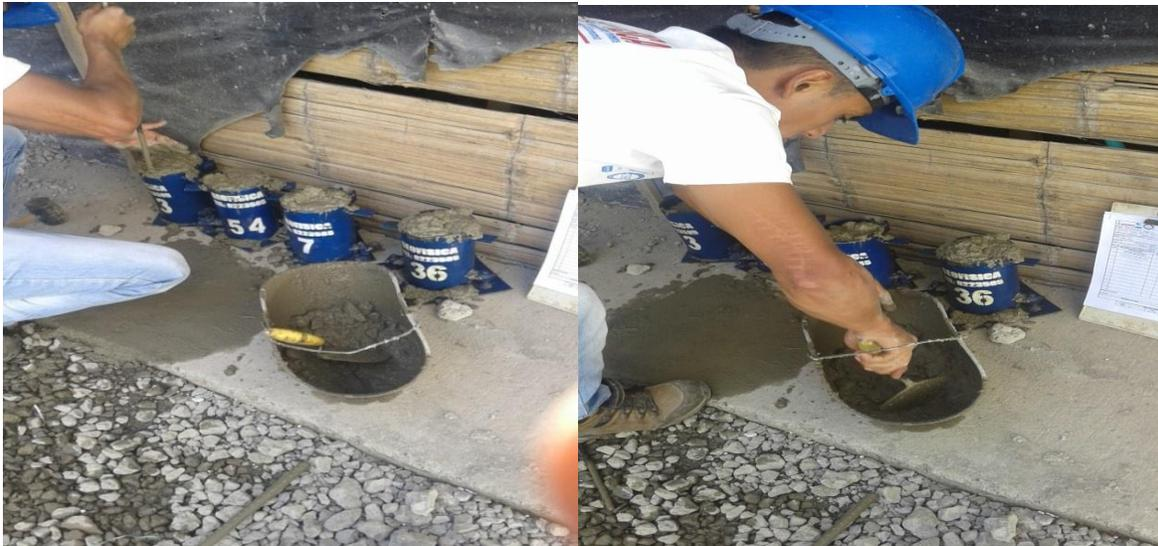
**Figura 34. Toma de cilindros de concreto 2**
