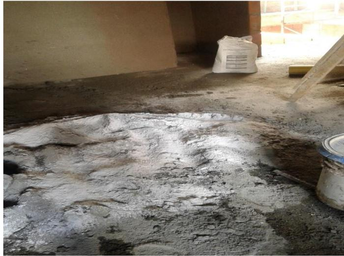
**Figura 88. Mezcla manual de los materiales para mortero**
