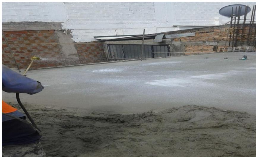
**Figura 85. Curado de losas con aditivo antisol**
