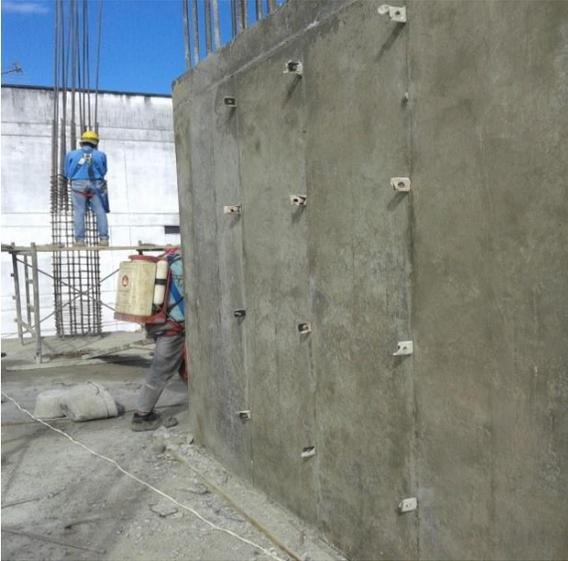
Figura 59. Desencofrado en pantalla
