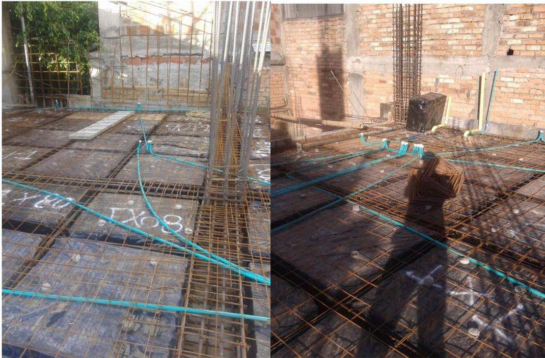
Figura 73. Tubería eléctrica embebida en la losa
