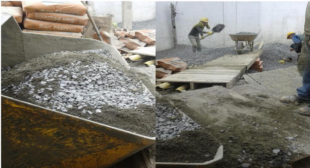
**Figura 78. Materiales para fundición de losas**
