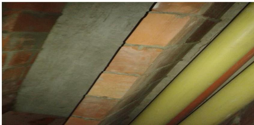
**Figura 77. Buitrón para tuberías**
