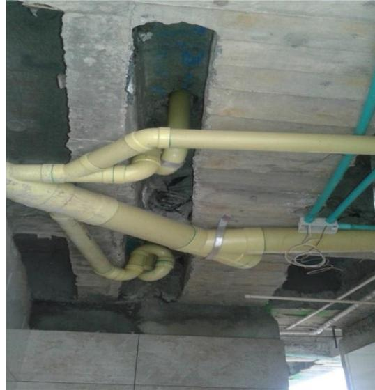
**Figura 75. Red hidráulica embebida****Figura 76. Red hidráulica por cielo**
