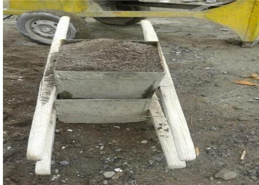
**Figura 27. Cajones para agregados**
