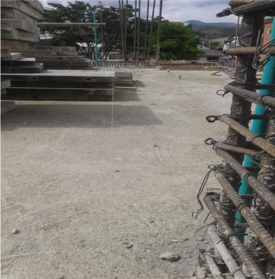
**Figura 44. Hilos de ejes de columna**
