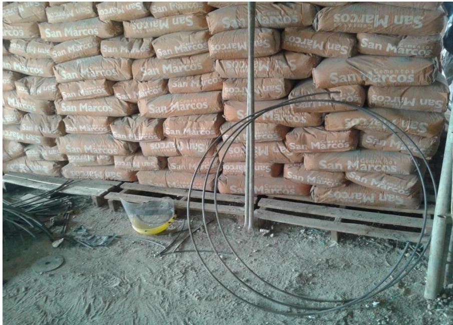
**Figura 10. Almacenamiento del cemento**
