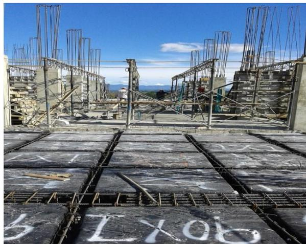
**Figura 72. Colocación de casetones**
