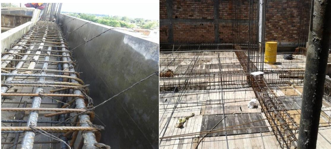
**Figura 64. Colocación del refuerzo en vigas**
