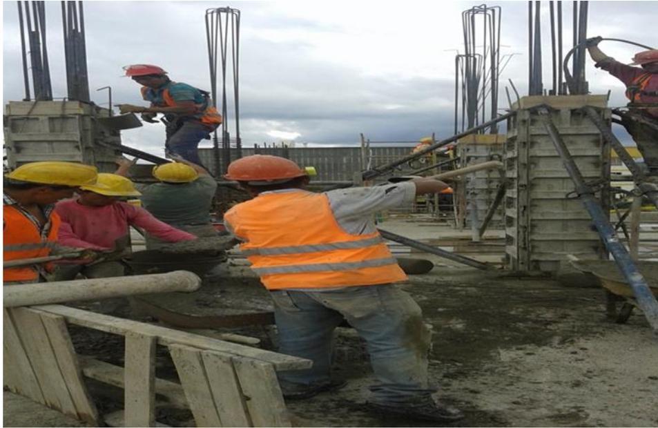
**Figura 58. Vibrado del concreto en columnas**
