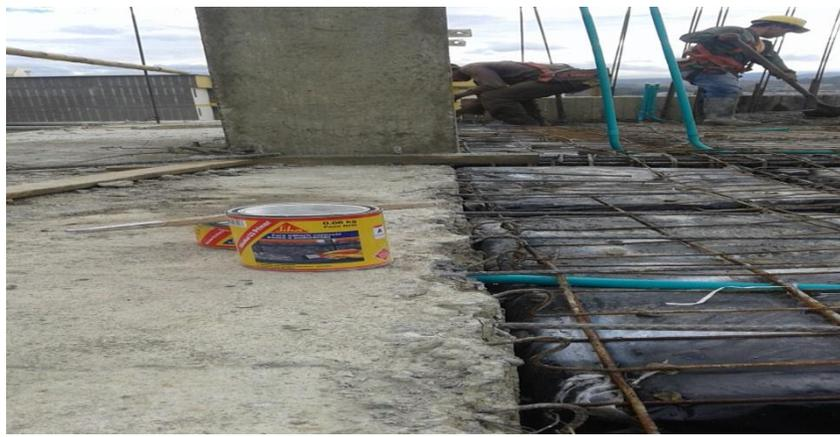
**Figura 81. Adherencia entre concreto fresco y endurecido**
