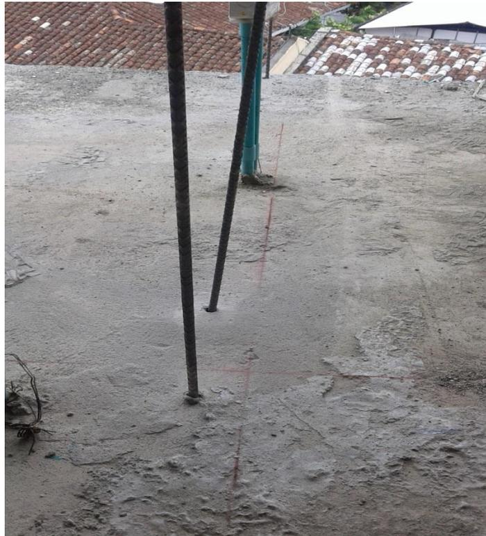
**Figura 91. Refuerzo vertical en varilla 3/8" y anclajes**
