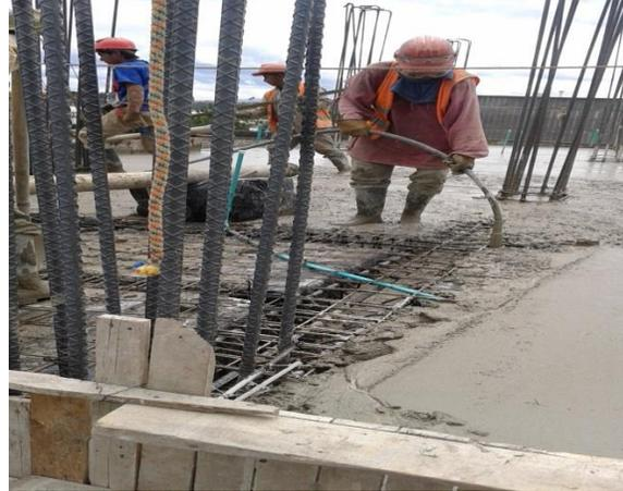
**Figura 83. Vibrado en vigas**
