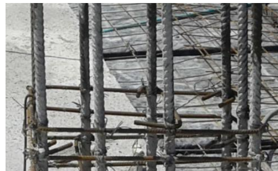
Ilustración 23. Ganchos en columnas.
