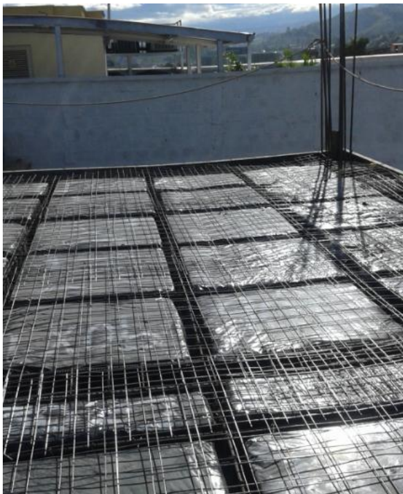
Ilustración 30. Refuerzo de retracción y temperatura en losa aligerada.
