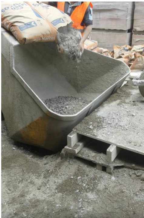
Ilustración 43. Equipo de mezcla y bombeo de concreto.
