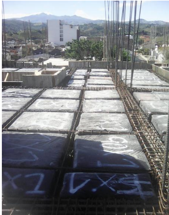
Ilustración 38. Ubicación de casetones de icopor.
