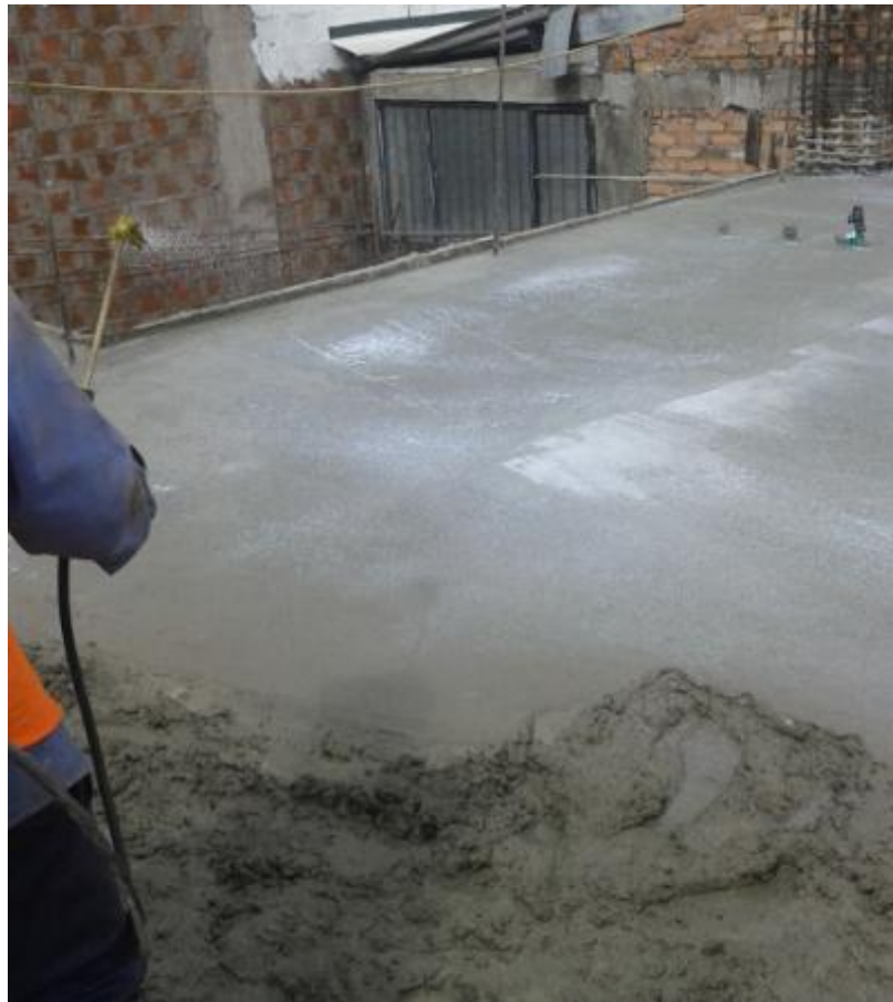
Ilustración 56. Curado del concreto.
