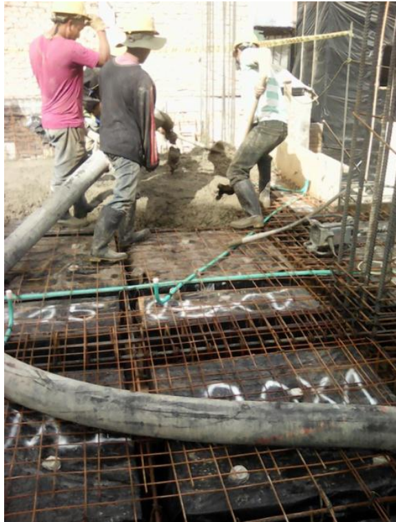
Ilustración 52. Colocación del concreto tipo trompa de elefante.
