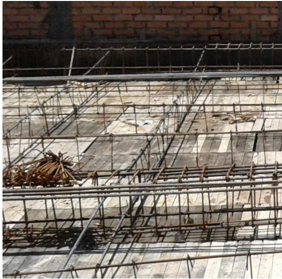
Ilustración 29. Acero de refuerzo en nervios de losas de entrepiso.
