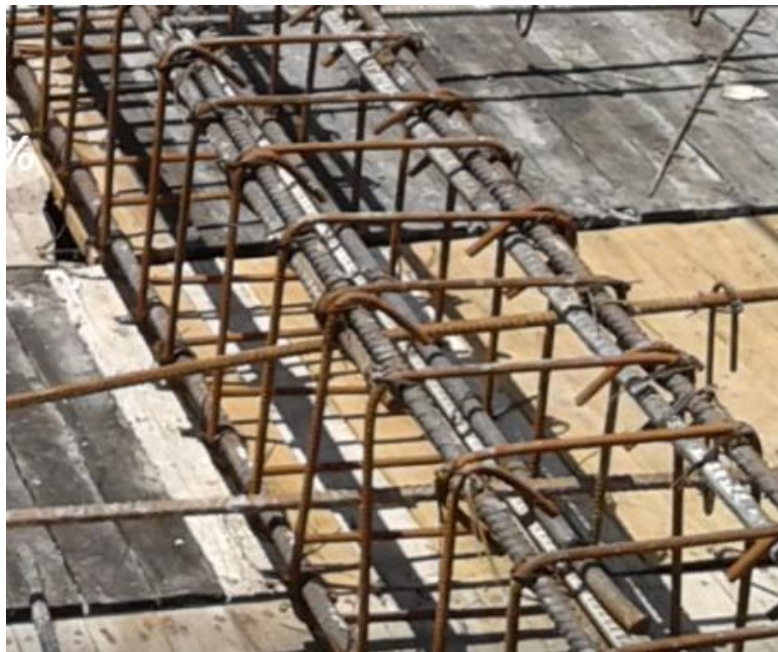
Ilustración 25. Ubicación de estribos en vigas.
