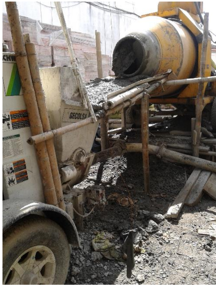
Ilustración 42. Equipo de mezcla y bombeo de concreto.
