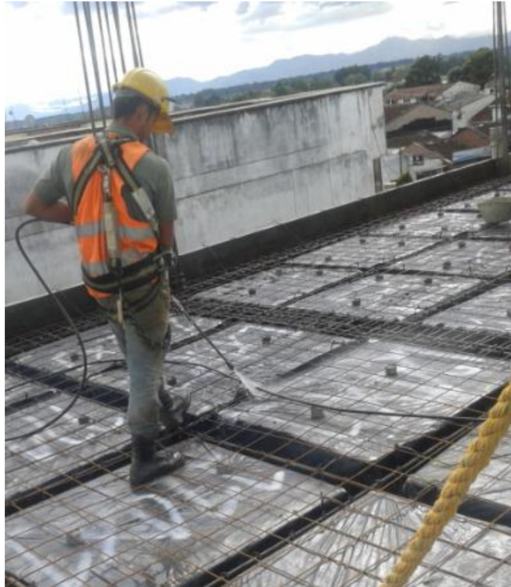
Ilustración 51. Preparación del área de fundición del concreto.
