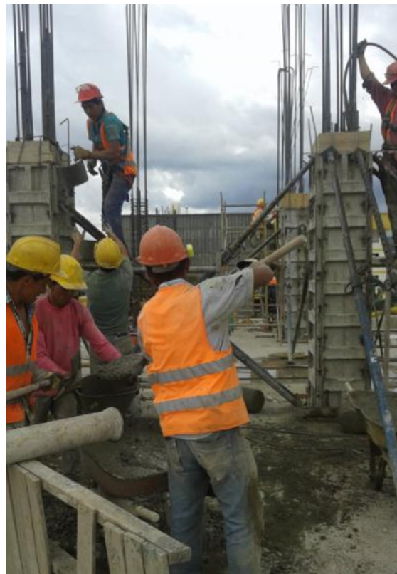
Ilustración 55. Colocación y vibrado de concreto en columnas.
