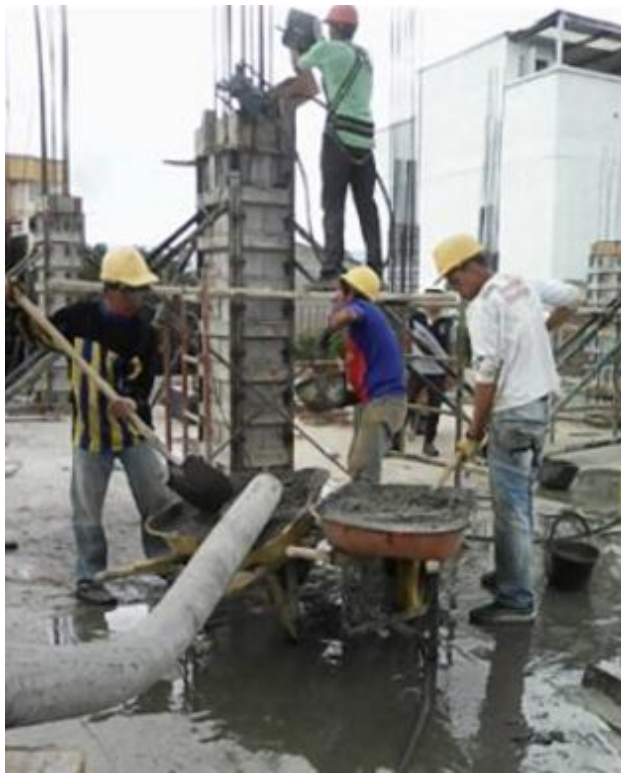
Ilustración 53. Colocación del concreto en columnas.
