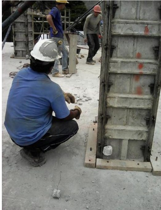
Ilustración 35. Chequeos de verticalidad de encofrado de columnas.
