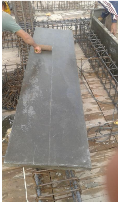
Ilustración 32. Aplicación de Sika separol.
