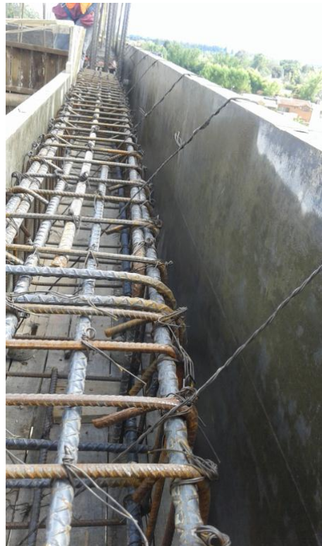
Ilustración 37. Encofrado de vigas de entrepiso.
