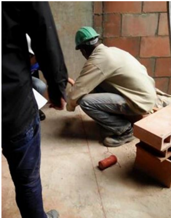
Ilustración 59. Replanteo de muros.
