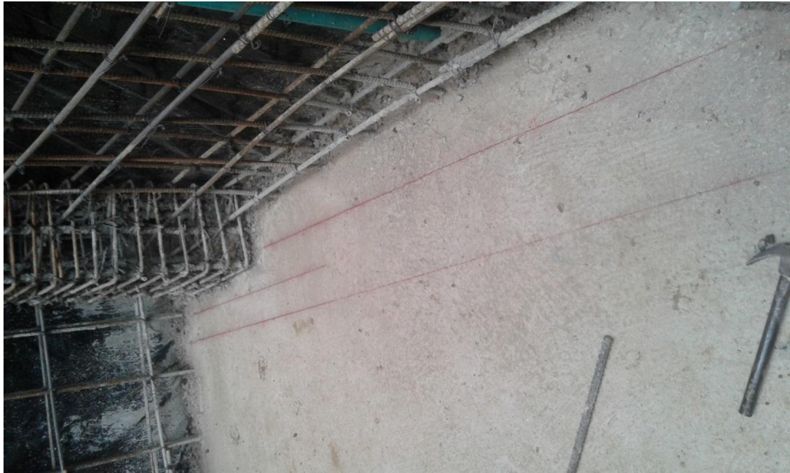
Ilustración 22. Trazado de cimbras para el replanteo de columnas y pantallas.
