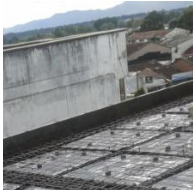
Ilustración 30. Refuerzo de retracción y temperatura en losa aligerada.
