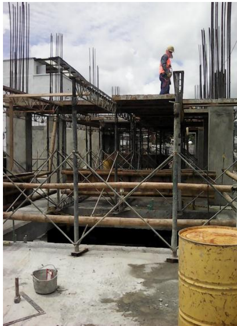
Ilustración 36. Encofrado de losa de entrepiso.
