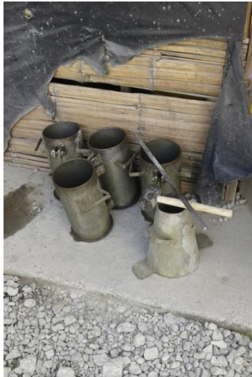
Ilustración 45. Equipo para realizar ensayos de control de concreto fresco.
