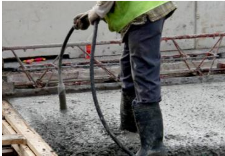
Ilustración 54. Vibrado interno en losas de entrespiso.
