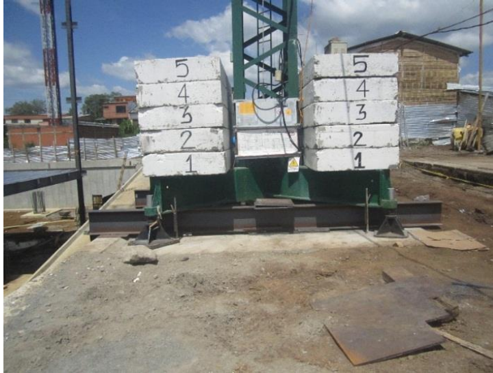
Figura 67. Nivelación de la torre grúa
