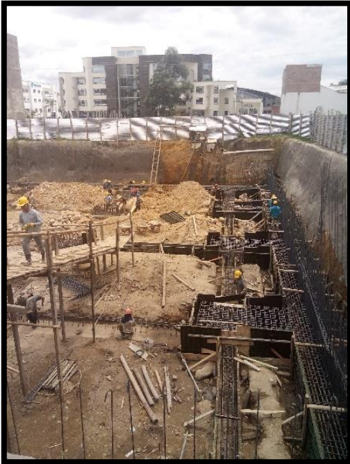
Figura 6. Estado de la obra 1, 27/08/2015
