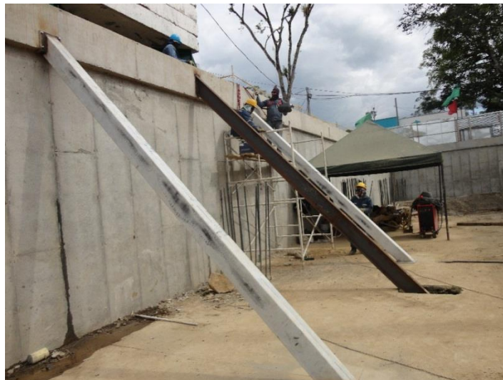
Figura 68. Apuntalamiento de la viga corona
