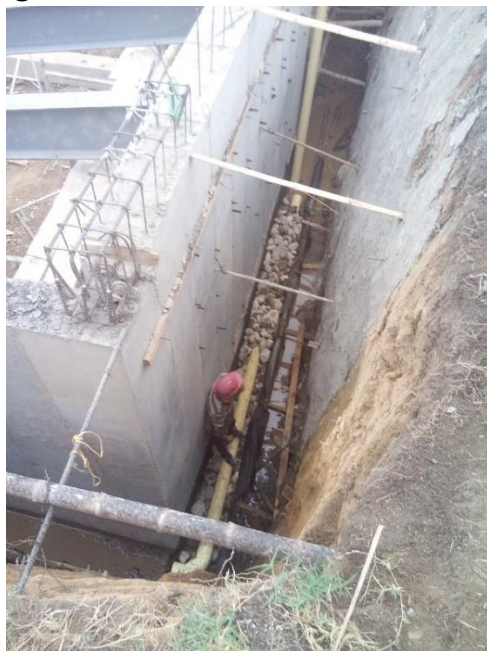
Figura 54. Colocación de tubería novafort para subdrén perimetral
