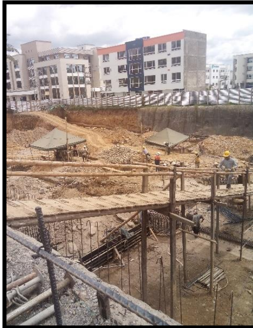
Figura 7. Estado de la obra 2, 27/08/2015
