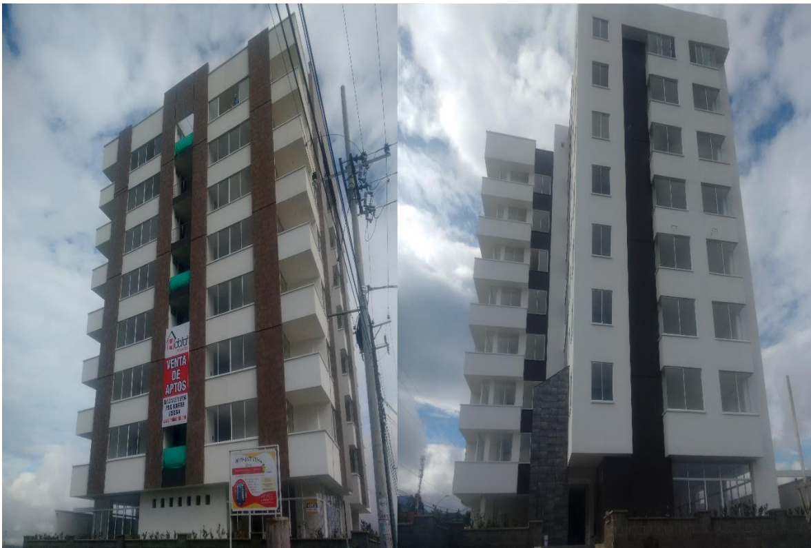
Figura 28. Enchapes En Fachada. Fuente Autor
