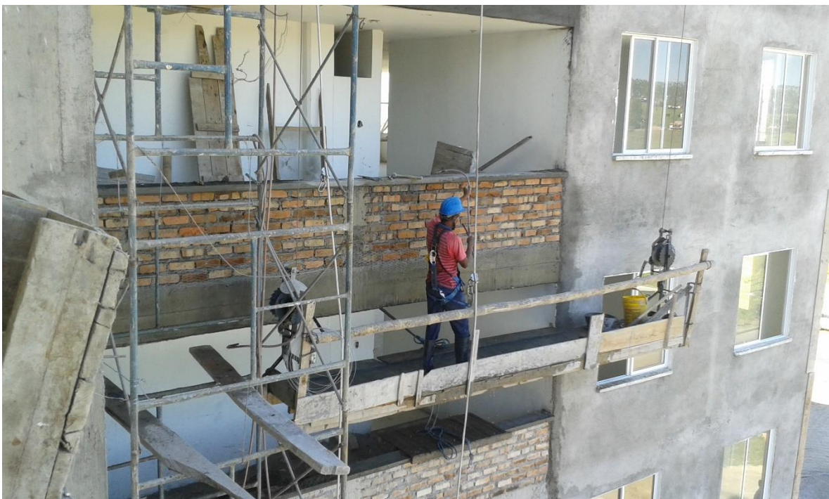
Figura 27. Repello Liso Sobre Fachada. Fuente Autor
