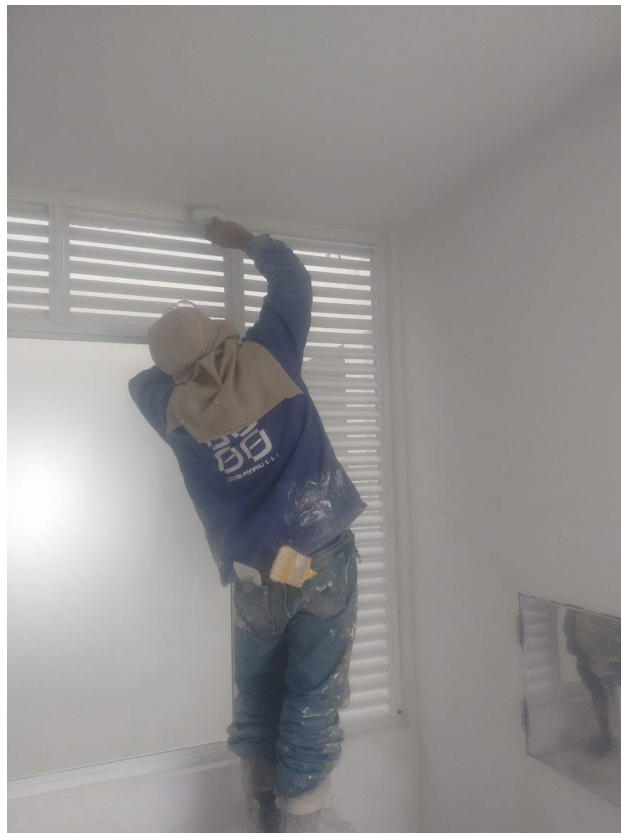
Figura 22. Pintura Blanca Sobre Muros. Fuente Autor
