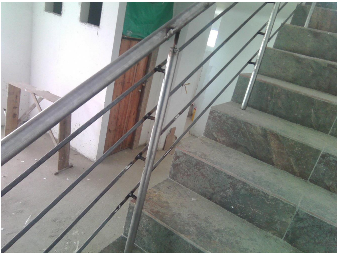
Figura 13. Reconocimiento Primer Piso. Fuente Autor
