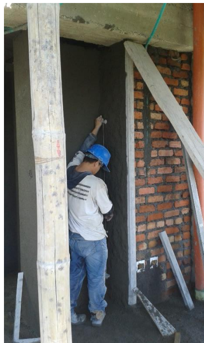
Figura 17. Repello de muro. Fuente Autor
