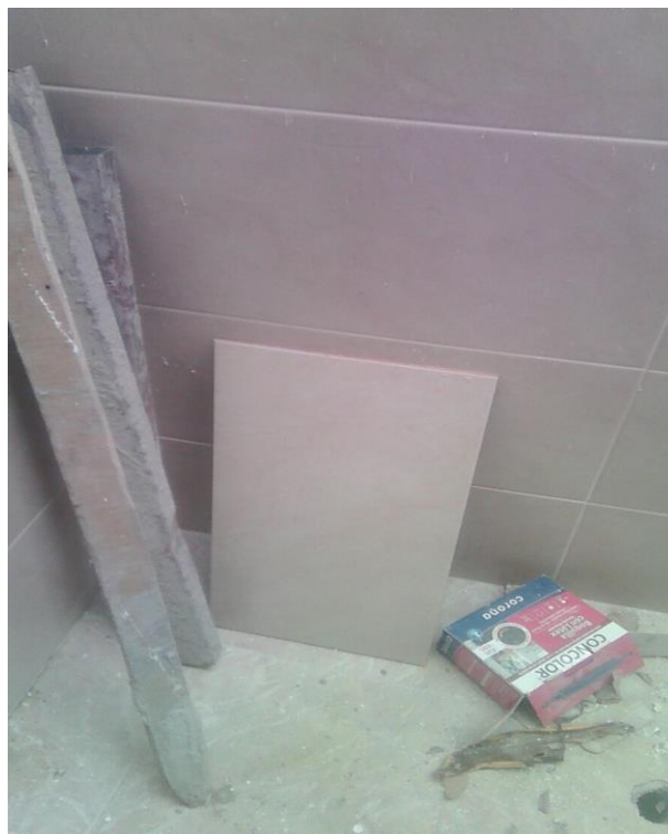
Figura 20. Enchapado De Pisos. Fuente Autor
