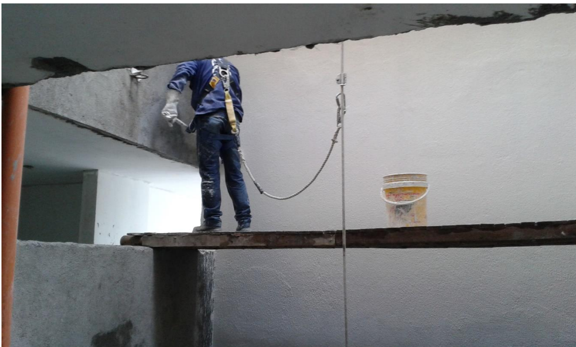
Figura 32. Supervisión De Obra. Fuente Autor
