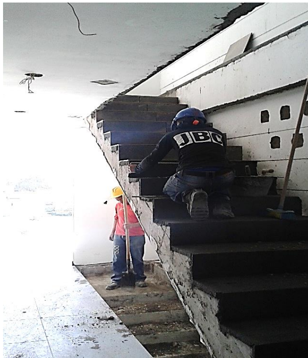
Figura 19. Nivelación De Piso Con Mortero. Fuente Autor
