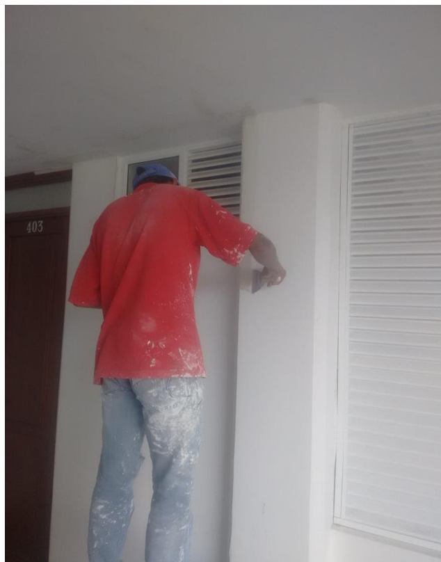
Figura 18. Estucado Sobre Muros. Fuente Autor
