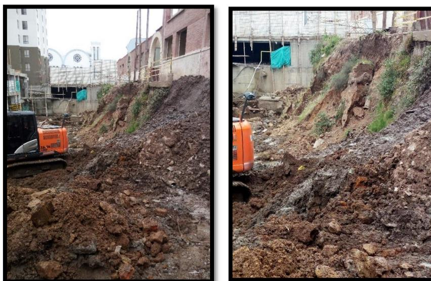
**Figura 82. Excavación de terreno- Movimiento de tierra**
