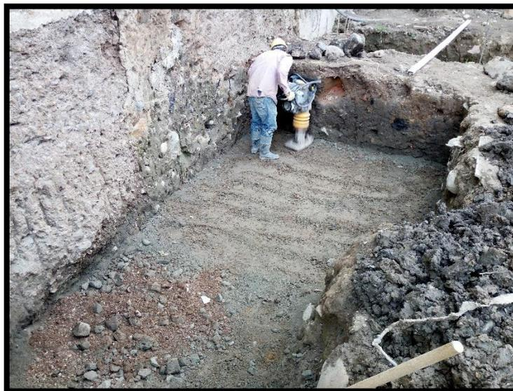
Figura 86. Compactación del material para el mejoramiento del suelo.
