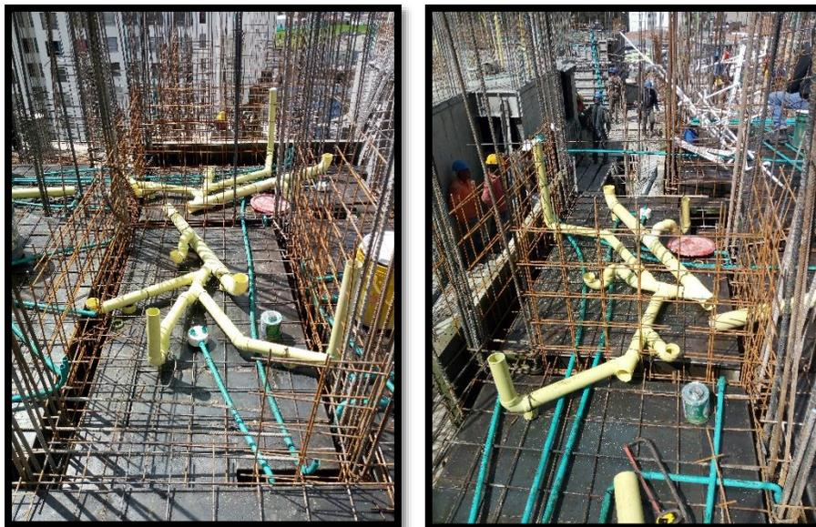
**Figura 28. Instalación de tubería sanitaria.**
