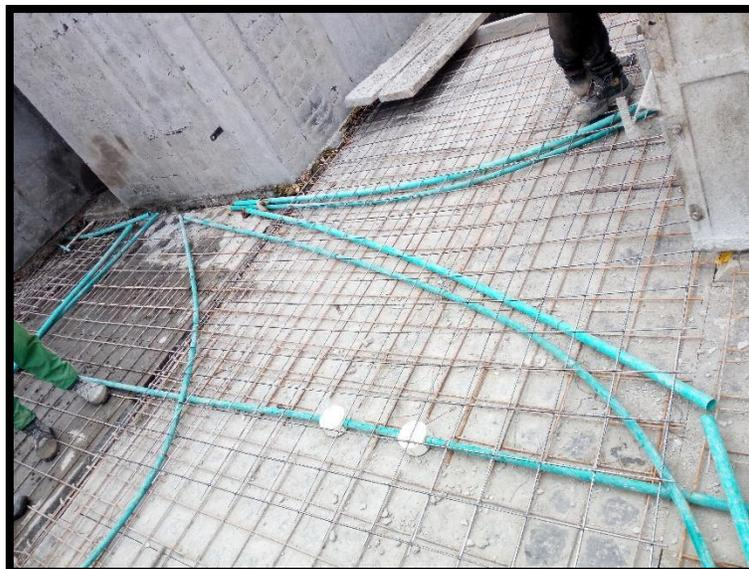
Figura 43. Malla electro soldada en el punto fijo.
