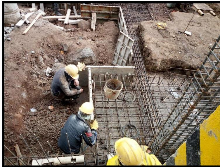
Figura 89. Armado de zapata.
