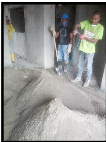
**Figura 54. Preparación del material para el afinado de pisos.**
