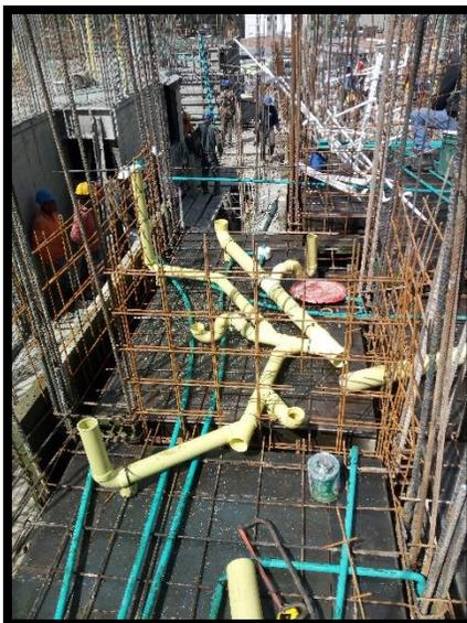
**Figura 41. Tubería sanitaria en la formaleta de FORSA.**
