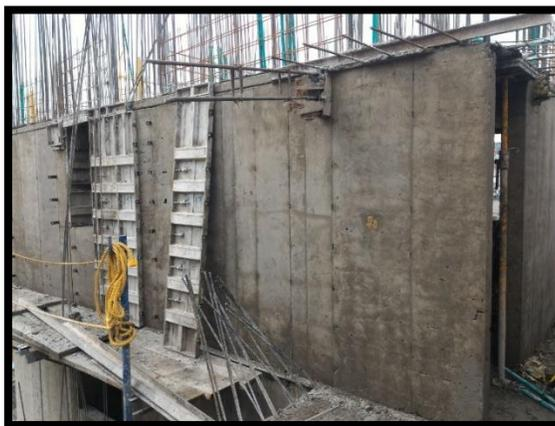
Figura 37. Desencofrado del apartamento.
