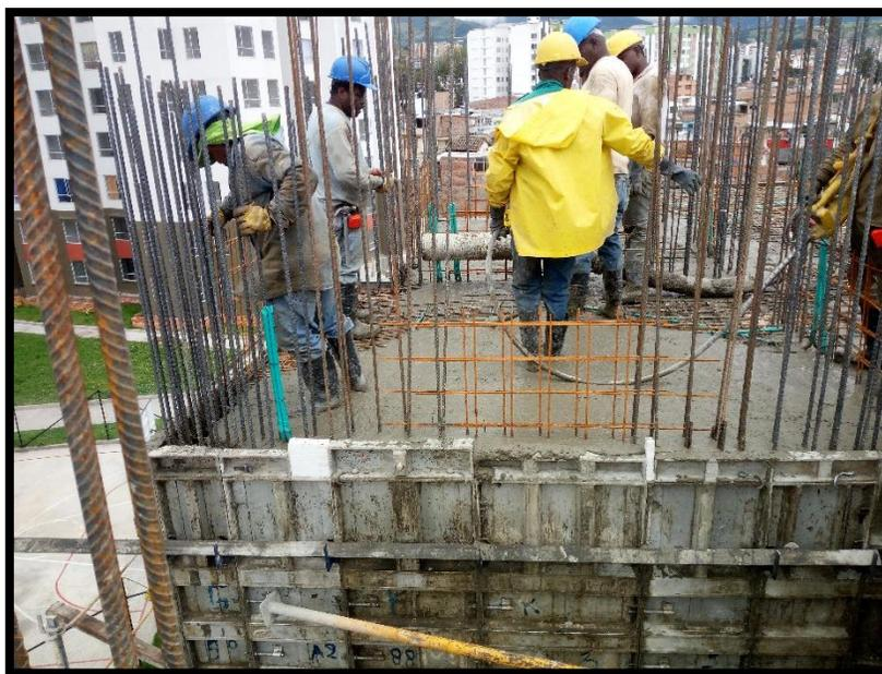
**Figura 33. Vibrado de la mezcla en la fundición.**
