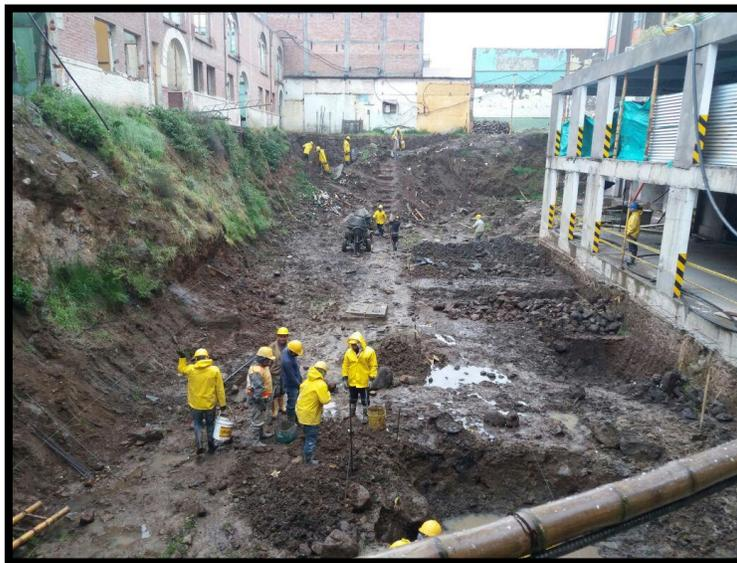
Figura 85. Trazado de ejes y excavación de zapatas.
