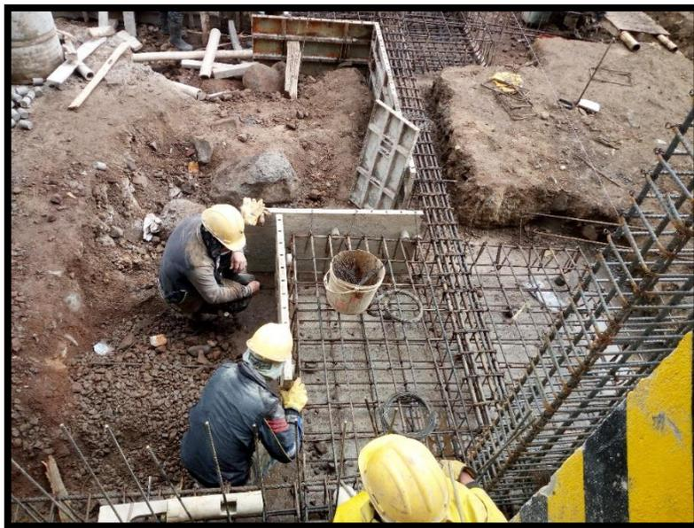
**Figura 96. Armado de vigas de cimentación.**
