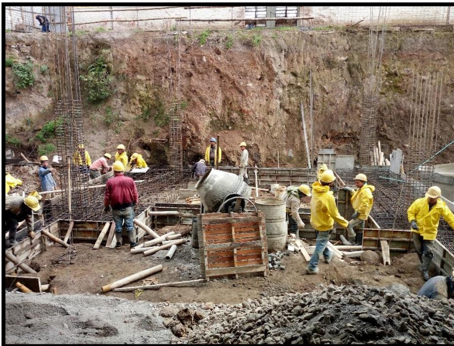
Figura 92. Armado de columnas. Cimentación centro comercial.
