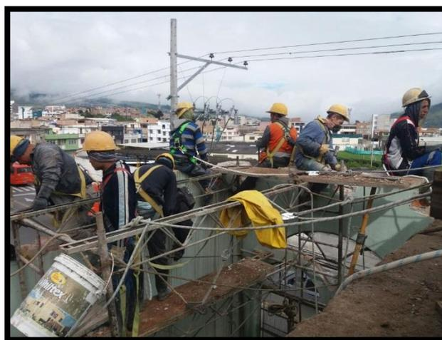
**Figura 98. Demolición manual de estructura.**
