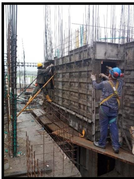
**Figura 69. Instalación de palomeras para armado de apartamentos.**
