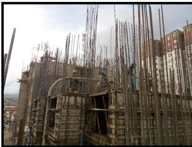
**Figura 30. Instalación de la tubería para la fundición de apartamento.**
