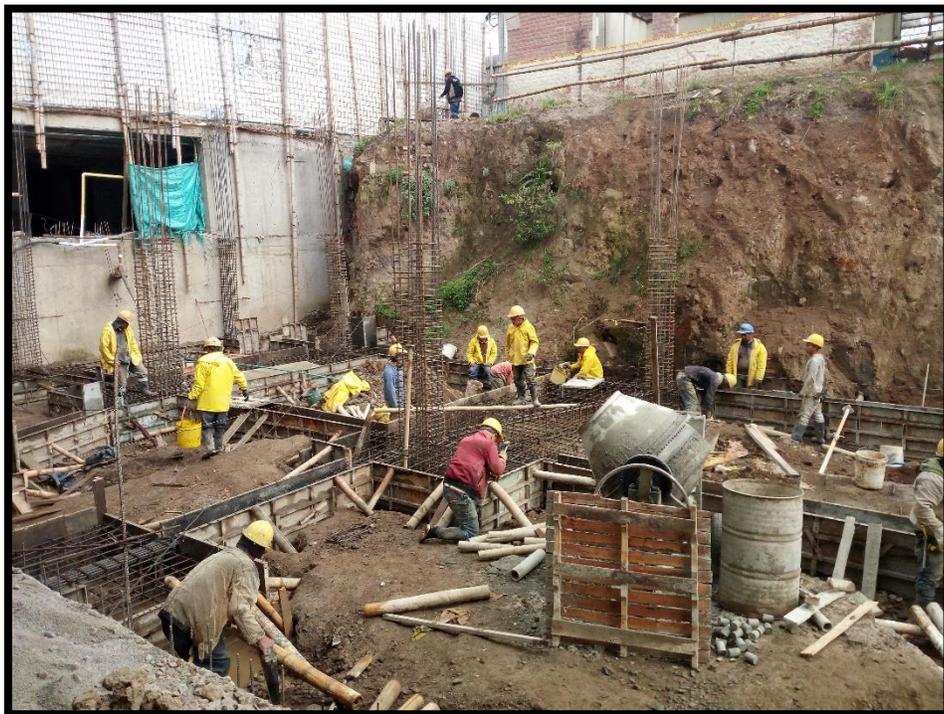
**Figura 95. Armado de vigas de cimentación.**
