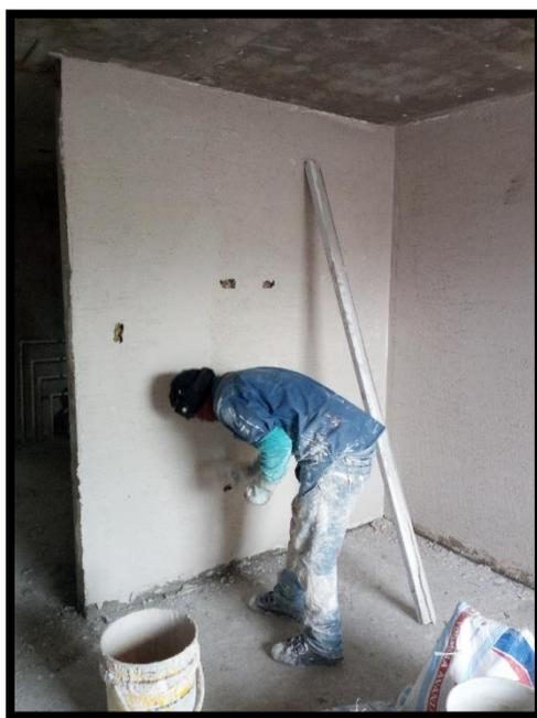
**Figura 52. Aplicación del estuco relleno.**
