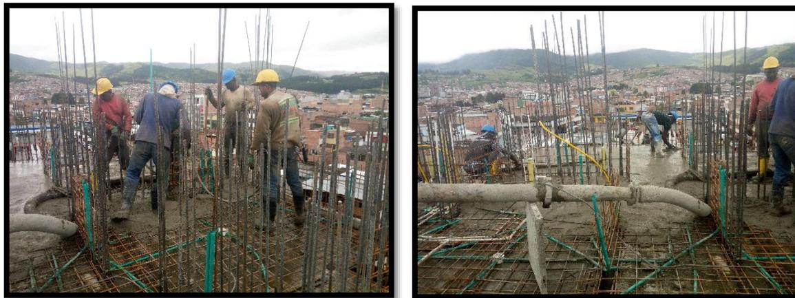
**Figura 32. Fundición de muros y losa de apartamento.**
