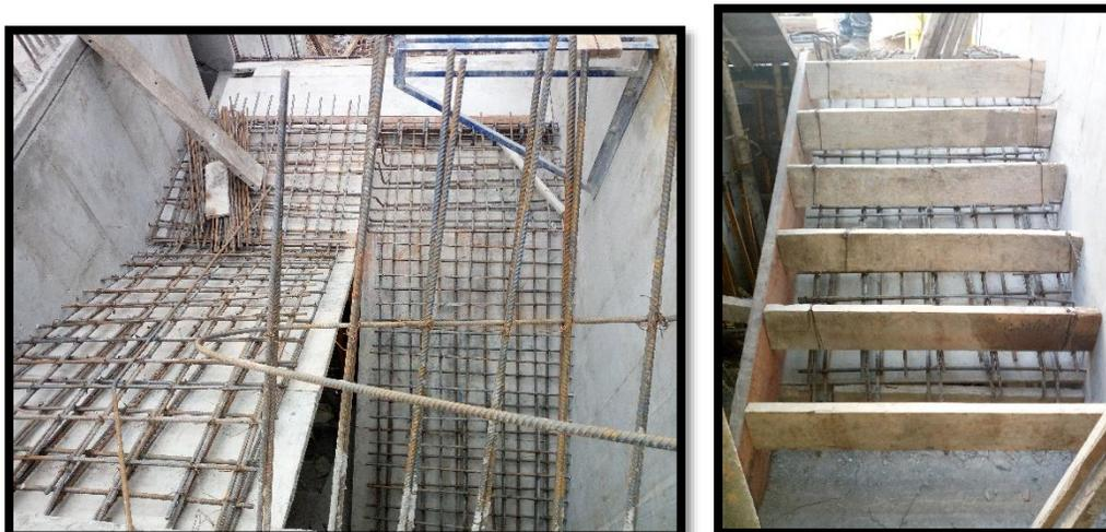
**Figura 48. Colocación de acero y armado de escaleras.**
