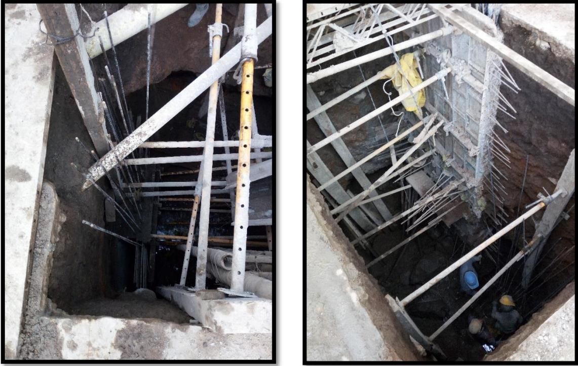
**Figura 102. Colocación del acero y fundición de pantallas.**
