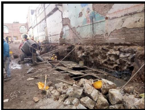
**Figura 83. Excavación para armado de muro de contención.**
