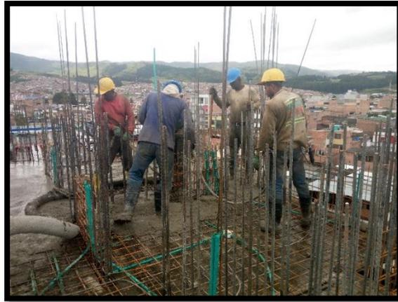
Figura 5. Fundición losa de apartamento.
