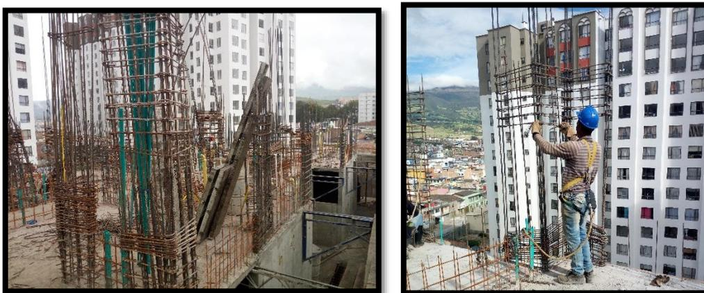
**Figura 19. Colocación de las varillas y los flejes en cada elemento de borde.**
