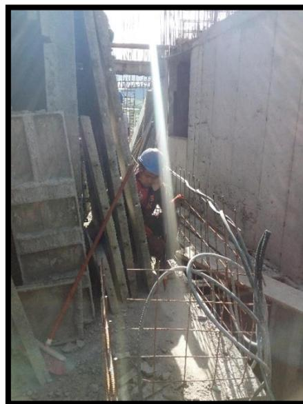
Figura 17. Colocación de la plomada.
