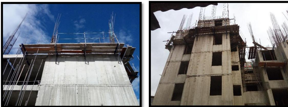
**Figura 68. Instalación de palomeras.**
