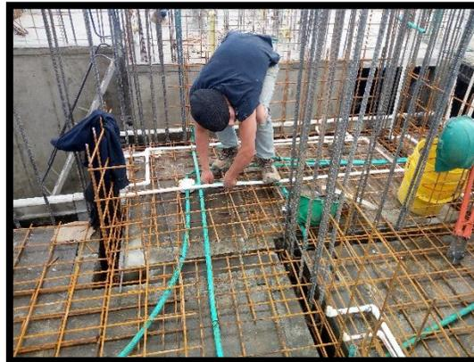
Figura 27. Colocación de las tuberías.
