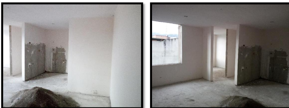
**Figura 51. Muros estucados.**
