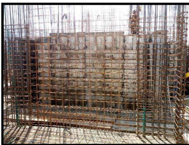
**Figura 20. Colocación de la malla en los muros de apartamento.**
