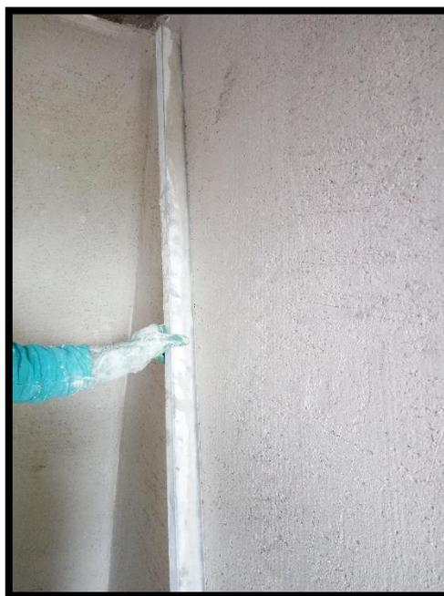
**Figura 53. Chequeo del muro con codal.**
