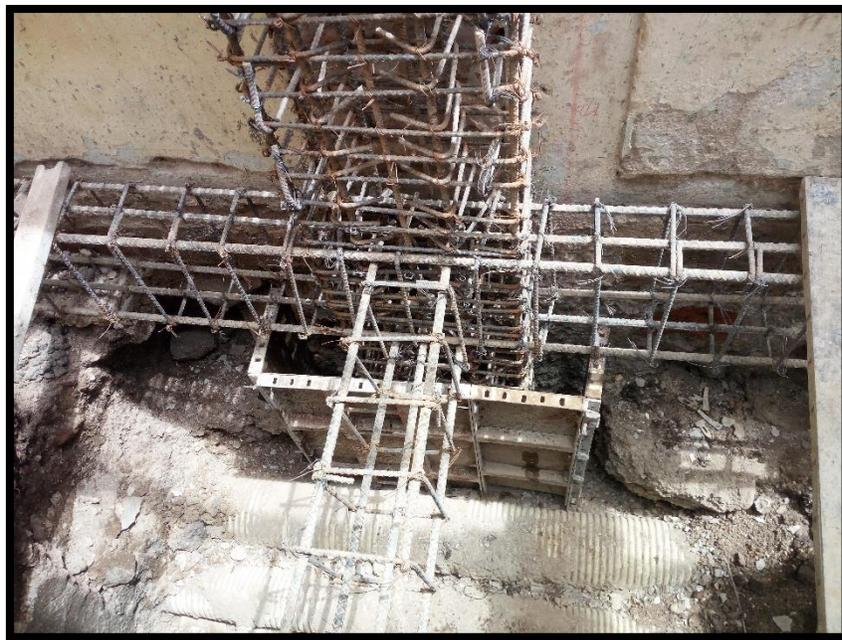
**Figura 105. Armado de columna y viga.**
