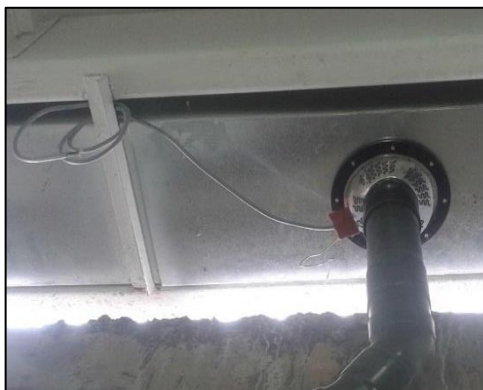
Figura No. 57 Instalación de calentador en tragante. Fuente propia
