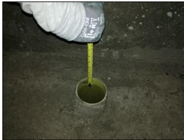
Figura No. 74 Medida final en tubería de desagües. Fuente propia
