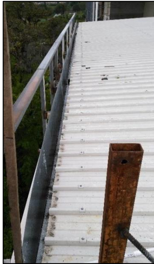
Figura No. 46 Canaleta a lo largo de la cubierta con pendiente hacia los bajantes. Fuente propia
