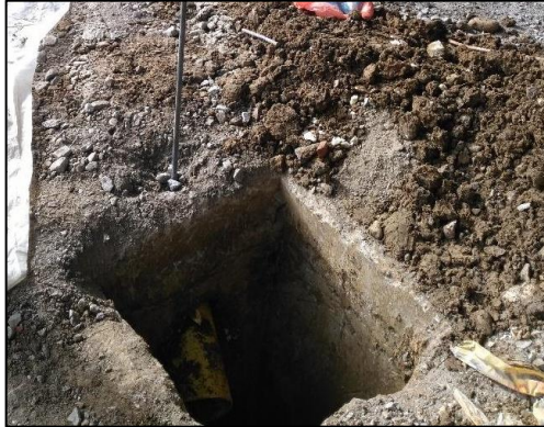
Figura No. 14 Excavación para cajilla de inspección 80x80cm de lado. Fuente propia
