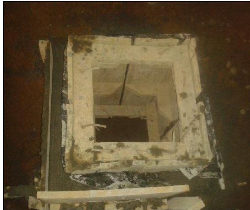
Figura No. 15 Formaleta en madera para cajilla de inspección 60x60cm de lado. Fuente propia
