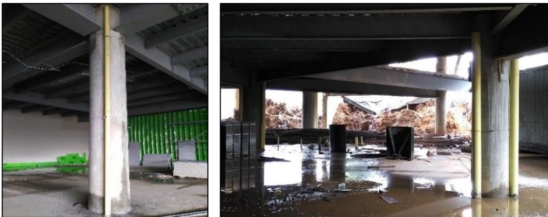
Figura No. 43 Bajantes. Fuente propia
