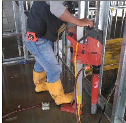
Figura No. 42 Pase con Sacanúcleos para bajante. Fuente propia.
