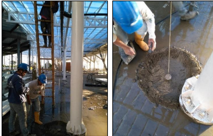
Figura No. 63 Ubicación de bajante con plomada para pase. Fuente propia
