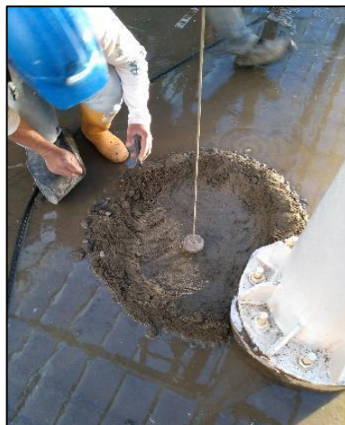
Figura No. 41 Ubicación con plomada para bajante. Fuente propia.
