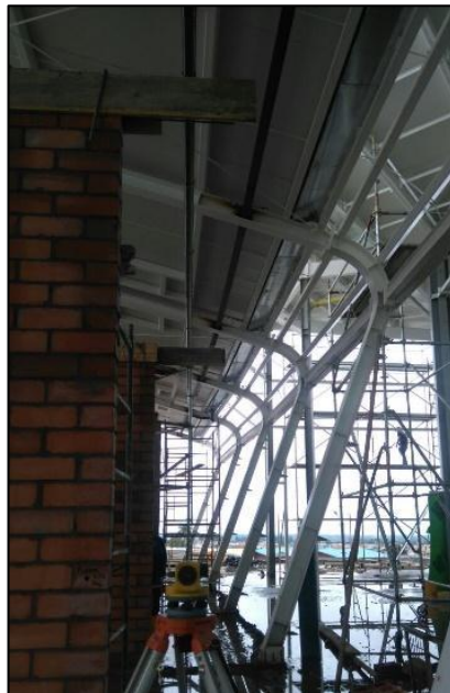
Figura No. 58 Verificación de nivel de manguera por encima de nivel de colector con equipo: nivel de precisión. Fuente propia.
