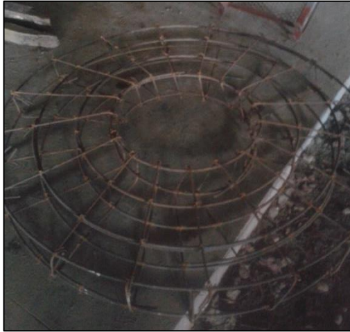
Figura No. 24 Refuerzo para tapa de cámara de inspección. Fuente propia.
