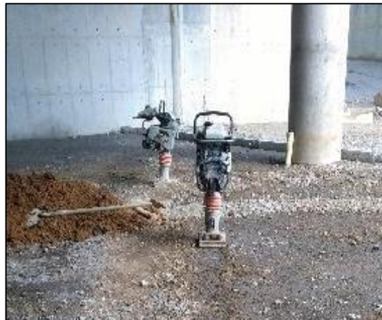
Figura No. 30 Compactación del terreno con saltarín. Fuente propia
