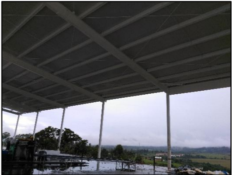
Figura No. 53 Estructura metálica con canal y teja de cubierta. Fuente propia
