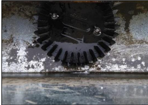
Figura No. 56 Instalación de tragante en la parte superior del canal. Fuente propia
