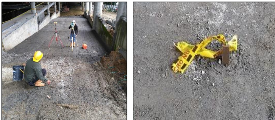
Figura No. 13 Localización de elementos en campo con topografía. Fuente propia
