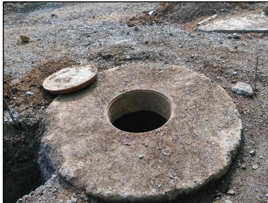
Figura No. 25 Fundición de armadura de tapa para cámara de inspección. Fuente propia.
