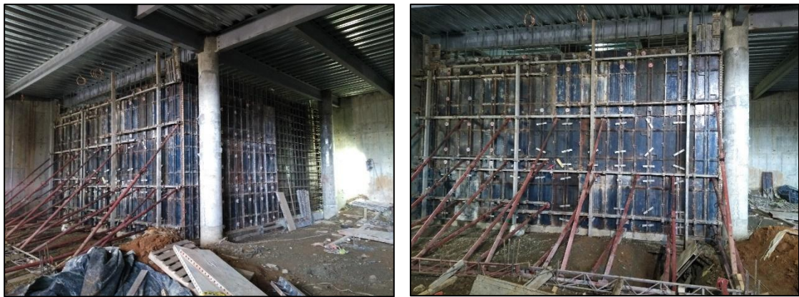
Figura No. 8 Fijación de formaleta de paredes del tanque. Fuente propia
