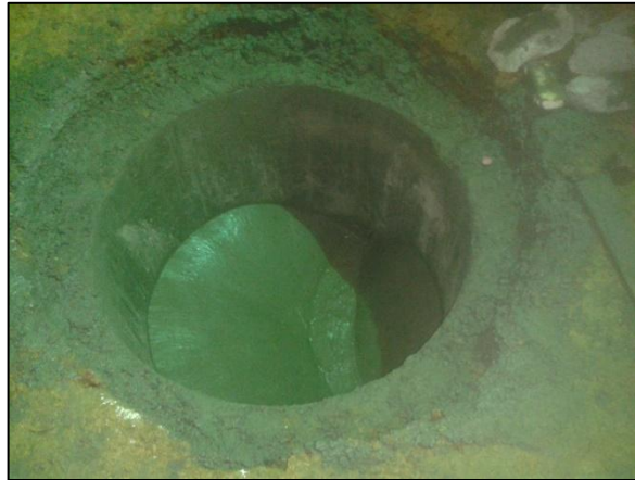
Figura No. 22 Cañuelas en cámaras de inspección. Fuente propia.
