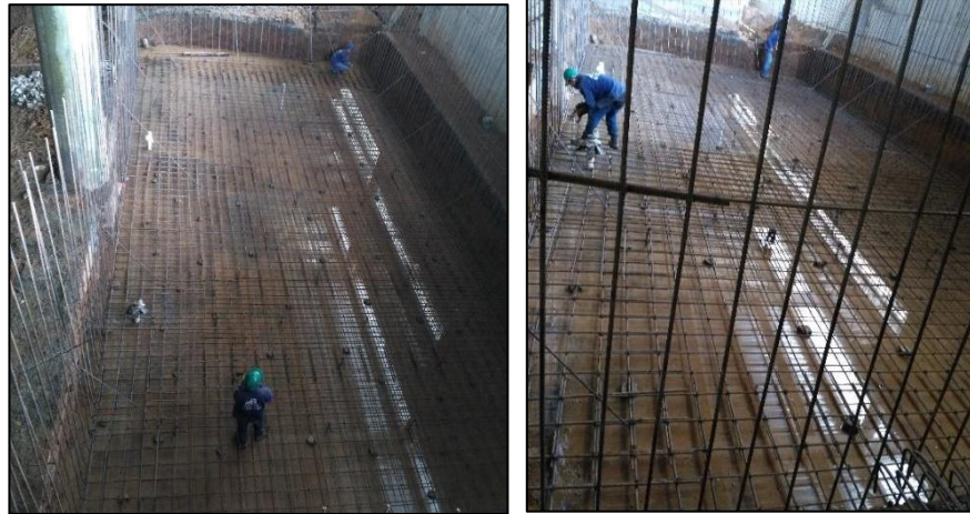
Figura No.6 Ubicación de refuerzo para tanque de abastecimiento de agua. Fuente propia.
