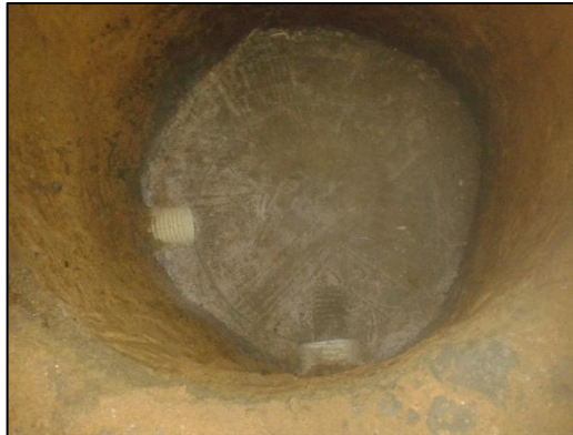
Figura No. 18 Excavación de círculo con 1.5m de diámetro para cámara de inspección. Fuente propia.
