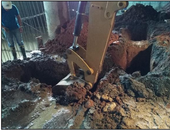
Figura No. 27 Excavación con retroexcavadora hidráulica pequeña para tubería enterrada. Fuente propia.
