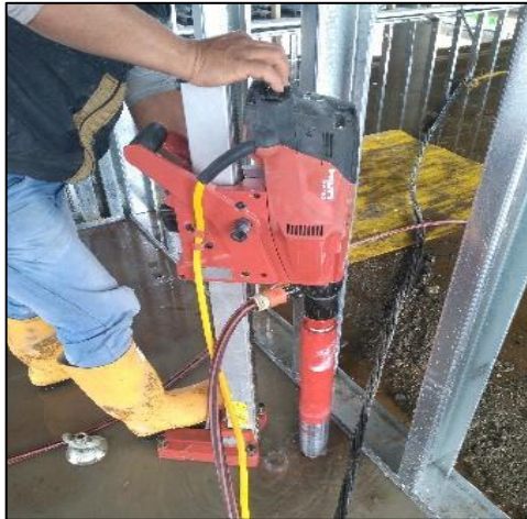
Figura No. 9 Ubicación de pase en campo y fijación de Sacanúcleos. Fuente propia.
