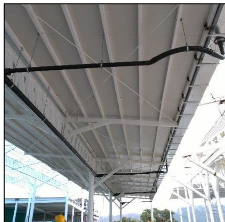
Figura No. 62 Colector horizontal conectado a todos los ramales del isométrico. Fuente propia
