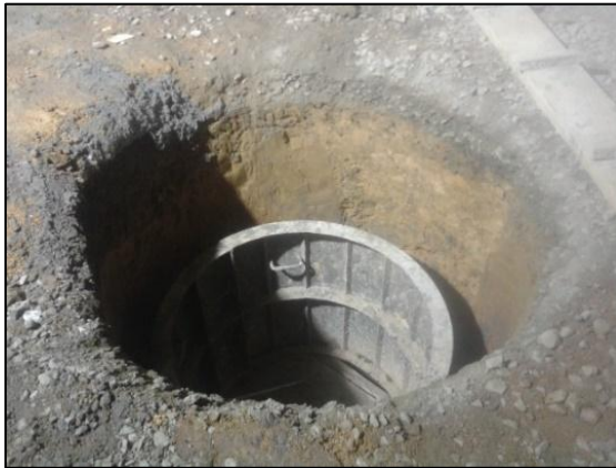
Figura No. 20 Colocación de formaleta cilíndrica. Fuente propia.
