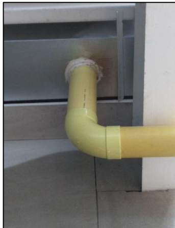
Figura No. 47 Exosto de tubo PVC-sanitario de PAVCO de 6" adherida al canal con Sikaflex. Fuente propia
