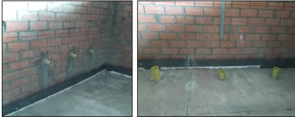
Figura No. 40 Puntos de desagüe de baños en muro y piso. Fuente propia.
