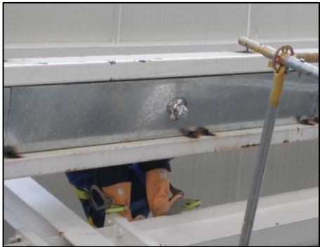
Figura No. 55 Instalación de platina de anclaje para embudo conector. Fuente propia
