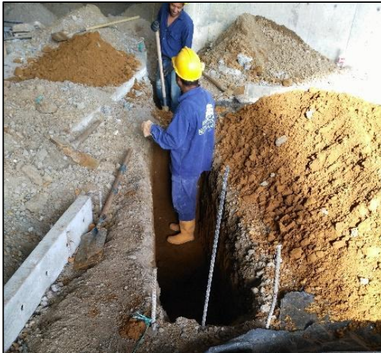
Figura No. 28 Excavación a mano para tubería enterrada. Fuente propia.
