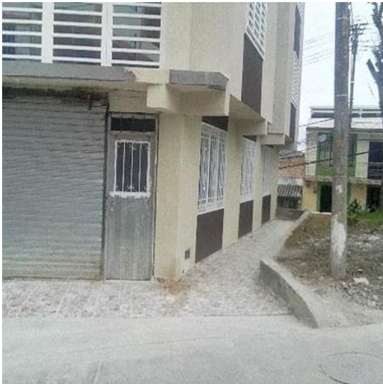
Imagen 39. Obra 8, fachada occidental, andén.
