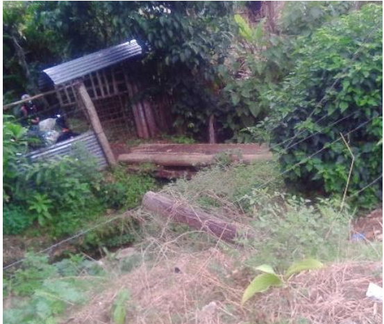
Imagen 108. Visita 11, puente artesanal 2.
