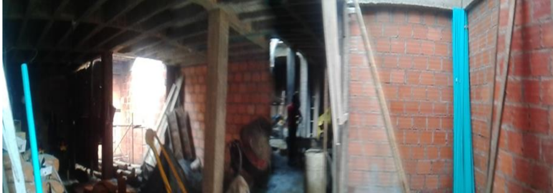
Imagen 27. Obra 5, muros y columnas construidos en la primera planta.
