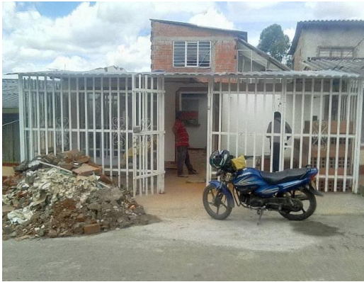
Descripción: Detalle fachada sobre la Calle 2N.
