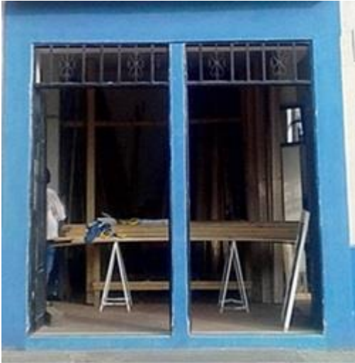
Imagen 7. Obra 1, puertas construidas primera planta.
