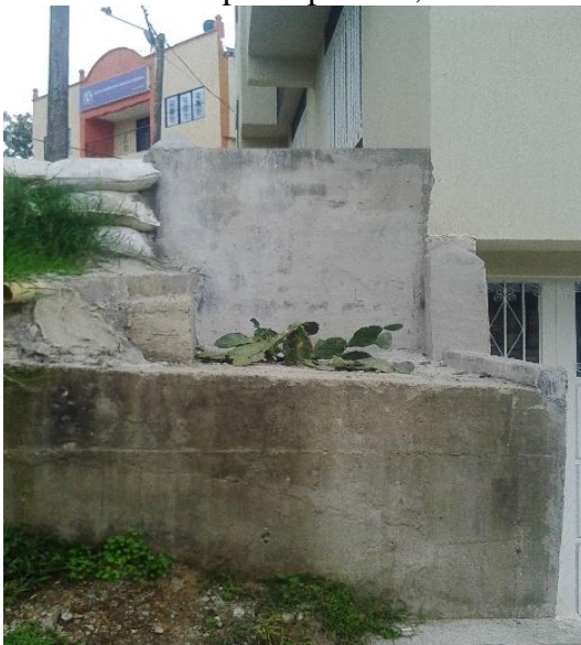
Fuente: Fotografía tomada en obra. (26 de enero de 2017)
