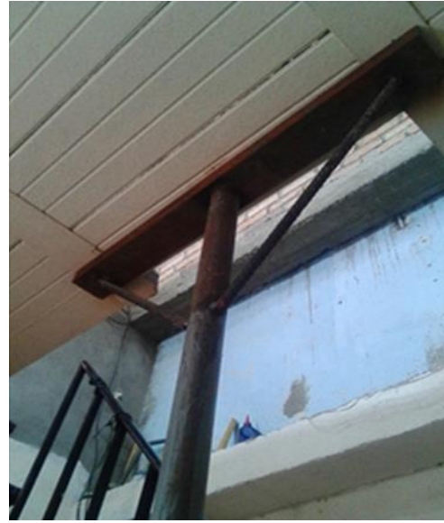
Fuente: Fotografía tomada en obra (12 de enero de 2017).
