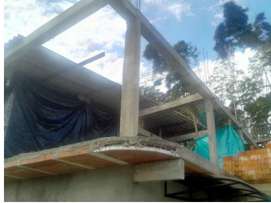
Imagen 58. Obra 10, vigas y columnas construidas sobre segunda planta.
