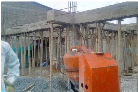
Imagen 87. Visita 1, vigas y columnas construidas.
