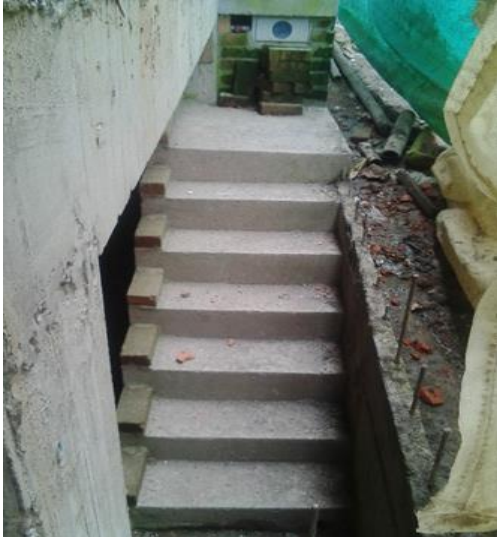
Fuente: Fotografía tomada en obra. (30 de enero de 2017)
