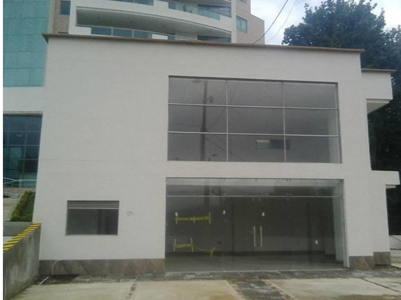
Imagen 37. Obra 7, local comercial debidamente terminado frente a la edificación.
