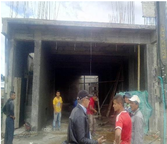
Imagen 70. Obra 13, fachada construida sobre la calle 15.
