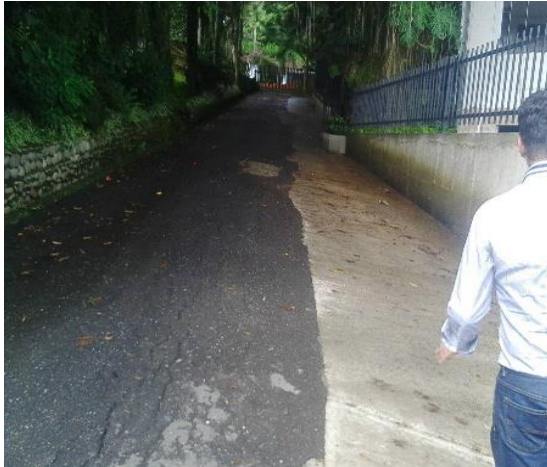
Fuente: Fotografía tomada en obra. (11 de enero de 2017)
