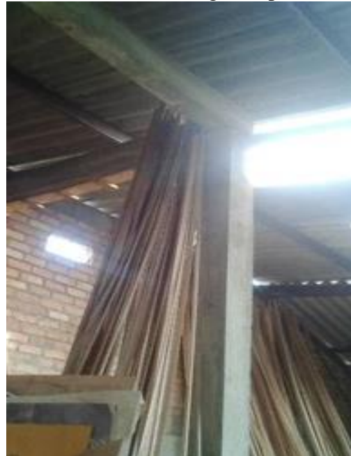
Fuente: Fotografía tomada en obra. (12 de enero de 2017)
