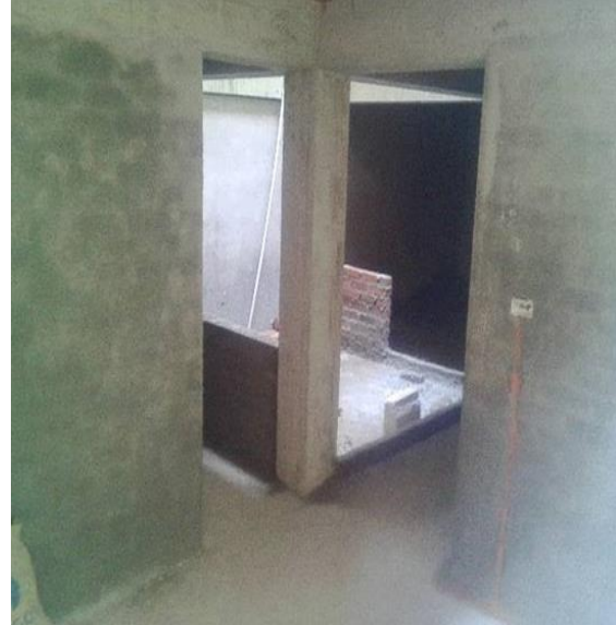
Fuente: Fotografía tomada en obra. (30 de enero de 2017)
