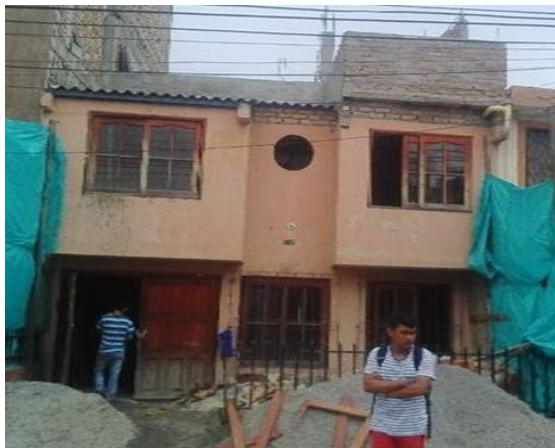
Imagen 73. Obra 14, fachada sobre la Cra. 7.
