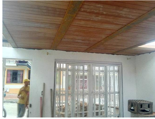
Descripción: Detalle losa en bloquelon construida sobre la zona sala comedor.
