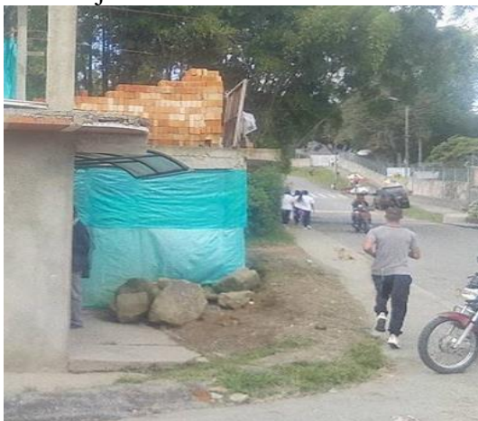
Imagen 55. Obra 10, construcción sobre antejardín vista desde la Calle 16.
