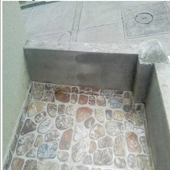
Imagen 40. Obra 8, muro construido.
