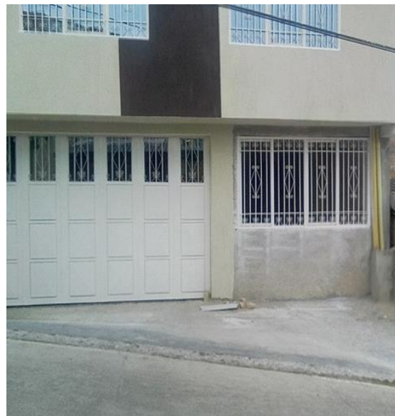
Fuente: Fotografía tomada en obra. (26 de enero de 2017)
