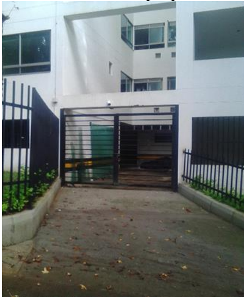
Fuente: Fotografía tomada en obra. (11 de enero de 2017)
