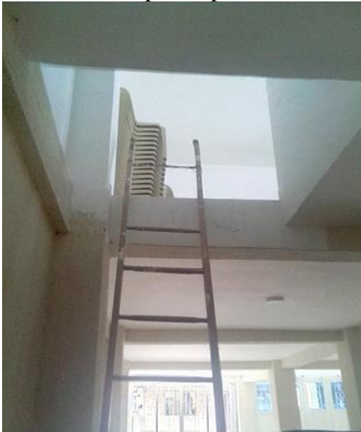
Fuente: Fotografía tomada en obra. (26 de enero de 2017)
