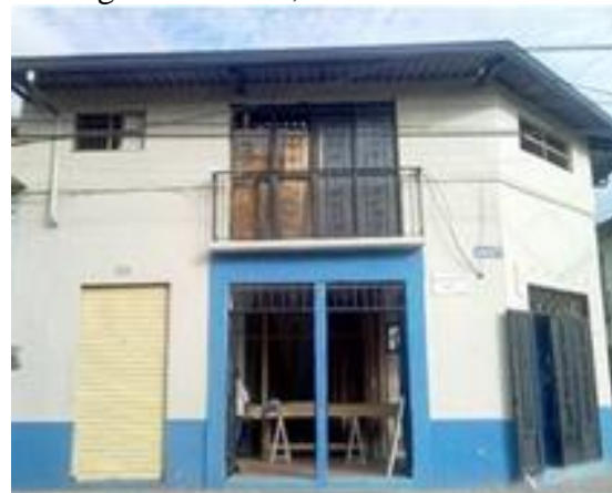
Fuente: Fotografía tomada en obra. (12 de enero de 2017)
