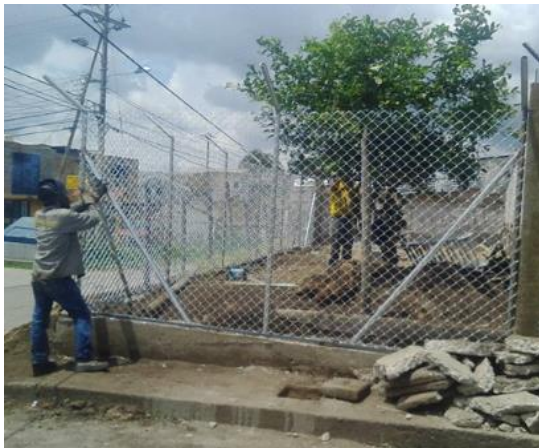
Imagen 76. Obra 15, cerramiento sobre la Calle 61AN.
