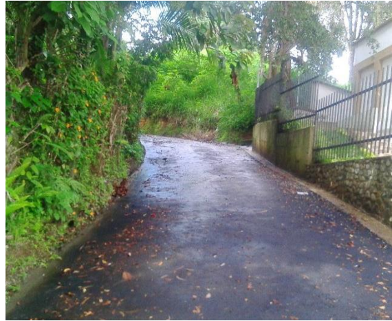
Fuente: Fotografía tomada en obra. (11 de enero de 2017)
