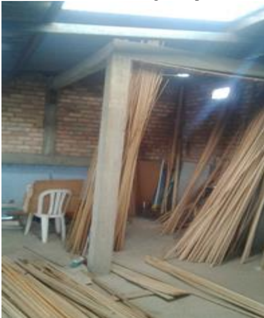
Fuente: Fotografía tomada en obra. (12 de enero de 2017)
