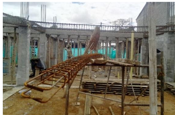
Imagen 88. Visita 1, vigas y columnas construidas.
