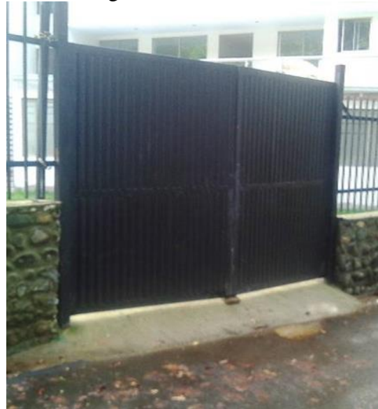
Fuente: Fotografía tomada en obra. (11 de enero de 2017)
