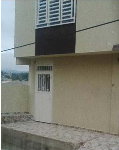
Fuente: Fotografía tomada en obra. (26 de enero de 2017)
