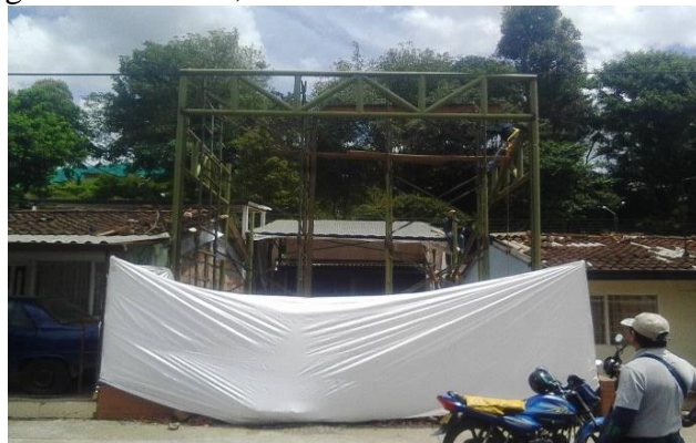
Imagen 82. Obra 17, estructura metálica en construcción.
