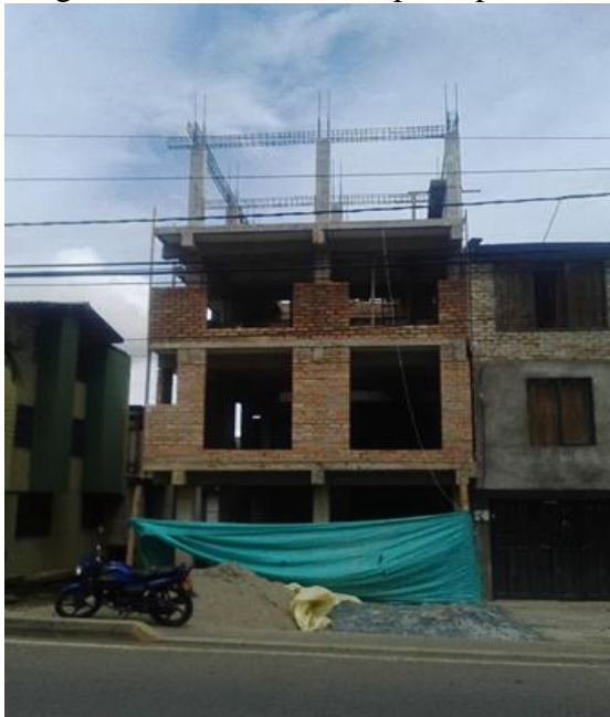
Imagen 50. Obra 9, fachada principal Cra. 2.
