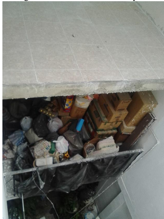
Imagen 30. Obra 6, losa tercera planta.
