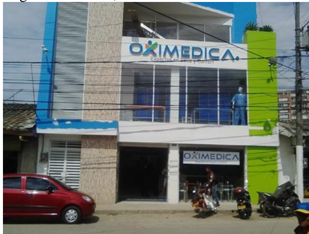
Imagen 25. Obra 4, fachada edificio sobre la Cra. 6.
