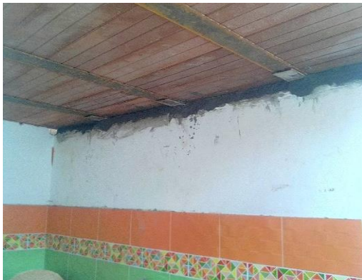
Descripción: Detalle losa en bloquelon construida sobre la cocina.
