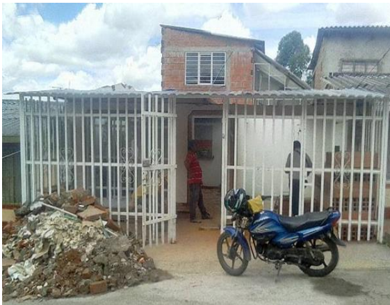
Imagen 79. Obra 16, fachada sobre la Calle 2N.
