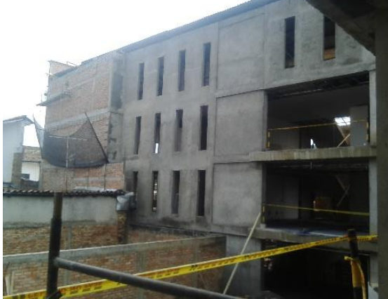
Imagen 105. Visita 10, muros construidos.
