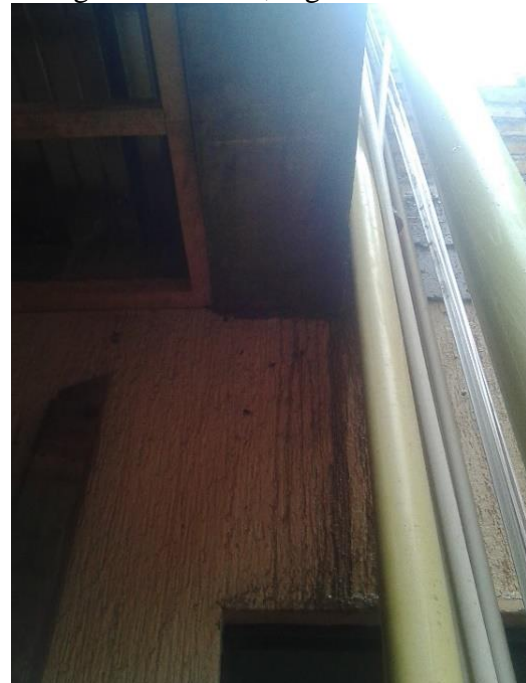
Imagen 23. Obra 3, viga con voladizo.
