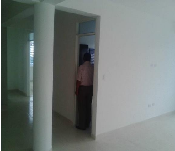
Fuente: Fotografía tomada en obra. (26 de enero de 2017)
