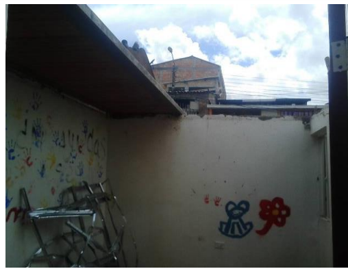
Descripción: Detalle cubierta demolida y montaje de losa sobre alcoba.
