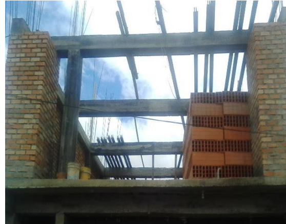
Fuente: Fotografía tomada en obra. (1 de febrero de 2017)
