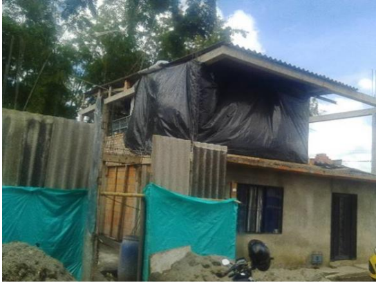
Imagen 57. Obra 10, fachada construida sobre la calle 16.
