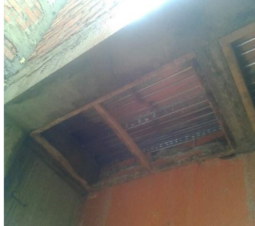
Imagen 21. Obra 3, voladizo construido.
