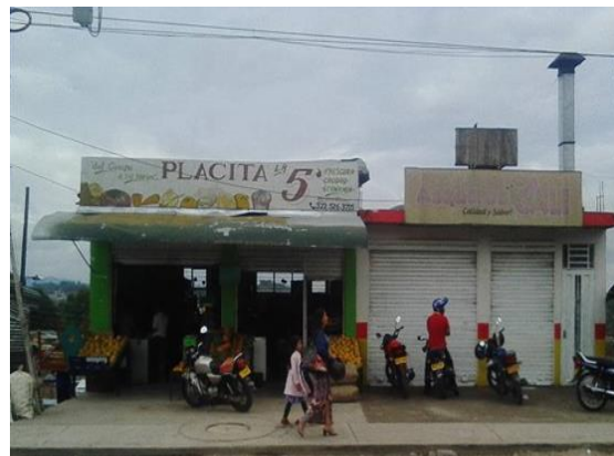
Imagen 61. Obra 11, Placita la 5 y Asaderos Cali.
