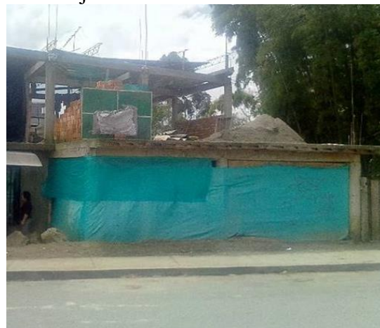
Imagen 56. Obra 10, construcción sobre antejardín vista desde la Calle 17.
