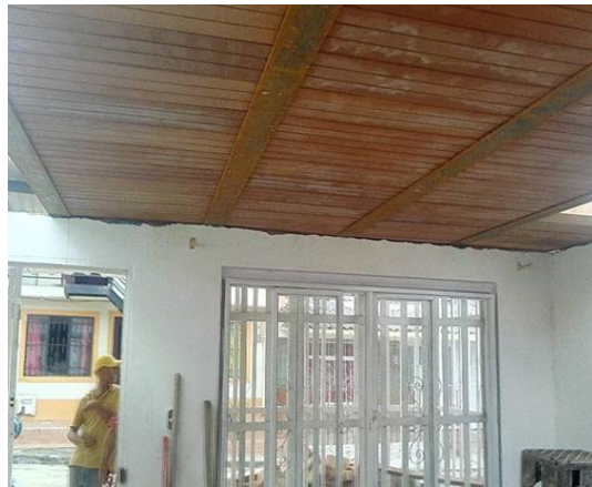
Imagen 80. Obra 16, losa en bloquelón construida sobre la zona sala comedor.
