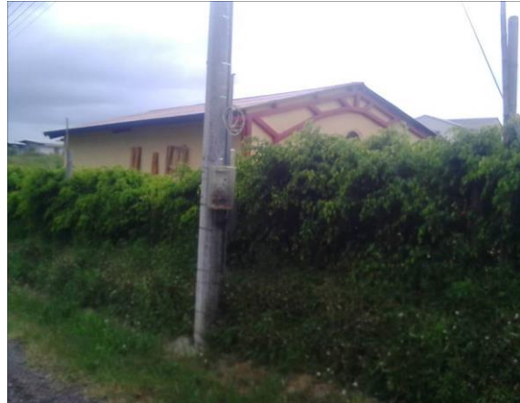
Fuente: Fotografía tomada en obra. (15 de febrero de 2017)
