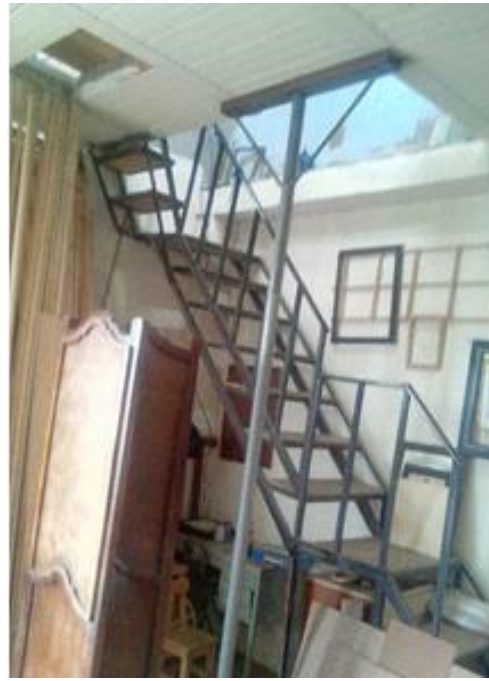
Imagen 10. Obra 1, estructura metálica y huella en madera.
