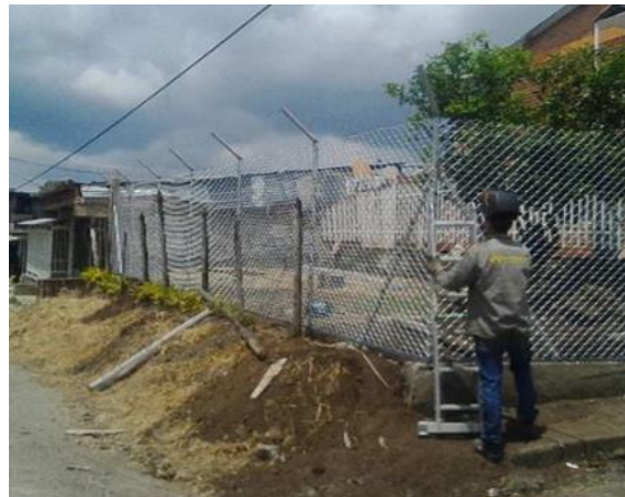
Imagen 77. Obra 15, cerramiento sobre la Calle 16A.
