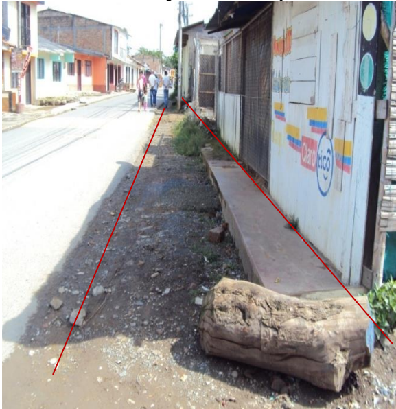
Figura34. Construcción de obras complementarias de la infraestructura municipal de transporte (andenes y sardineles)de la carrera 3 desde la calle 27N hacia la calle 27BN – calle 27N desde casa con nomenclatura 2A-67 (Terminación Escuela Alejandro de Humboldt yanaconas) hacia carrera 1. Barrio Yanaconas
