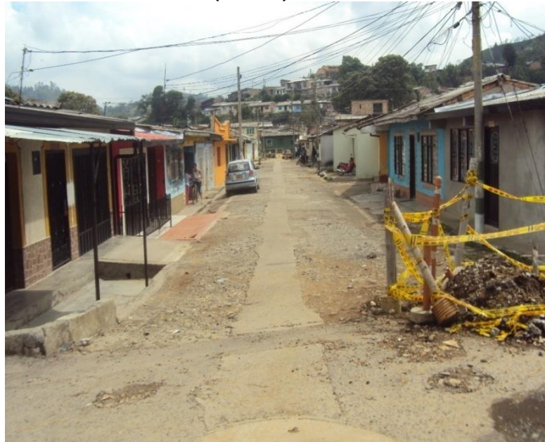
Figura64. Barrio Los Sauces CONTRATO DE OBRA No: 20161800013657 (ANTES)
