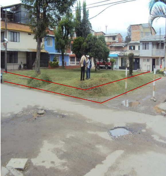
Figura18. Construcción de Andenes en la vía carrera 7 hacia la 7A con calle 17. Carrera 8 con calle 17 casa 8-14 hacia la carrera 9 carrera 8 con 17A frente a la casa con nomenclatura #8-45 hacia la carrera 9. Barrio Pajonal
