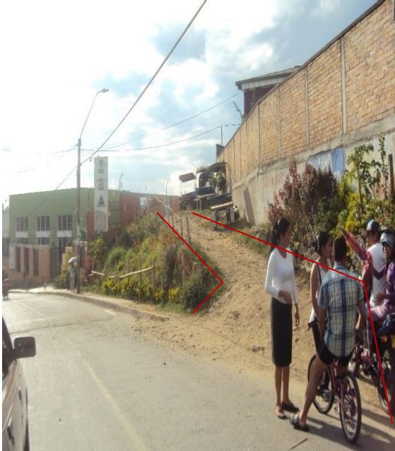
Figura26. Pavimentación, manzana 4 carrera 28 hasta la carrera 31 del barrio 31 de marzo iniciando desde la carrera 28 del barrio la conquista hacia la carrera 31 del barrio 31 de marzo, terminación de pavimento
