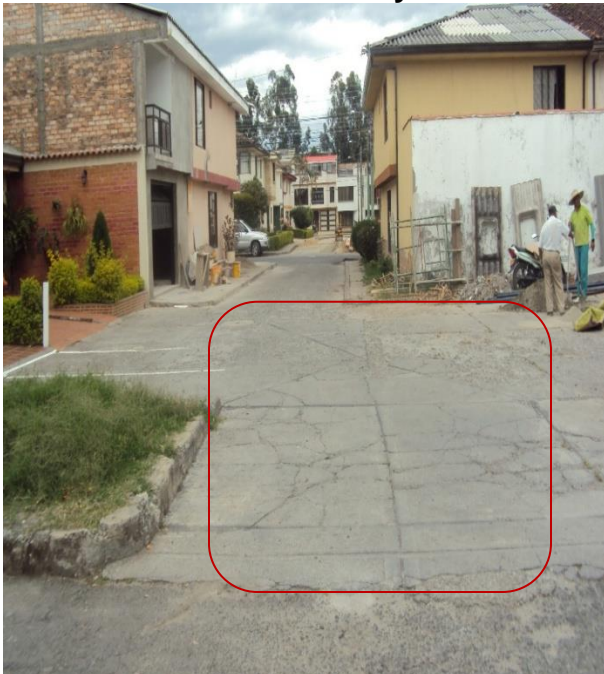
Figura5. Terminación de pavimento desde Carrera 11A entre calles 1A Norte y 2 Norte. Barrio Rosales
