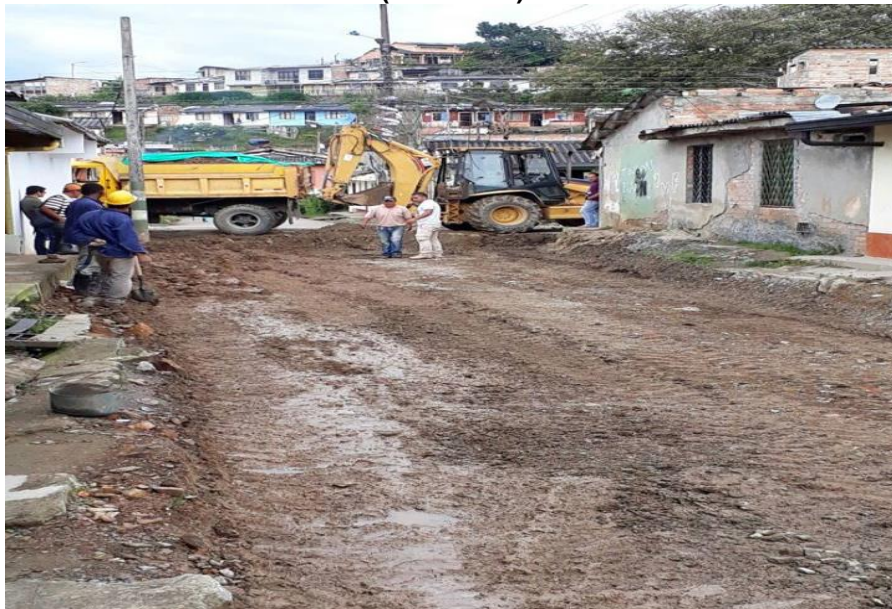
Figura65. Barrio Los Sauces CONTRATO DE OBRA No: 20161800013657 (DESPUÉS)
