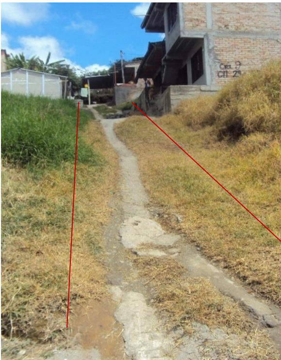
Figura19. Construcción de placa huella en la calle 29 A #9-16 y calle 29B #9-24. Barrio Miraflores
