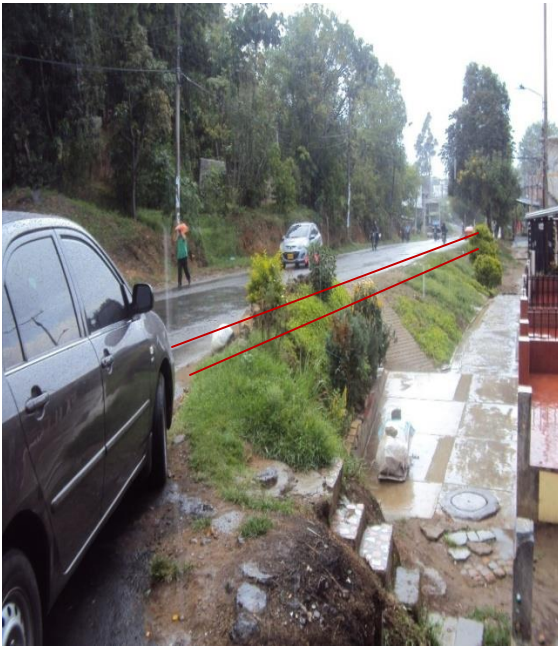
Figura15. Construcción de Andenes en la vía carrera 12 desde la calle 22 hacia la carrera 17. Barrio Deán Bajo
