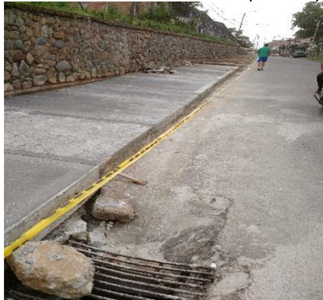
Figura67. Barrio Santa Fe Convenio 1419/16(DESPUÉS)
