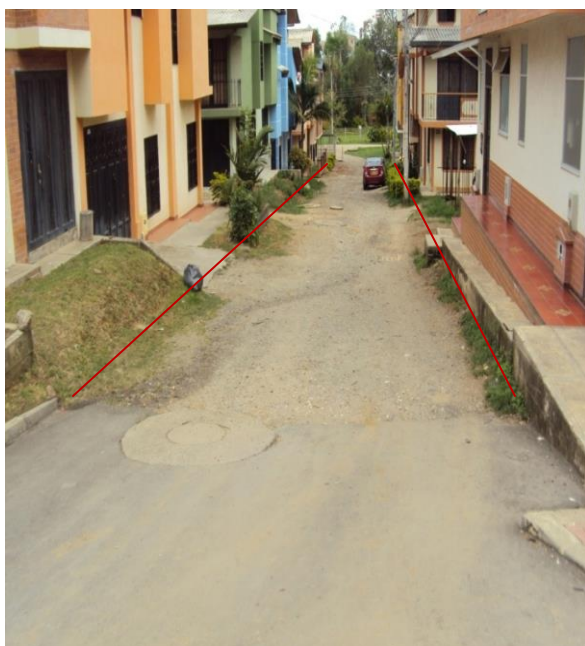
Figura40. Pavimentación de la calle 20CN desde la carrera 2 hacia la carrera 3. Barrio Balcones de Pomona
