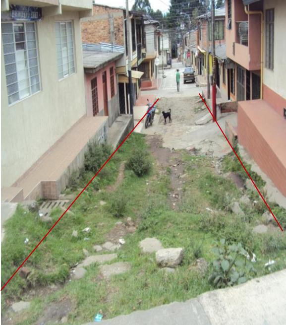
Figura46. Pavimentación en concreto rígido de la carrera 28A desde la calle14 hacia la calle 13. Barrio Mirador
