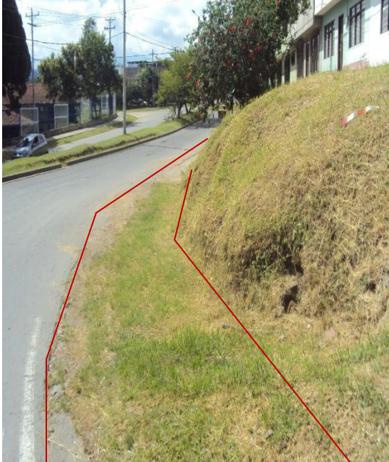
Figura24. Construcción de andenes en la carrera 12 con 17 hacia la carrera 16B continuación anden calle 20A hacia la carrera 17 andenes carrera 16B hacia la carrera 12 anden carrera 16 con calle 20B #20b-19. Barrio Nueva Granada
