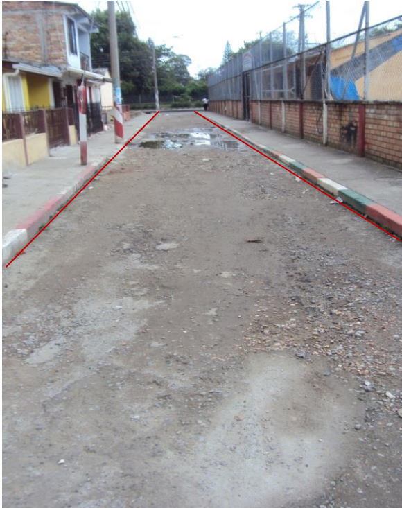
Figura44. Pavimentación de la calle 13A entre carreras 15 y 17. Urbanización El Dorado
