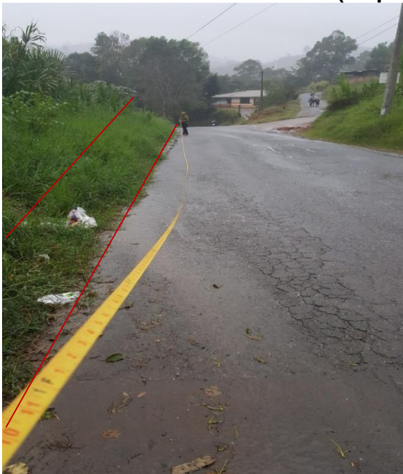
Figura35. Construcción de obras complementarias de la infraestructura municipal de transporte (andenes y sardineles)en la calle 26N desde la carrera 1e (esquina casa C1) hacia pueblillo
