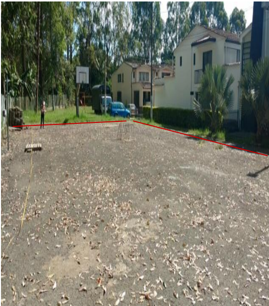
Figura31. Reparación de lacarpeta asfáltica de la cancha múltiple existente en la –urbanización la playa
