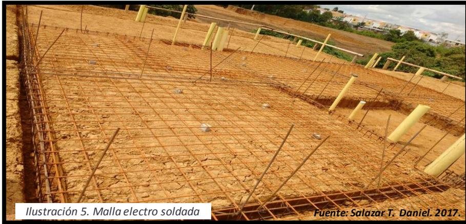
Ilustración 5. Malla electro soldada
