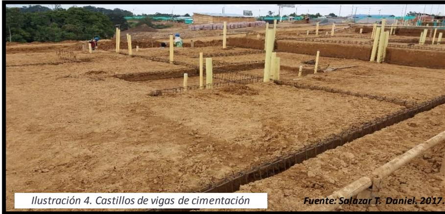
Ilustración 4. Castillos de vigas de cimentación
