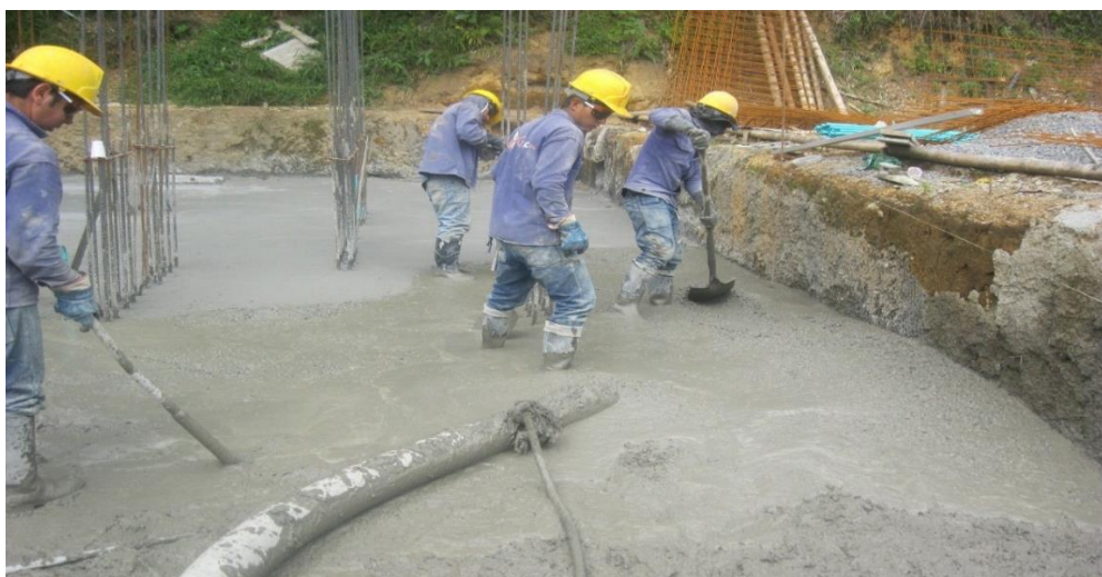
Figura N° 30: Fundición de la torta superior de losa de cimentación.
