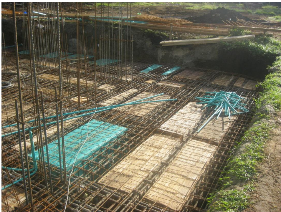
Figura N° 28: Instalación de tubería para redes eléctricas y de telecomunicaciones.
