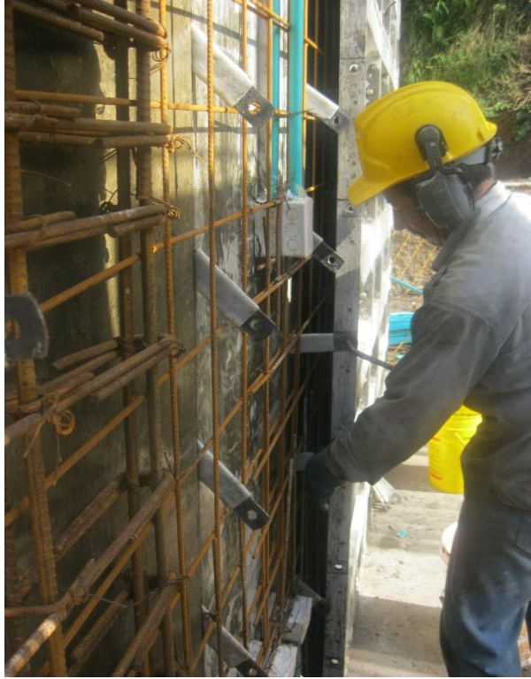
Figura N° 48: Proceso de colocado de corbatas en la formaleta.
