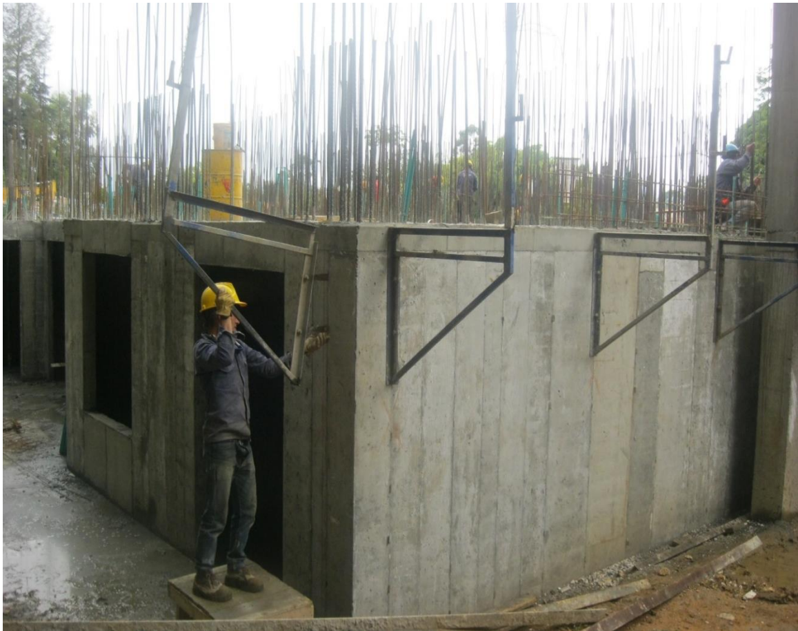
Figura N° 31: Estructura del piso 1 de la Torre D.
