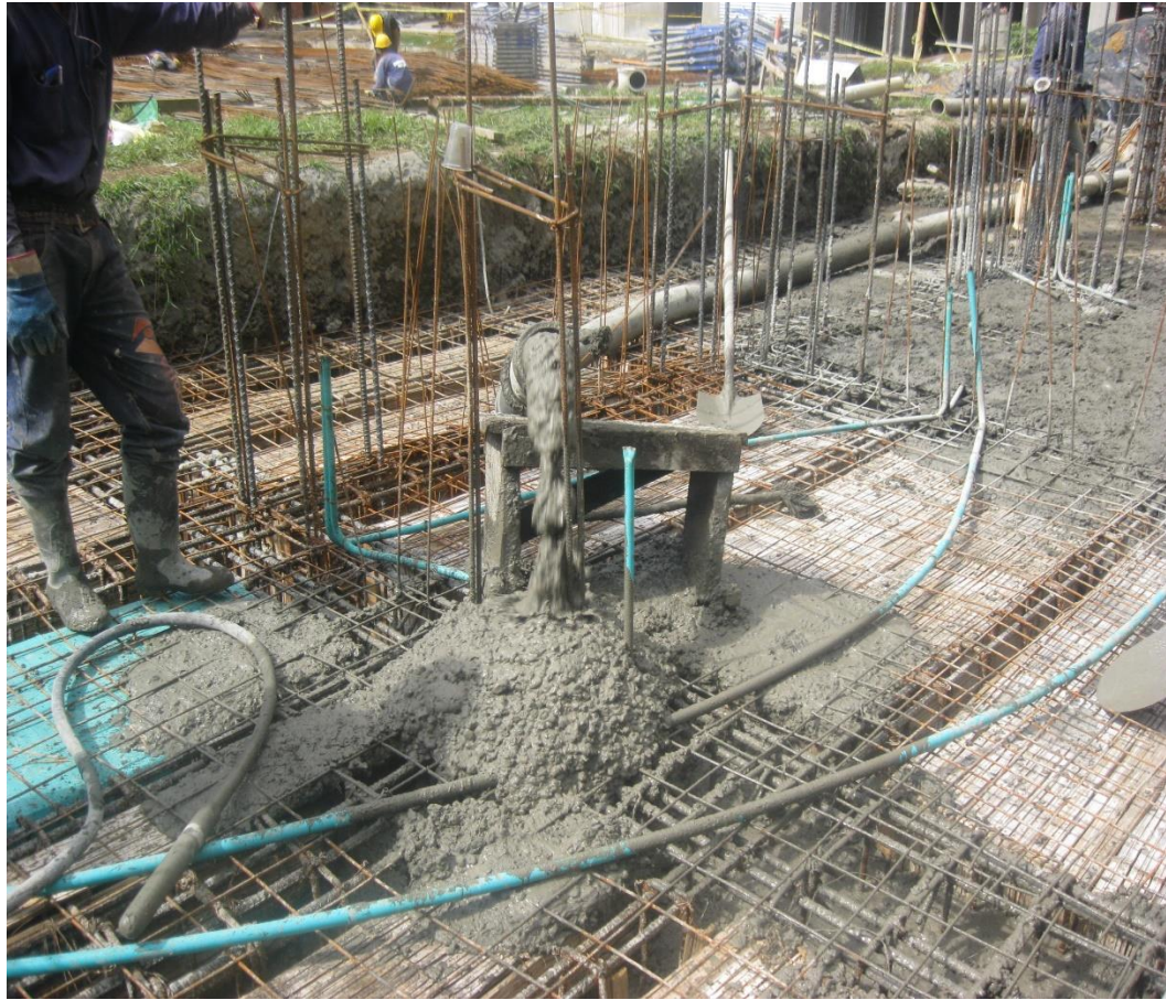
Figura N° 17: Proceso de fundición de la losa de cimentación garantizando el anclaje de los Elementos de Borde.
