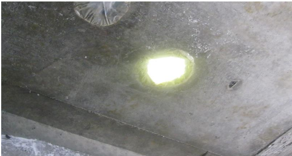
Figura N° 45: Pases sanitarios en losa.
