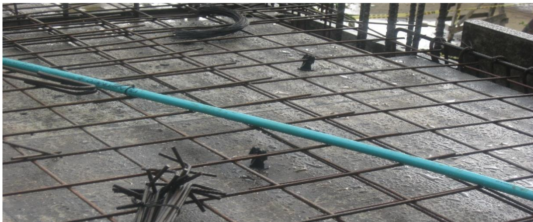
Figura N° 51: Separadores de malla de losa.
