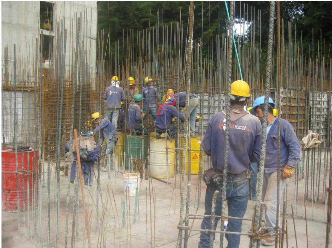
Figura N° 32: Amarre de aceros de los elementos de borde del primer piso de la torre.
