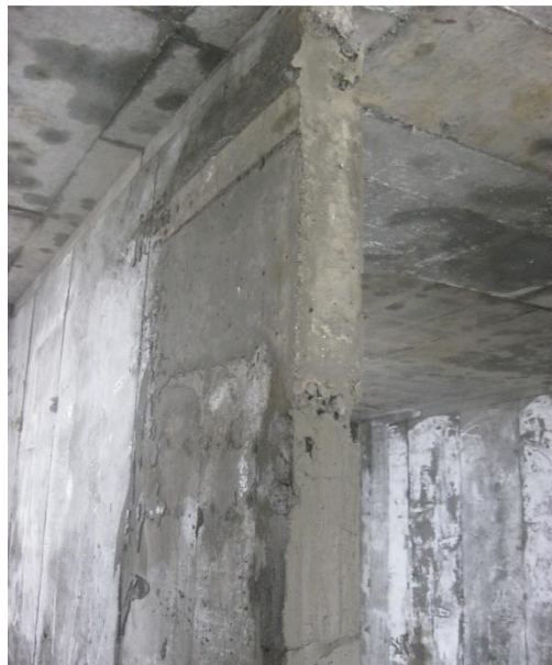
Figura N° 66: Muro después de su segunda fundición listo para ser resanado.
