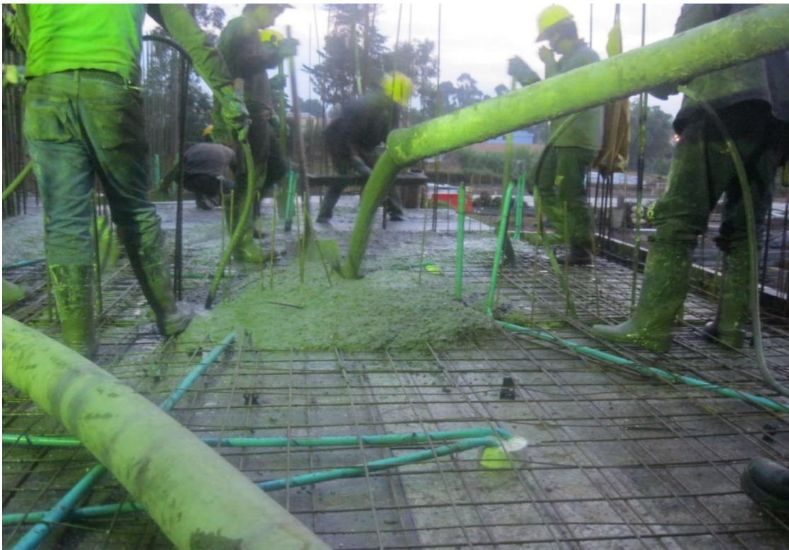
Figura N° 56: Fundición de losa de entrepiso.
