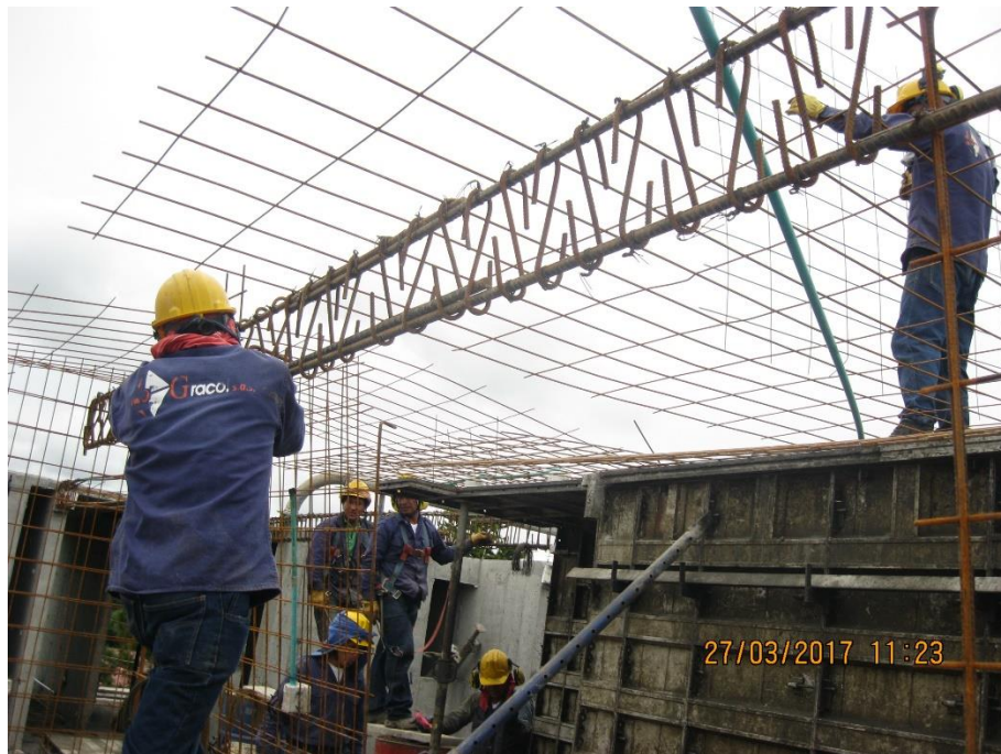
Figura N° 38: Proceso de amarre de aceros para dintel 2.
