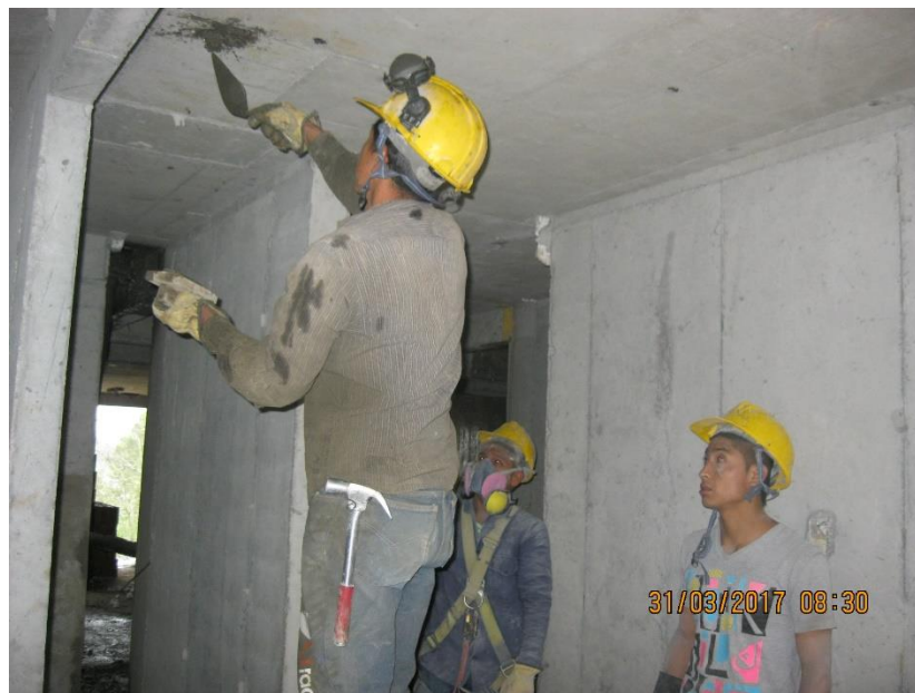
Figura N° 68: Resane de hormigueros.
