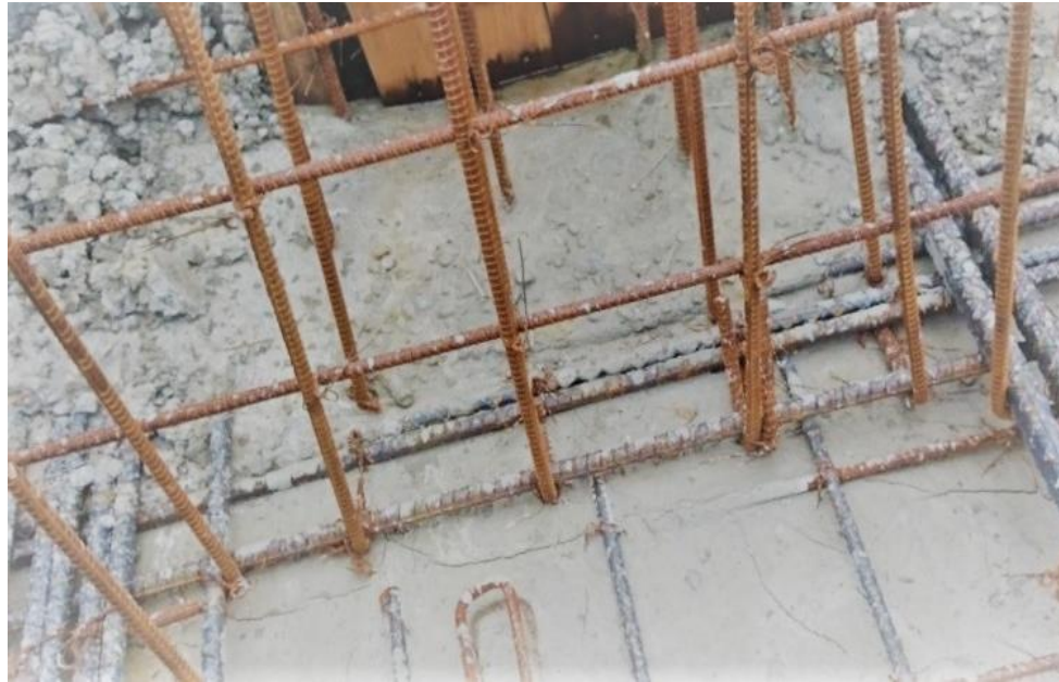
Figura N° 25: Losa o torta inferior de la losa de cimentación.
