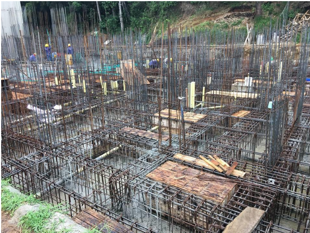
Figura N° 5: Losa aligerada con casetones para la cimentación de Torre D, con concreto de limpieza, redes sanitaria y pluvial y con arranques para los elementos de borde.
