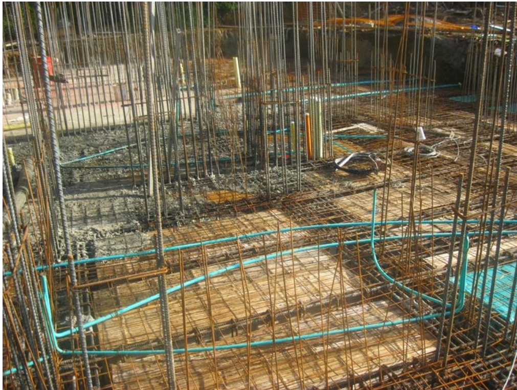
Figura N° 16: Proceso de anclaje de Elementos de Borde en la losa de cimentación.
