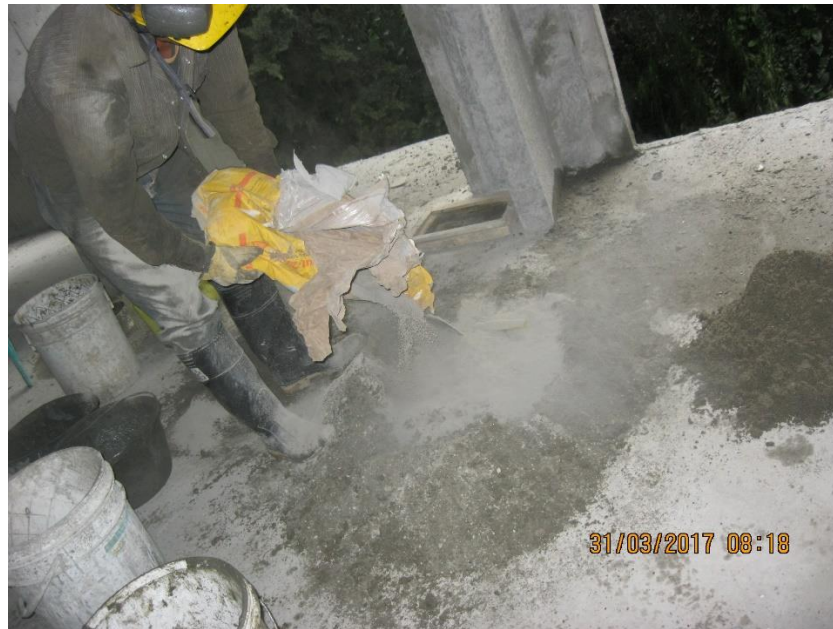
Figura N° 67: Preparación del mortero para resane de hormigueros.
