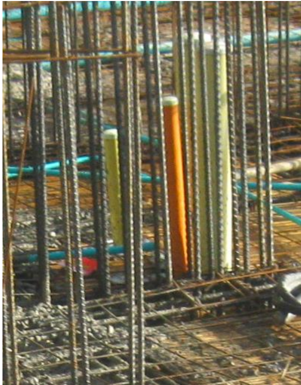
Figura N° 44: Tubería para pases sanitarios en losa.
