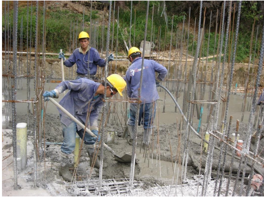
Figura N° 24: Proceso de fundición de la losa de cimentación.
