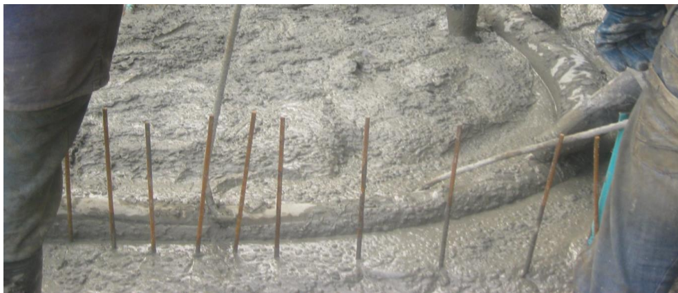
Figura N° 21: Arranque de mallas anclados en la losa de cimentación.
