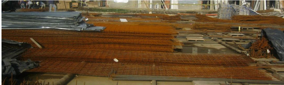
Figura N° 29: Malla electro soldada calibre 8 mm para torta superior de losa de cimentación.
