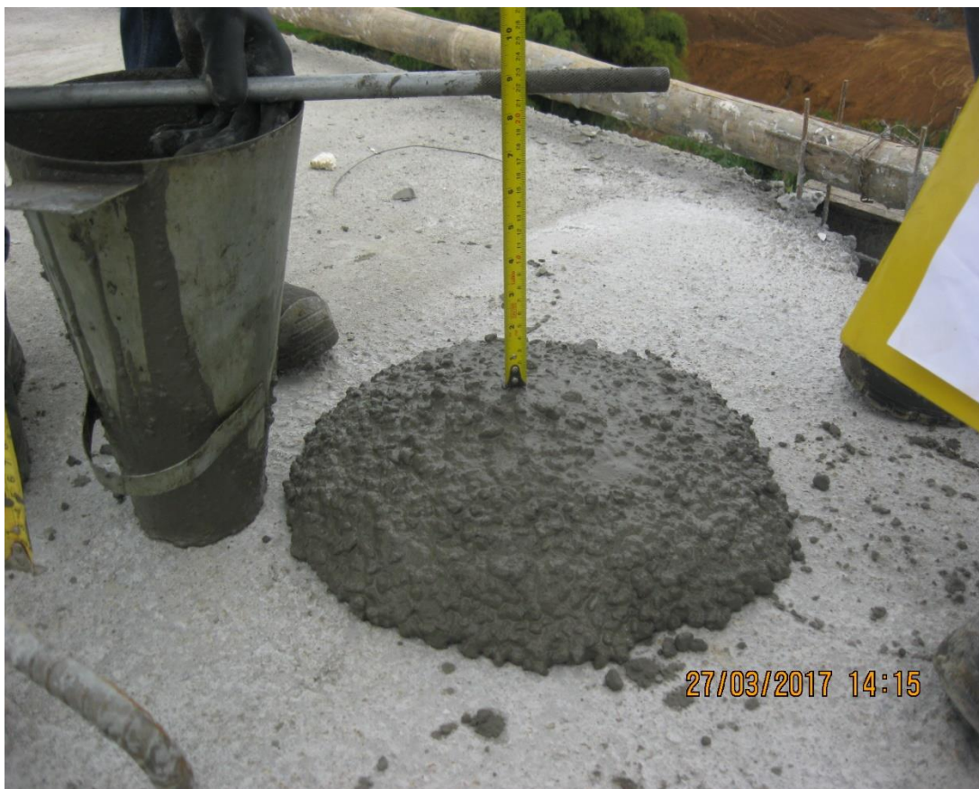
Figura N° 59: Prueba de asentamiento con el cono Slump.
