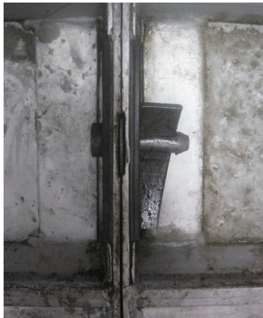
Figura N° 49: Pin y cuña en acero utilizadas para asegurar las corbatas.
