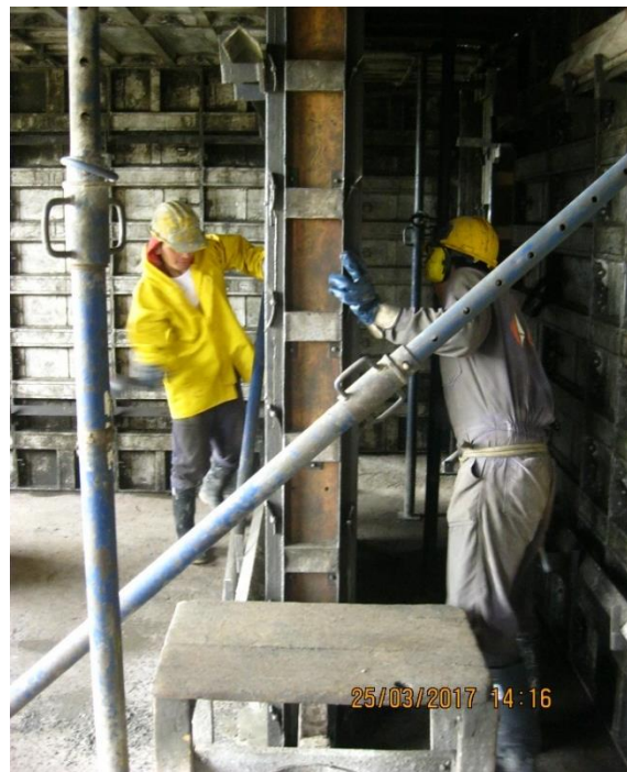
Figura N° 55: Proceso de “chipoteado” en el momento de fundición.
