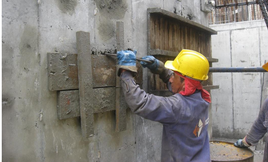
Figura N° 65: Puesta de formaleta para reparar error de fundición.
