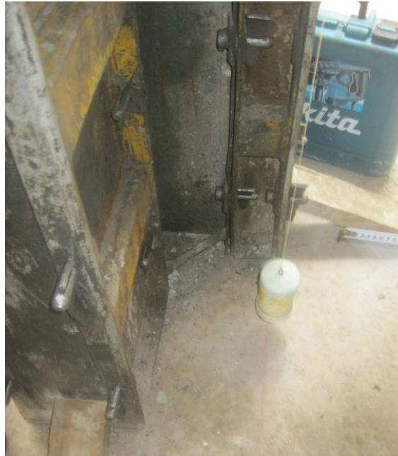
Figura N° 50: Plomada utilizada para garantizar la verticalidad de los muros.
