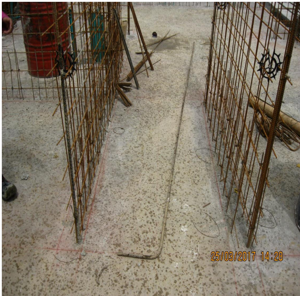
Figura N° 39: Malla electro soldada de muros o pantallas con pelos.
