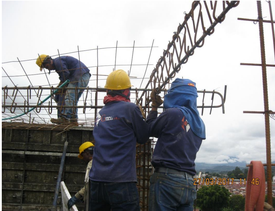
Figura N° 37: Proceso de amarre de aceros para dintel 1.
