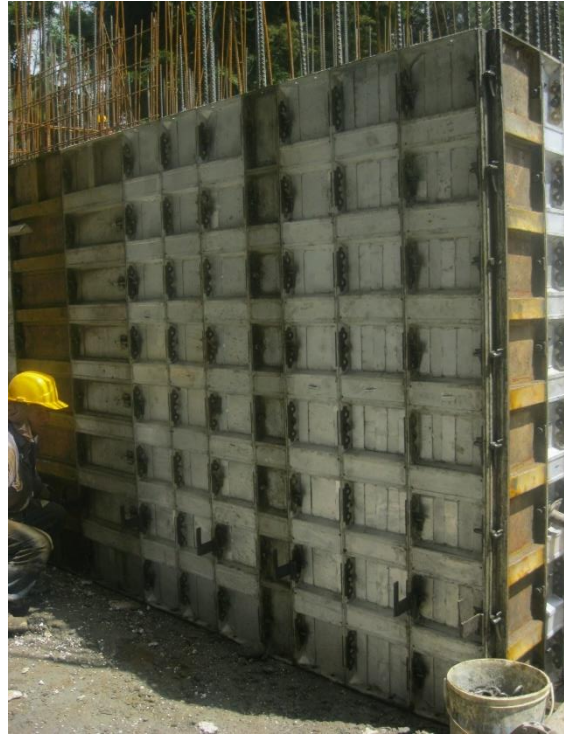
Figura N° 52: Apartamento encofrado listo para ser fundido.
