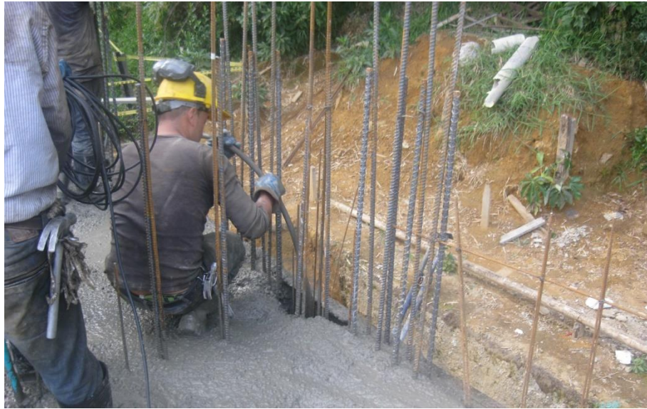
Figura N° 54: Proceso de vibrado en el momento de fundición.
