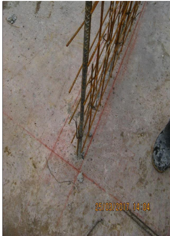
Figura N° 47: Cimbrado para la colocación de formaletas tipo Forsa
