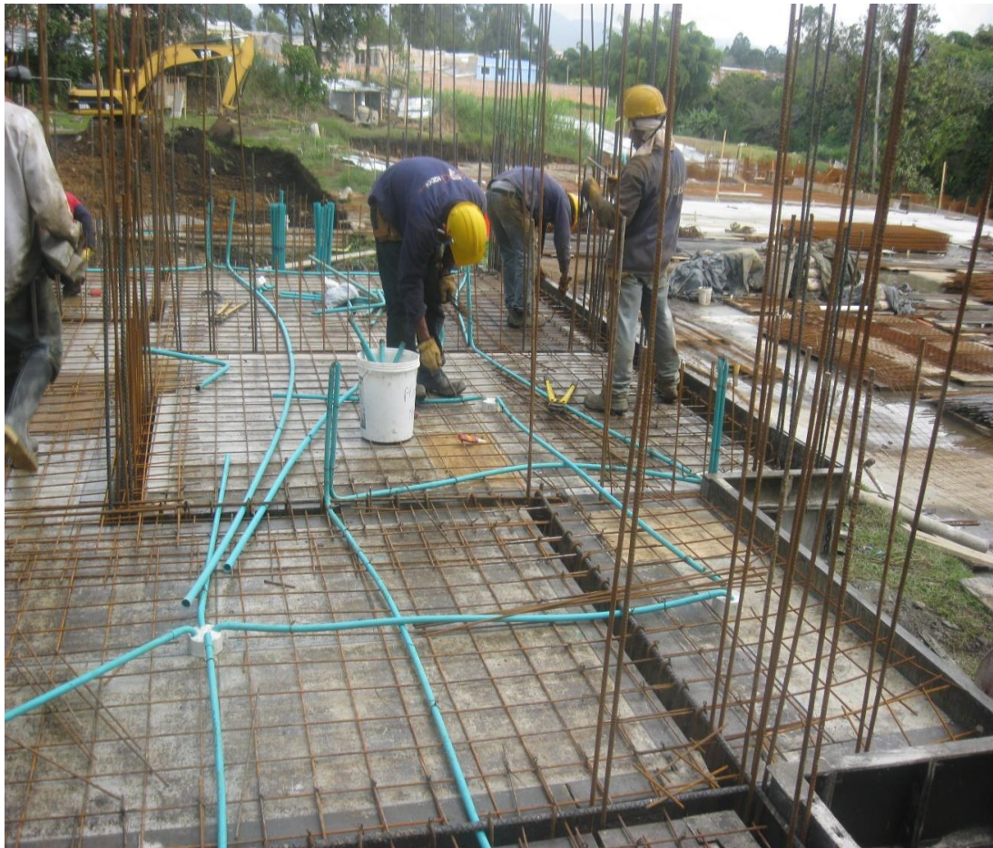
Figura N° 40: Instalación de red eléctrica en losa de entrepiso.
