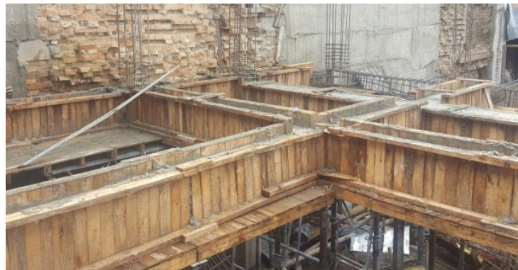
Figura 47 Vigas de entepiso nivel 1 y nivel2 . Fuente Contrato 1617-2015
