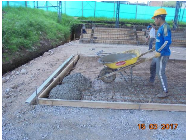
Figura 22 Inicio de fundición de placa de contrapiso espesor 10 cm. Fuente Contrato 1318-2013
