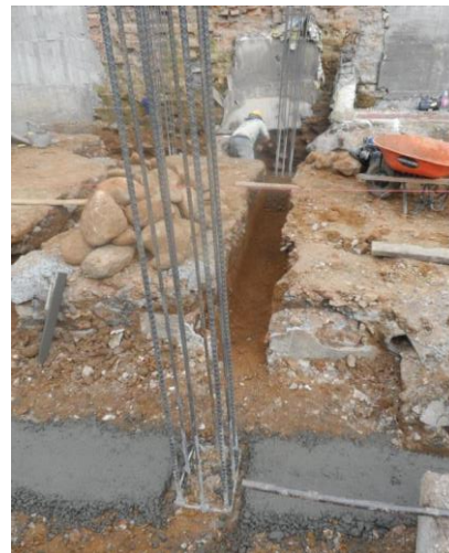
Figura 43 Solado de concreto para vigas de cimentación.
