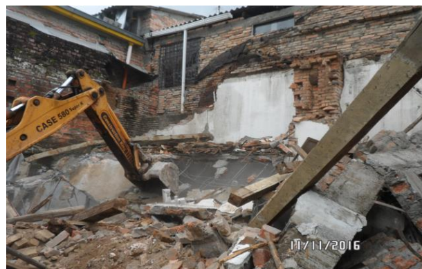
Figura 40 Demolición de la estructura. Fuente Contrato 1617-2015
