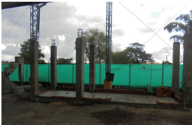
Figura 20 Placa de contrapiso para baterías sanitarias. Fuente Contrato 1318-2013
