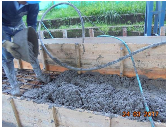
Figura 33 Fundición y vibración de graderías módulo 1. Fuente Contrato 1318-2013
