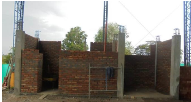
Figura 36 Estructura de baterías sanitarias para repellar. Fuente Contrato 1318-2013
