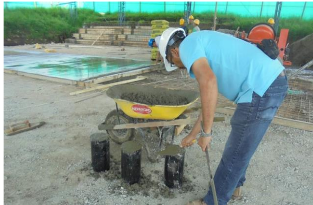
Figura 24 Toma de cilindros para ensayo a la resistencia del concreto de la placa de contrapiso. Fuente Contrato 1318-2013
