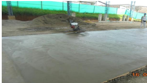
Figura 29 Pulido del concreto con helicóptero de la placa de contrapiso. Fuente Contrato 1318-2013
