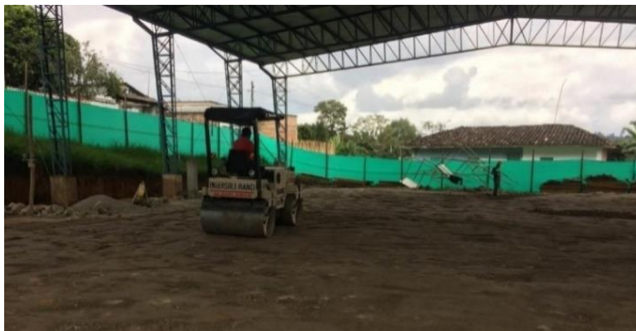
Figura 14 Nivelación de base granular. Fuente Contrato 1318-2013
