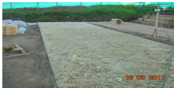
Figura 30 Curado del concreto con agua y yute de cabuya. Fuente Contrato 1318-2013
