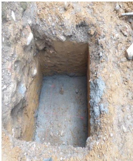
Figura 42 Solado de concreto para zapatas.
