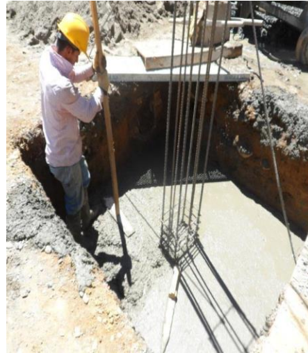
Figura 44 Vaciado de concreto vigas de cimentación Figura 45 Vaciado de concreto zapatas.
