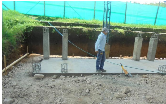
Figura 19 Placa de contrapiso para gradería. Fuente Contrato 1318-2013
