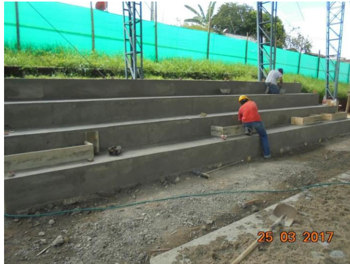
Figura 35 Terminado de la fundición de graderías módulo 1 Fuente Contrato 1318-2013
