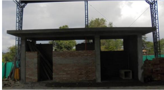
Figura 37 Estructura de baterías sanitarias para repellar. Fuente Contrato 1318-2013
