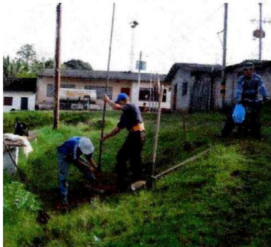
Figura 2. Realización de los sondeos en el terreno. Fuente Estudios y diseños contrato 1318-2013
