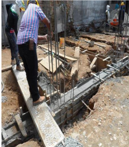
Figura 44 Vaciado de concreto vigas de cimentación Figura 45 Vaciado de concreto zapatas.
