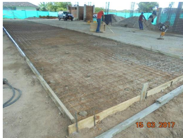
Figura 21 Colocación malla electro soldada para placa de concreto. Fuente Contrato 1318-2013
