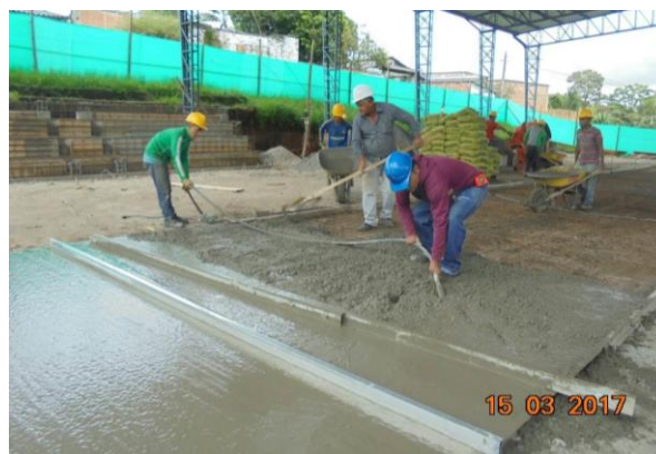
Figura 23 Vibrado del concreto de la placa de contrapiso. Fuente Contrato 1318-2013
