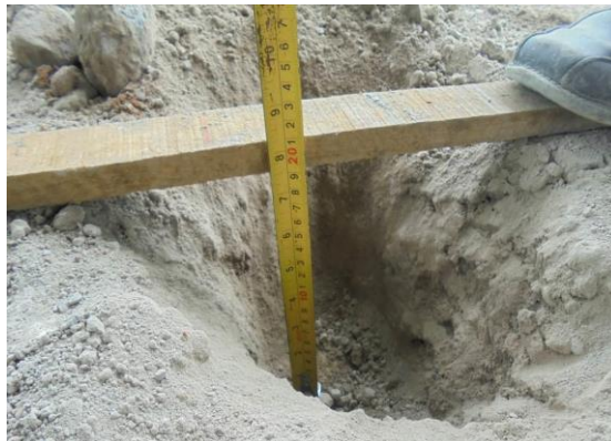
Figura 18 Chequeo de espesores. Fuente Contrato 1318-2013
