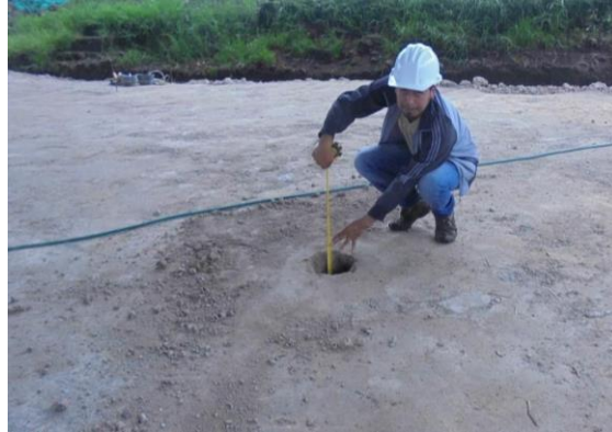
Figura 17 Chequeo de espesores por parte de residente interventor. Fuente Contrato 1318-2013
