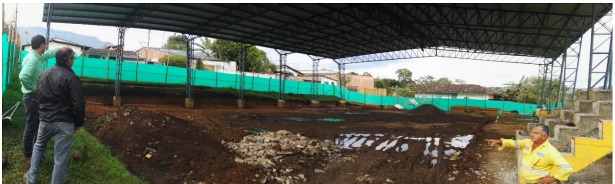
Figura 13 Demolicion y descapote para realizacion de placa. Fuente Contrato 1318-2013
