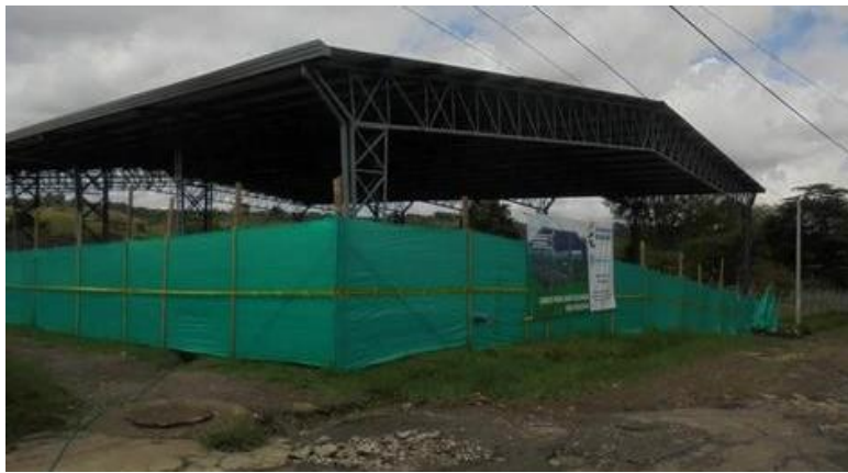
Figura 11 Estructura primera etapa polideportivo Tunia. Fuente Contrato 1318-2013
