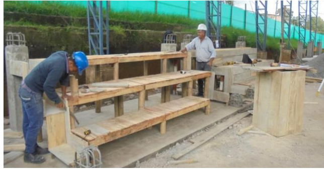
Figura 31 Formaleta para graderías módulo. Fuente Contrato 1318-2013
