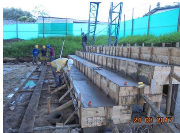
Figura 34 Fundición y vibración de graderías módulo 1. Fuente Contrato 1318-2013
