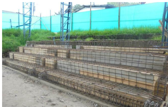
Figura 32 Formaleta para graderías módulo y refuerzo de acero. Fuente Contrato 1318-2013
