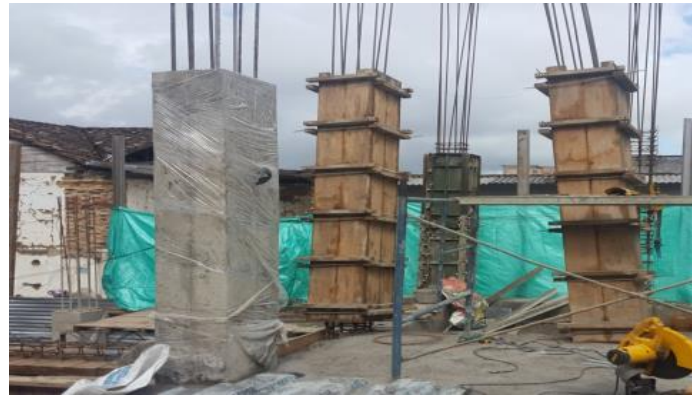
Figura 46 Columnas nivel 1 . Fuente Contrato 1617-2015
