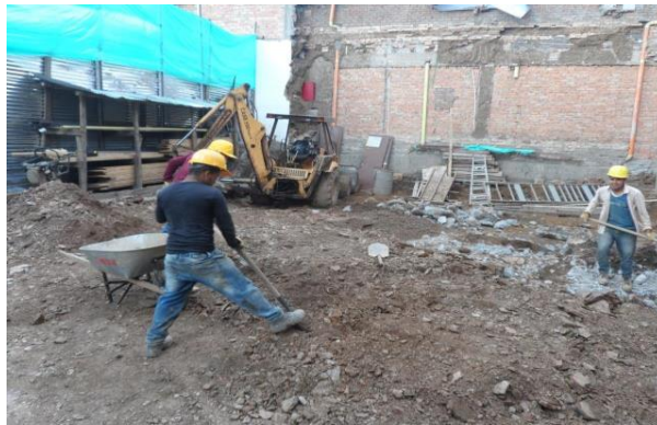
Figura 41 Nivelación del terreno. Fuente Contrato 1617-2015
