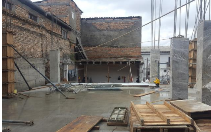
Figura 48 Losa de entepiso. Fuente Contrato 1617-2015
